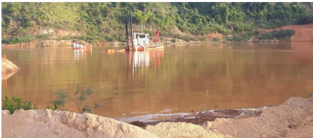
Figura 6.2.2-1: Registro da dragagem de desassoreamento do lago da UHE Risoleta Neves.
