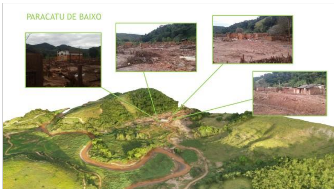
Figura 2.1-3: Danos ao subdistrito de Paracatu de Baixo – Destruição quase total (Jun/2017).
