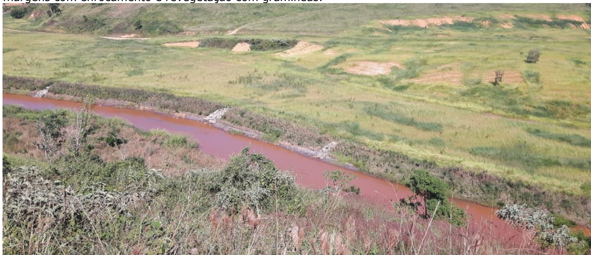
Figura 6.2.2-5: Área prioritária inspecionada, onde há obras de drenagem, estabilização de margens com enrocamento e revegetação com gramíneas.
