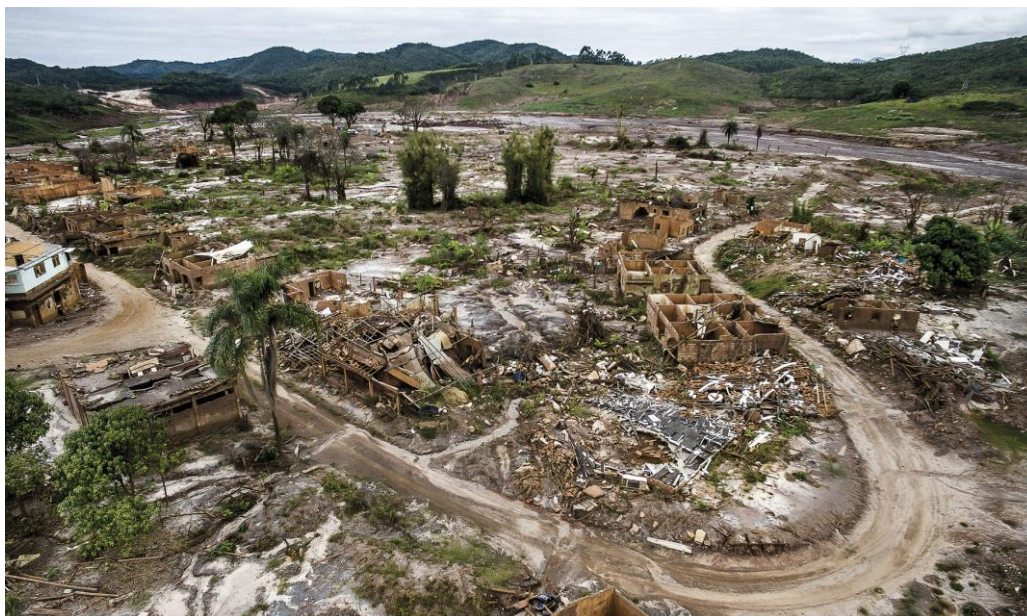
Figura 2.1-2: Danos ao subdistrito de Bento Rodrigues – Destruição quase total (Jul/2016).
