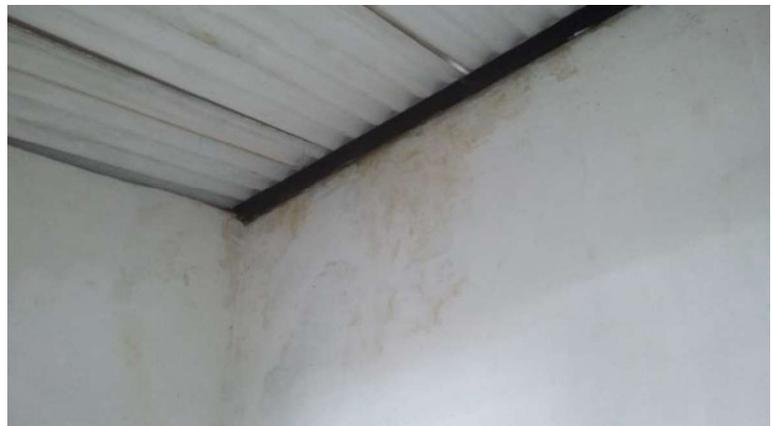
Foto 8: sala de atendimento próxima a uma das enfermarias com infiltração.
