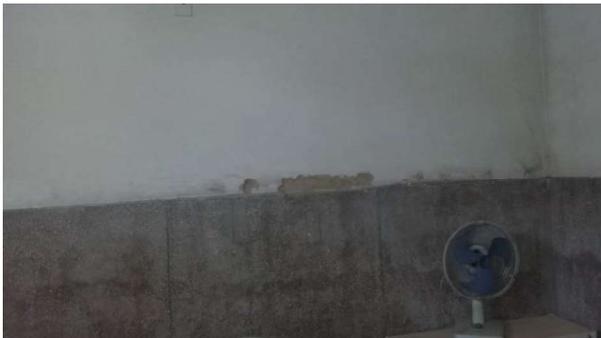
Foto 23: infiltrações na parede e ventilador sem tela de proteção.
