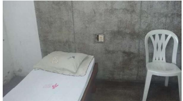
Foto 22: tomada elétrica sem proteção.
