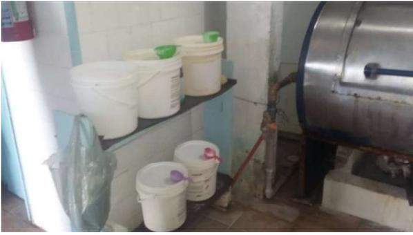
Foto 12: lavadora com pontos de oxidação.
