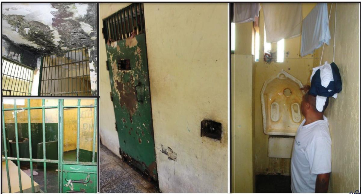
**Foto 22:** Infraestrutura predial comprometida com infiltrações, portões e portas de aço em corrosão, estrutura sanitária deteriorada. (Fonte: Acervo do MNPCT, 2019).
