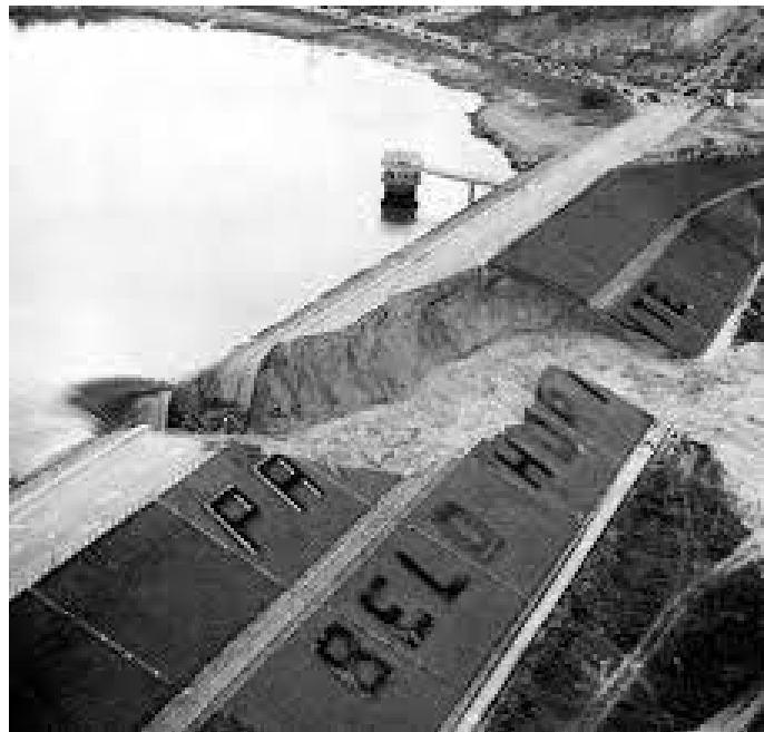
Figura 5: Ruptura da barragem da Pampulha (1954) - Fonte: Google (2023)
