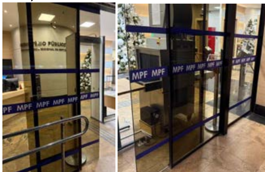
Acessibilidade, instalação de identidade visual em adesivos, na porta de vidro automática da portaria
