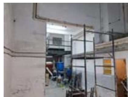
Preparo das paredes para pintura da área das docas
