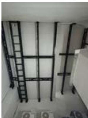
Instalação da estrutura do telhado na parte baixa
