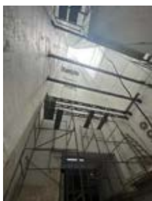
Instalação da estrutura do telhado na parte baixa
