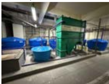
Sistema após manutenção
