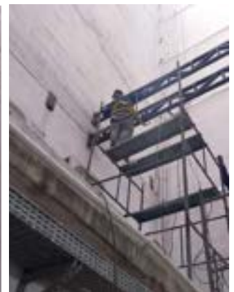
Instalação da estrutura do telhado na parte baixa do prisma
