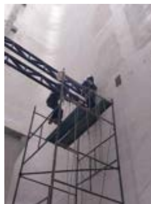
Instalação da estrutura do telhado na parte baixa do prisma
