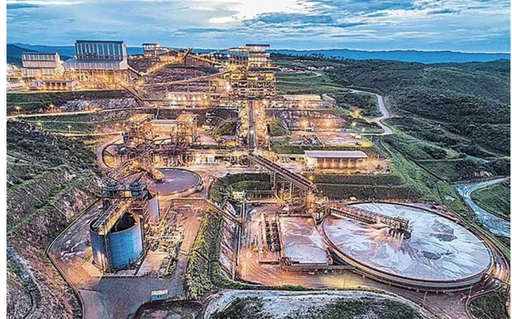
Imagem: Usina de Beneficiamento
