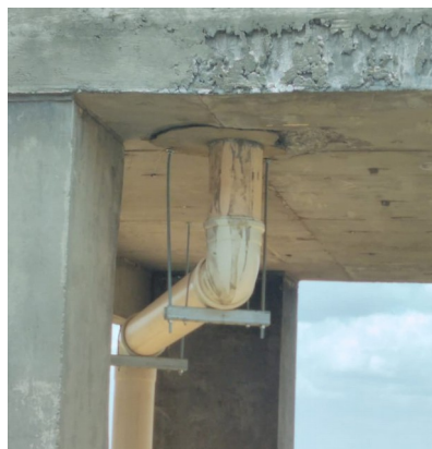
Figura 8. Descida da tubulação pluvial.
