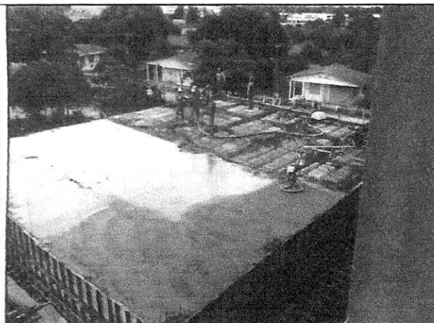
Foto 1: Vista da laje durante a concretagem.
