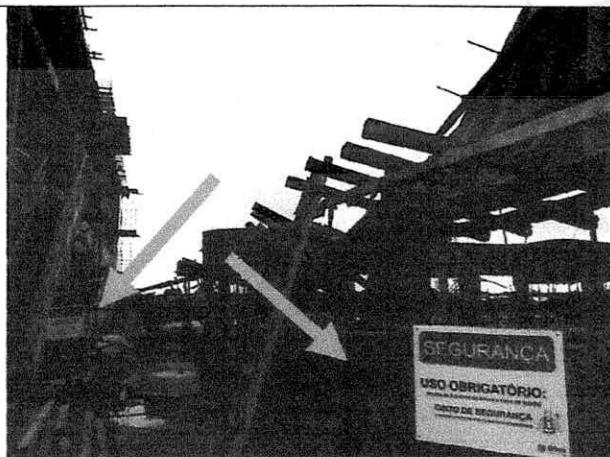
Foto 2: Placa indicando a obrigatoriedade do Uso de Cinto de Segurança tipo paraquedista ligado a linha de vida e outros EPI's.
