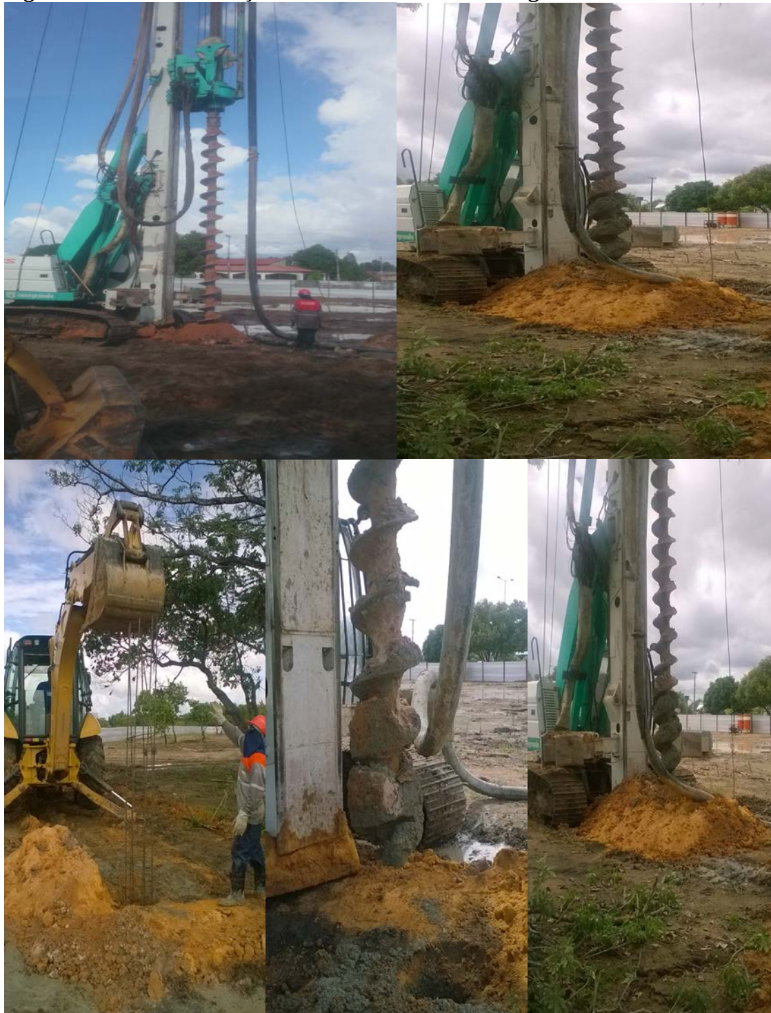
Figuras 33 a 49 – Perfuração – Estacamento – Concretagem – Barraco – Placa
