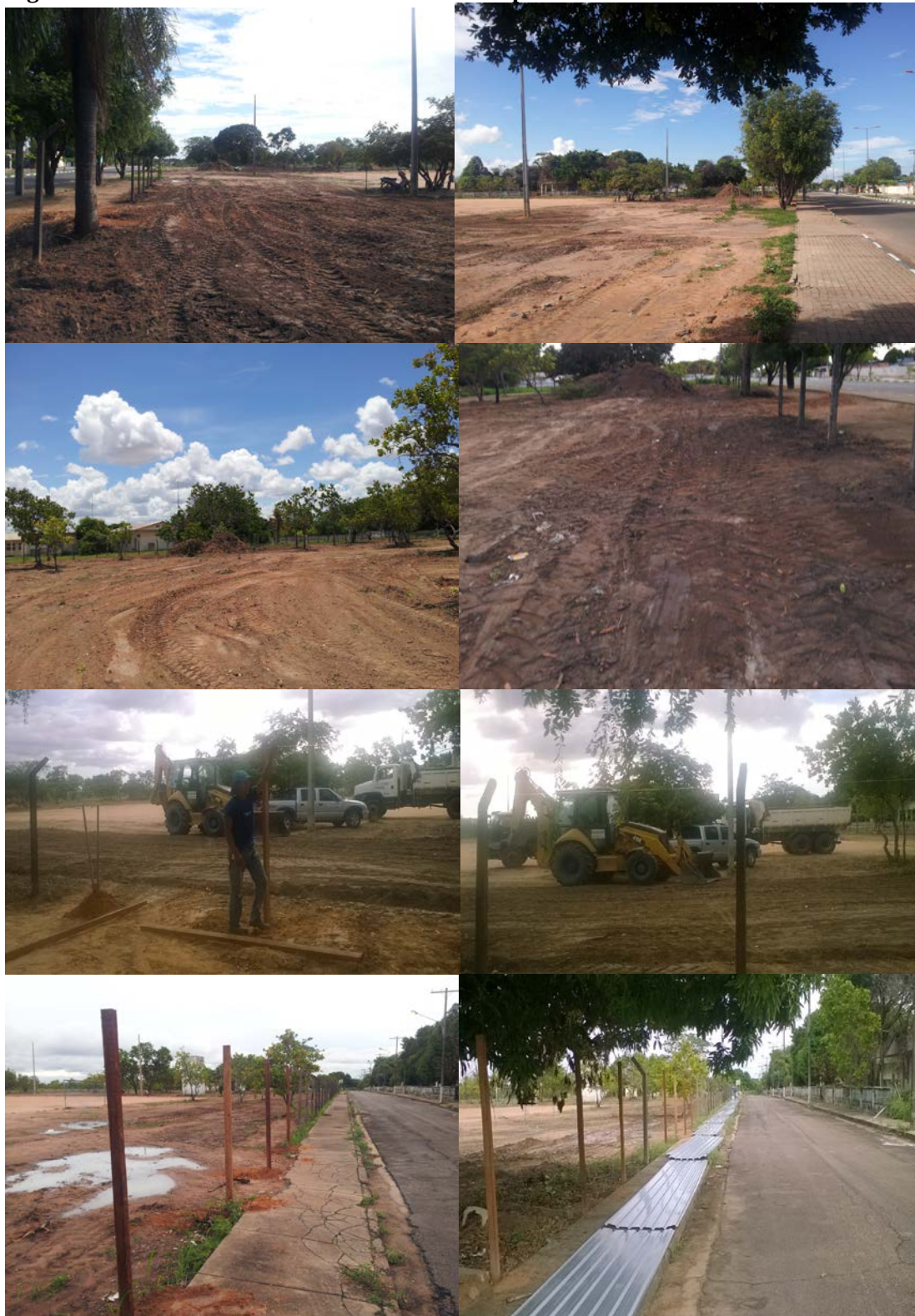
Figuras 13 a 20 – Área do Terreno durante a limpeza
