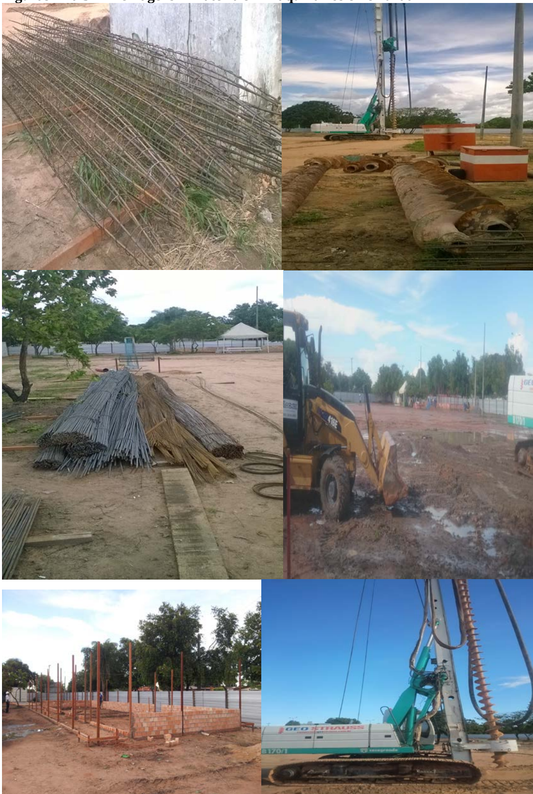
Figuras 27 a 32 – Ferragens – Materiais – Maquinários e Perfuratriz
