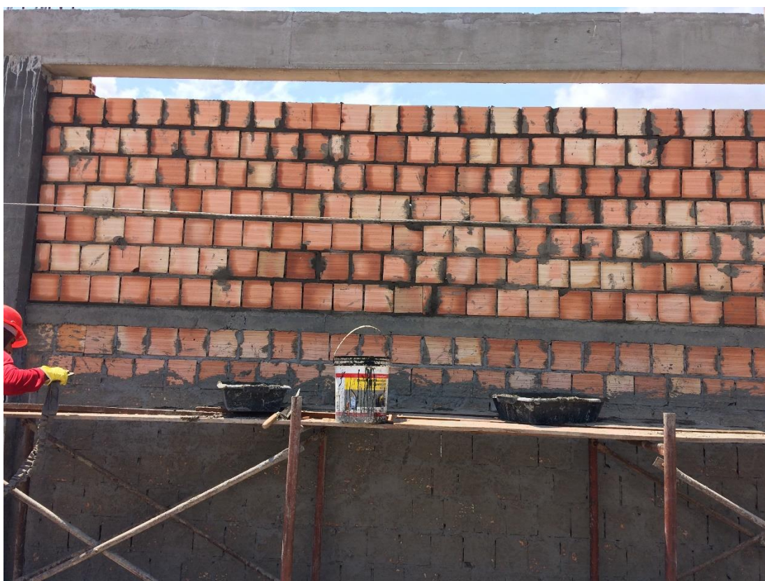
Fechamento da alvenaria do pavimento cobertura.
