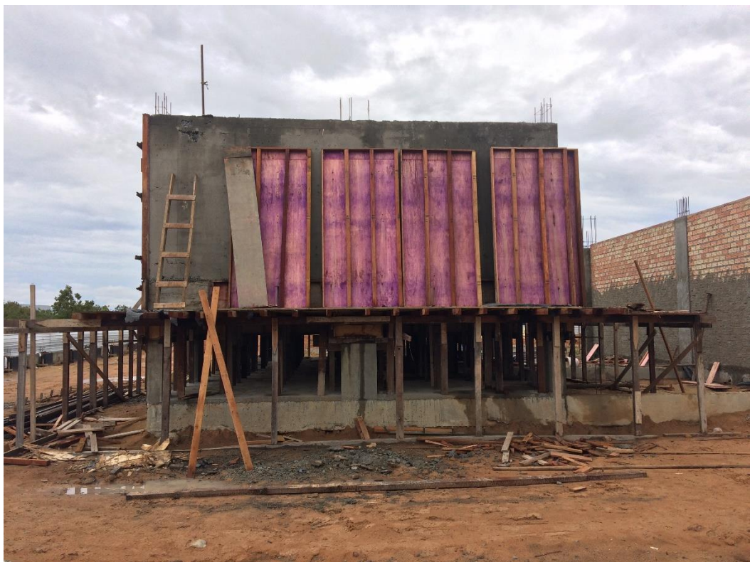
Retirada de formas laterais do reservatório da casa de máquinas.
