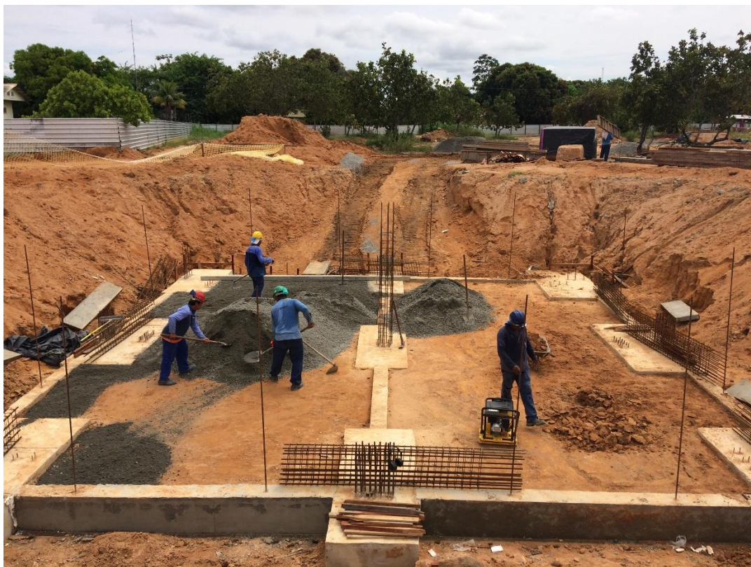
Aterro e compactação da base para assentamento do reservatório de reuso.
