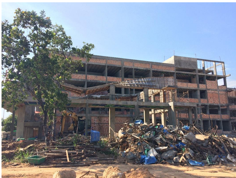
Retirada de lajes colapsadas do auditório.
