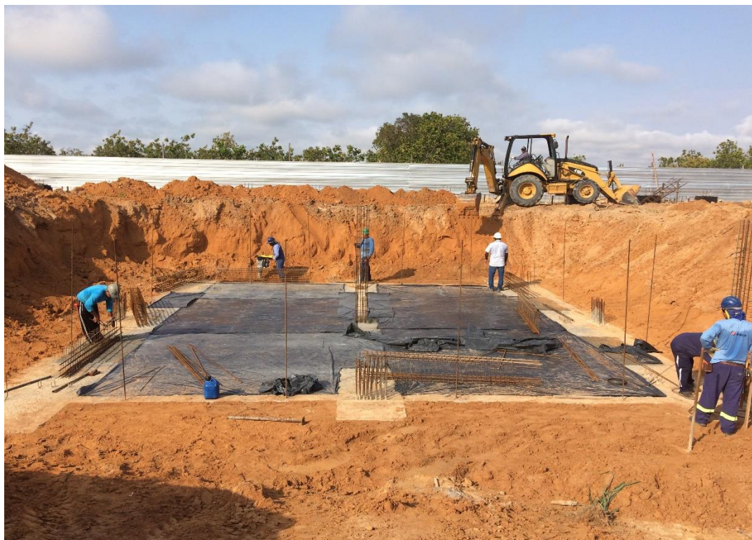
Impermeabilização do solo no reservatório de reuso.
