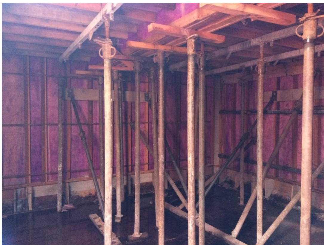
Escoramento do reservatório de reuso.
