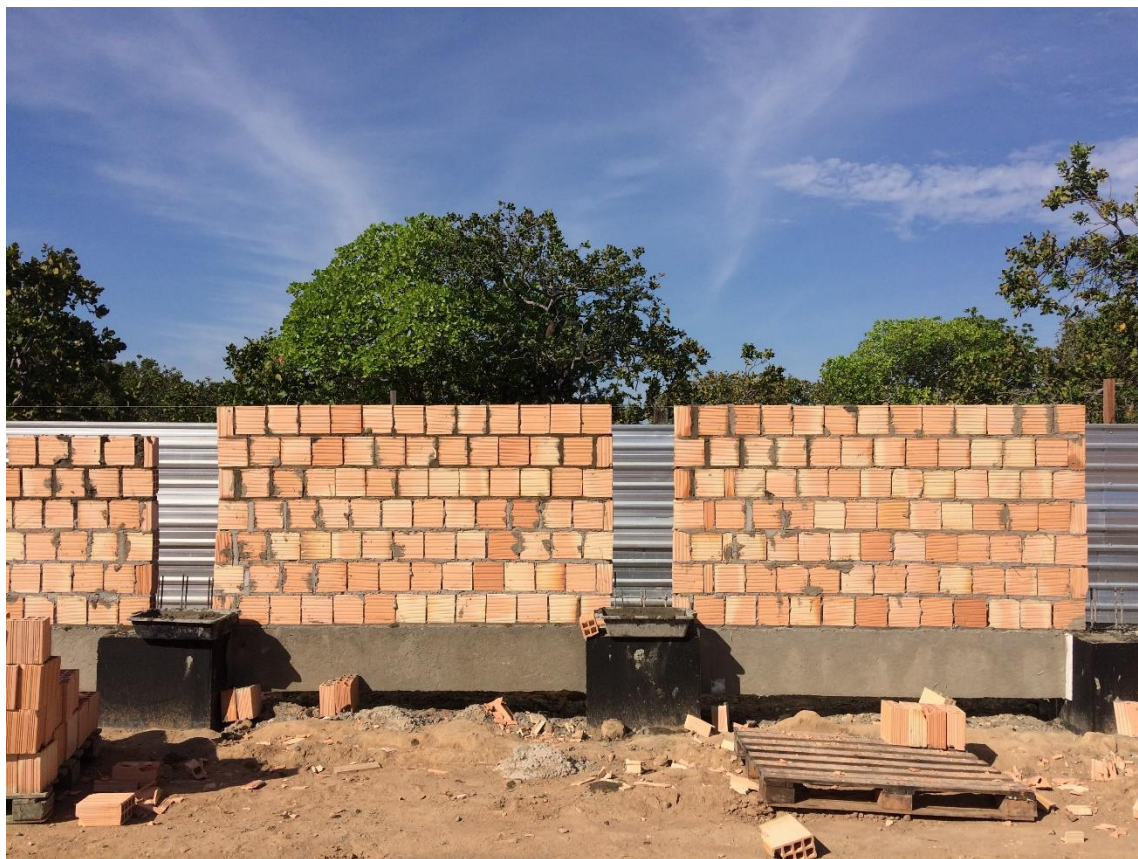
Lançamento da alvenaria do muro.
