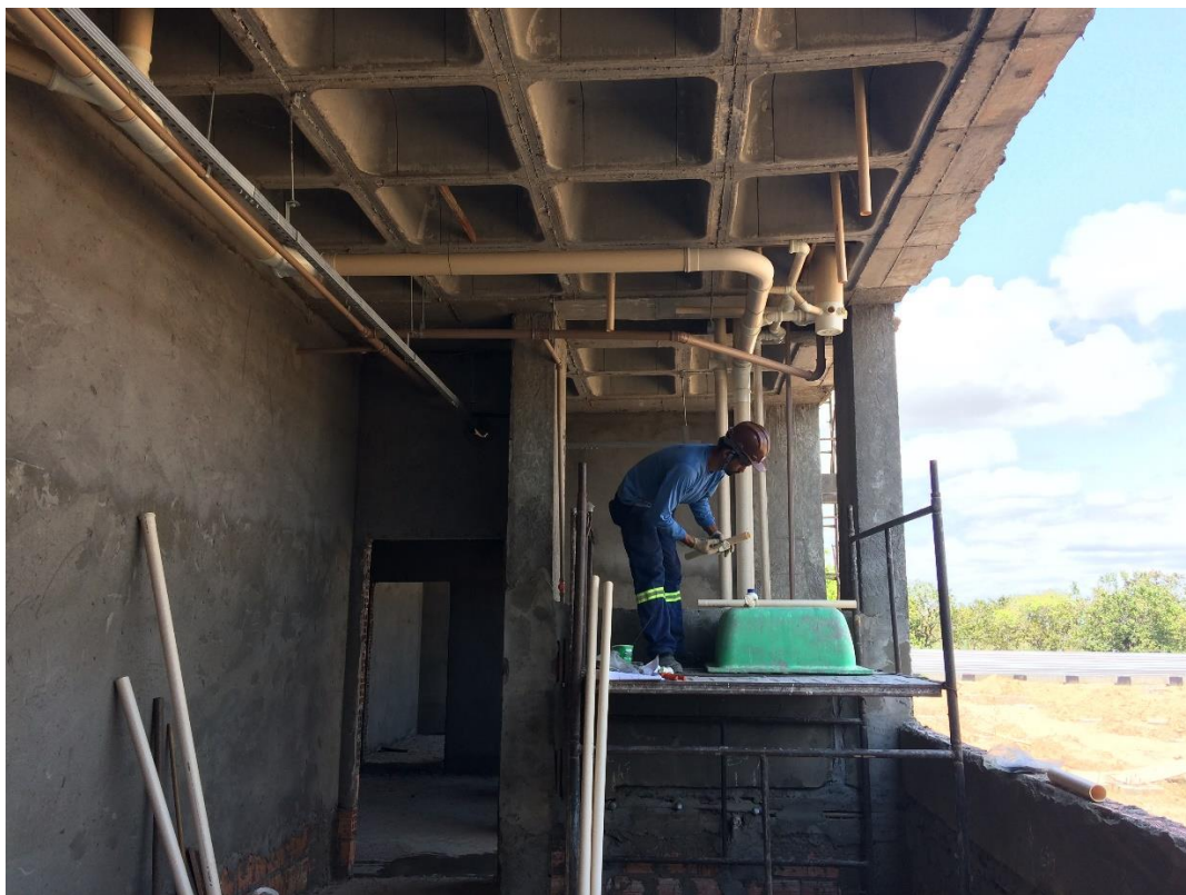
Instalação de tubulações hidrossanitárias.
