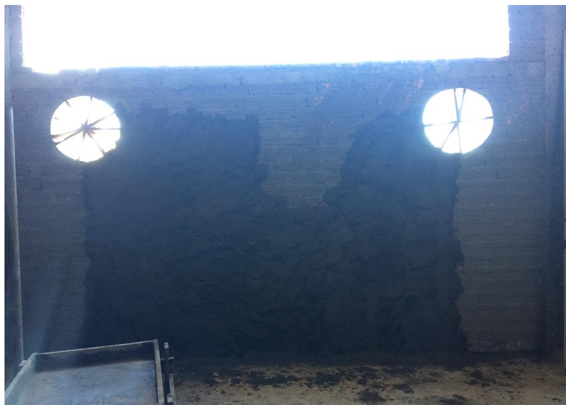
Reboco da casa de máquinas.
