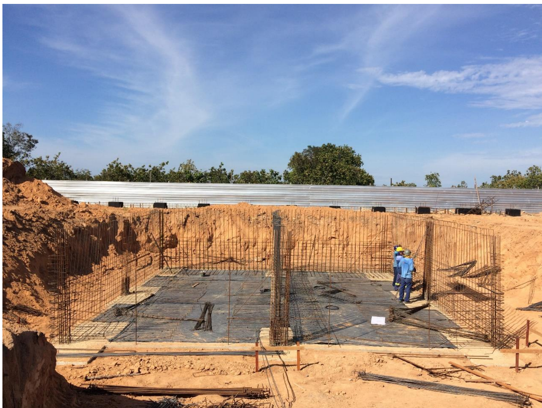
Montagem de armações do reservatório de reuso.
