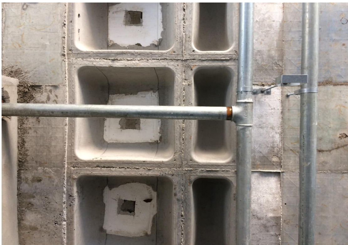
Lançamento de tubulação para combate a incêndio.
