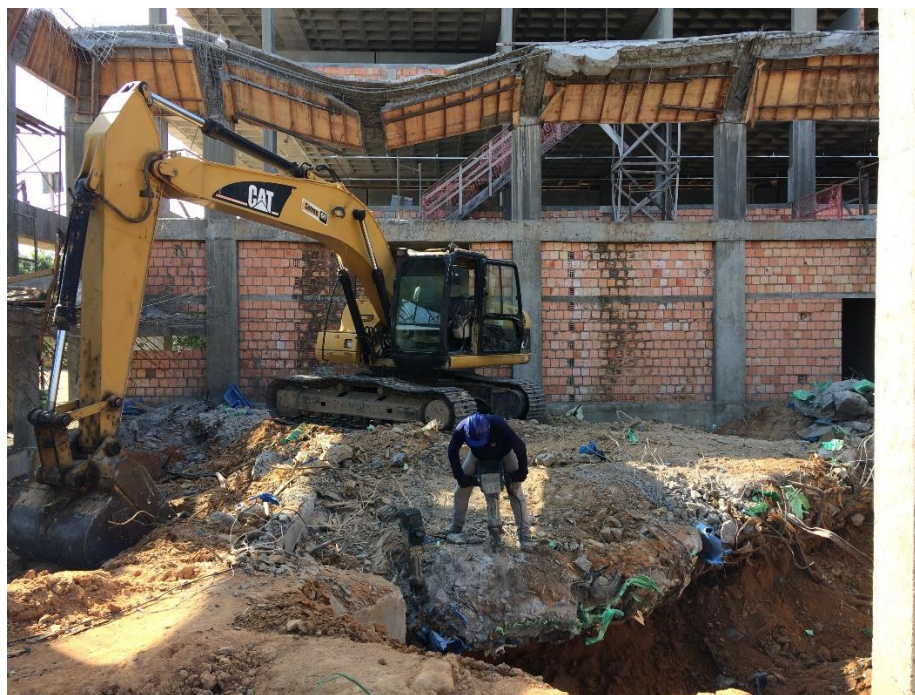
Retirada de lajes colapsadas do auditório.
