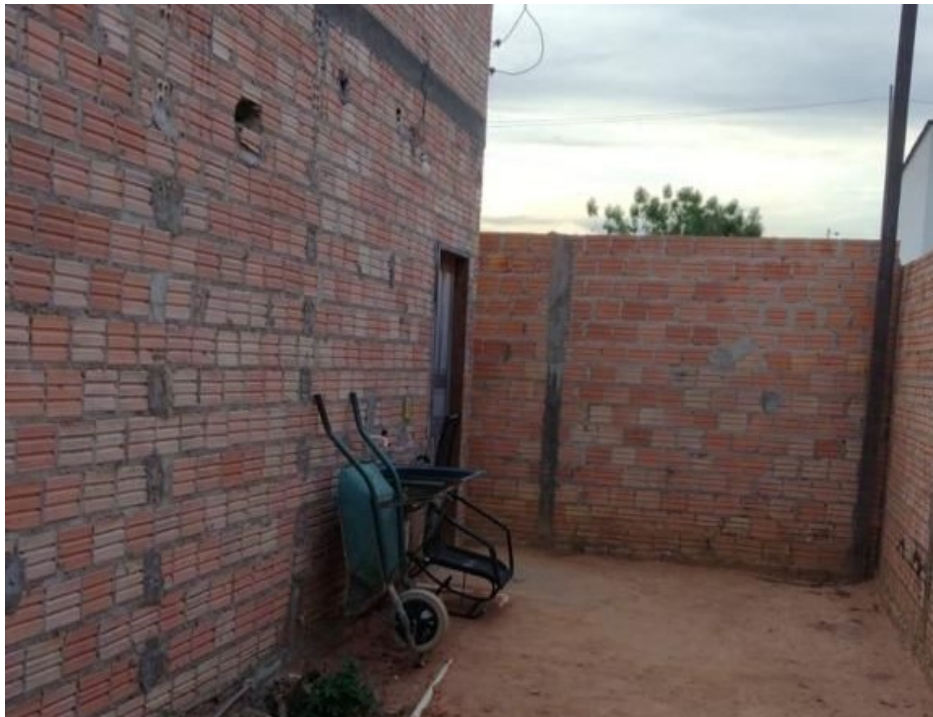
Construção de casas também sido paradas por conta do valor do cimento. (Foto: Arquivo pessoal/Jailson Souza)
