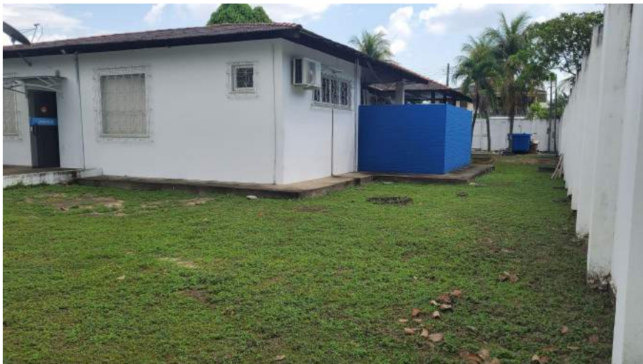
Foto 15 - Amostra de área externa e edificação
