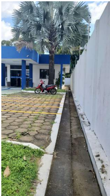
Fotos 08 e 09 - Dique lateral do edifício principal
