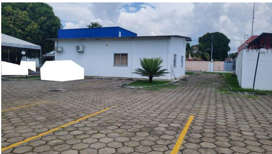
Foto 14 - Amostra de área externa e edificação
