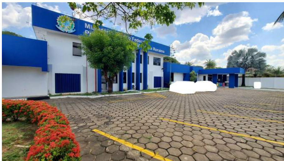
Foto 03 - Fachada principal e pátio de estacionamento frontal
