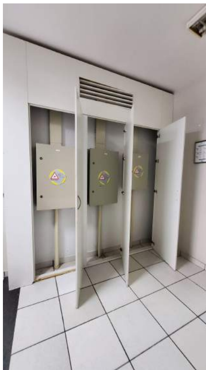
Fotos 30 e 31 - Amostras de áreas internas - armários com quadros de energia elétrica
