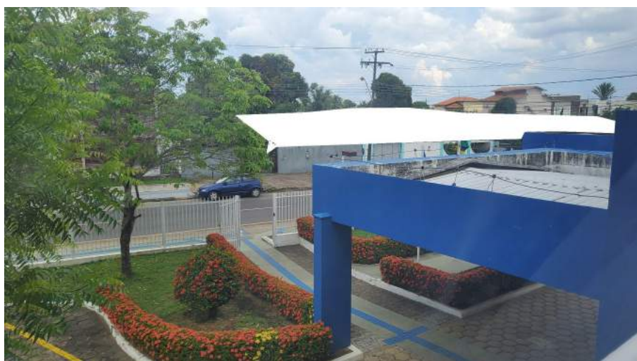
Foto 04 - Vista do acesso principal e de parte de sua cobertura
