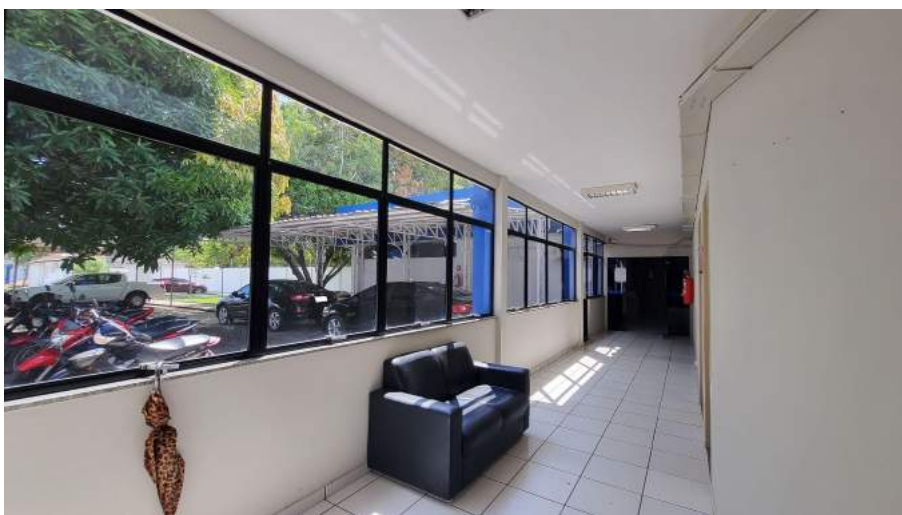
Foto 26 - Amostra de área interna e esquadrias - circulação
