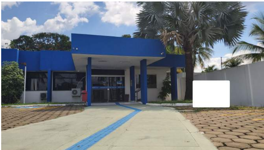
Foto 21 - Amostra de área externa e edificação
