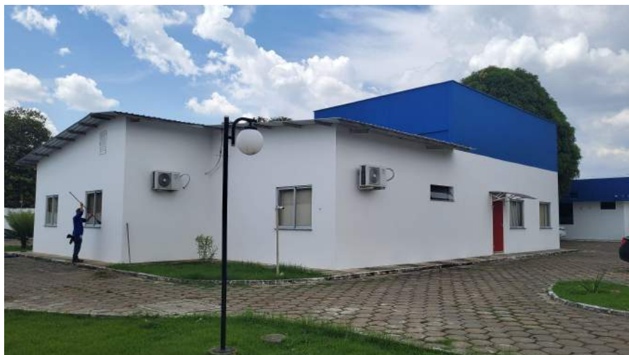
Foto 18 - Amostra de área externa e edificação
