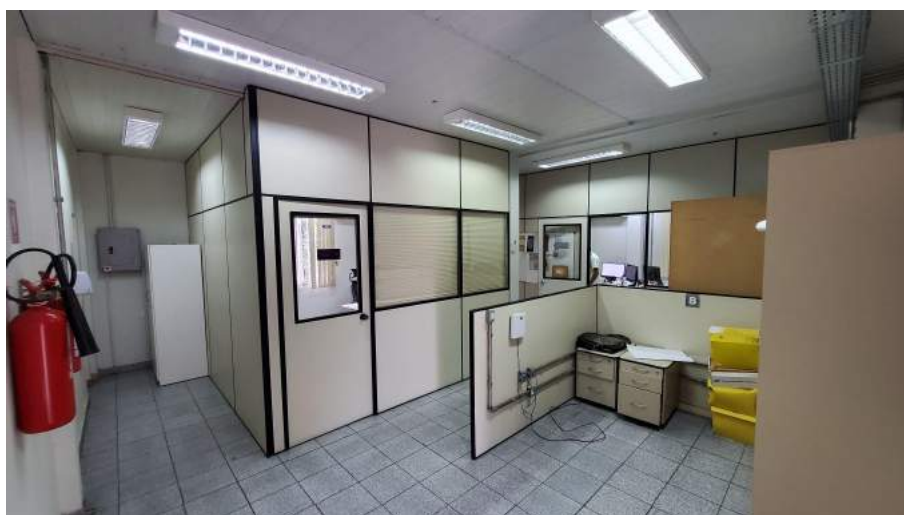
Foto 55 - Amostra de área interna - circulação e esquadrias
