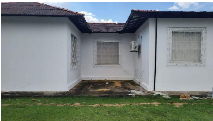
Foto 16 - Amostra de área externa e edificação
