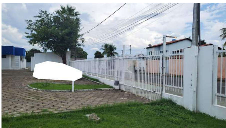
Foto 19 - Amostra de área externa e gradil lateral
