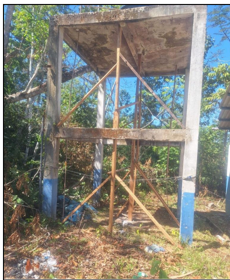
Imagem 7 - Estrutura para caixa d'água em más condições.
