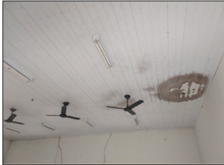
Imagem 4 – Teto da sala de aula com mofo e com infiltração.
