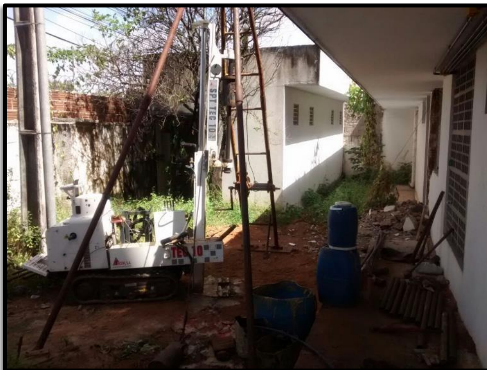
Figura 7: Sondagem na área do empreendimento.
