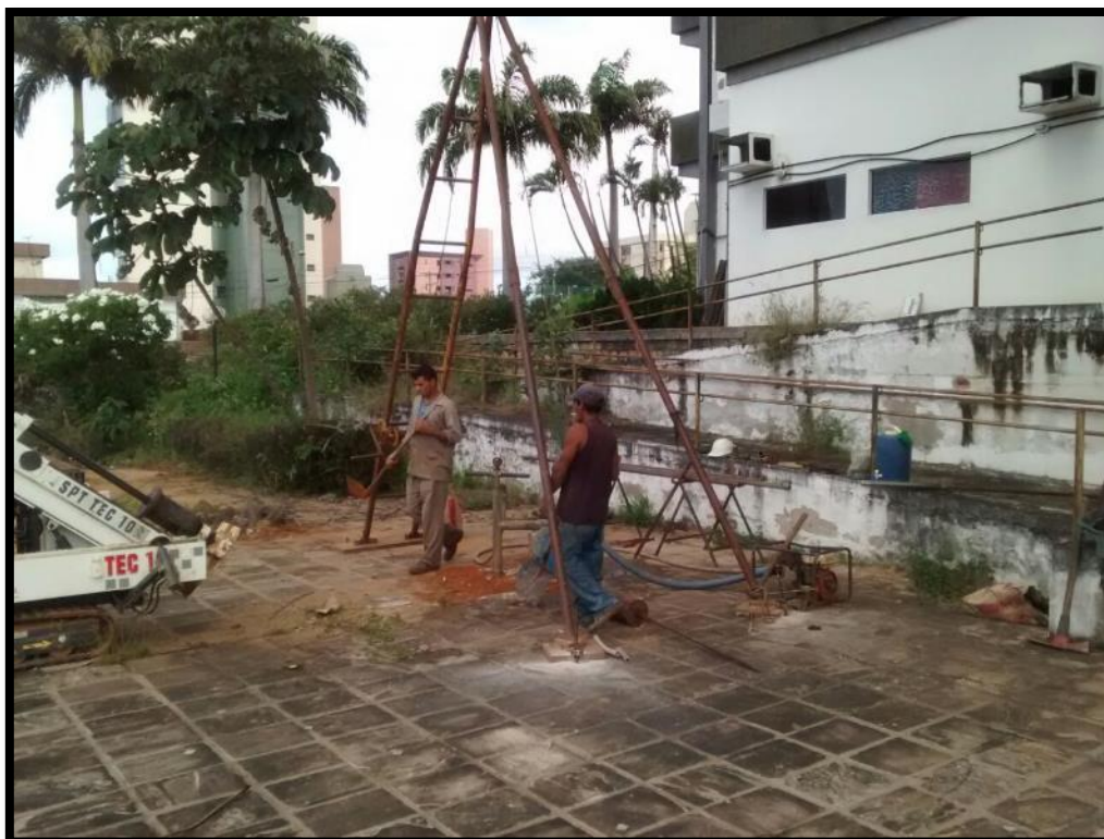
Figura 9: Identificação da sondagem área do empreendimento.
