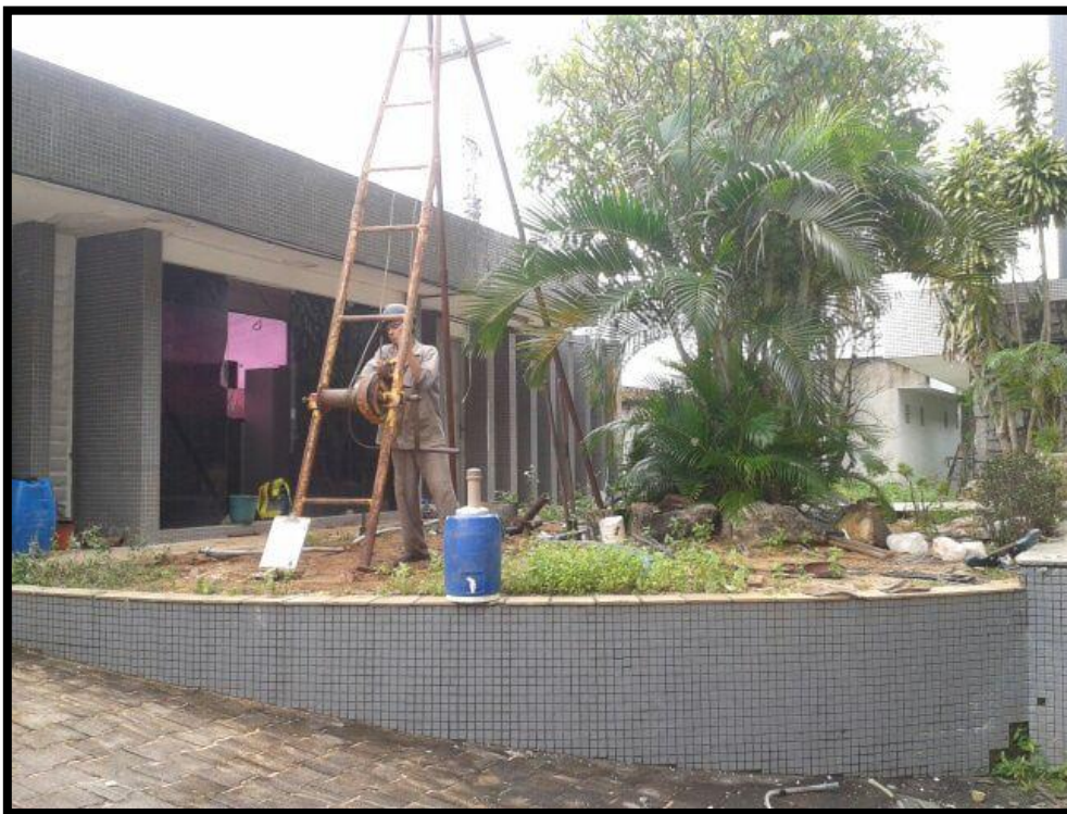
Figura 5: Sondagem na área do empreendimento.
