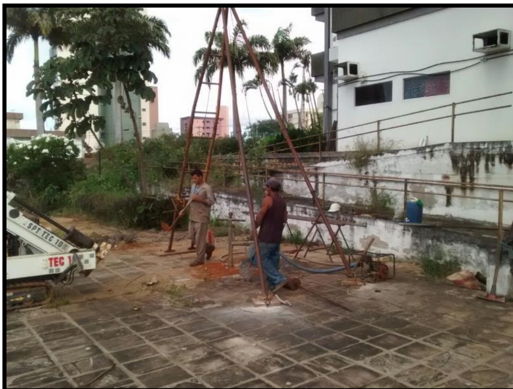
Figura 9: Identificação da sondagem área do empreendimento.
