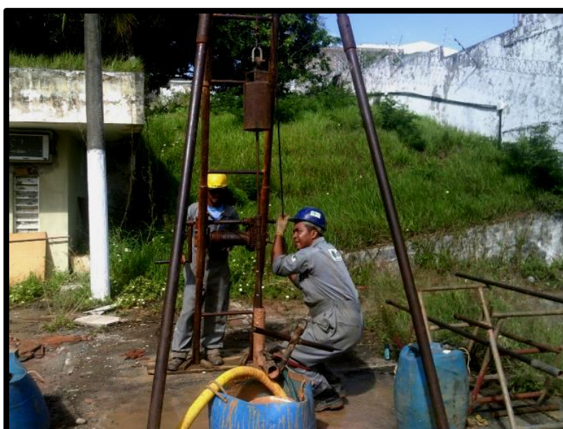
Figura 4: Execução da sondagem SPT na área do empreendimento.
