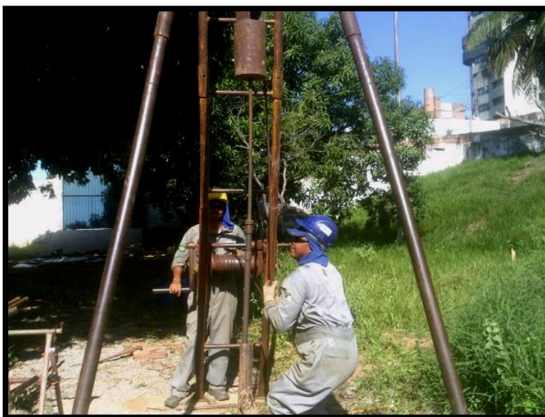
Figura 3: Execução da sondagem SPT na área do empreendimento.
