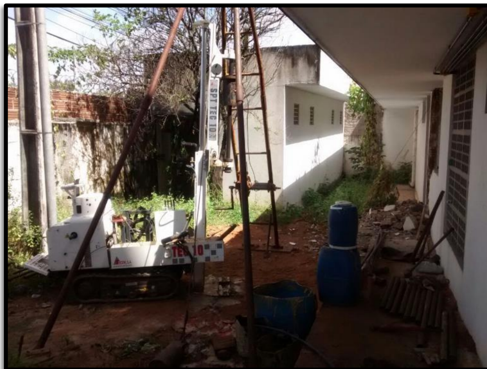
Figura 7: Sondagem na área do empreendimento.
