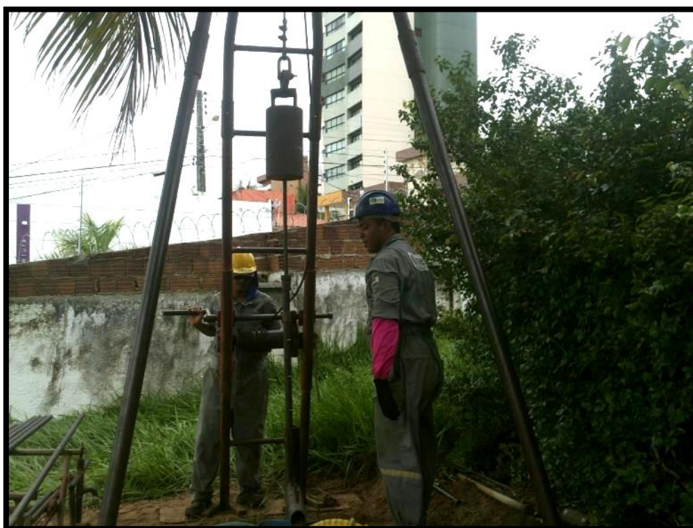
Figura 6: Sondagem na área do empreendimento.
