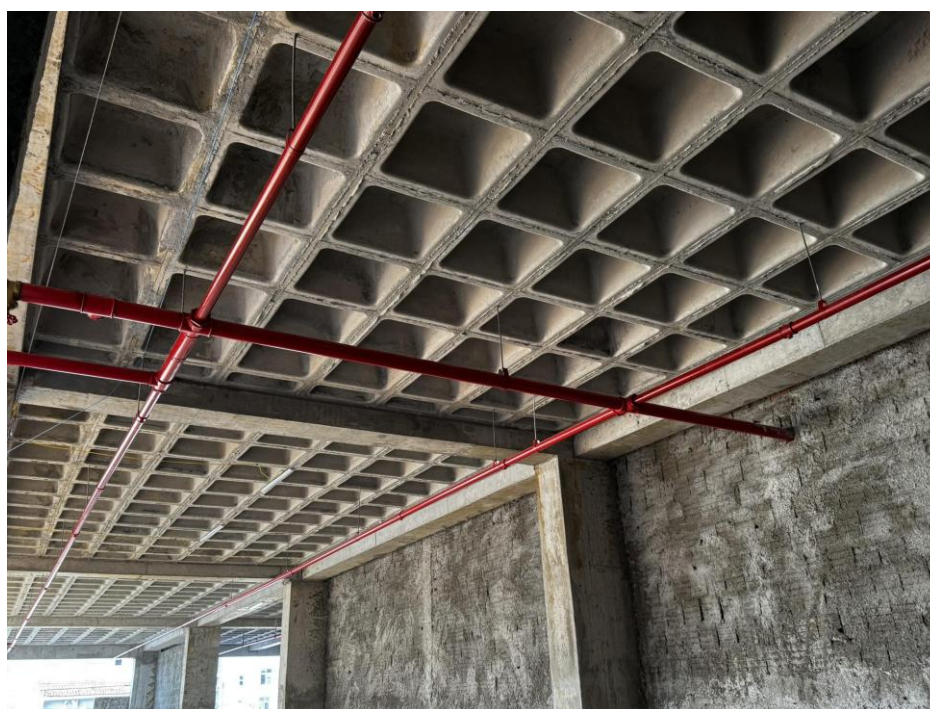
Figura 14. Instalação das tubulações de aço galvanizado de hidrantes e sprinkler.
