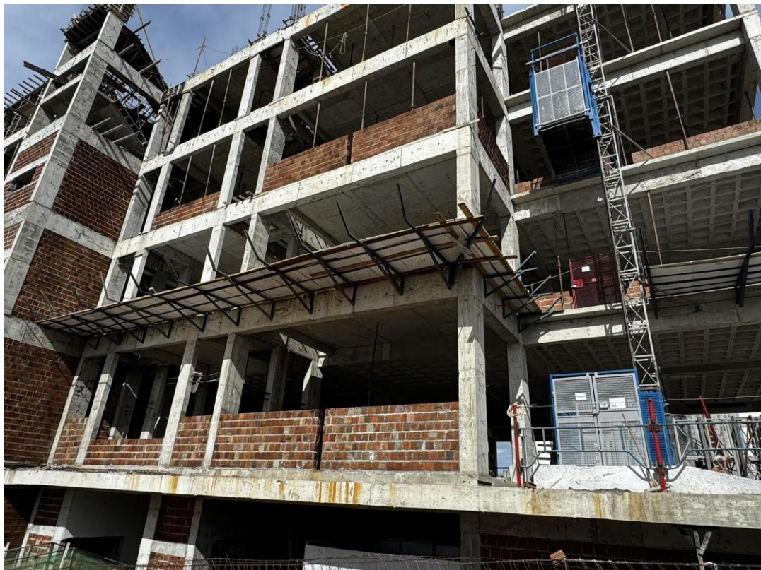
Figura 12. Execução de alvenaria com tijolos cerâmicos de 14cm de largura.
