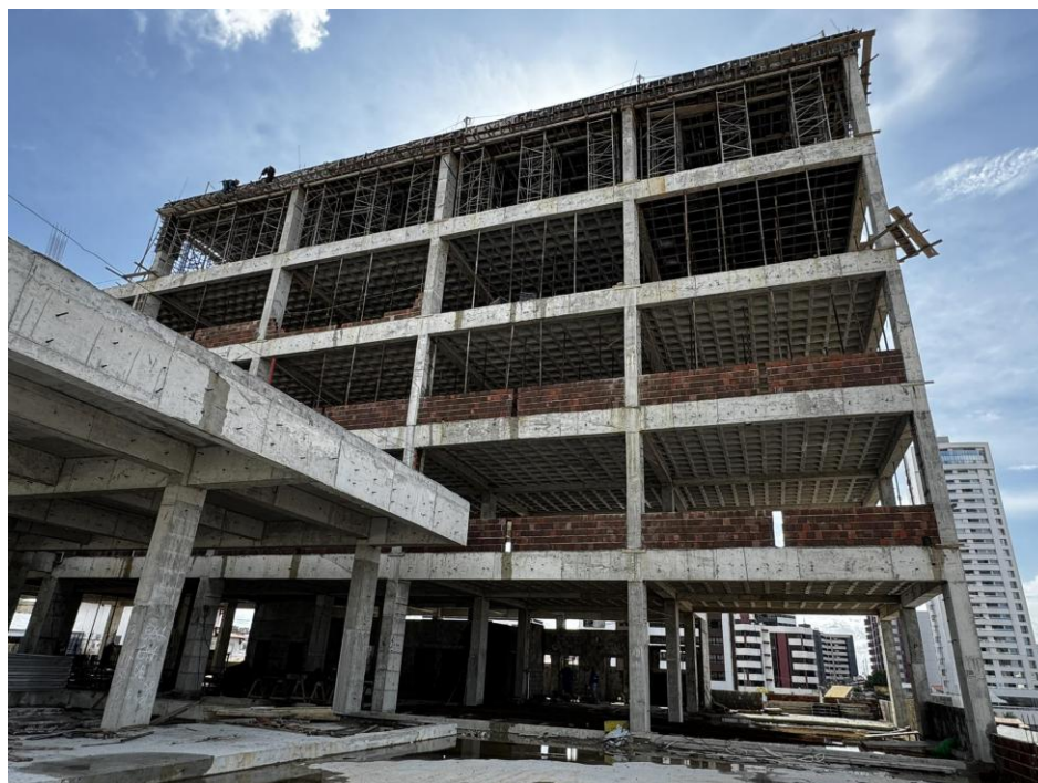
Figura 5. Visão da fachada sul com a concretagem da primeira metade da laje de cobertura do quarto pavimento.
