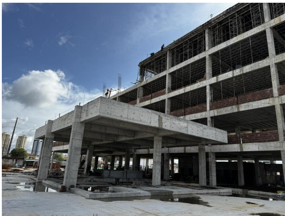
Figura 10. Execução de alvenaria de 14 cm no perímetro dos pavimentos.
