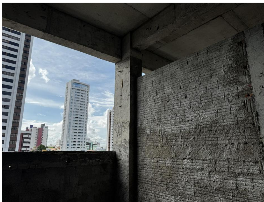
Figura 13. Chapisco aplicado nas paredes internas.
