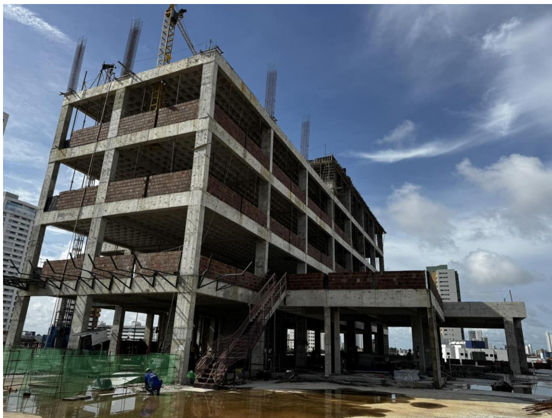
Figura 1. Visão geral da obra.
