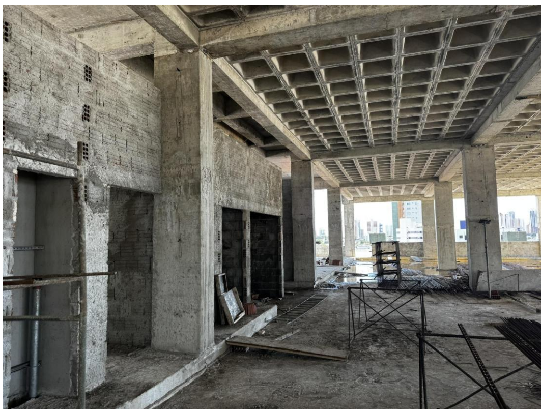
Figura 11. Execução de alvenaria dos banheiros no pavimento térreo.
