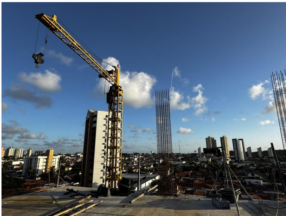
Figura 4. Visão da Grua na laje de piso do quarto pavimento.
