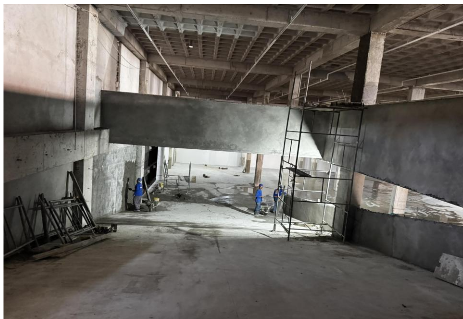
Figura 9. Execução de alvenarias na rampa entre os pavimentos semi enterrado 1 e 2..
