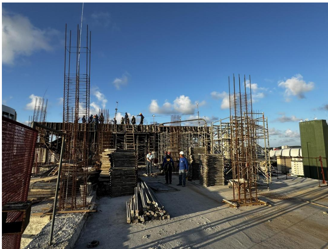
Figura 6. Montagem e concretagem dos pilares do quarto pavimento.
