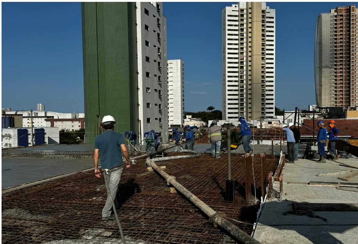
Figura 7. Trecho da laje de cobertura do segundo subsolo para ser concretado.
