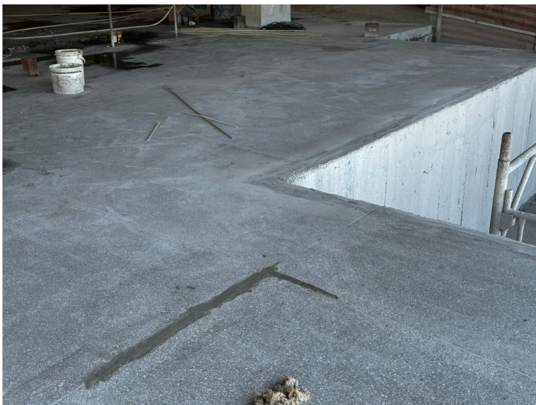
Figura 10. Execução de piso granilite no segundo subsolo.
