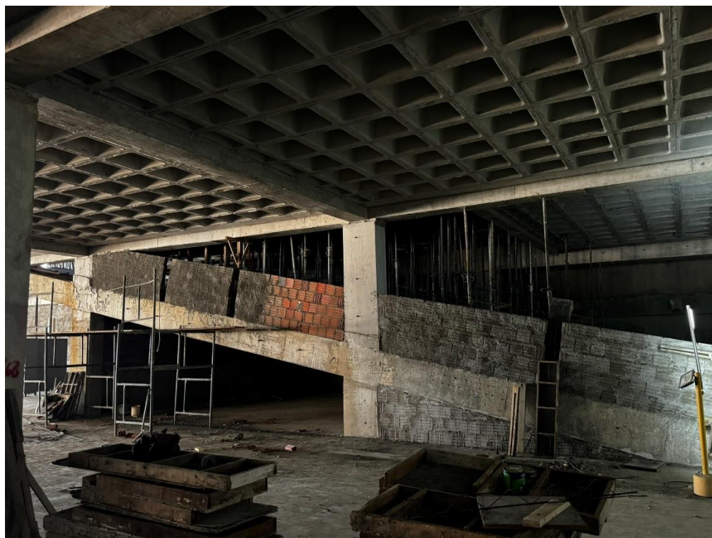
Figura 3. Andaimos para execução de alvenaria.
