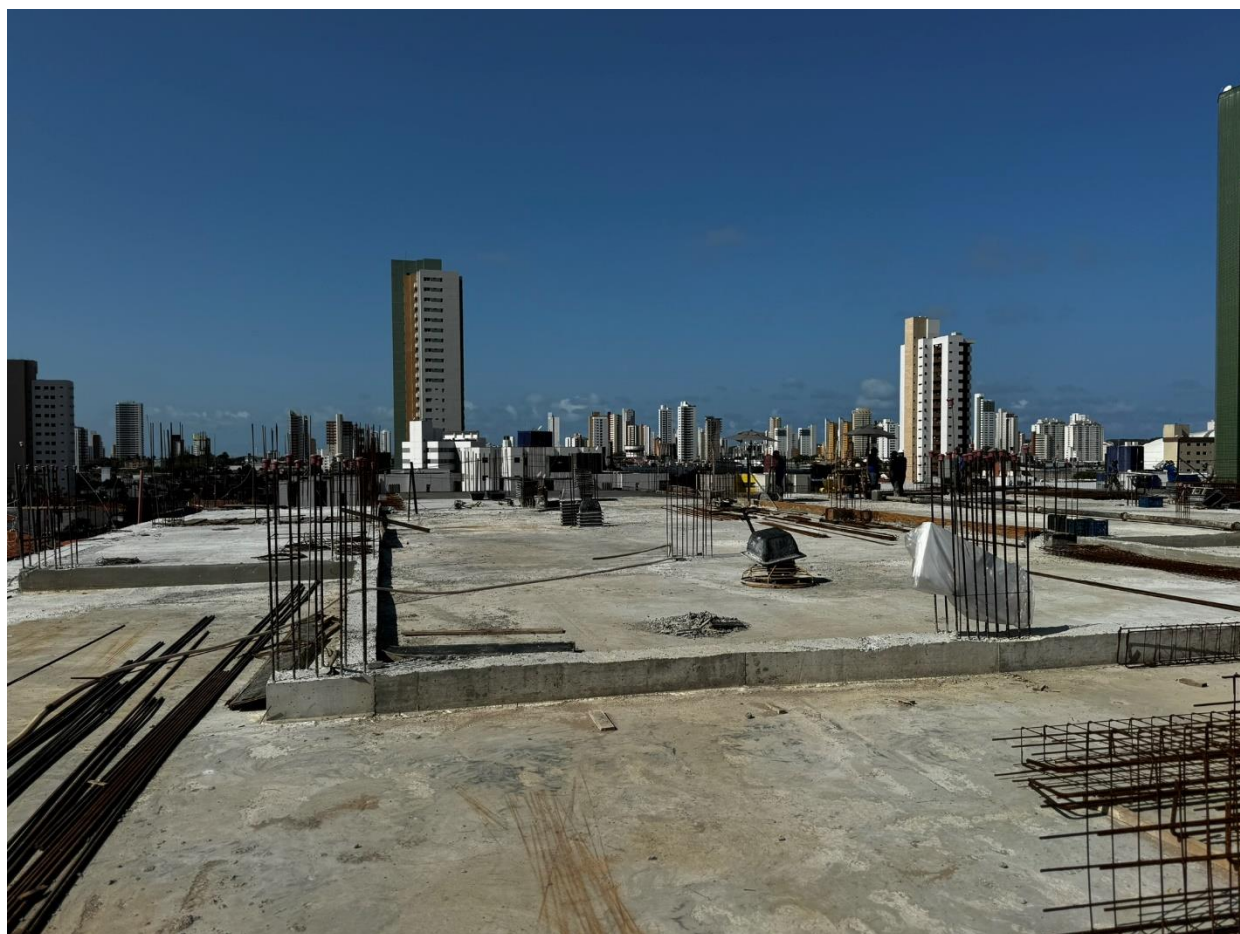
Figura 1. Visão geral da obra.
