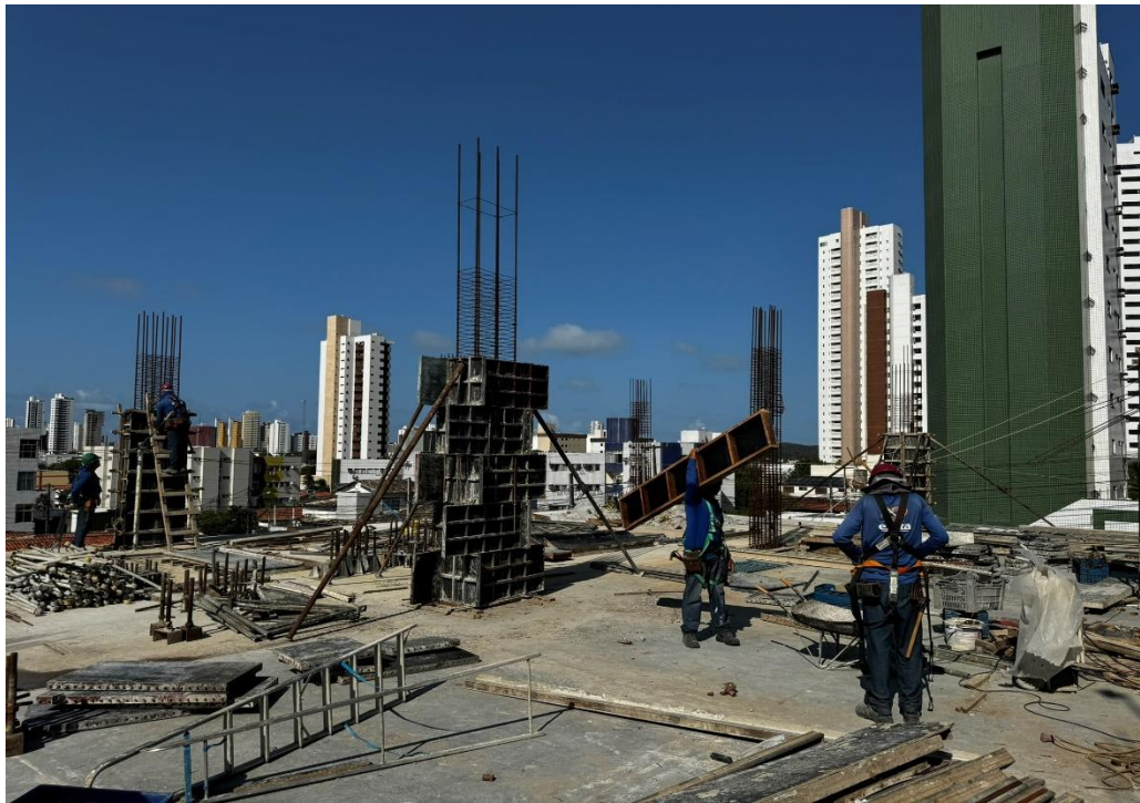
Figura 5. Montagem e desmontagem dos pilares do primeiro subsolo.
