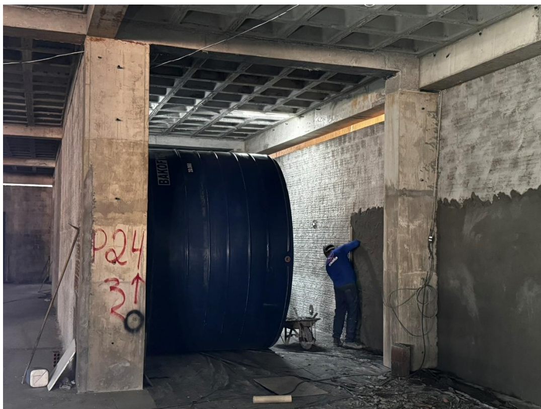
Figura 9. Alvenaria de tijolos cerâmicos no segundo subsolo.
