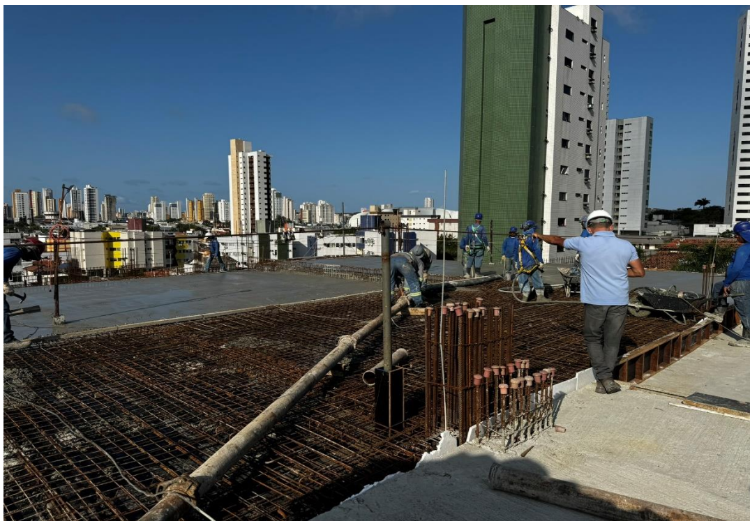
Figura 6. Laje de cobertura do segundo subsolo onde foi concretada a décima primeira etapa.
