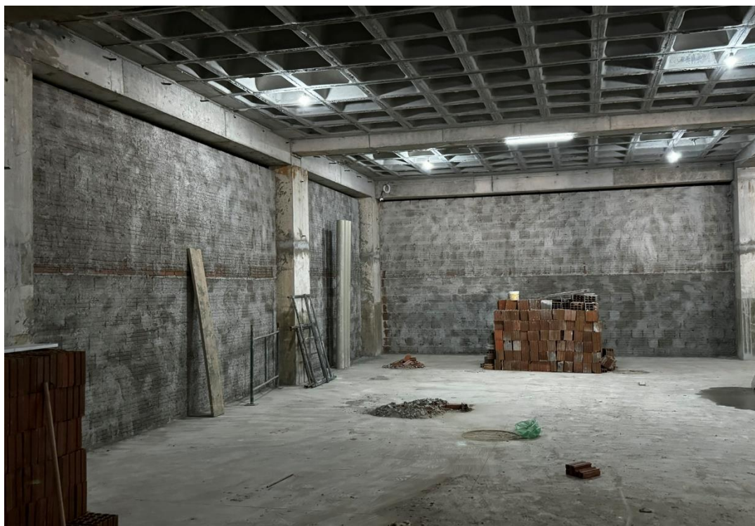
Figura 8. Alvenaria de tijolos cerâmicos no segundo subsolo.
