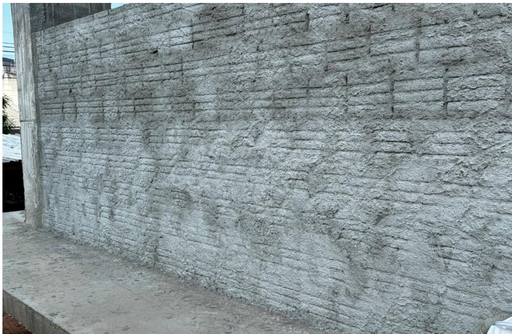
Figura 11. Aplicação de argamassa polimérica nas alvenarias do segundo subsolo.
