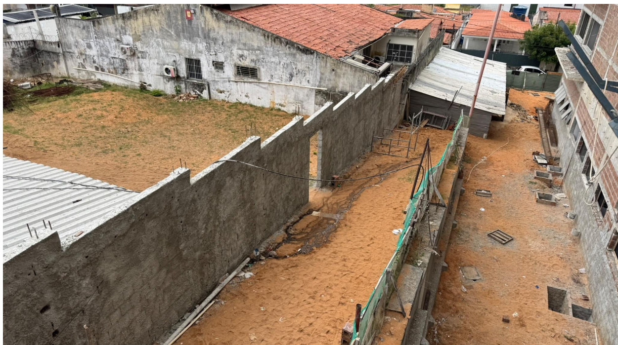
Figura 5. Elevação da alvenaria no muro lateral.
