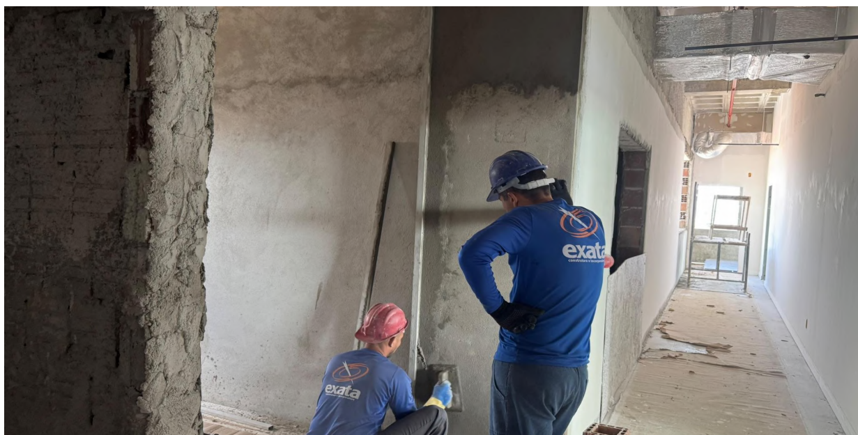
Figura 10. Execução de chapisco e massa única nas paredes internas.
