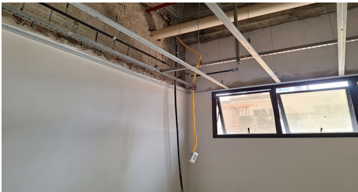
Figura 18. Instalação de conduítes e caixas de tomadas.
