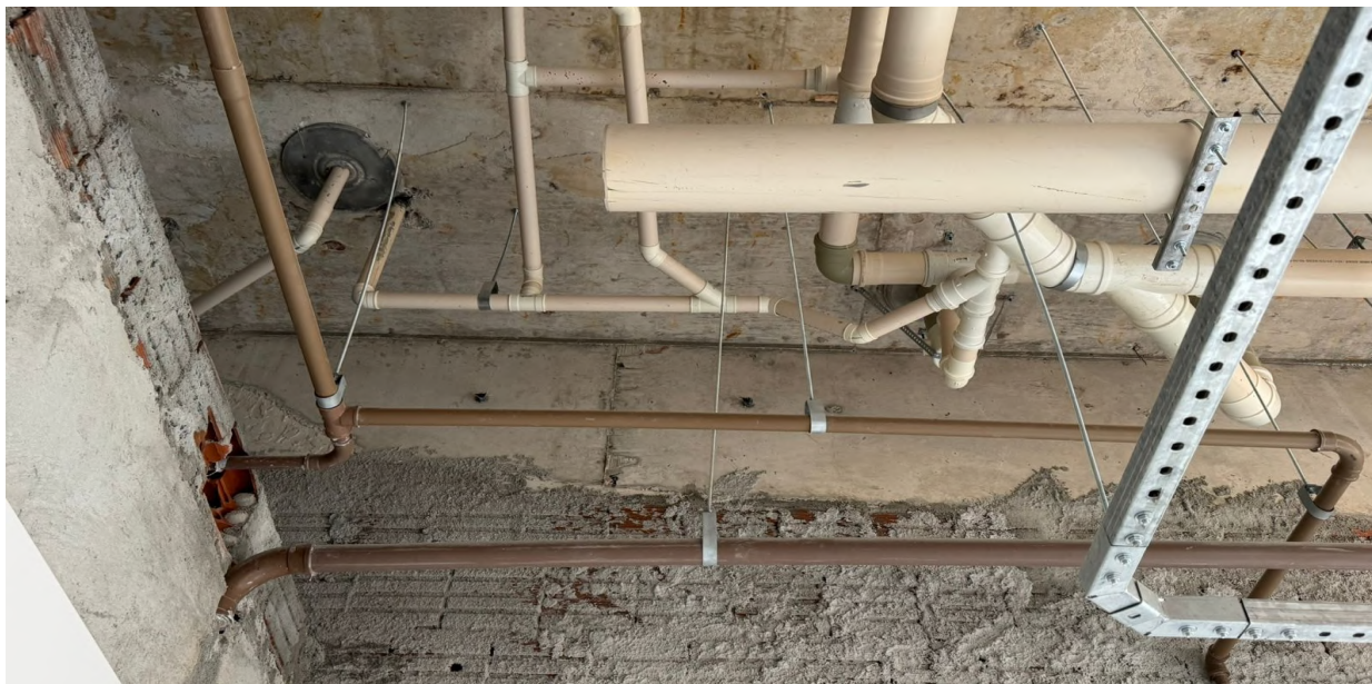
Figura 16. Tubulação de água e esgoto no banheiro coletivo do pavimento semienterrado 1.
