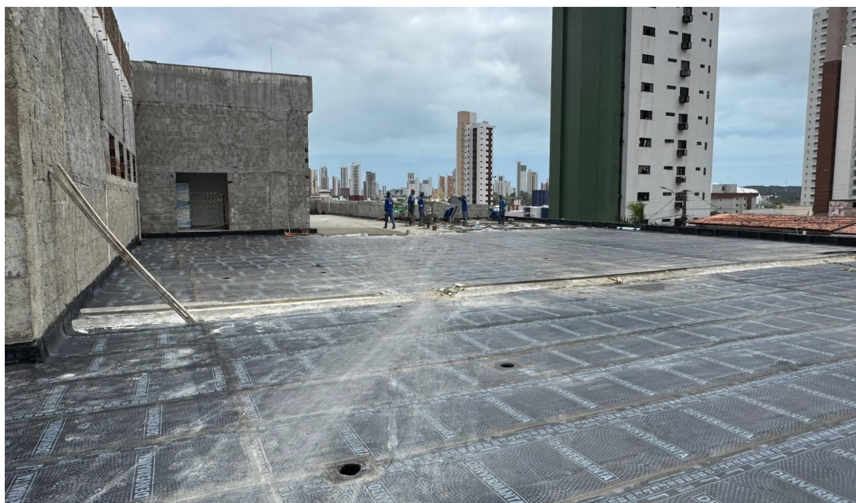
Figura 13. Execução de manta asfáltica dupla na laje do térreo...
