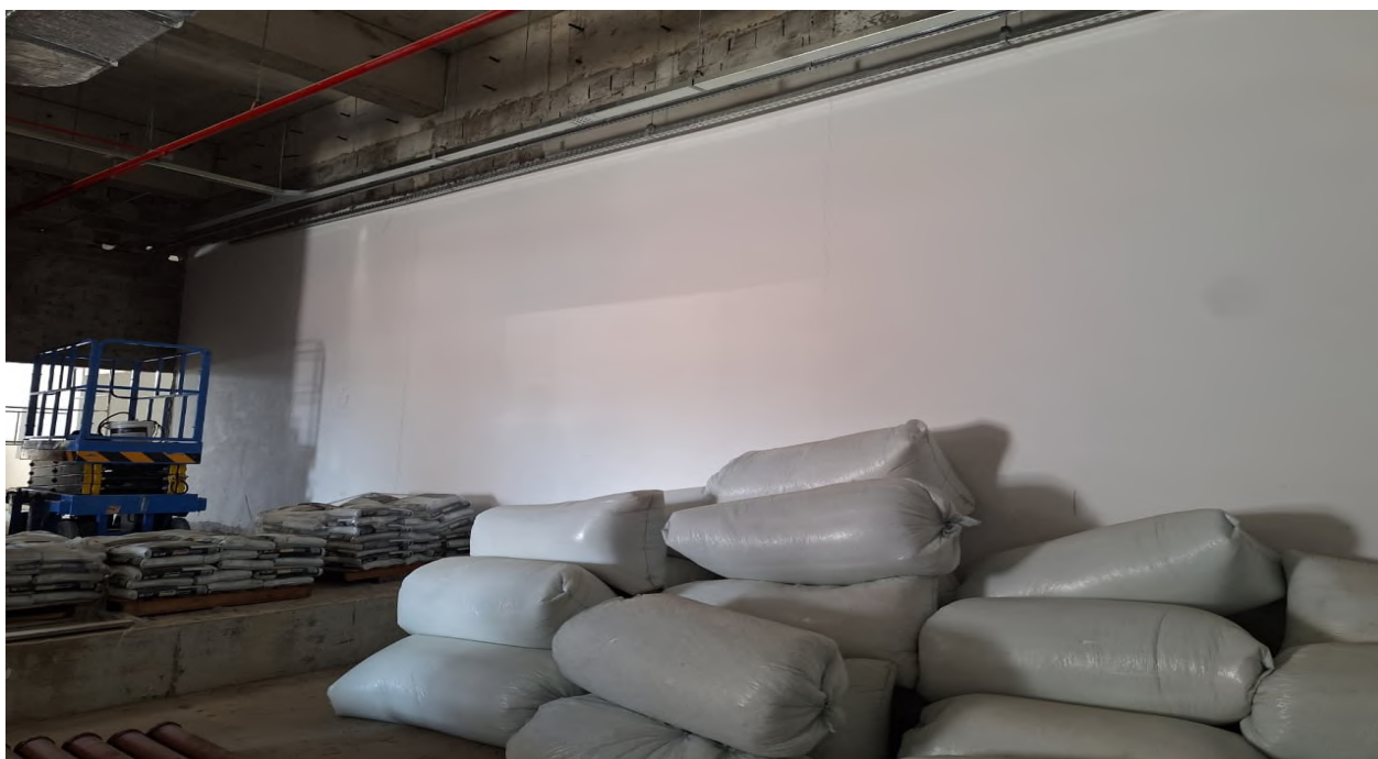
Figura 11. Paredes com aplicação de selador acrílico e massa corrida nas paredes do auditório no pavimento térreo.
