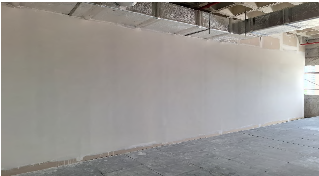
Figura 3. Instalação de paredes Drywall no segundo pavimento.
