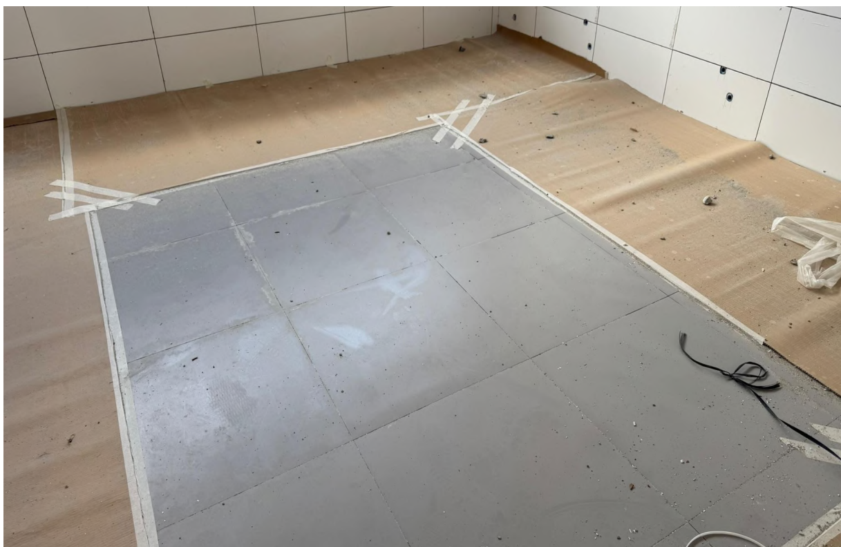
Figura 6. Instalação do piso dos banheiros coletivos no 1º pavimento, piso parcialmente protegido pelo salva piso..
