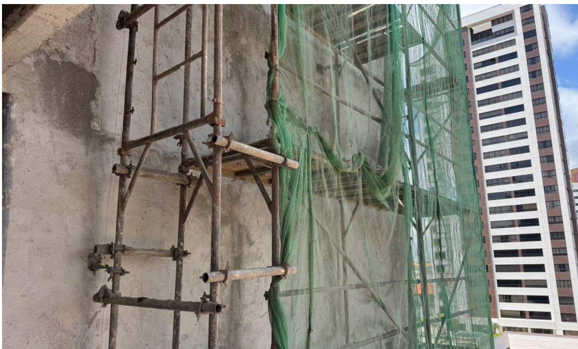
Figura 11. Execução de emboço na fachada.
