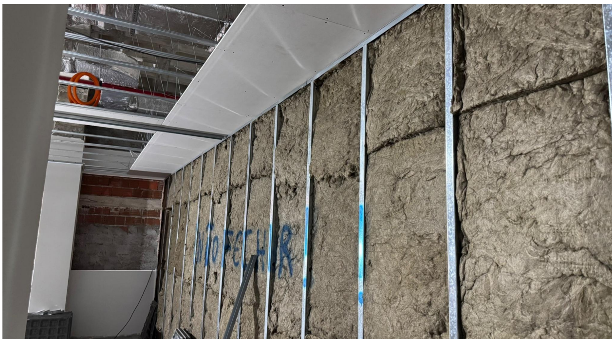
Figura 4. Instalação de lã de rocha em paredes Drywall no pavimento térreo.
