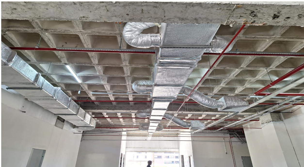
Figura 20. Instalação de tubulação dos ares-condicionados no pavimento térreo.
