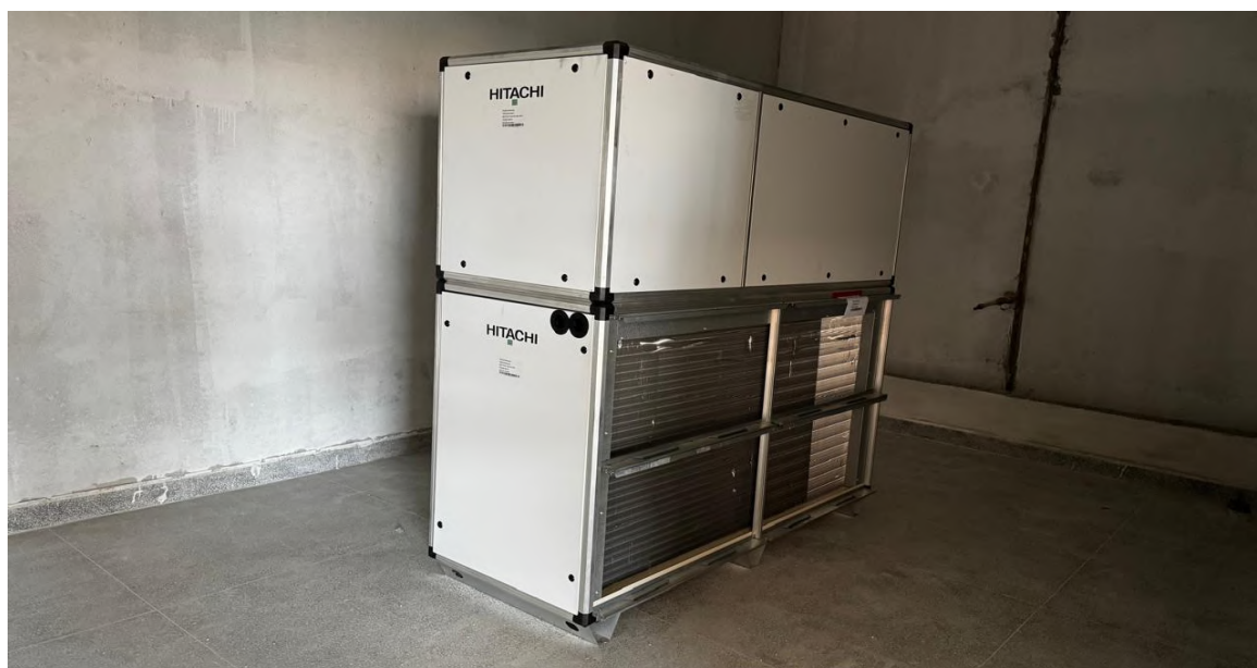
Figura 19. Instalação dos fancoils nas salas.
