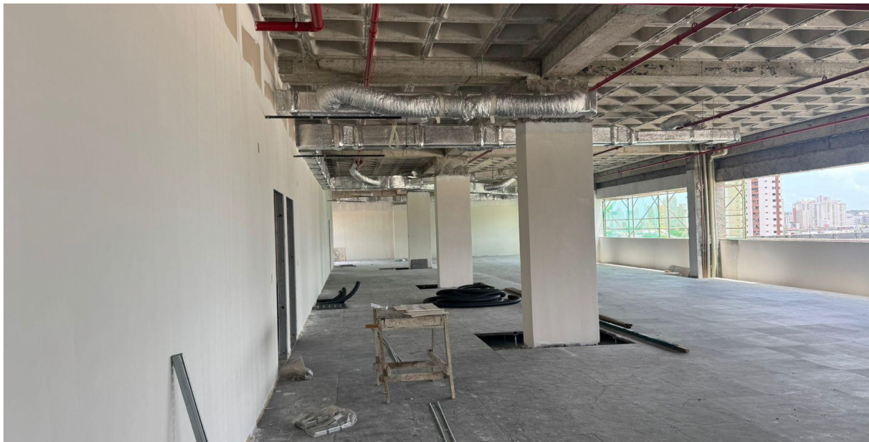
Figura 9. Instalação de piso elevado no primeiro pavimento.
