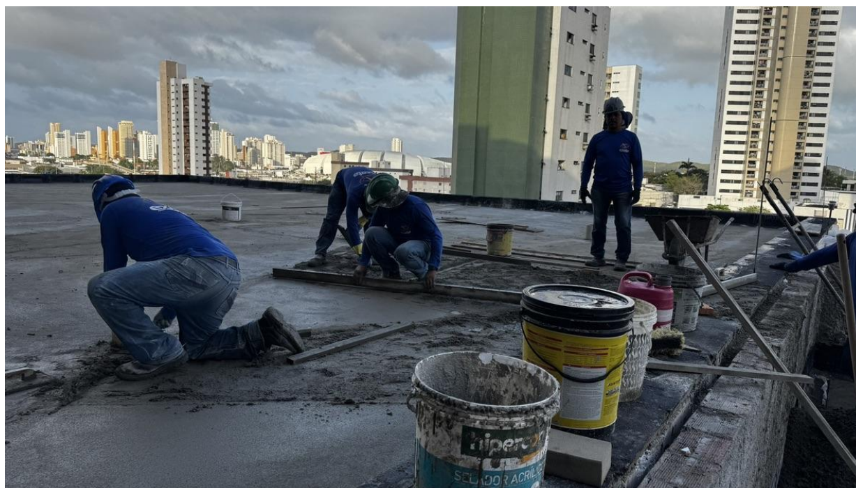
Figura 15. Execução de proteção mecânica para a manta da cobertura do auditório.
