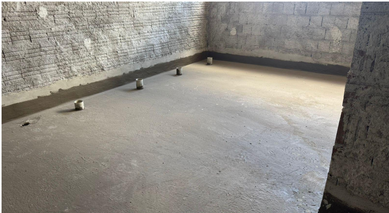
Figura 14. Execução de impermeabilização no piso dos banheiros coletivos.
