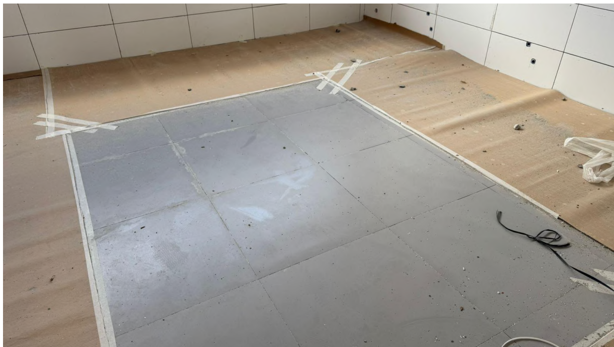
Figura 2. Instalação de Salva piso para proteção do porcelanato.
