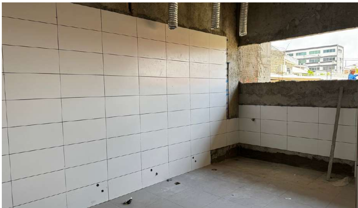
Figura 11. Execução de revestimento cerâmicos 30 x 60cm.
