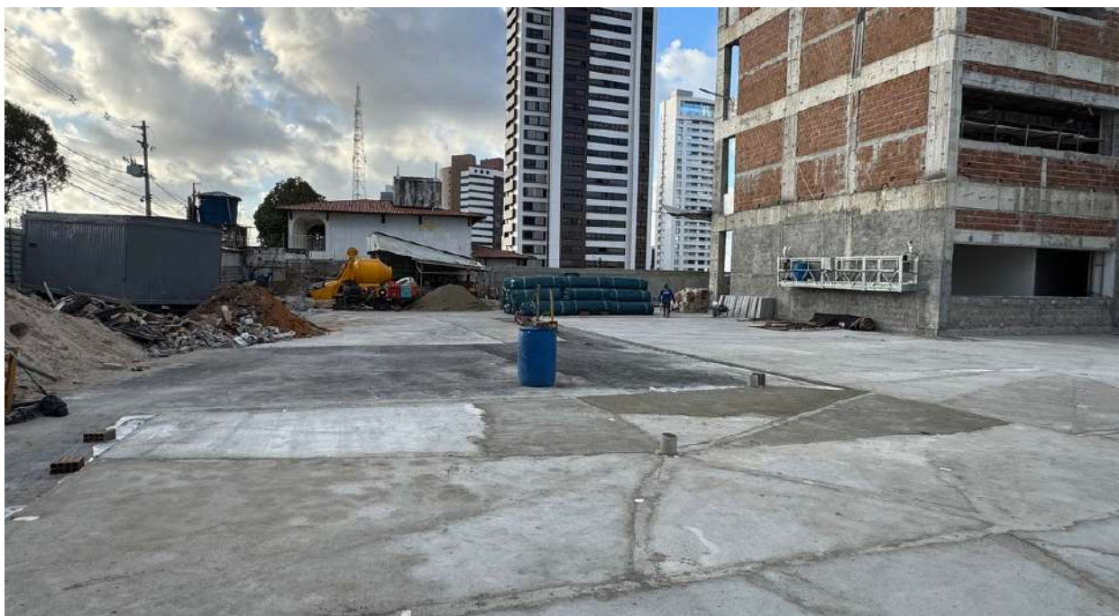
Figura 14. Execução de manta dupla na laje do térreo.
