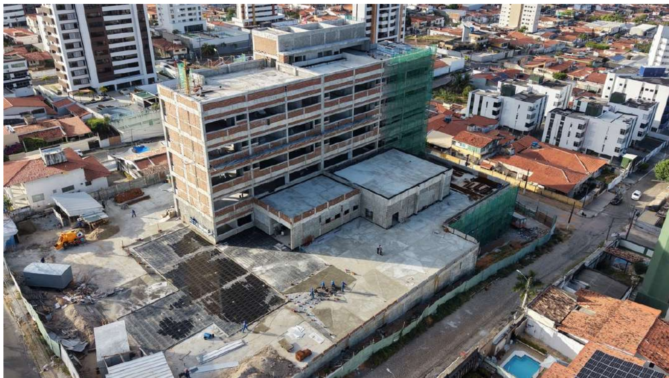
Figura 1. Visão geral da obra.
