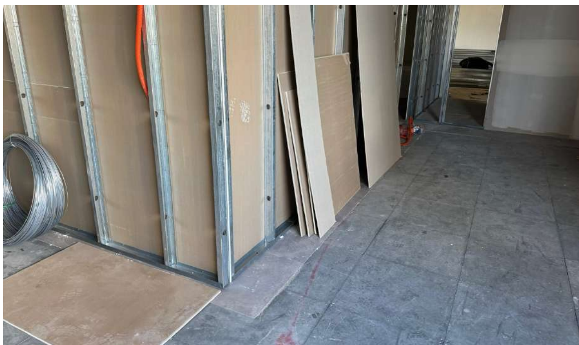
Figura 8. Instalação do piso vinílico anteriormente a instalação das paredes drywall no pavimento térreo.
