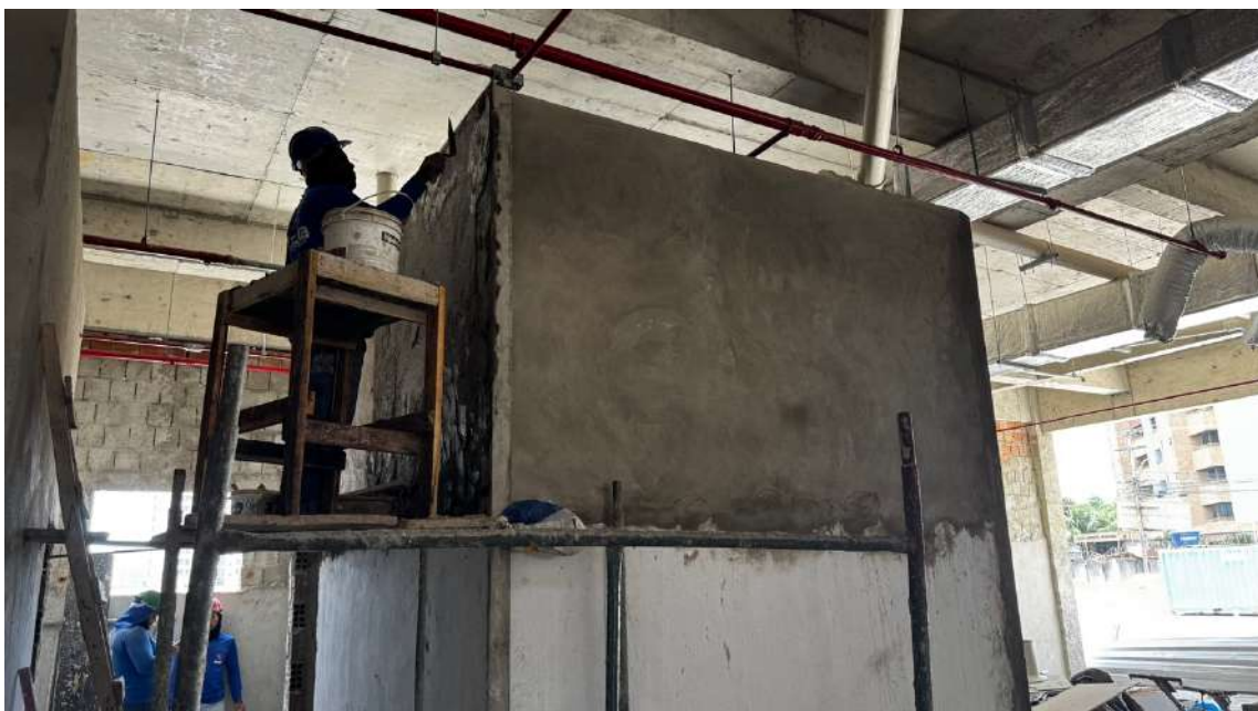
Figura 10. Execução de chapisco e massa única nas paredes internas dos banheiros do térreo.
