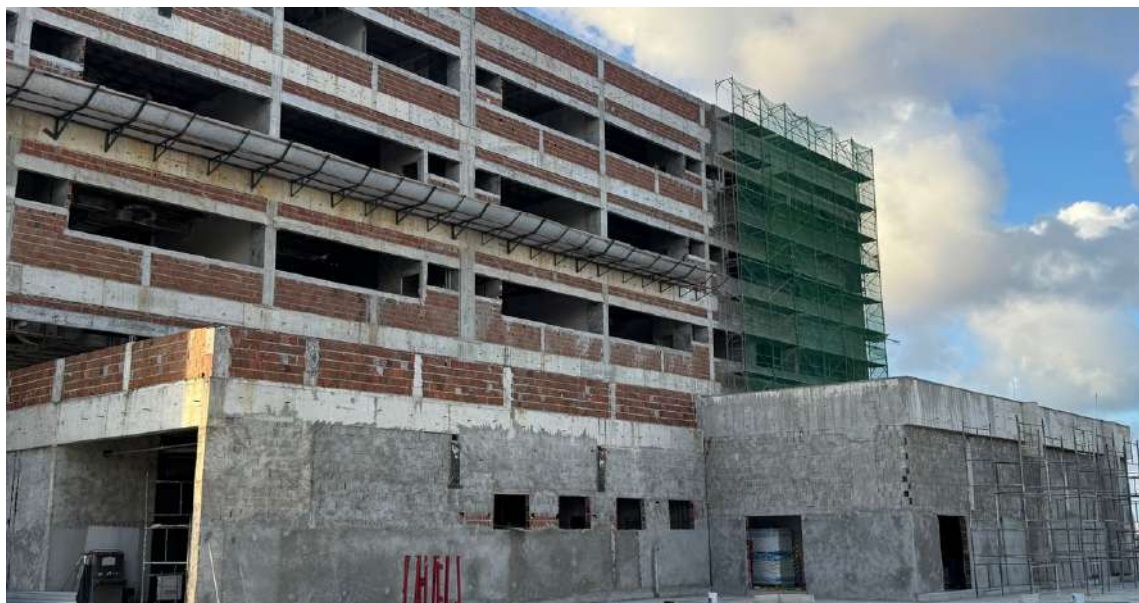
Figura 5. 4º pavimento como toda a alvenaria do perímetro finalizada.
