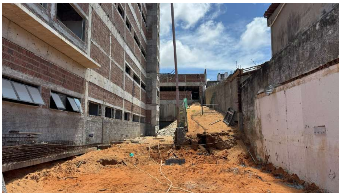
Figura 2. Parede lateral da obra e local a ser instalado a casa do lixo.
