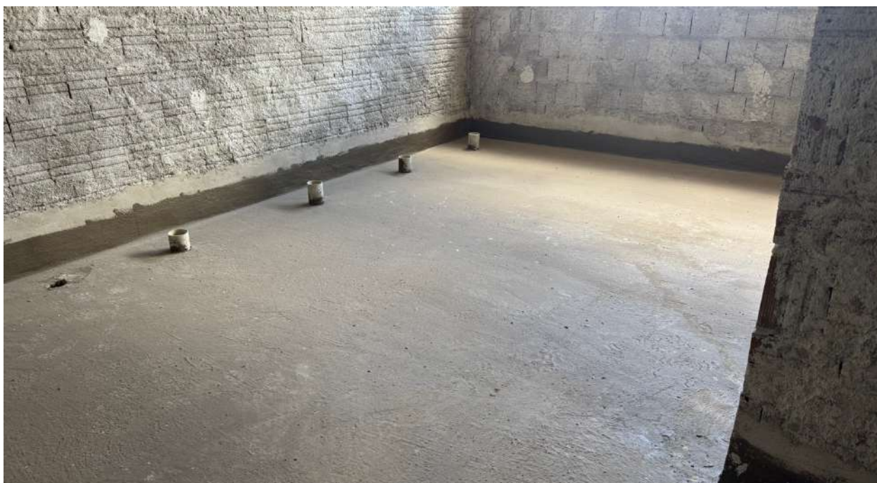
Figura 15. Execução de impermeabilização no piso dos banheiros coletivos.
