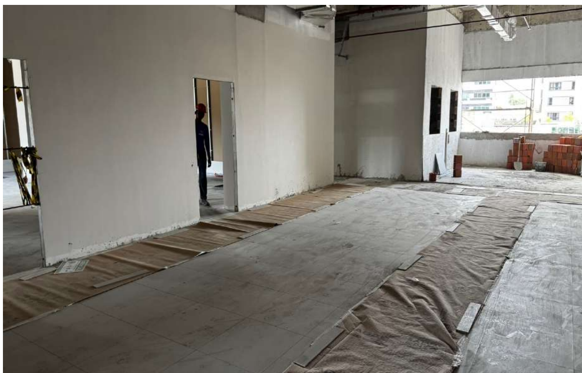
Figura 12. Execução de massa corrida nas paredes drywall.
