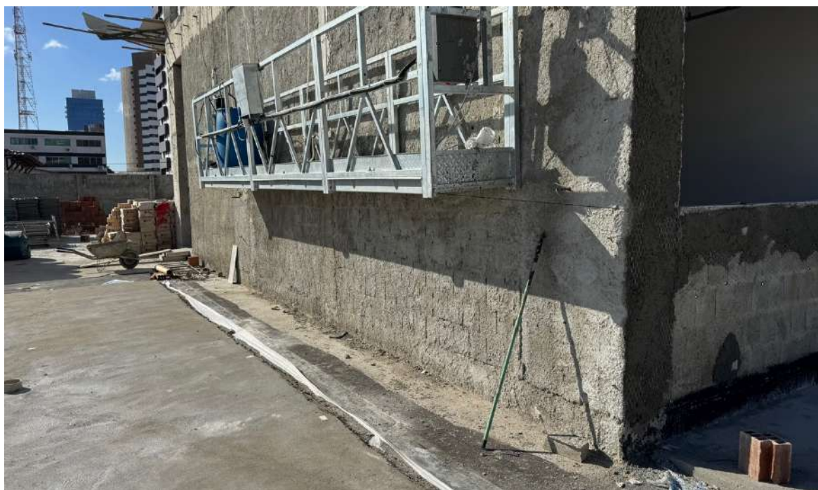
Figura 13. Execução de proteção mecânica para manta asfáltica dupla na laje do térreo.
