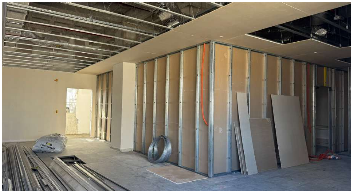
Figura 3. Instalação de paredes Drywall no pavimento térreo.
