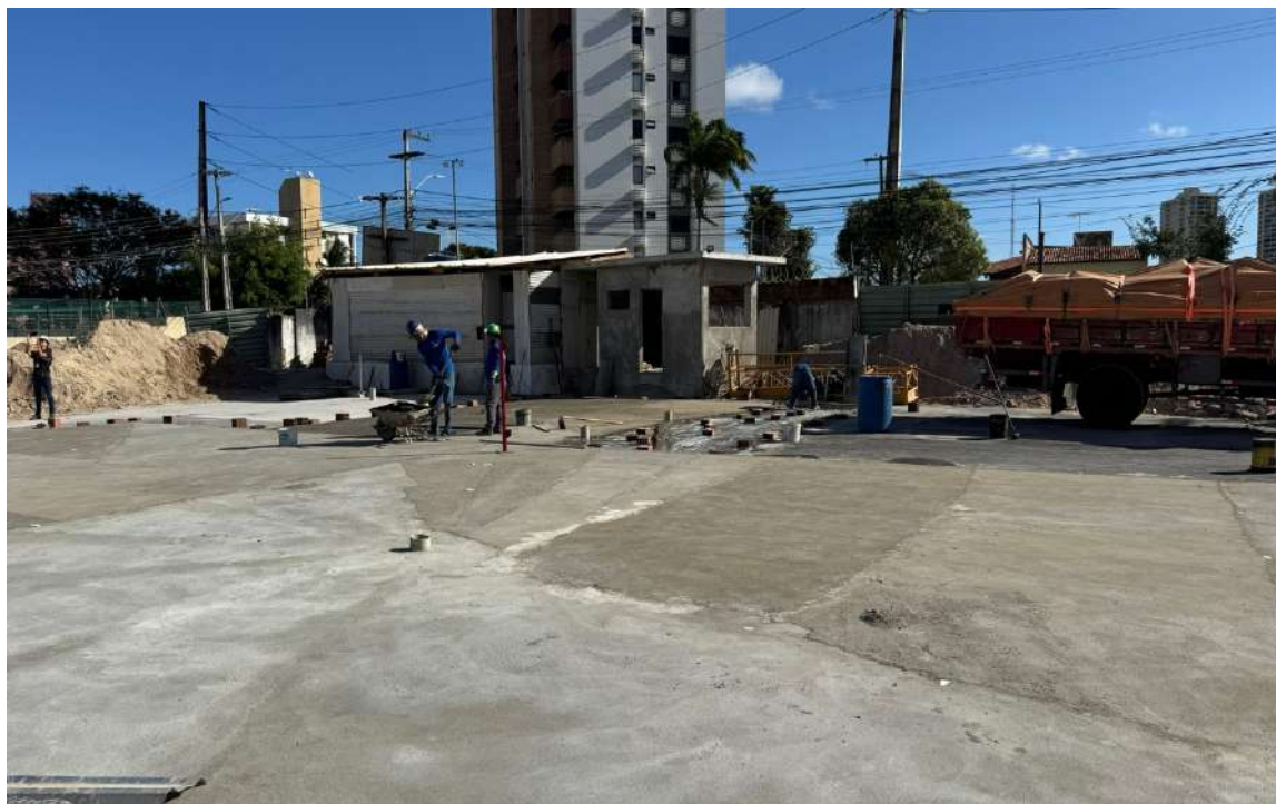
Figura 12. Execução de proteção mecânica para manta asfáltica dupla na laje do térreo.
