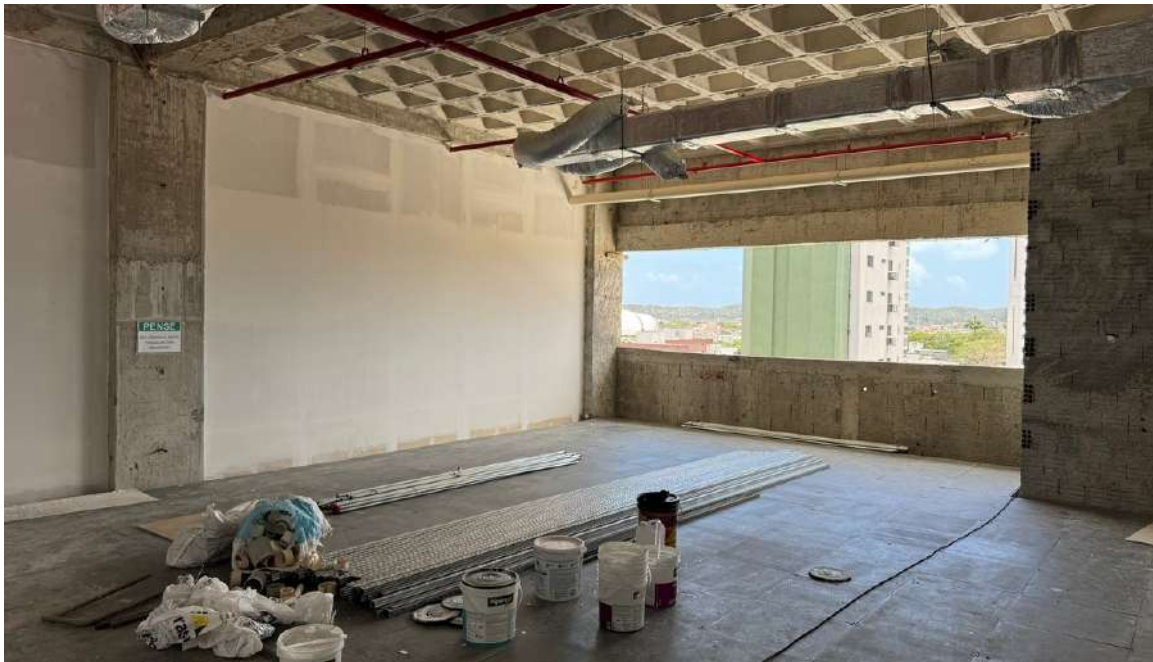
Figura 9. Instalação de piso elevado no segundo pavimento.
