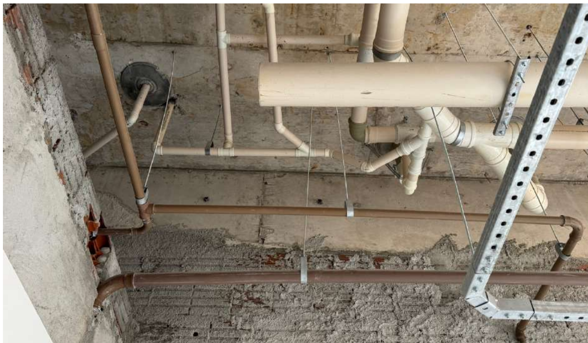
Figura 16. Execução de tubulações de esgoto sanitário e água fria.
