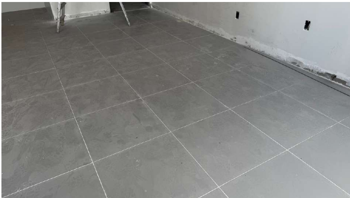
Figura 7. Instalação do piso no em frente aos elevadores no 2º pavimento.
