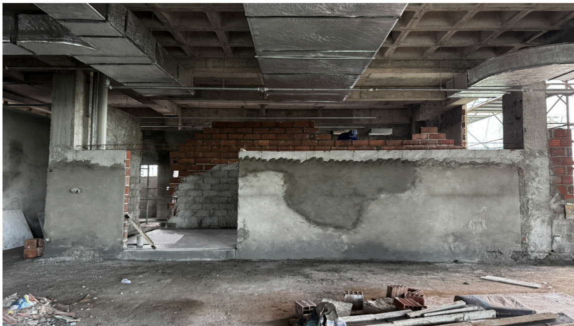
Figura 8. Execução de alvenaria com tijolos de 19cm de espessura nas salas dos fans coils.
