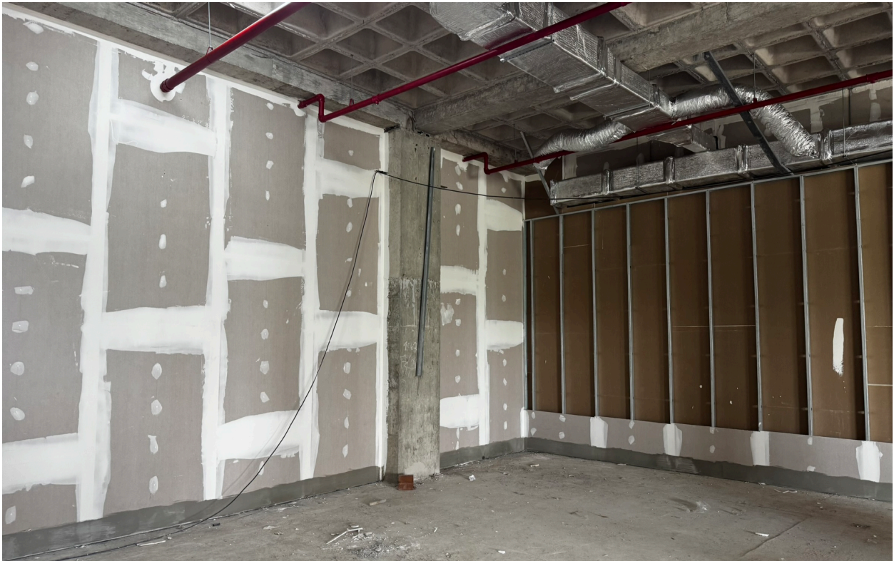
Figura 5. Instalação de paredes Drywall com aplicação de lan de rocha entre paredes.
