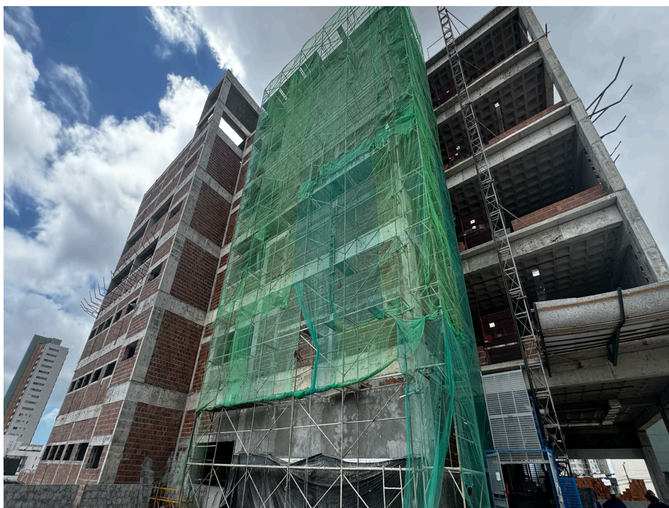
Figura 2. Andaime fachadeiro e instalação de tela de proteção.
