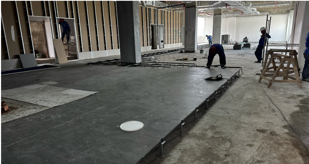
Figura 6. Instalação de piso elevado no pavimento térreo.
