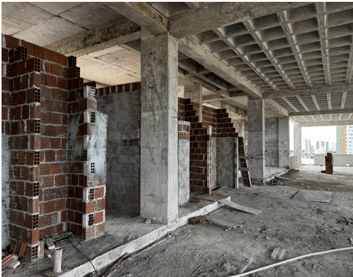
Figura 4. Elevação das alvenarias dos banheiros coletivos do pavimento 3.
