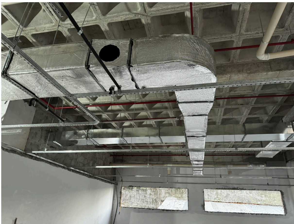
Figura 9. Instalação de eletrocalhas para passagem das fiações.
