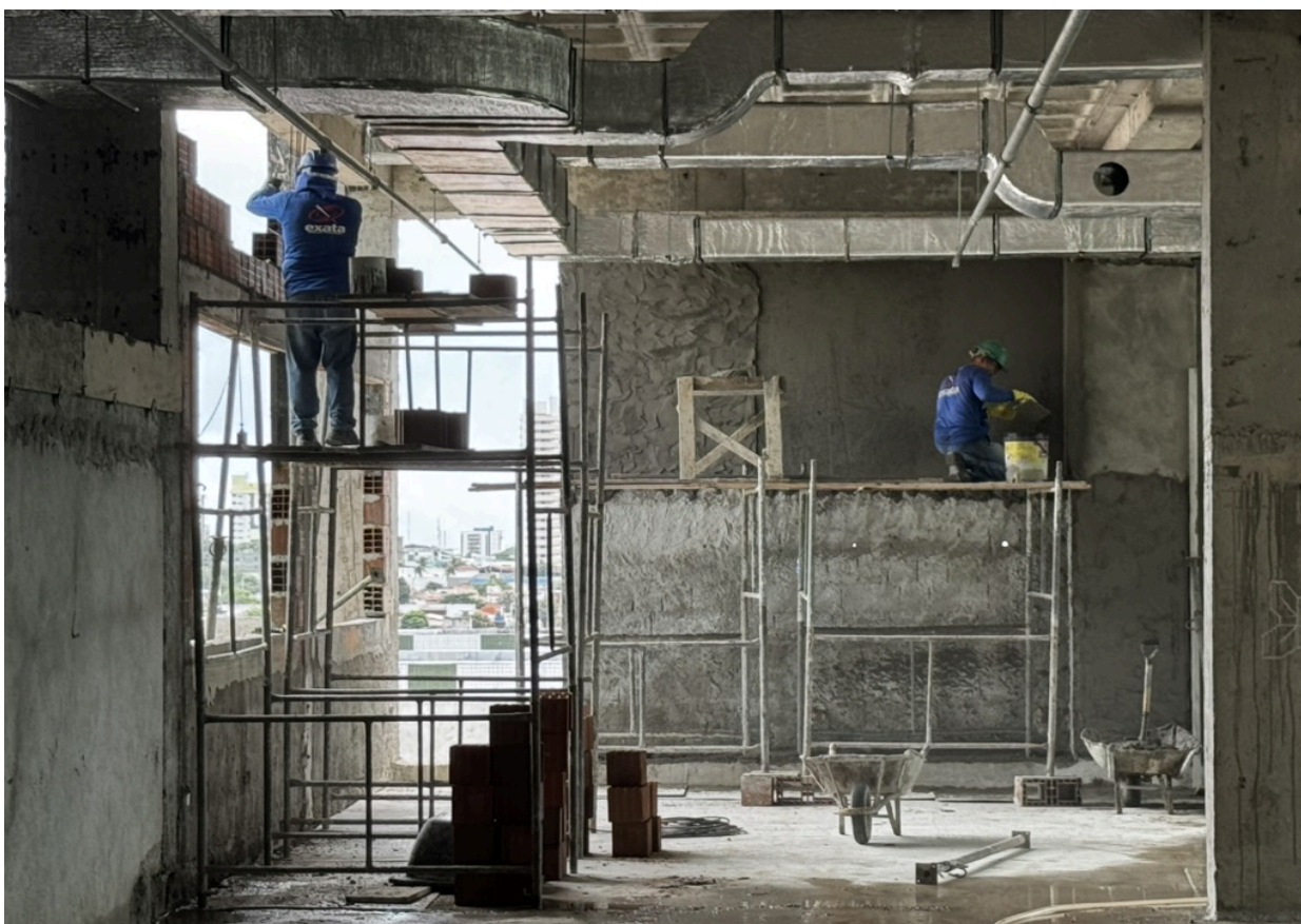
Figura 7. Execução de alvenaria com tijolos 14 x 9 x 19cm nas paredes externas, terceiro pavimento.
