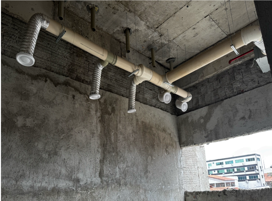
Figura 17. Instalação de tubulação e grelhas em PVC para o sistema de exaustão dos banheiros.
