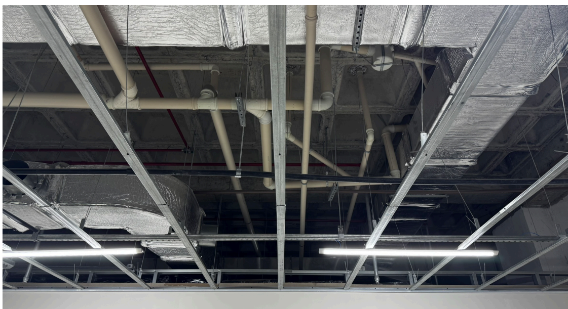
Figura 8. Tubulação de esgoto instalada no pavimento semienterrado 2.
