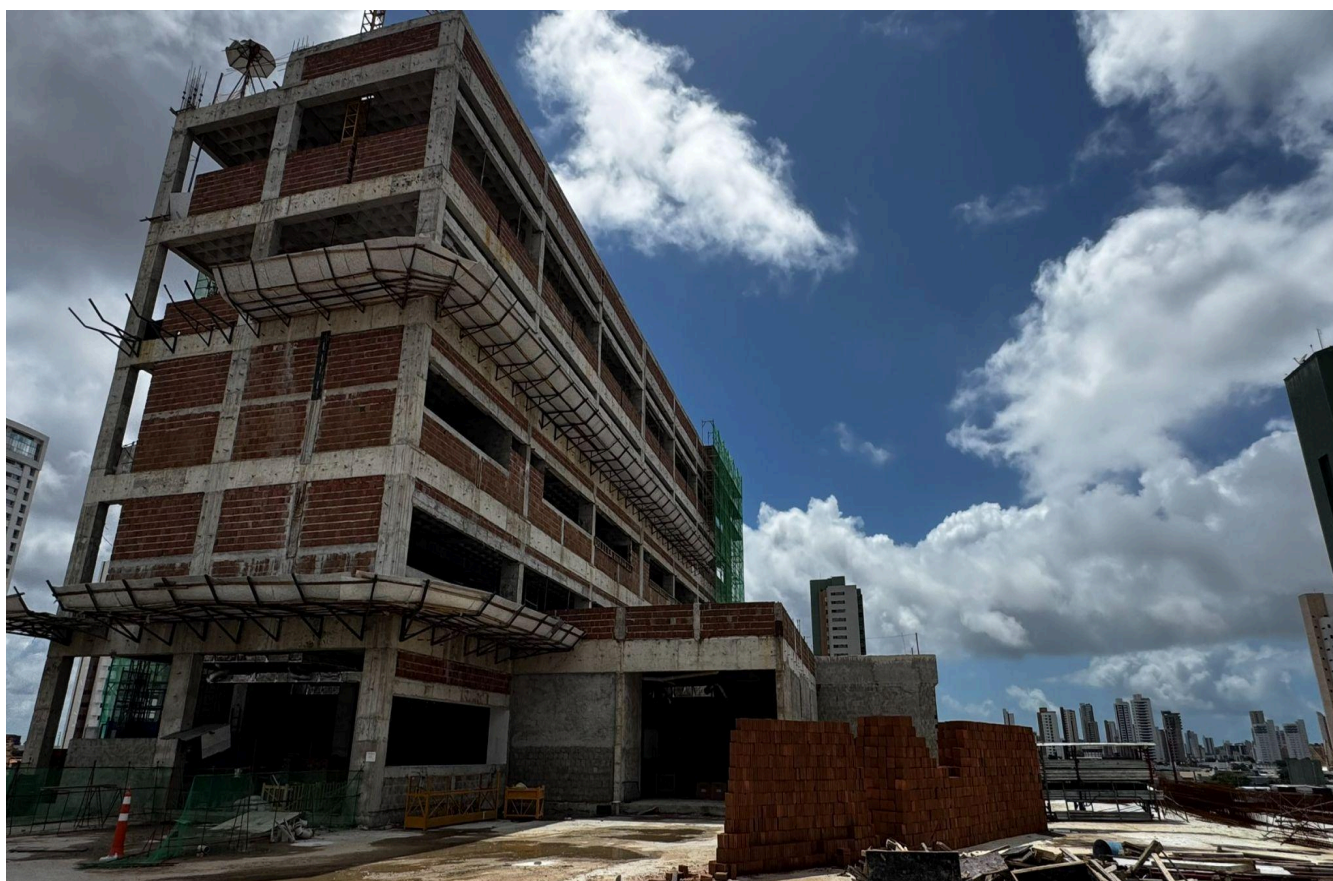
Figura 1. Visão geral da obra.
