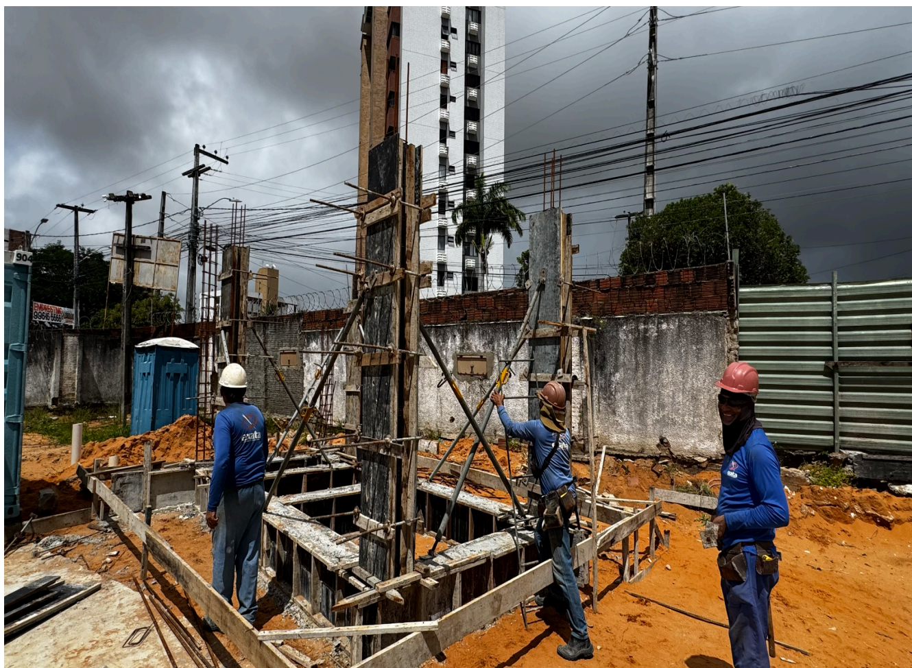
Figura 3. concretagem dos pilares da estrutura da guarita.
