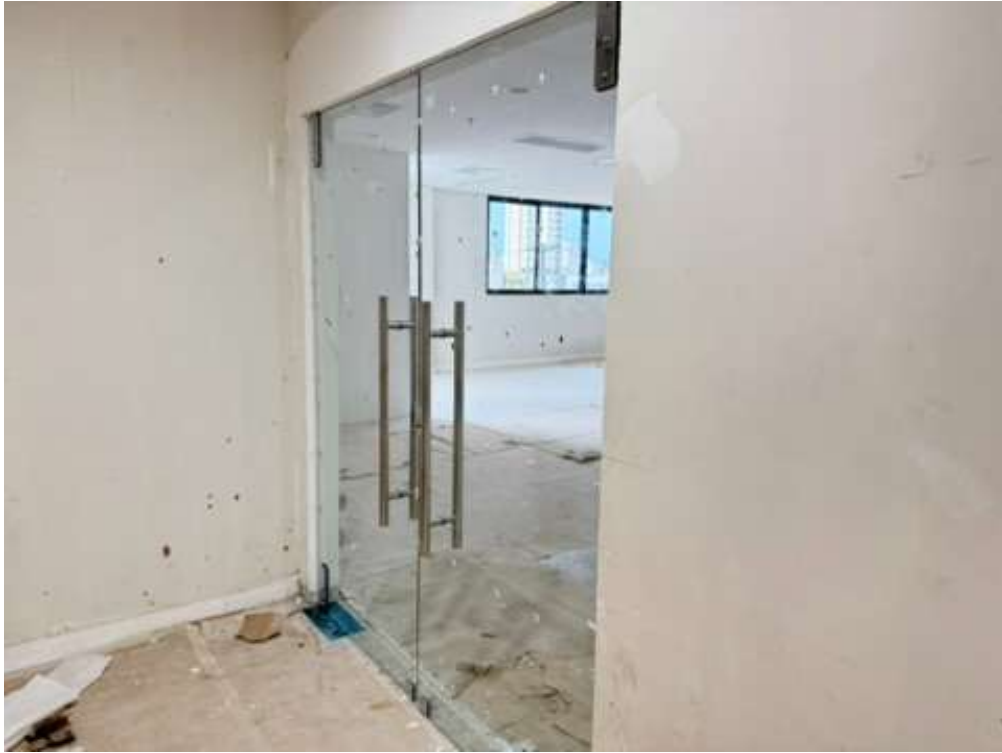
Figura 16 Instalação da porta de vidro no refeitório.
