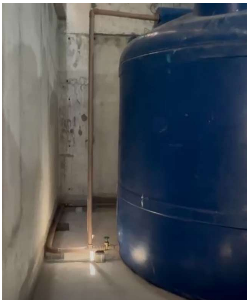
Figura 24 Instalação dos flanges nos reservatórios superiores.
