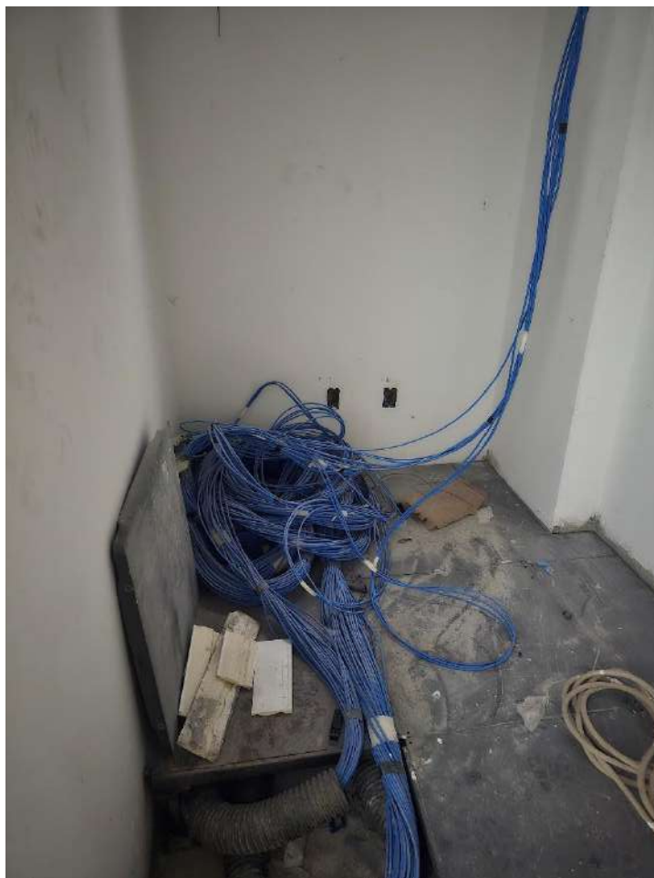
Figura 38 - Cabeamento Estruturado. Instalação de cabos UTP na sala de racks.
