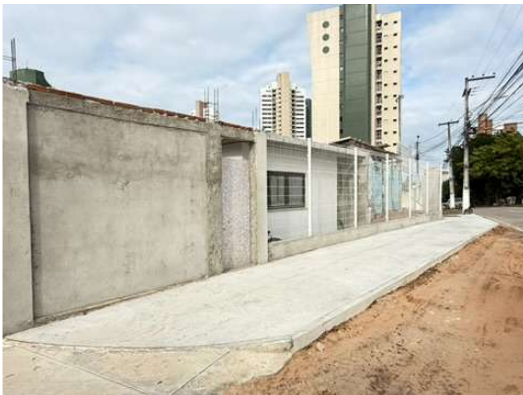
Figura 23 Execução da calçada de concreto e gradil na entrada principal.
