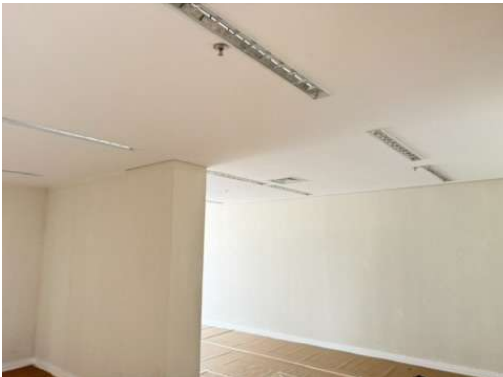
Figura 19 Aplicação de selador acrílico em paredes..
