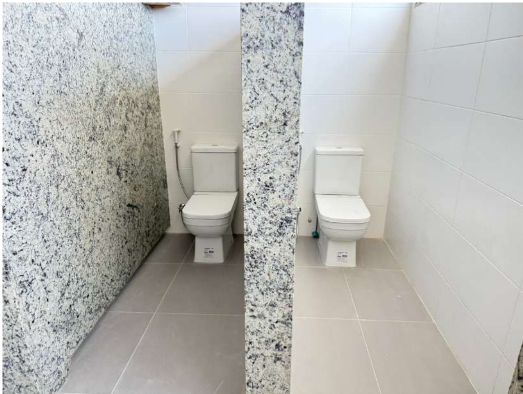
Figura 3. Instalação do piso porcelanato nos banheiros coletivos.
