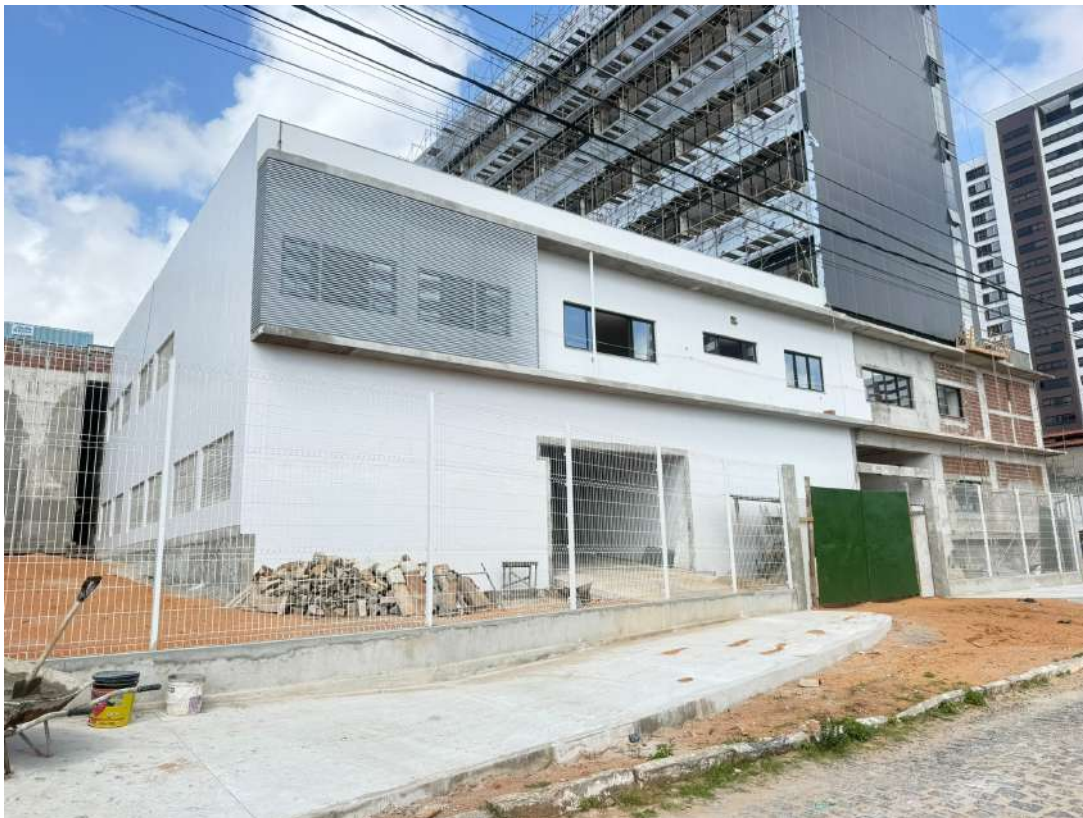
Figura 10 Início da instalação do Brise na fachada norte.
