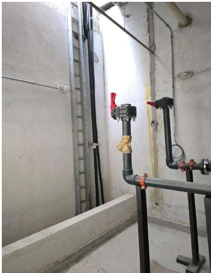
Figura 40 - Ligações típicas Fancoil
