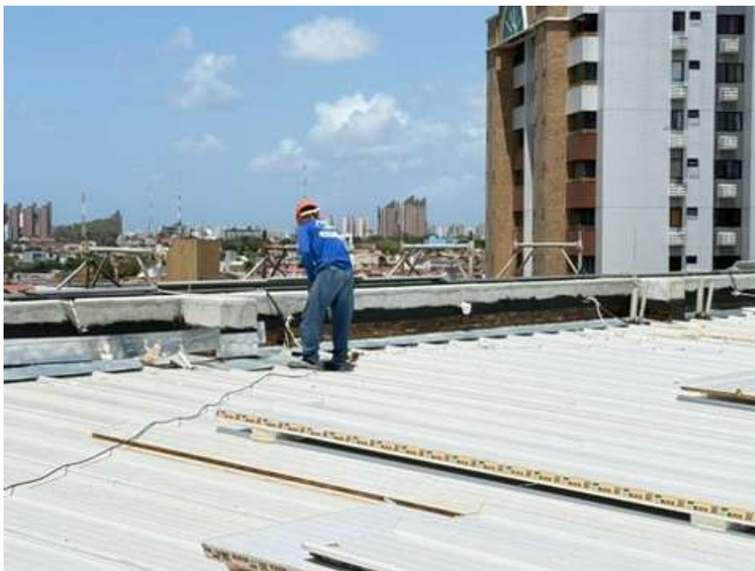
Figura 13 - Aplicação rufo em alumínio na cobertura.
