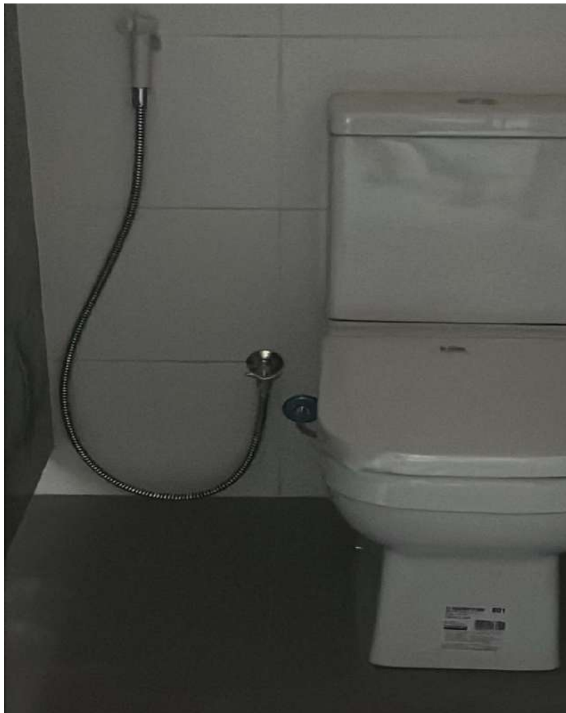
Figura 25 Instalação das duchas higiênicas.
