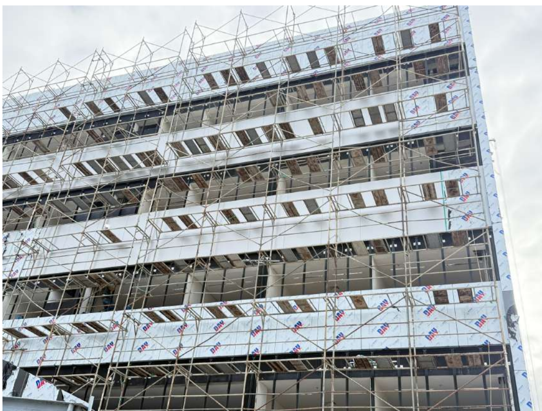
Figura 9 Instalação do ACM na fachada frontal da edificação.
