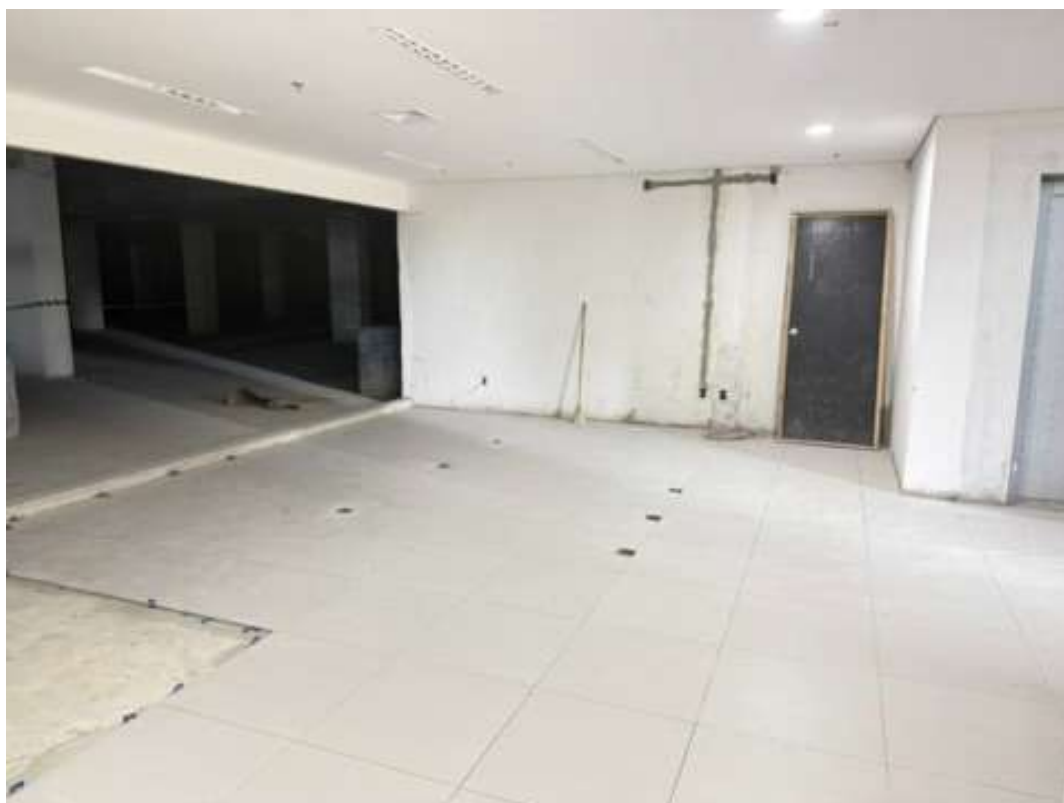
Figura 11 - Aplicação do forro drywall na recepção do pavimento semienterrado 1.
