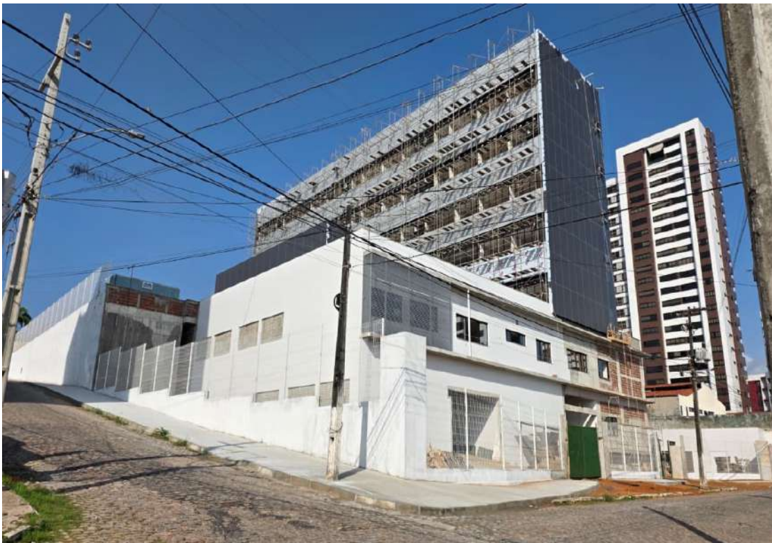
Figura 8 Instalação do ACM na fachada frontal e lateral sul da edificação.
