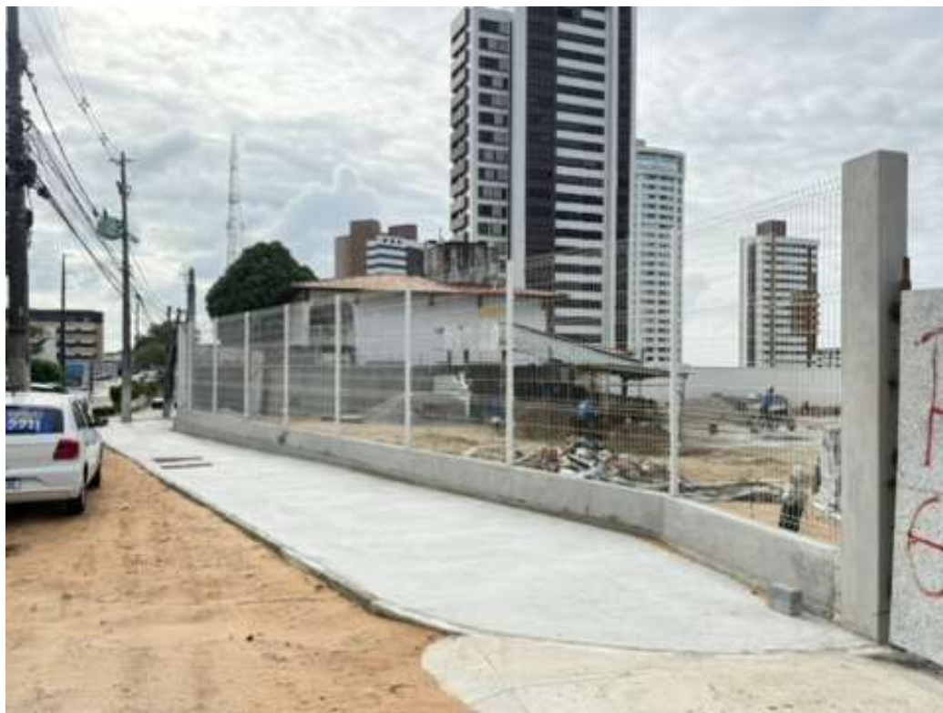
Figura 22 Execução da calçada de concreto e gradil na entrada principal.
