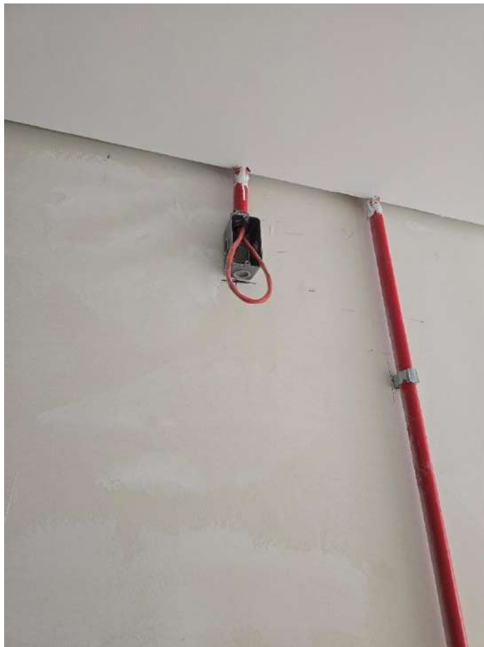
Figura 26 – Pintura dos tubos com esmalte sintético.
