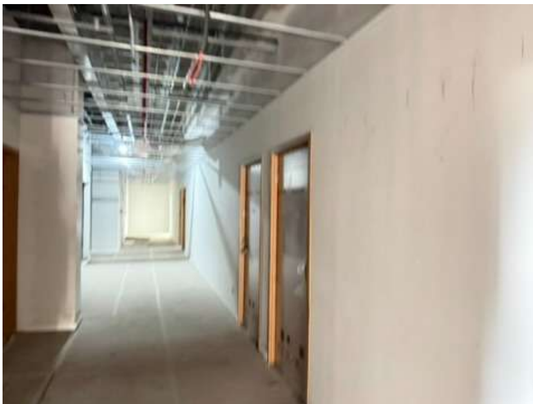
Figura 12 - Aplicação de estrutura para recebimento do forro drywall no corredor do pavimento semienterrado 1.
