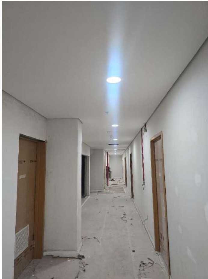
Figura 36 Instalação das luminárias em LED circulares.
