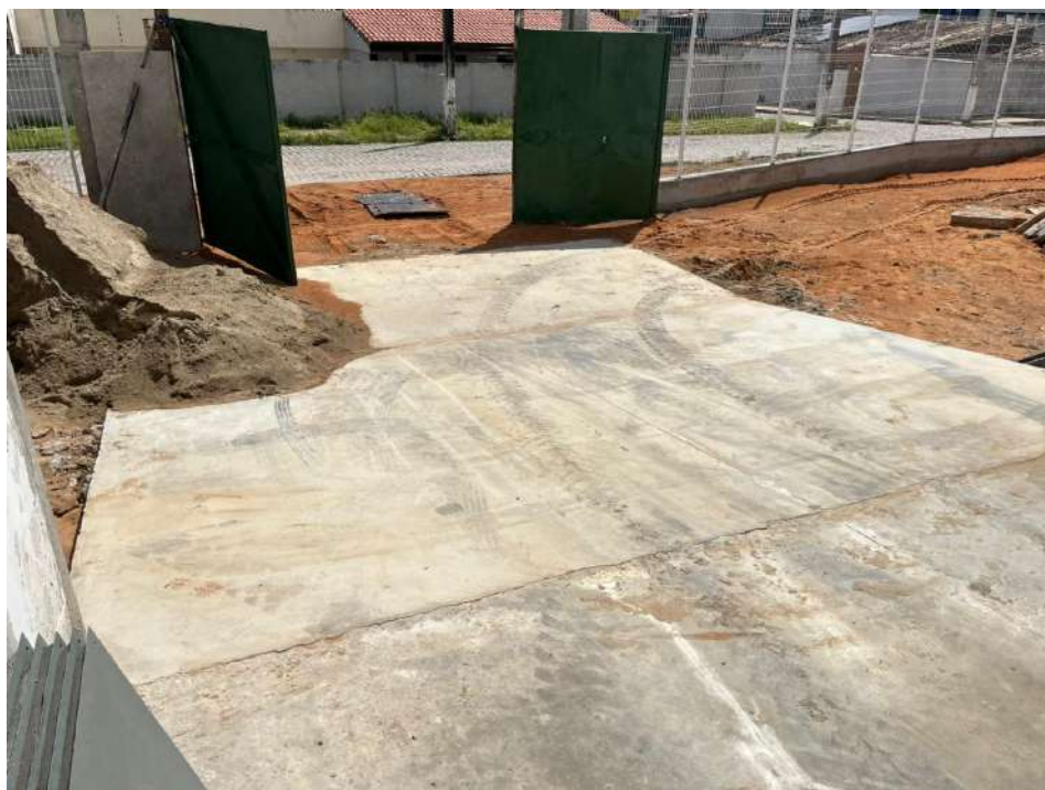
Figura 2. Execução da rampa de saída dos veículos no pavimento semienterrado 2.
