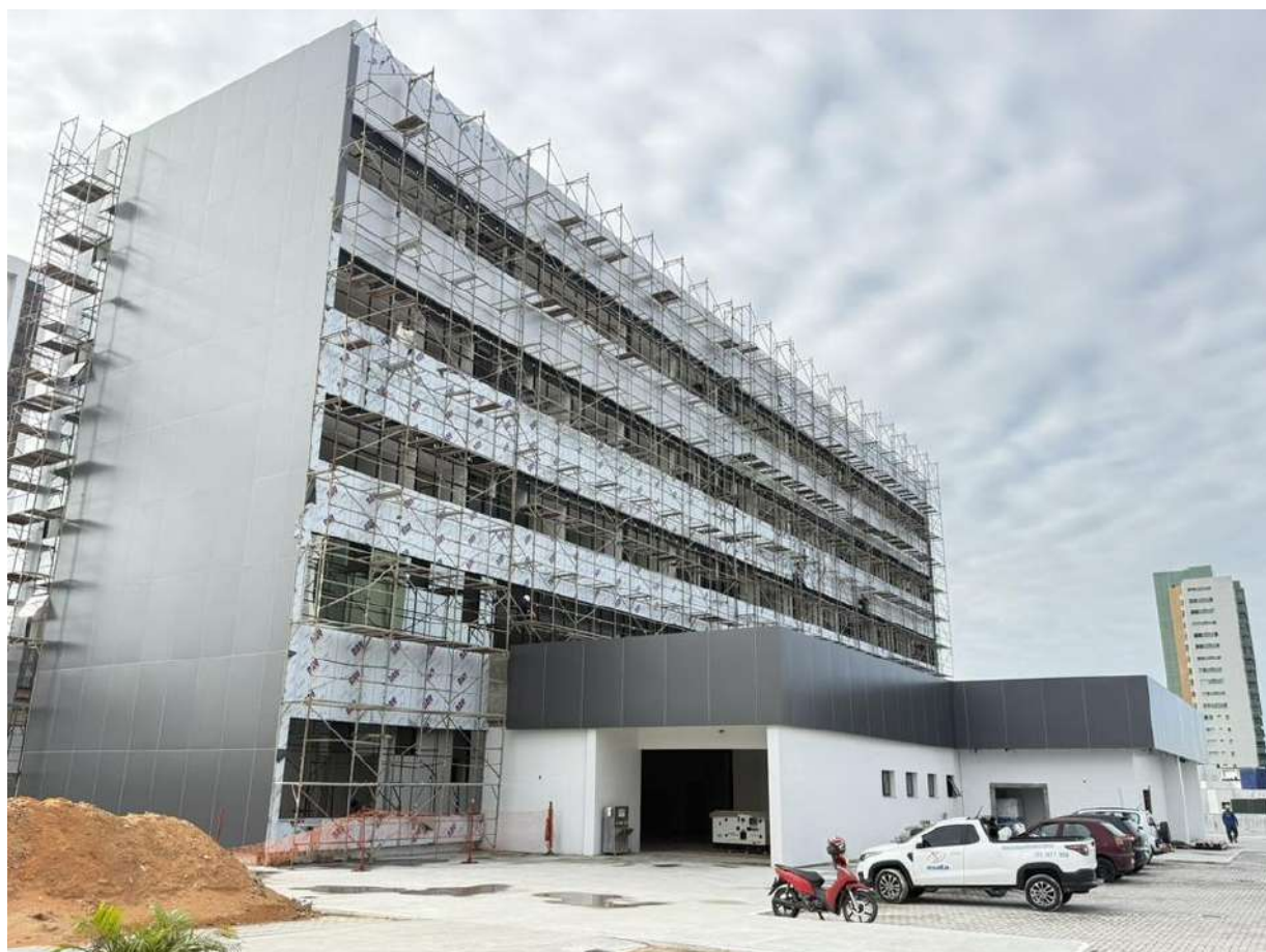
Figura 1. Visão geral da obra.
