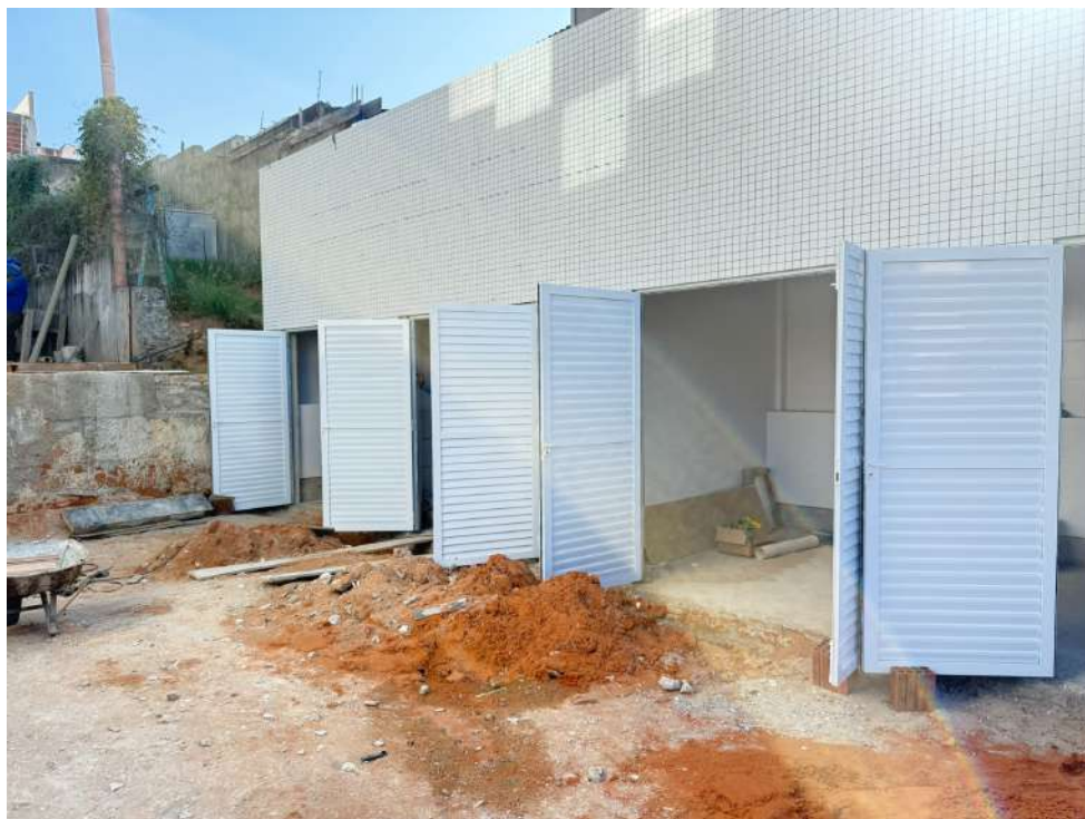
Figura 15 - Instalação das portas de alumínio na casa do lixo.
