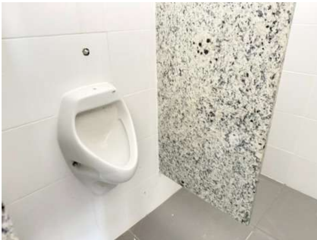
Figura 20 Instalação dos mictórios nos banheiros coletivos.
