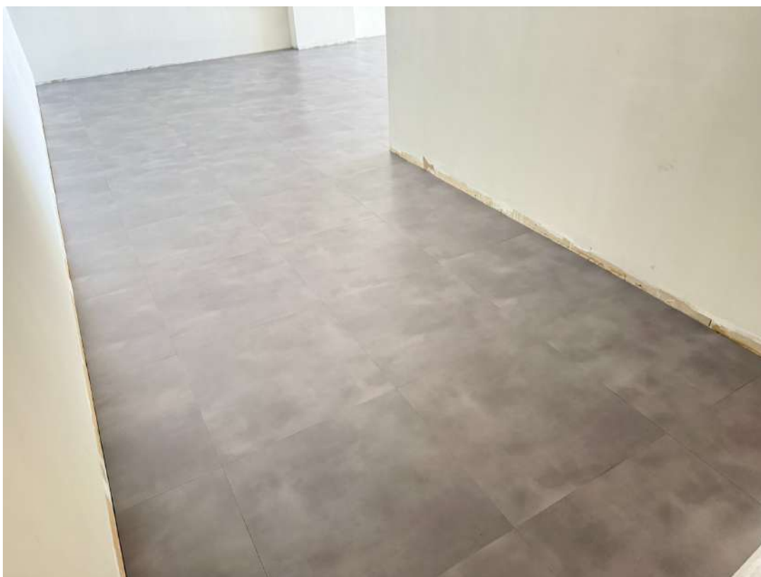
Figura 4. Assentamento do piso vinílico no 3º pavimento.
