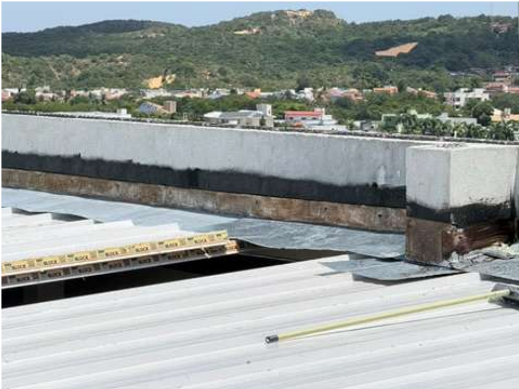
Figura 14 Instalação dos rufos na cobertura da edificação.
