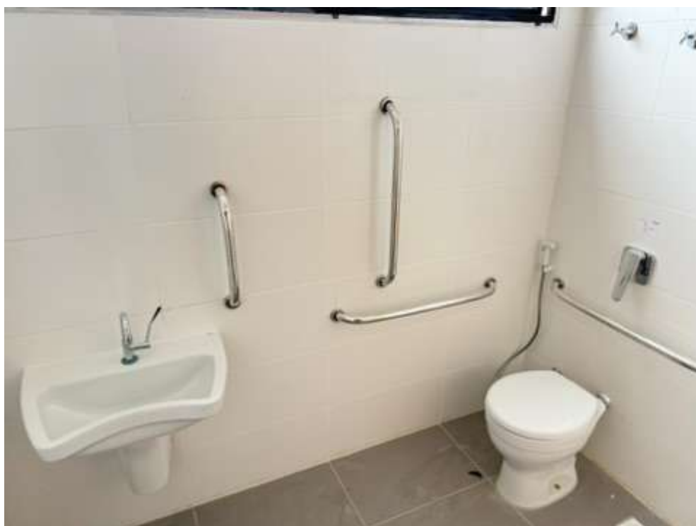
Figura 21 Instalação das torneiras, barras de apoio, válvula e vaso sanitário em banheiro PCD.
