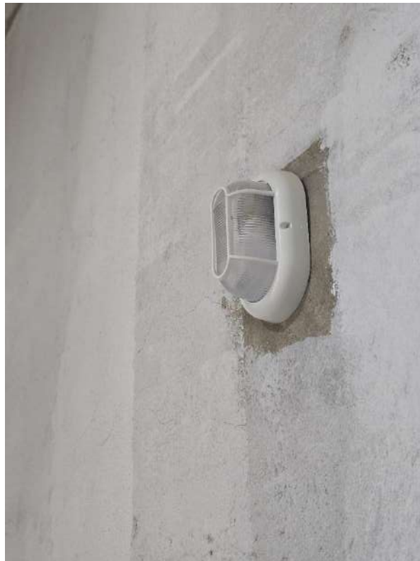
Figura 37 Instalação das luminárias tipo arandela.
