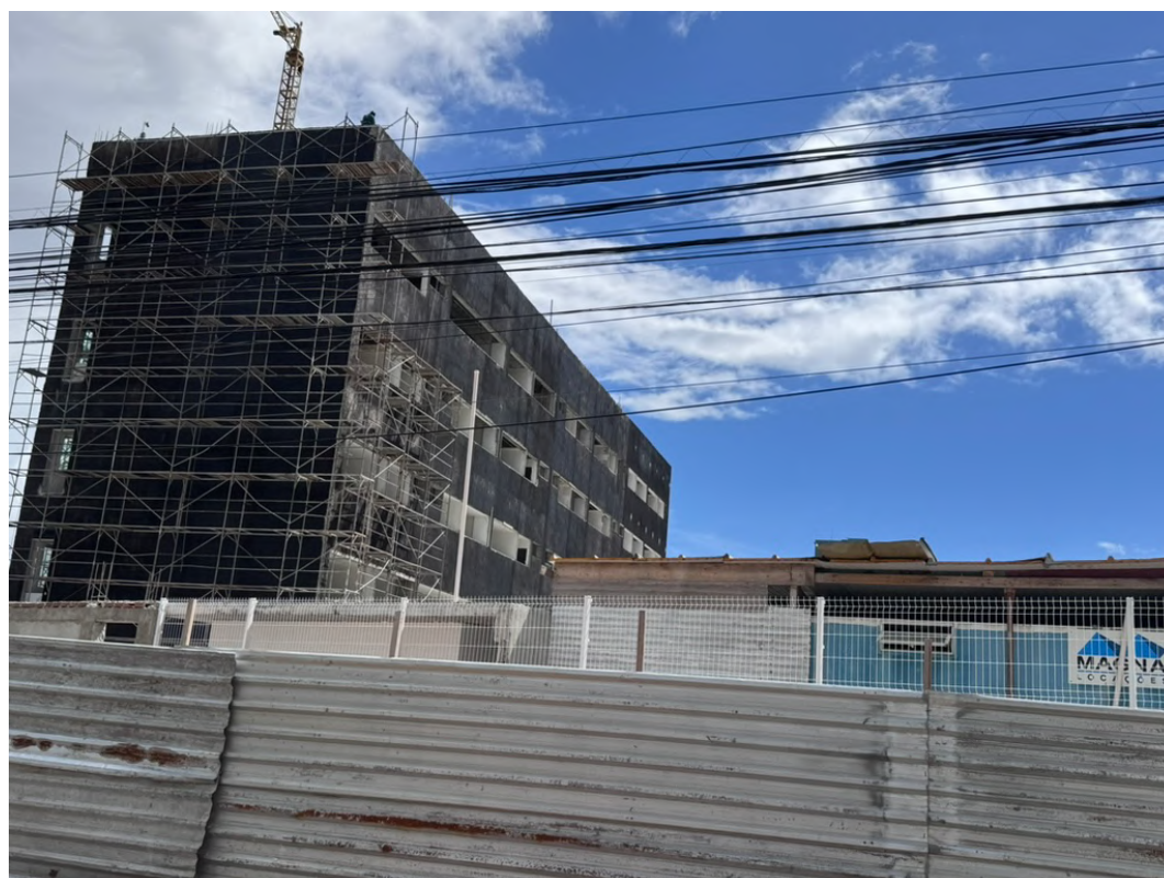
Figura 22 Fachada impermeabilizada com aplicação de emulsão asfáltica.
