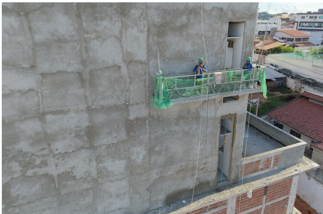
Figura 4 Aplicação de chapisco e emboço na fachada posterior da edificação.
