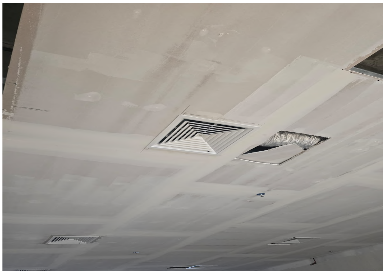
Figura 32 Instalação das grelhas fixas.
