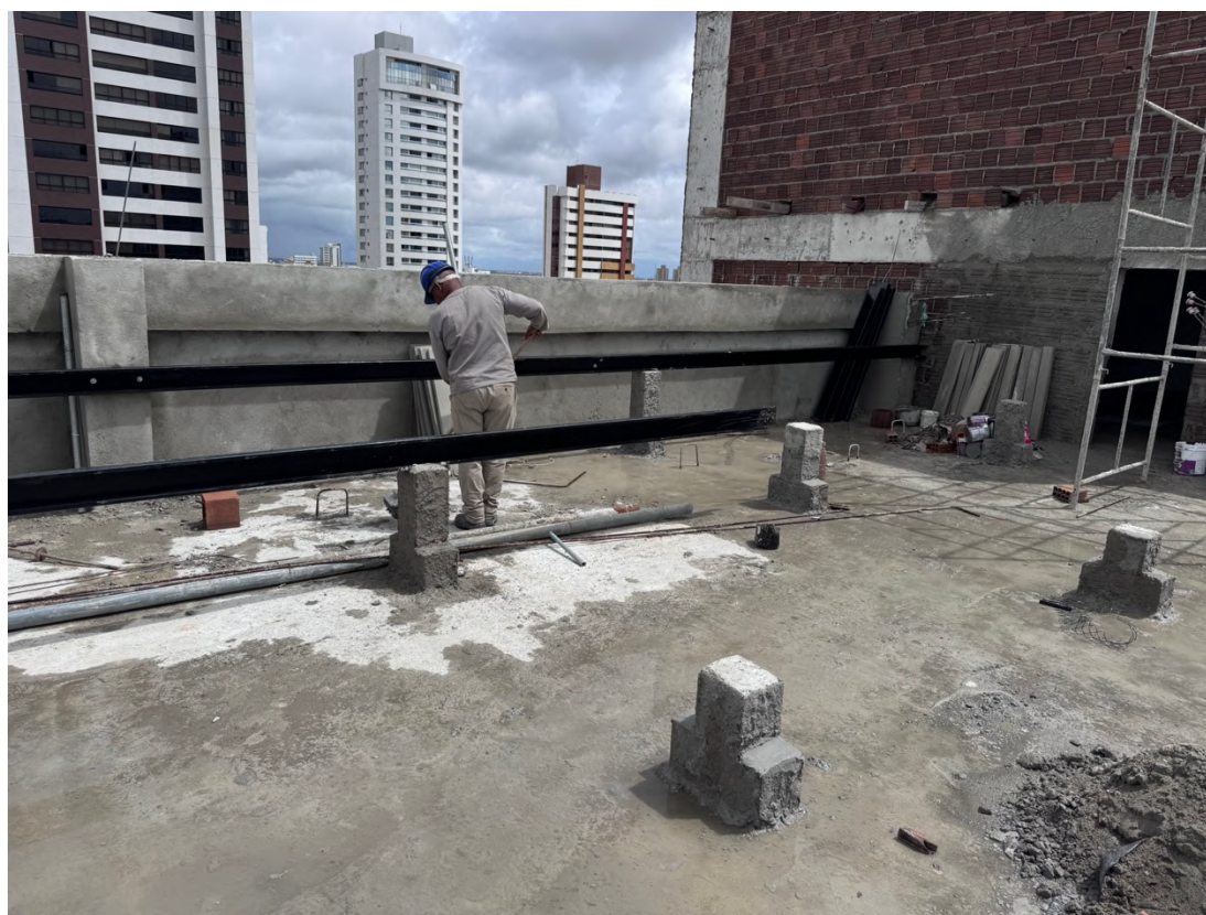
Figura 13 Estrutura para instalação da cobertura.
