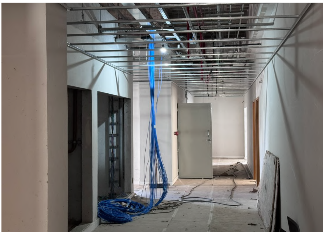
Figura 30 instalação de cabos de par trançado UTP
