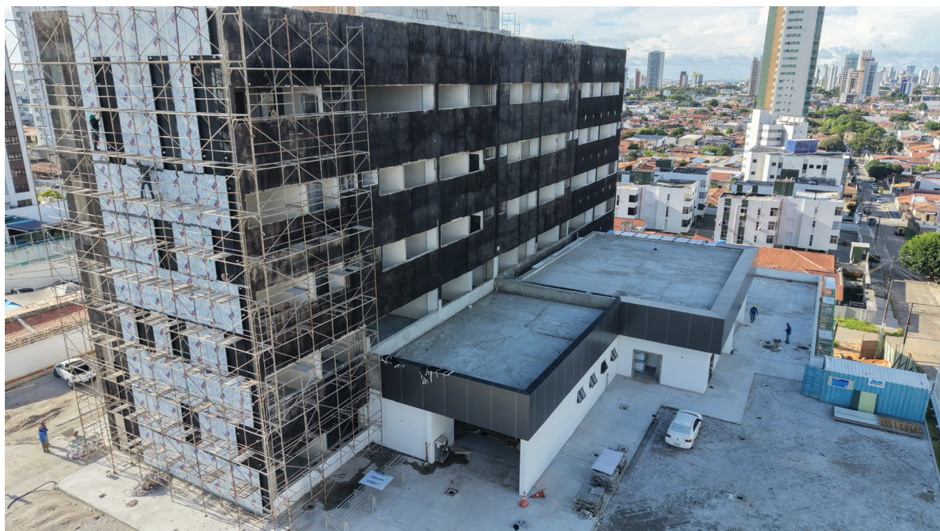
Figura 1. Visão geral da obra.
