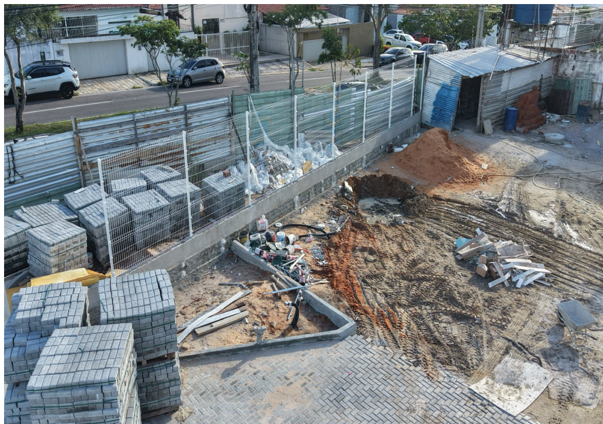
Figura 21 Instalação das muretas e gradil na entrada principal da edificação.
