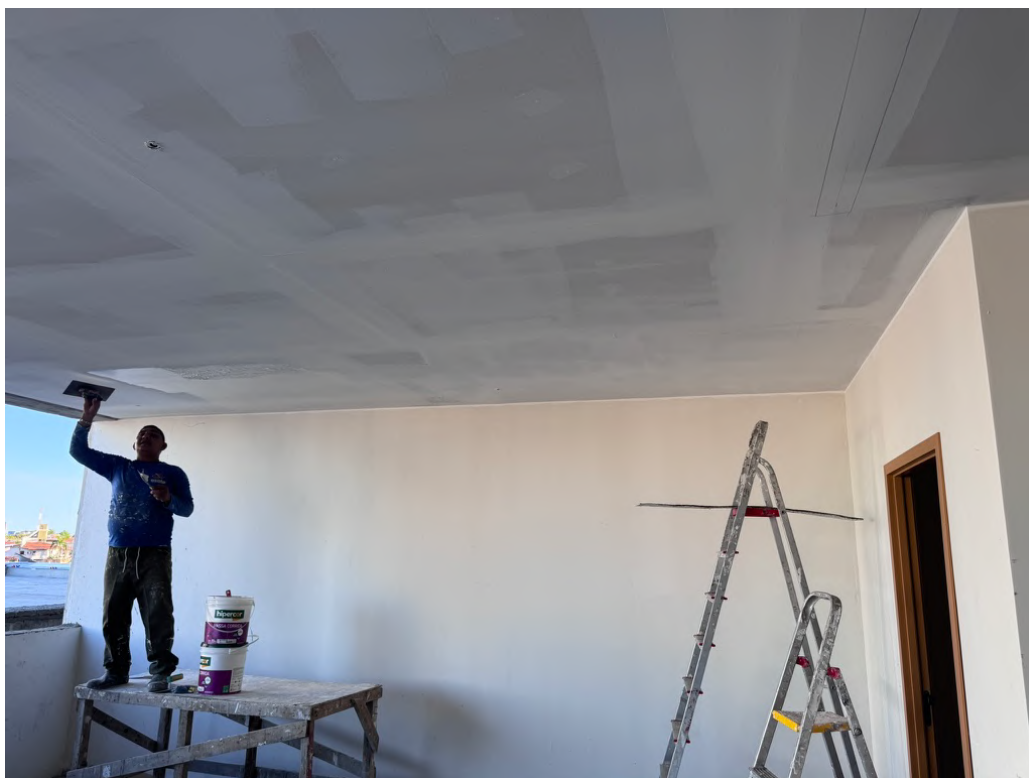
Figura 18 Aplicação de massa látex no teto.
