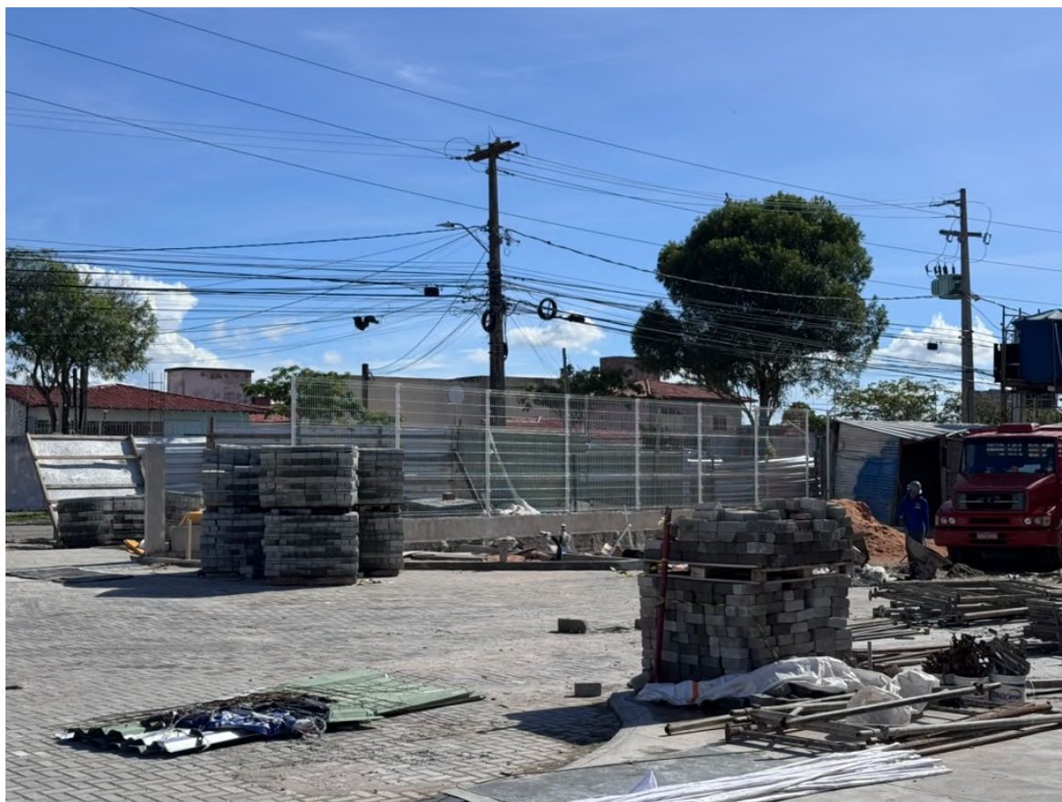
Figura 20 Instalação das muretas e gradil na entrada principal da edificação.
