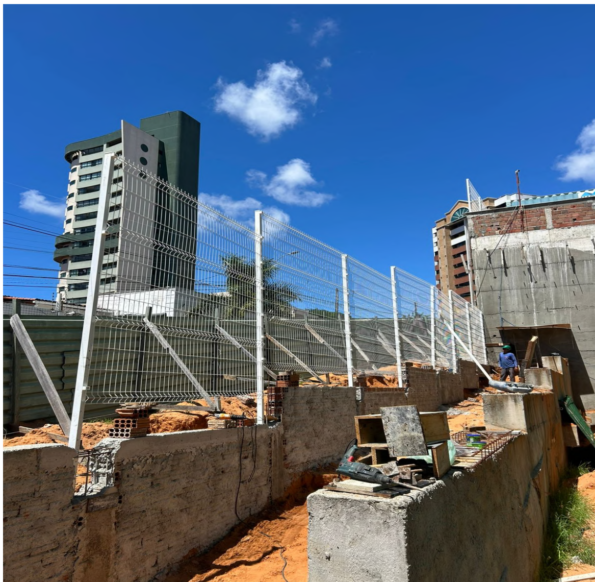
Figura 2 Execução da mureta na lateral da edificação.
