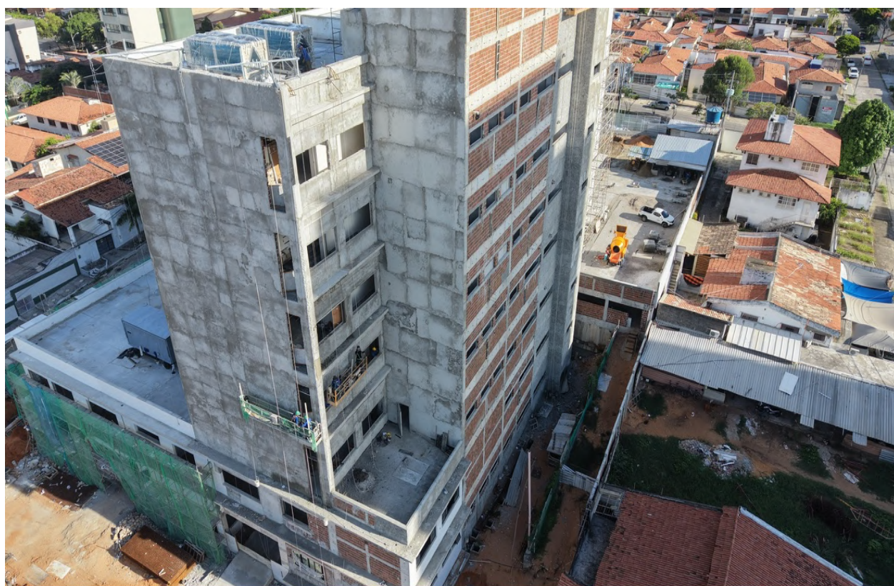
Figura 3 Aplicação de chapisco e emboço na fachada posterior da edificação.
