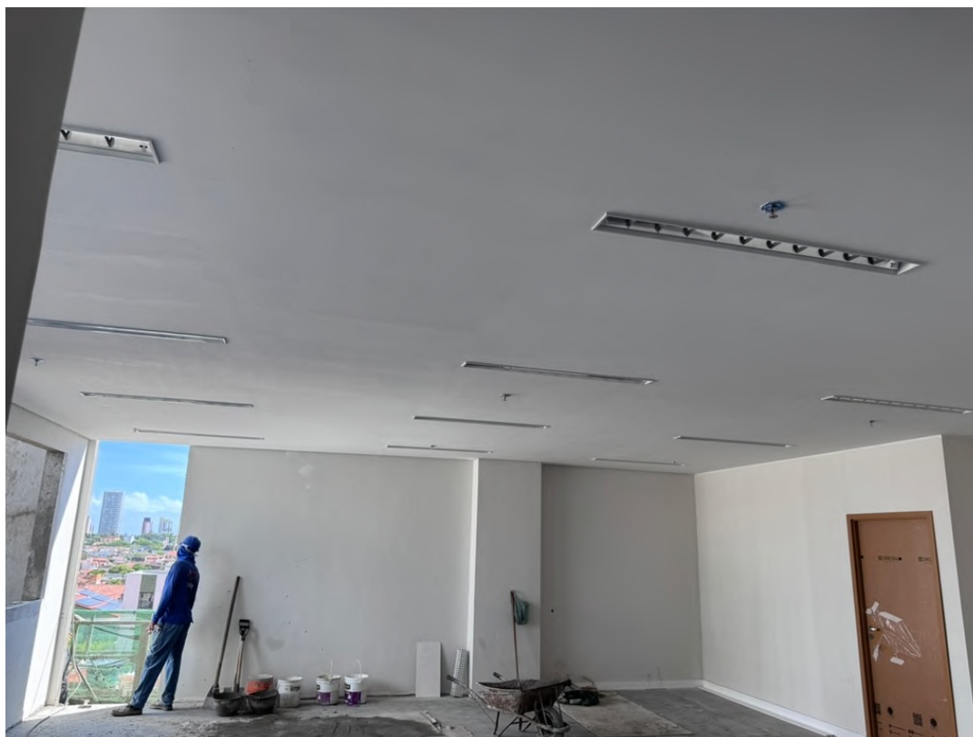
Figura 30 Instalação das luminárias em LED.
