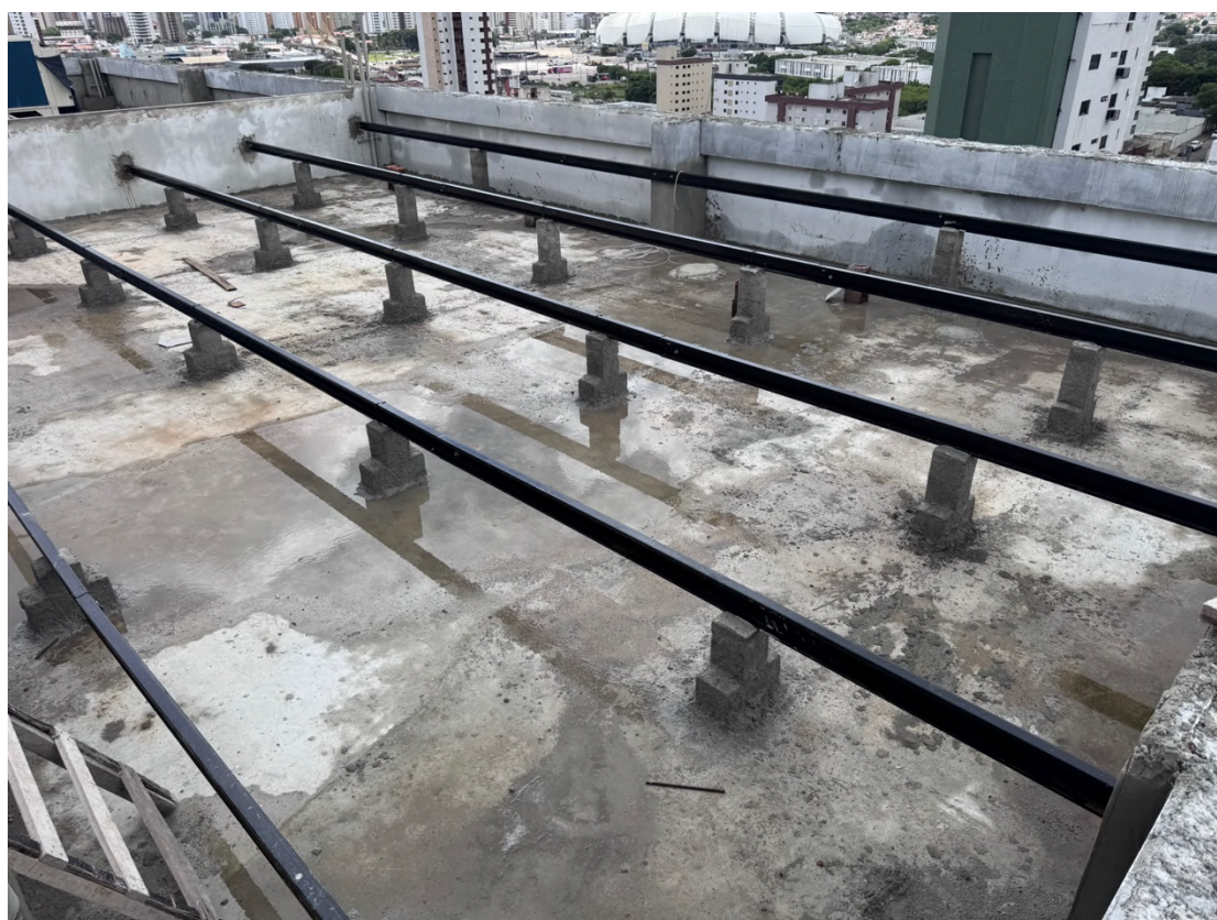
Figura 12 Estrutura para instalação da cobertura.
