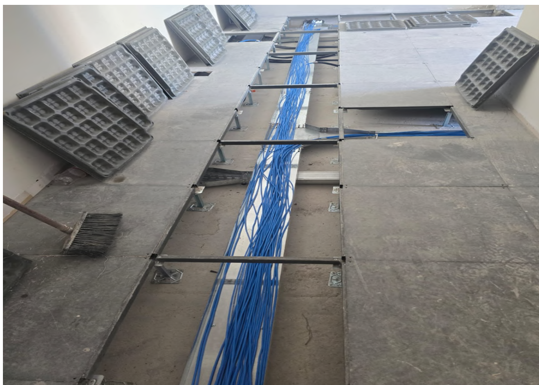
Figura 31 instalação de cabos de par trançado UTP
