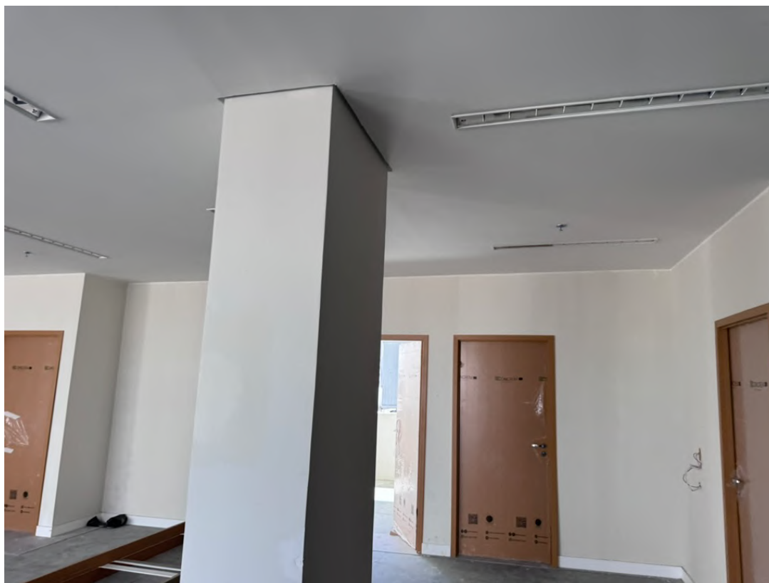
Figura 16 Instalação das portas internas.
