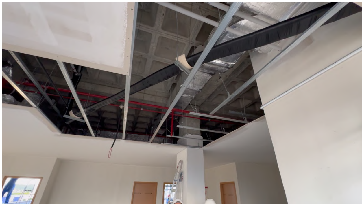
Figura 31 Instalação de tubulação frigorígena.
