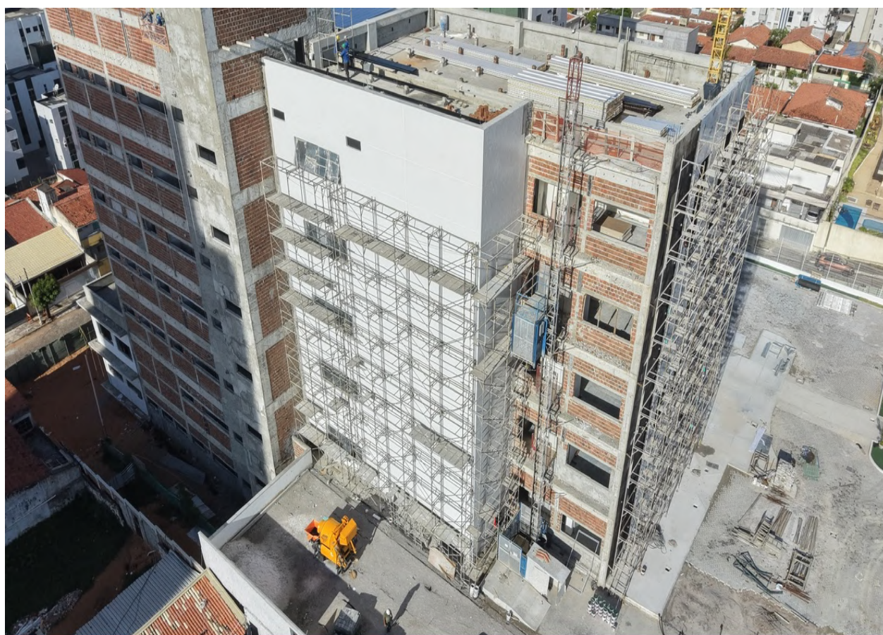
Figura 7 Instalação da junta de dilatação na fachada da edificação.
