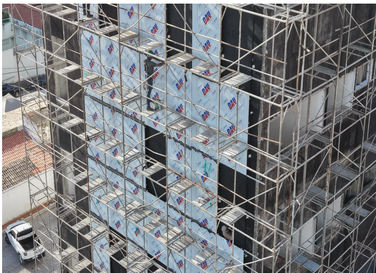
Figura 9 Instalação do ACM.
