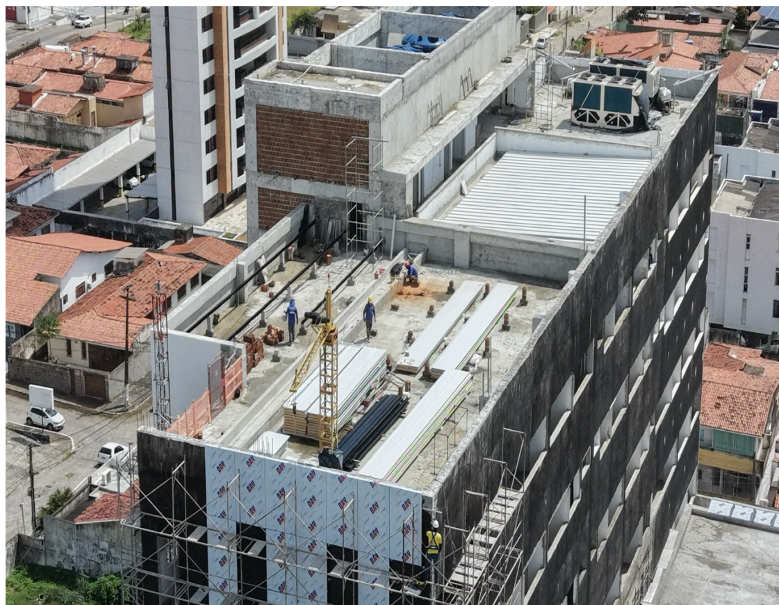
Figura 15 Instalação das telhas sanduiche.
