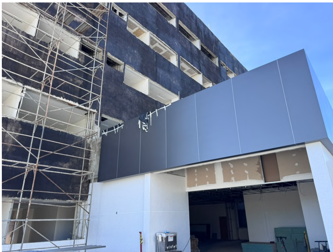
Figura 11 Aplicação do forro drywall RU na entrada da edificação, na recepção.
