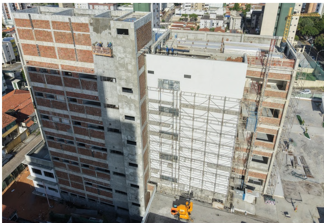
Figura 17 Instalação das esquadrias dos fossos dos elevadores.
