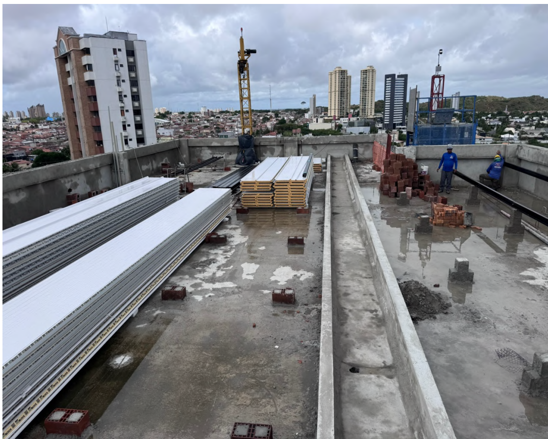
Figura 14 Estrutura e telhas sanduiche para instalação da cobertura.
