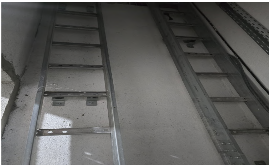
Figura 28 Instalação da estrutura elétrica.
