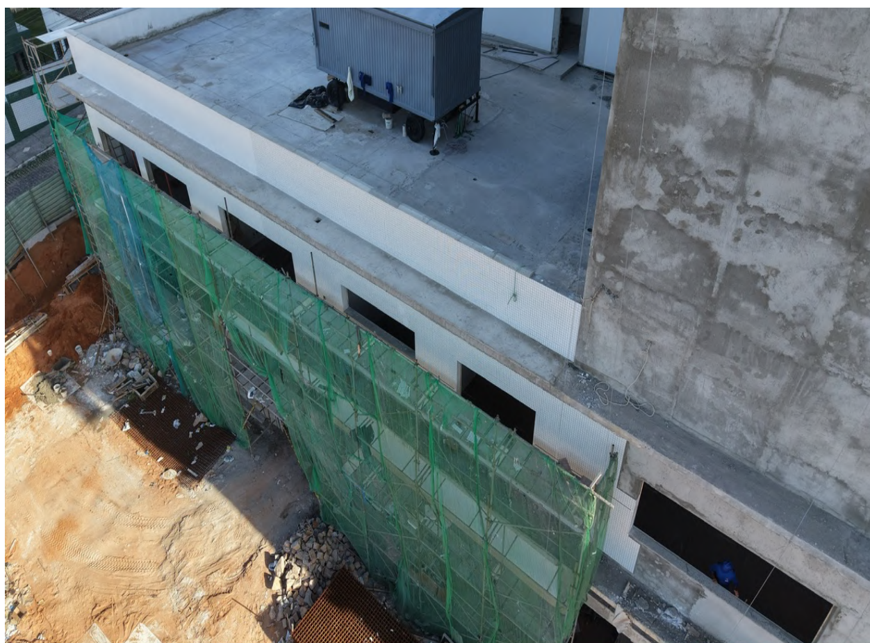
Figura 5 Aplicação de revestimento cerâmico na fachada posterior da edificação.
