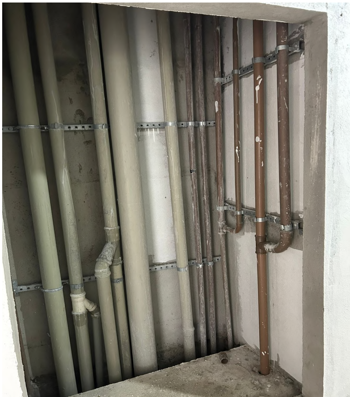
Figura 23 Sistema de esgotamento sanitário.
