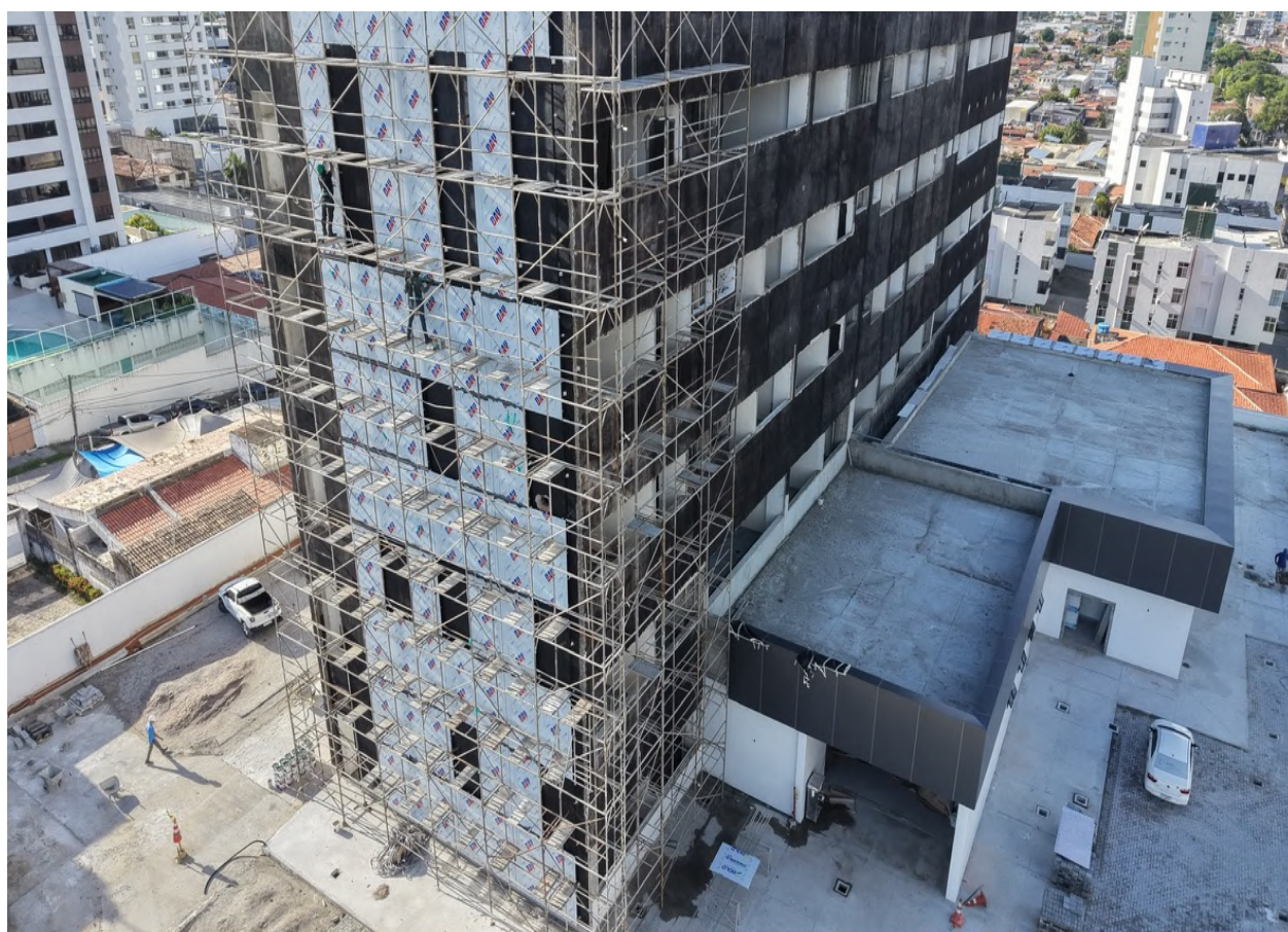
Figura 8 Instalação do ACM na fachada lateral da edificação.
