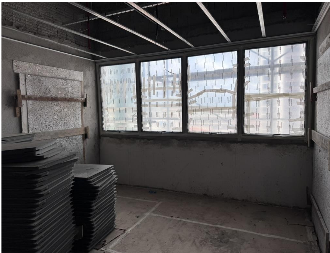
Figura 15 Instalação das janelas tipo basculante.
