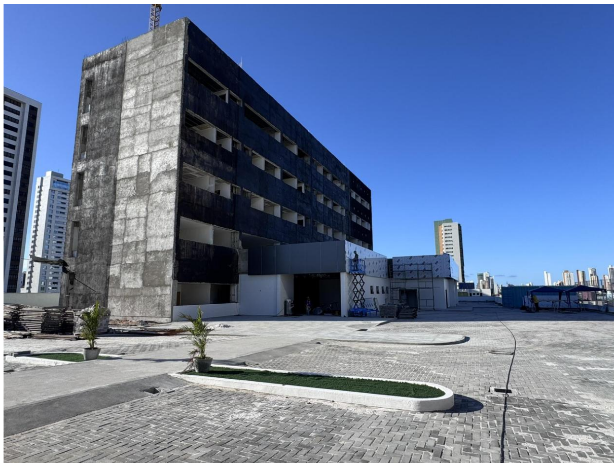
Figura 1. Visão geral da obra.
