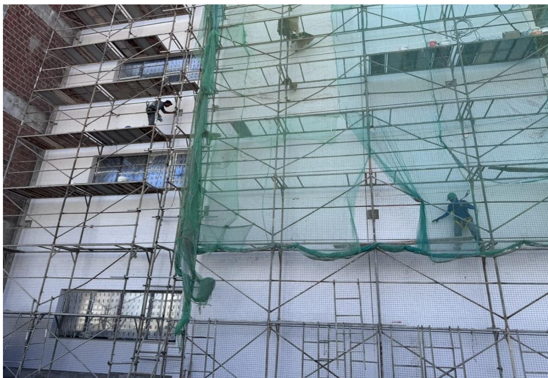
Figura 7 Instalação da junta de dilatação na fachada posterior da edificação.
