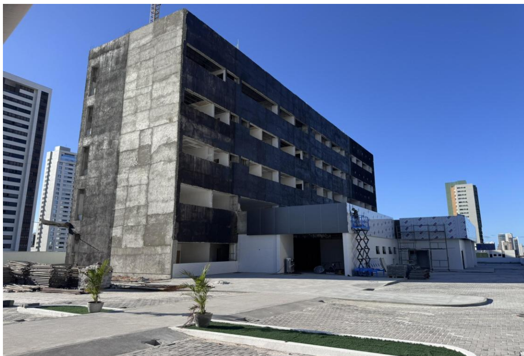
Figura 20 Fachada impermeabilizada com aplicação de emulsão asfáltica.
