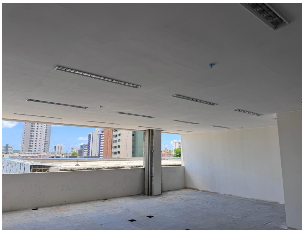
Figura 29 Instalação das luminárias em LED.
