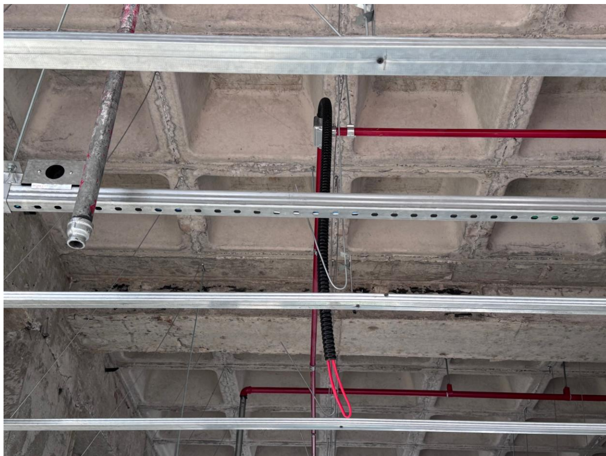
Figura 26 Instalação cabos do sistema de detecção e alarme de incêndio.
