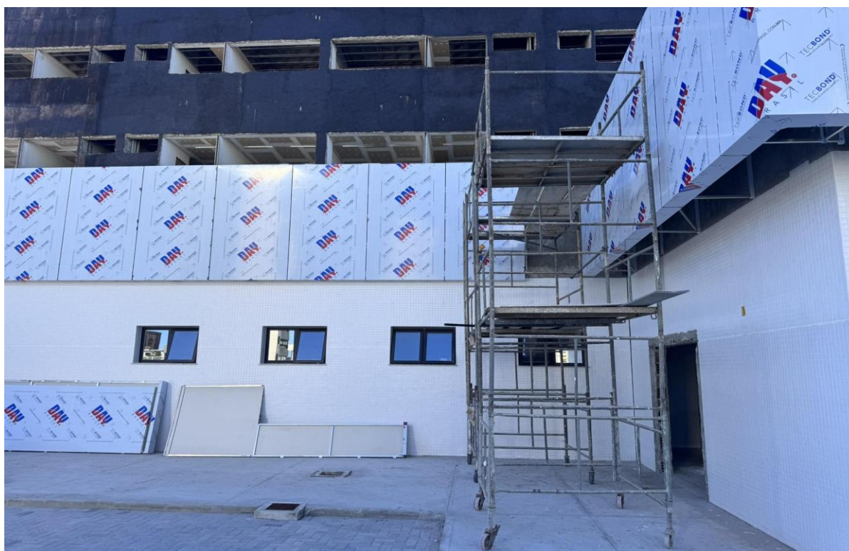
Figura 9 Instalação do ACM na lateral da recepção e auditório.
