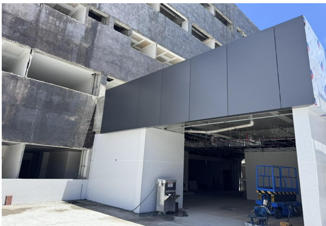
Figura 8 Instalação do ACM na fachada da recepção.
