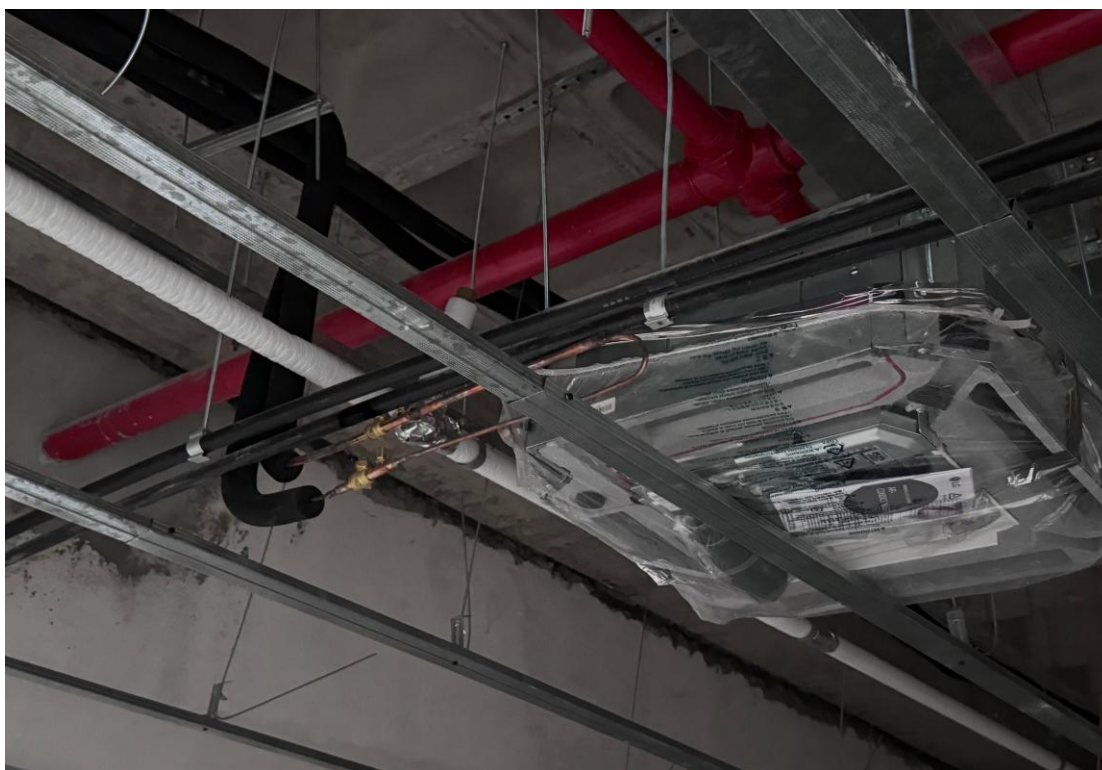
Figura 31 Instalação de tubulação frigorígena dos VRFs.
