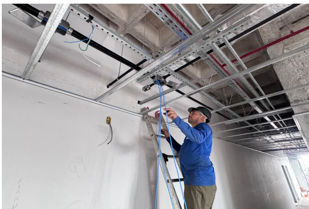
Figura 30 instalação de cabos de par trançado UTP
