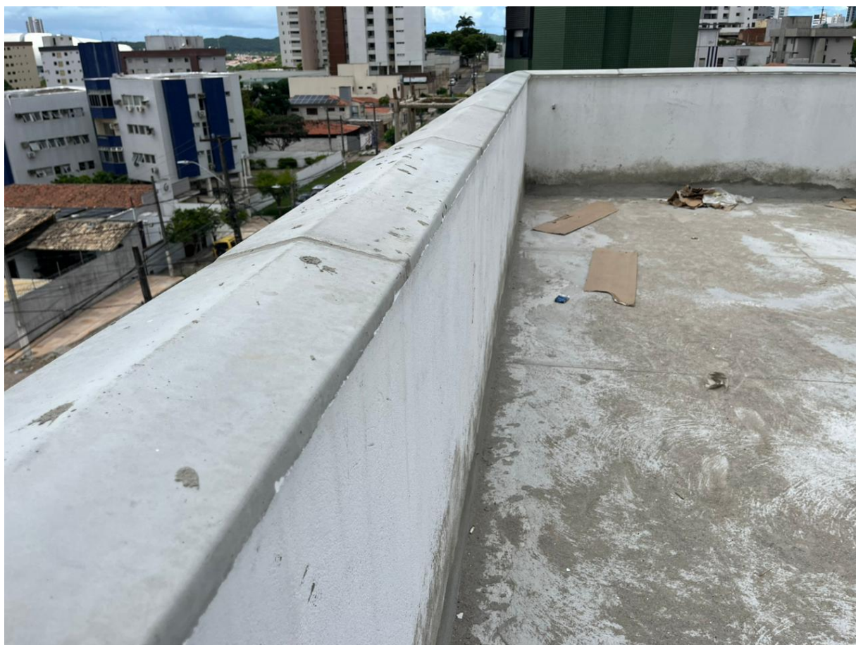
Figura 12 Instalação do chapim em concreto nas muretas.
