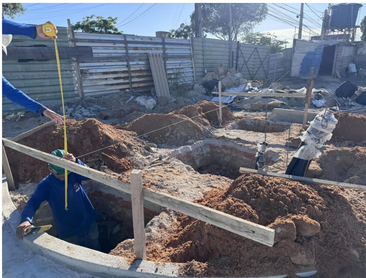
Figura 2 Execução das sapatas para fundação da mureta frontal.
