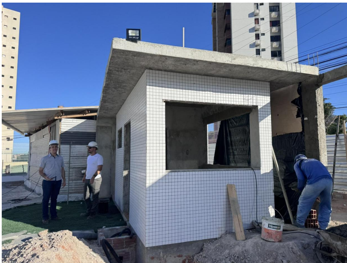
Figura 5 Aplicação de revestimento na guarita.
