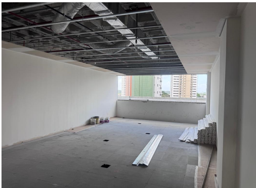
Figura 27 Instalação das caixas de multiconexão para piso elevado.
