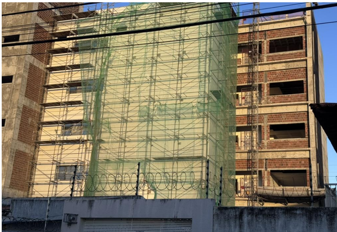
Figura 6 Aplicação de revestimento cerâmico na fachada posterior da edificação.
