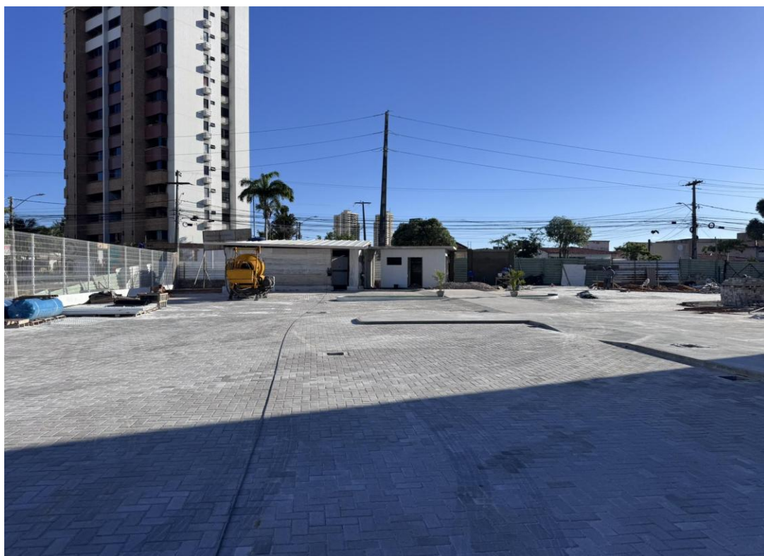
Figura 19 Execução das calçadas e passeios internos
