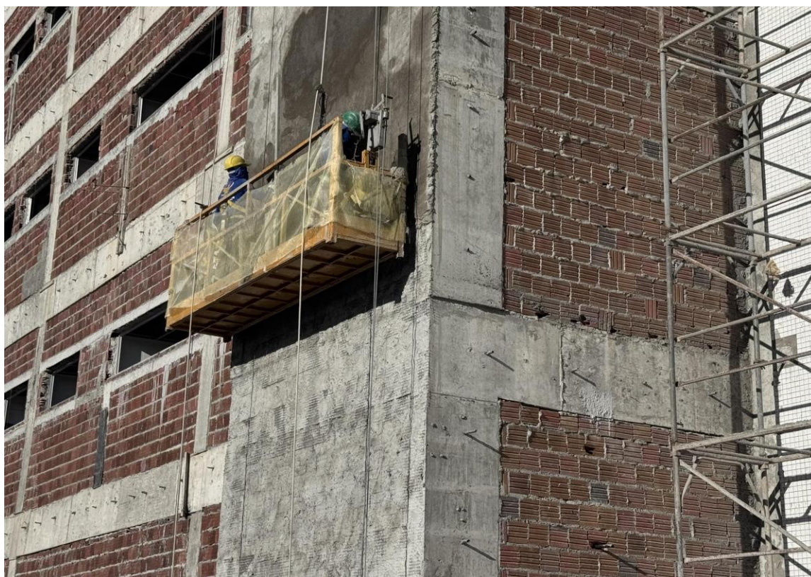
Figura 21 Chapisco e reboco da fachada posterior com aditivos impermeabilizante.
