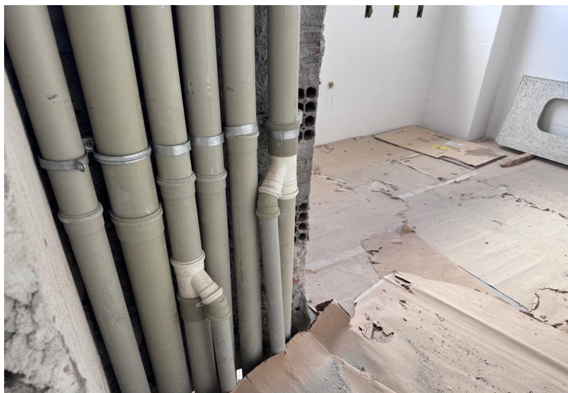
Figura 22 Sistema de esgotamento sanitário.
