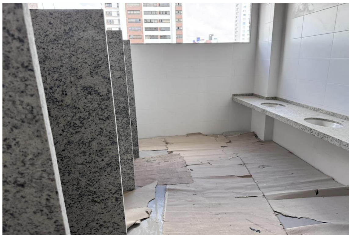
Figura 3 Instalação das divisórias em granito nos banheiros coletivos.
