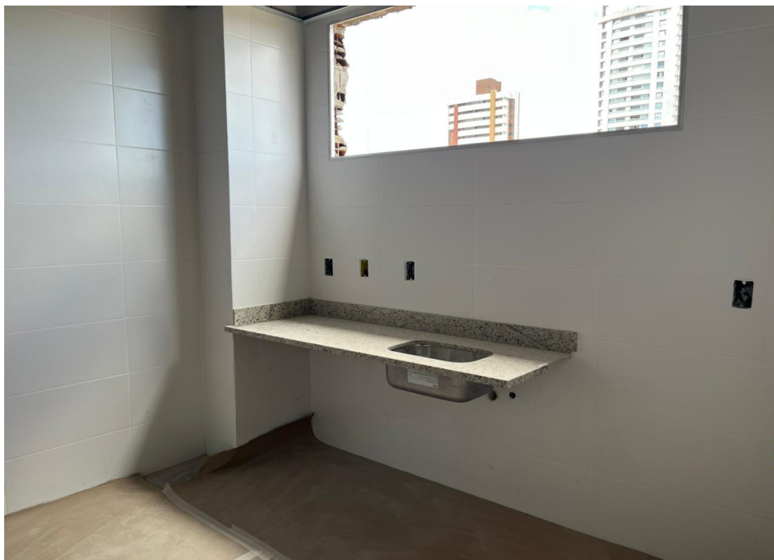
Figura 16 Instalação das bancadas em granito nas copas.
