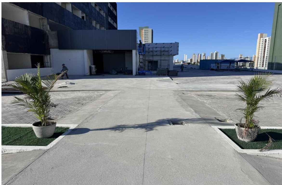
Figura 17 Execução das calçadas e passeios internos.
