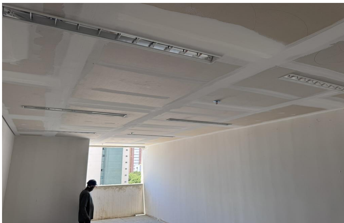
Figura 10 Aplicação do forro drywall nos ambientes internos.
