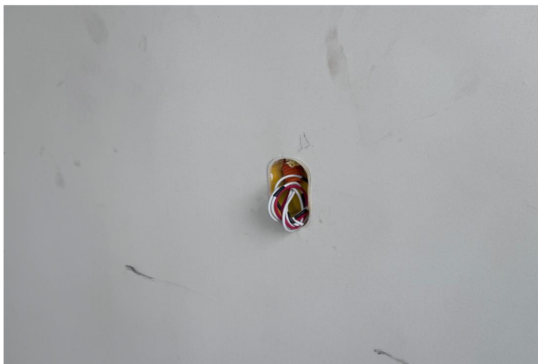
Figura 28 Instalação dos cabos elétricos.
