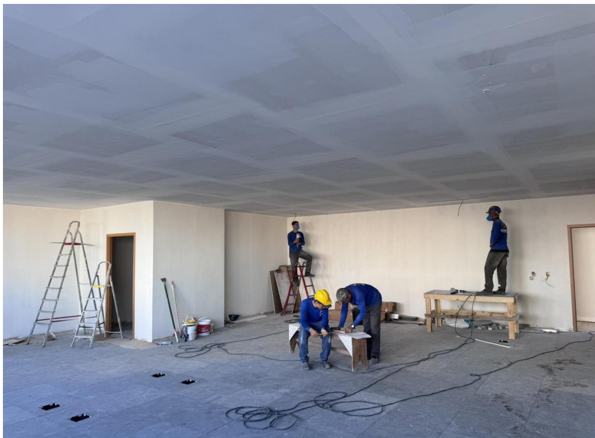
Figura 11 Aplicação do forro drywall nos ambientes internos.
