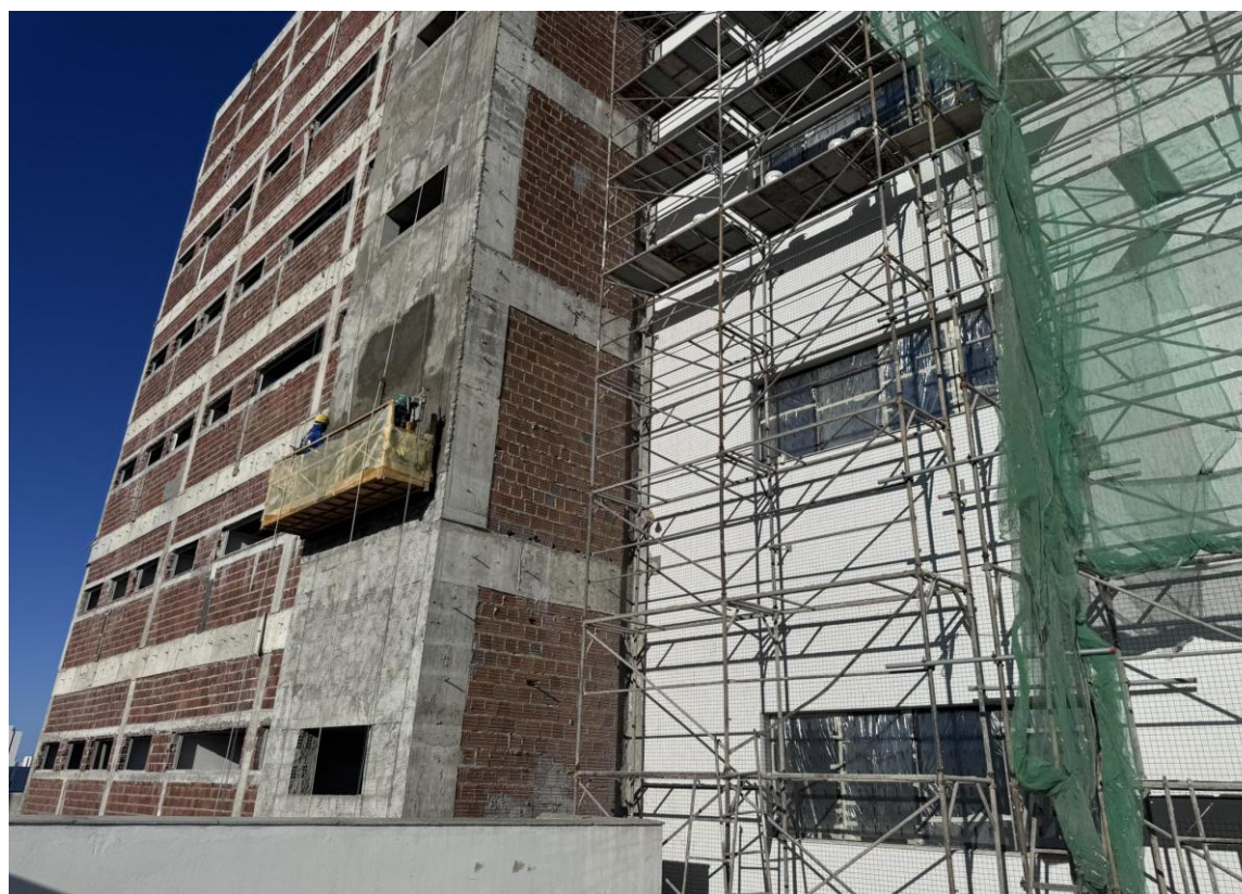
Figura 4 Aplicação de chapisco e emboço na fachada posterior da edificação.
