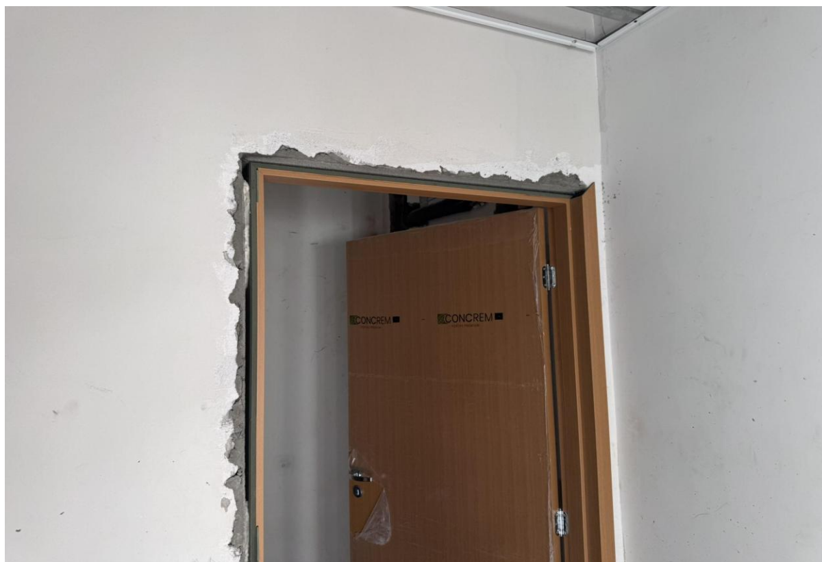
Figura 13 Instalação das portas internas.
