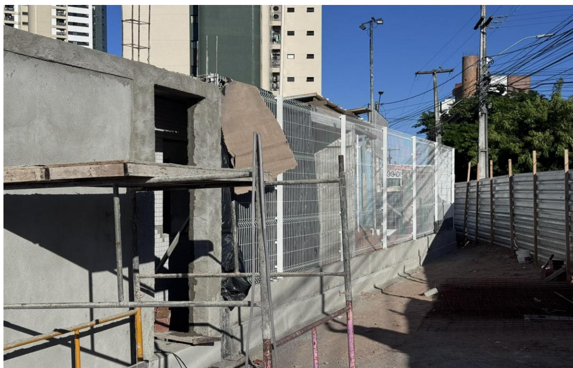
Figura 18 Instalação das muretas e gradil.
