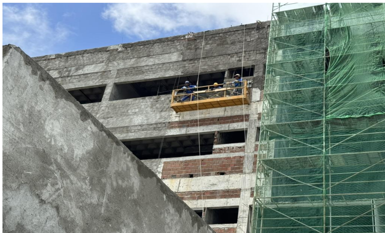
Figura 8. Aplicação de chapisco e emboço de na fachada frontal e lateral da edificação.
