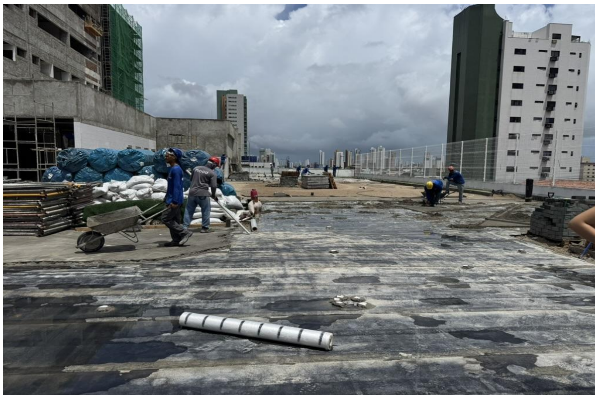
Figura 21. Aplicação de manta asfáltica dupla.
