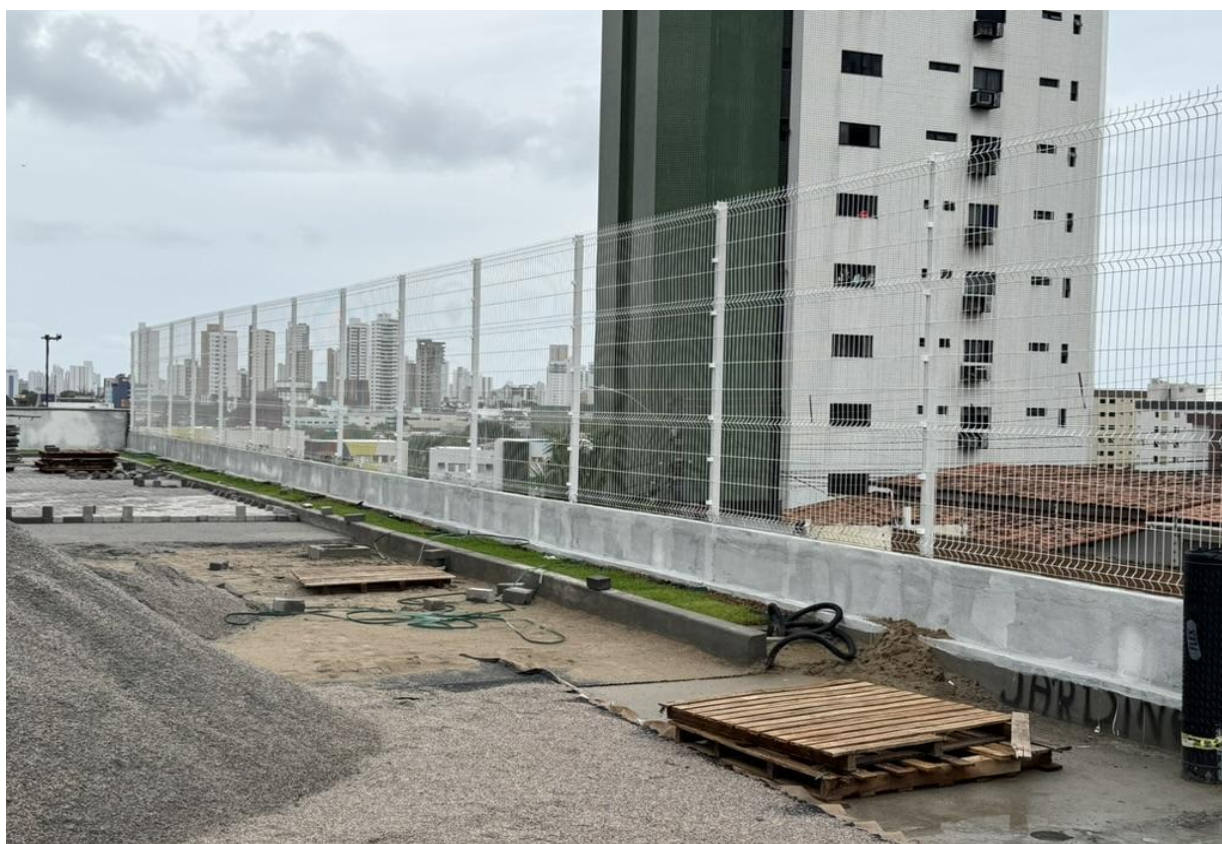
Figura 18. Instalação do Instalação de gradil e mureta.
