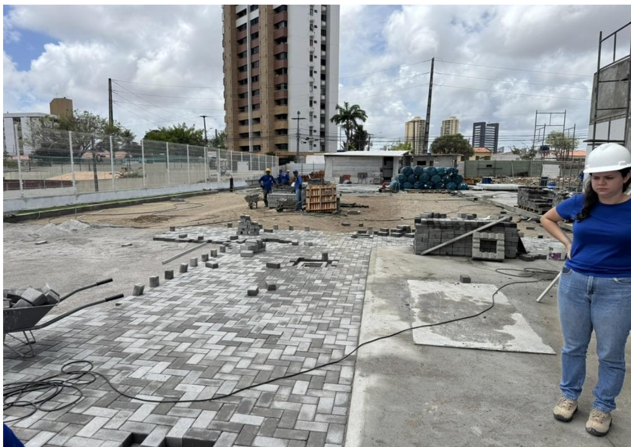
Figura 16. Instalação do piso intertravado.
