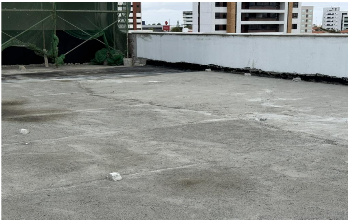
Figura 14. ACABAMENTO MECÂNICO ÁSPERO PARA PISO DE CONCRETO ARMADO..
