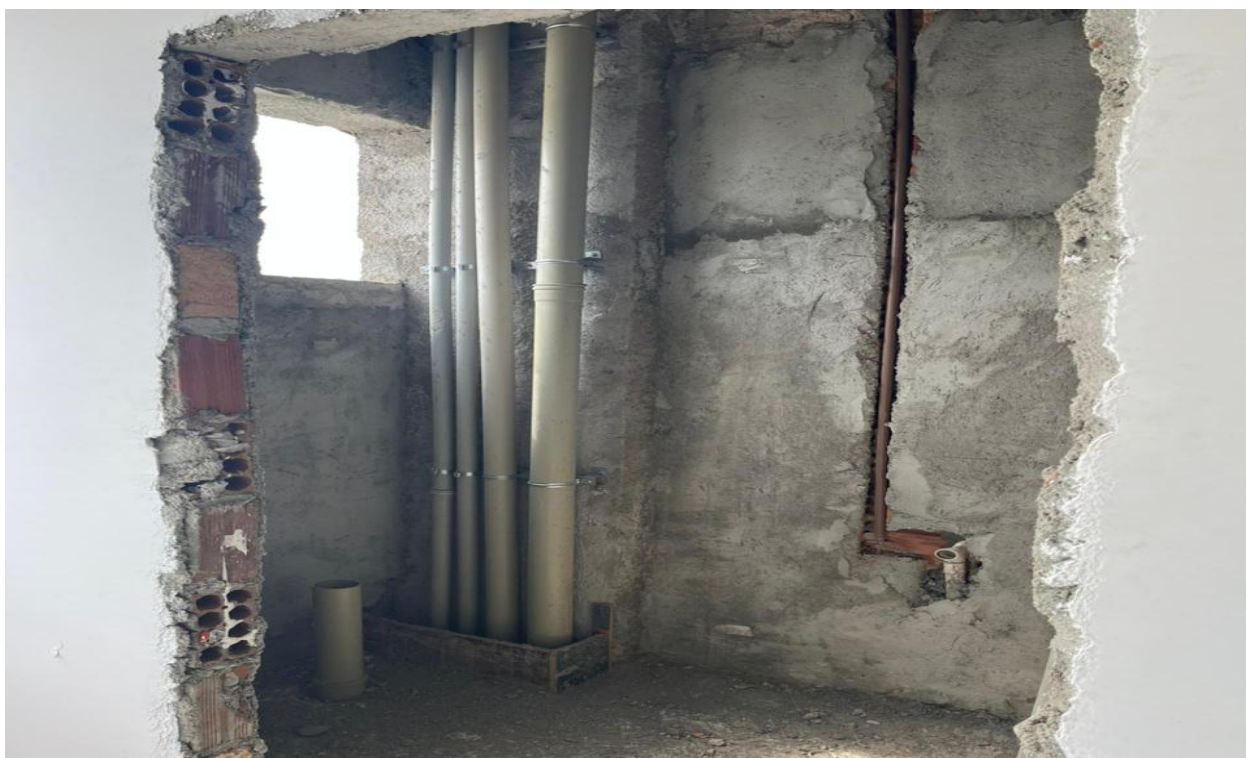
Figura 26. Passagem das tubulações no shaft do banheiro dos gabinetes.
