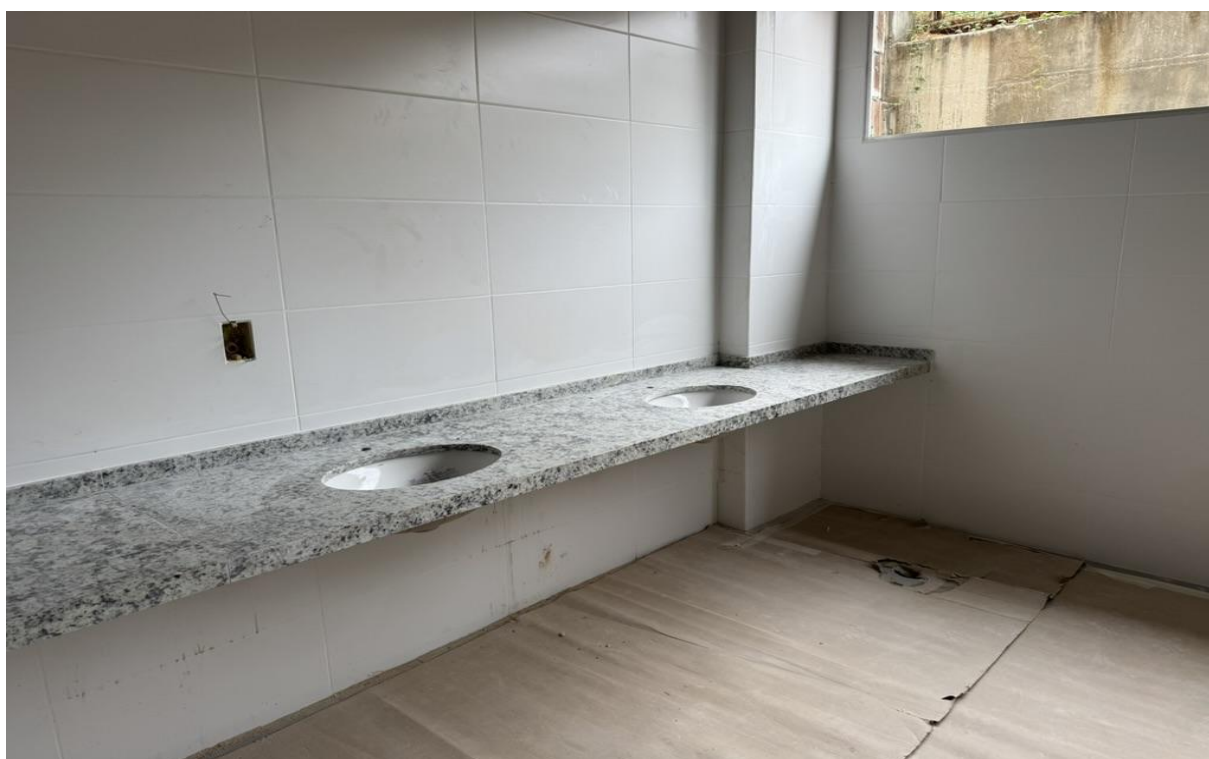
Figura 13. Bancada em granito instalada no banheiro coletivo do pavimento térreo.
