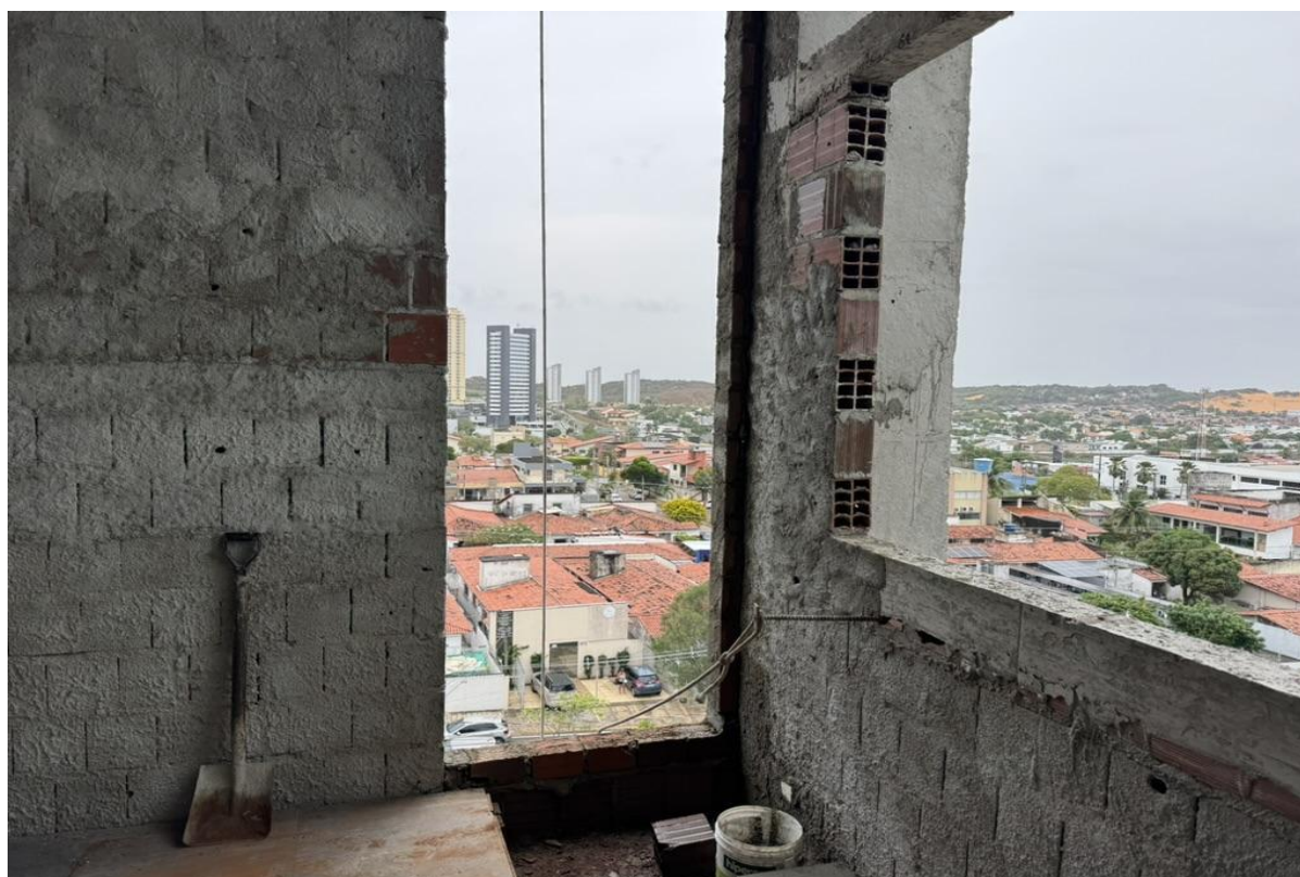
Figura 3, alvenaria de fechamento de parede na lateral da edificação, pavimento 3.
