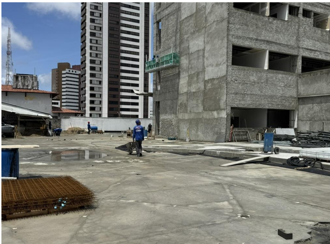
Figura 22. Execução de proteção mecânica sobre a manta asfáltica.
