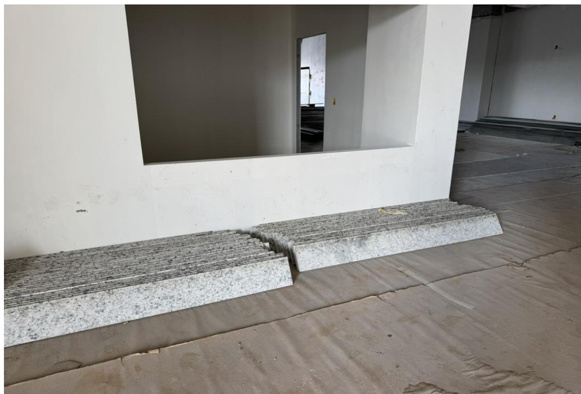
Figura 6. Soleiras para serem instaladas.
