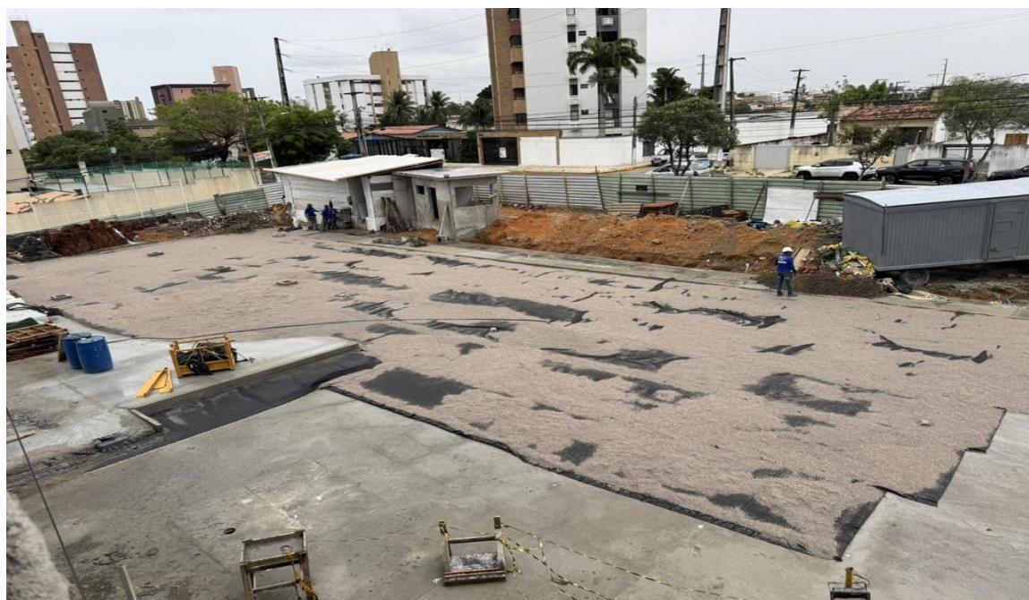
Figura 23. Execução de Manta têxtil drenante, Macdrain.
