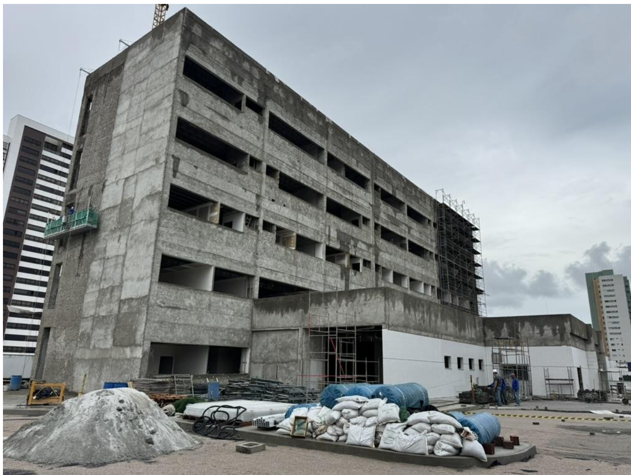
Figura 1. Visão geral da obra.
