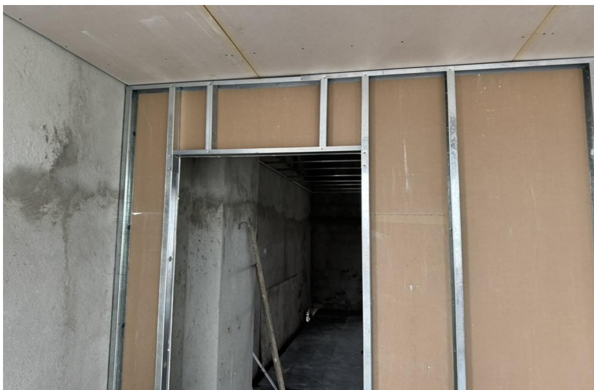
Figura 2. Instalação de paredes Drywall no 4o pavimento, aguardando o preenchimento com a lâ de rocha para fechamento.
