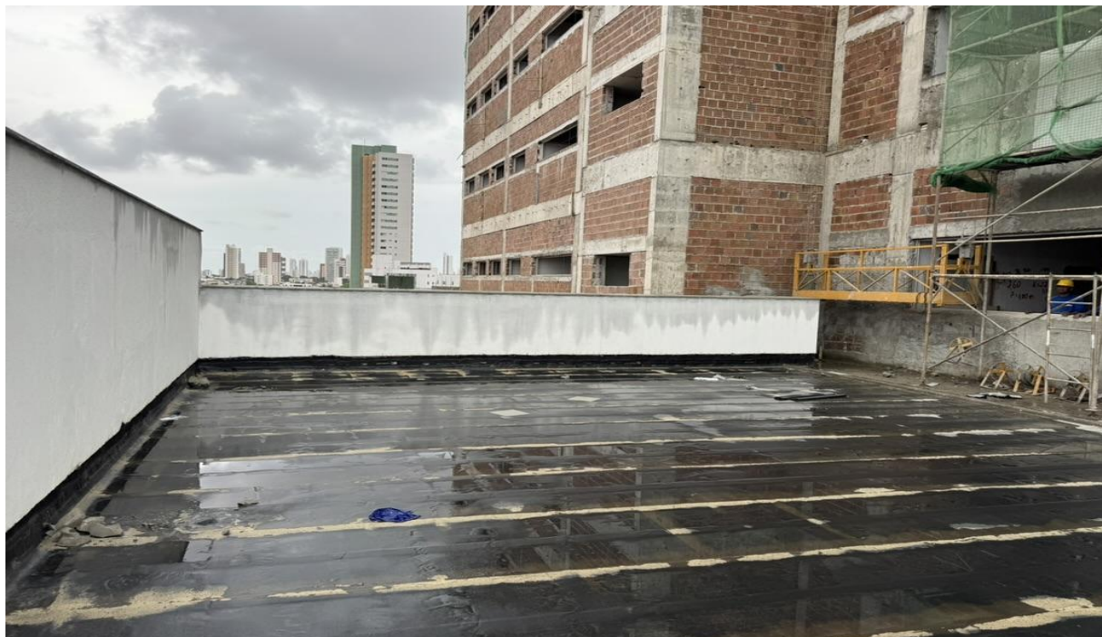
Figura 20. Aplicação de manta asfáltica dupla.
