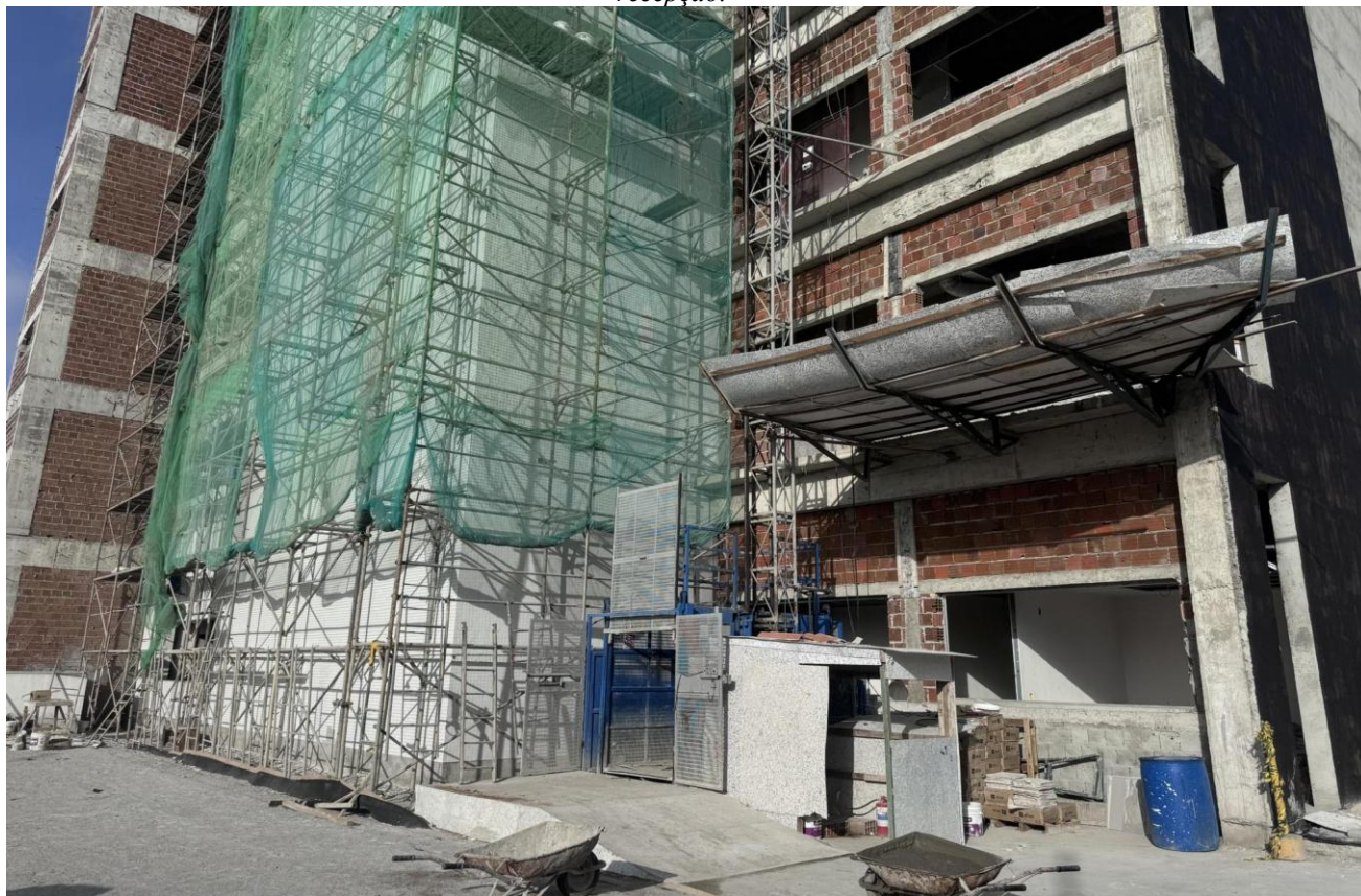
Figura 11. Assentamento de pastilhas cerâmicas na fachada posterior da edificação.
