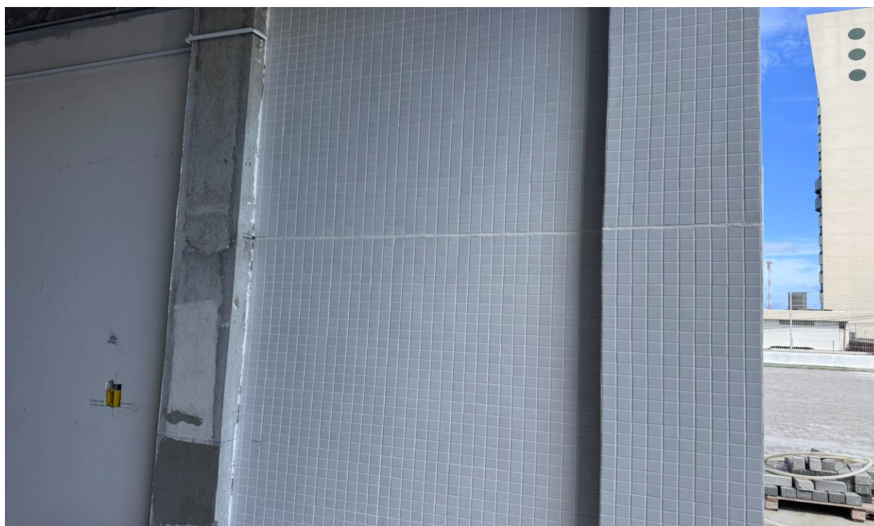
Figura 10. Assentamento de pastilhas cerâmicas na lateral da entrada da
