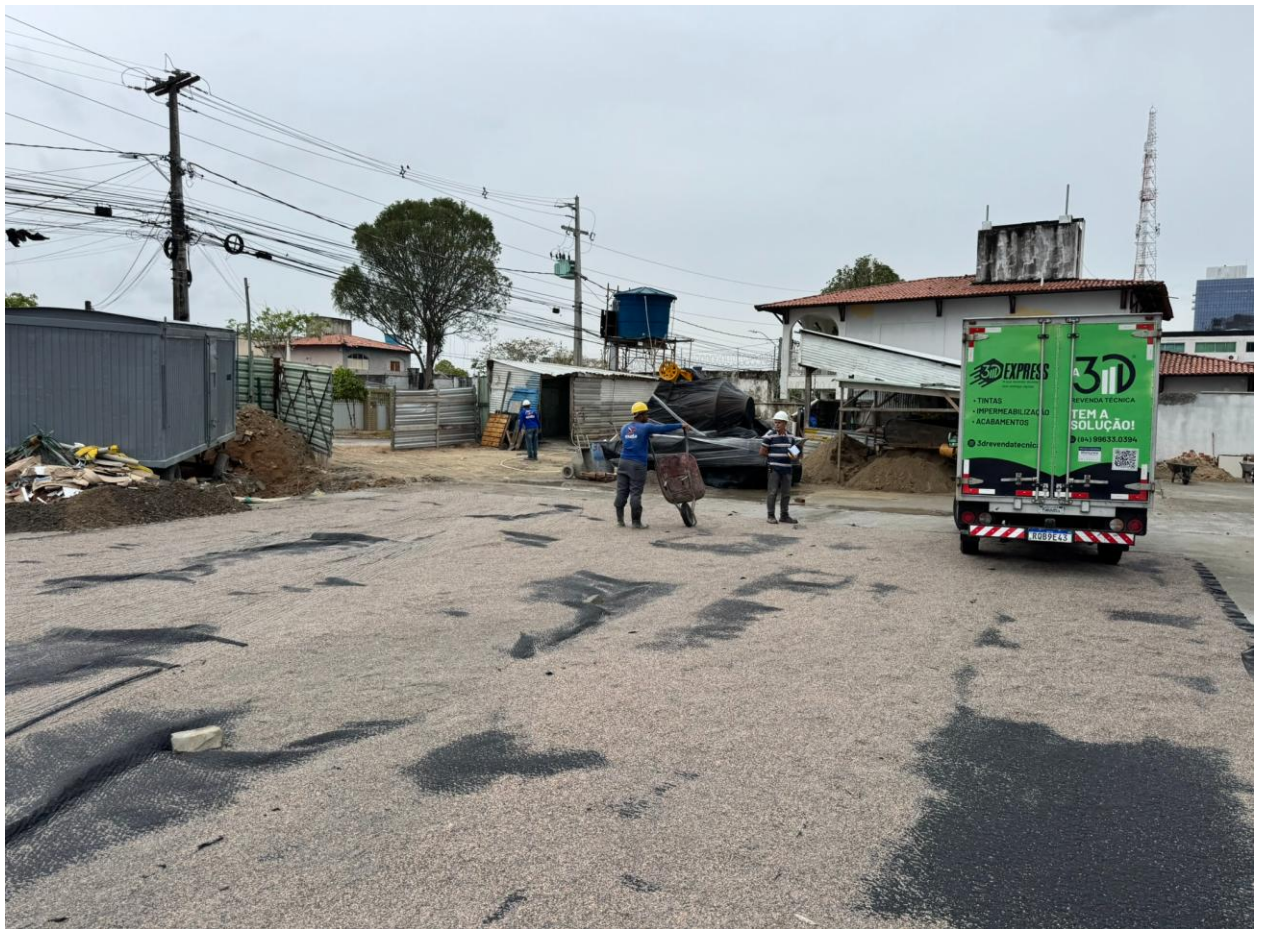
Figura 22. Execução de Manta têxtil drenante, Macdrain.
