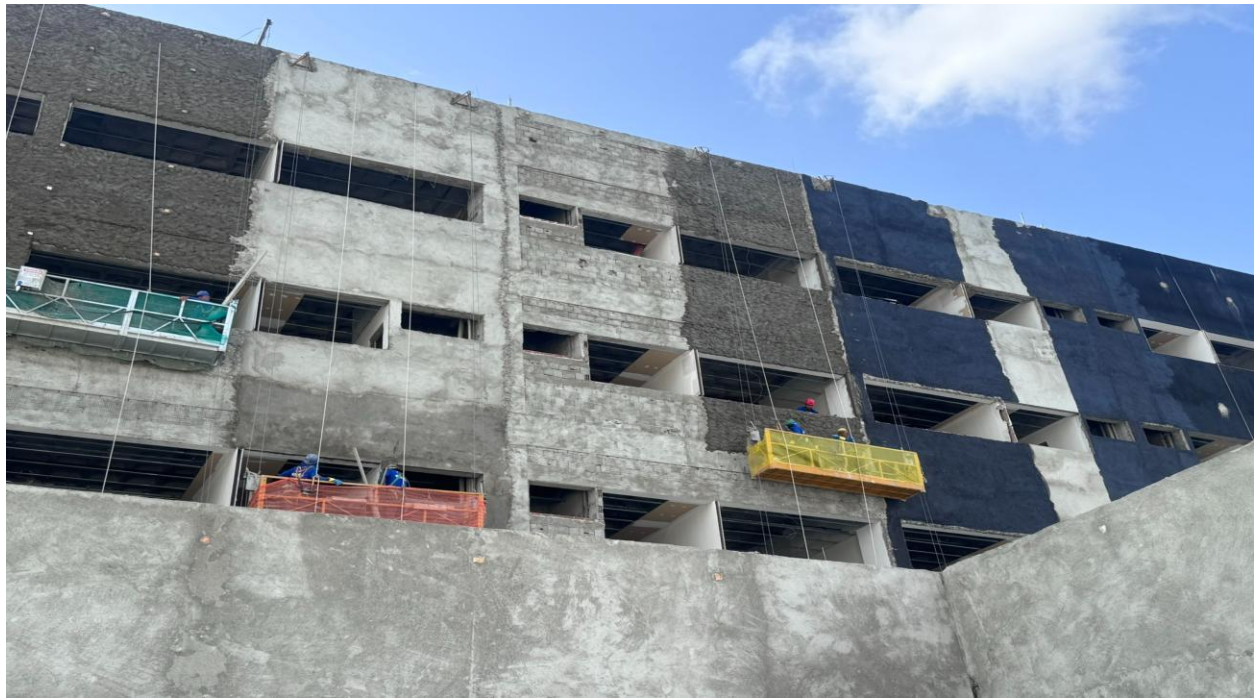
Figura 7. Aplicação de chapisco e emboço de na fachada frontal e lateral da edificação.
