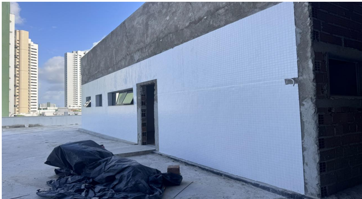
Figura 13. Janelas Maxim Ar instaladas no auditório.
