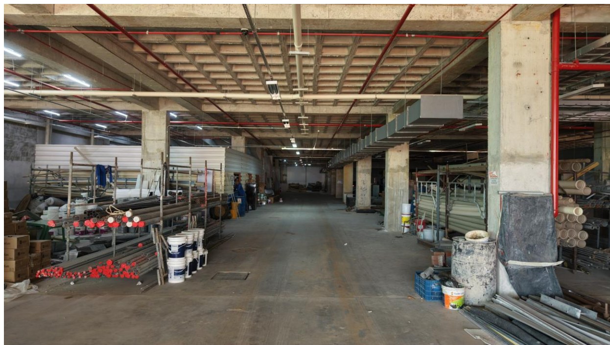
Figura 8, Entrada da garagem do pavimento semienterrado 2.
