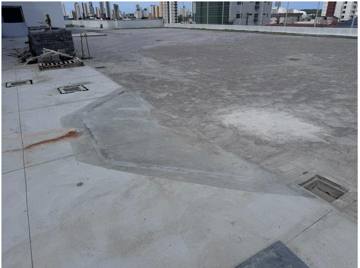
Figura 20. Instalação do piso intertravado ao lado da calçada do auditório.
