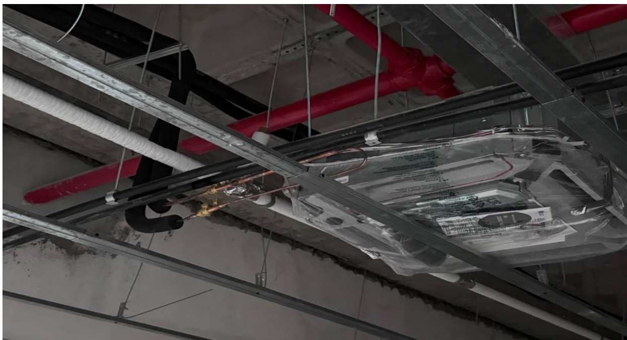
Figura 29. Instalação da tubulação frigorígena em ar condicionado VRF.
