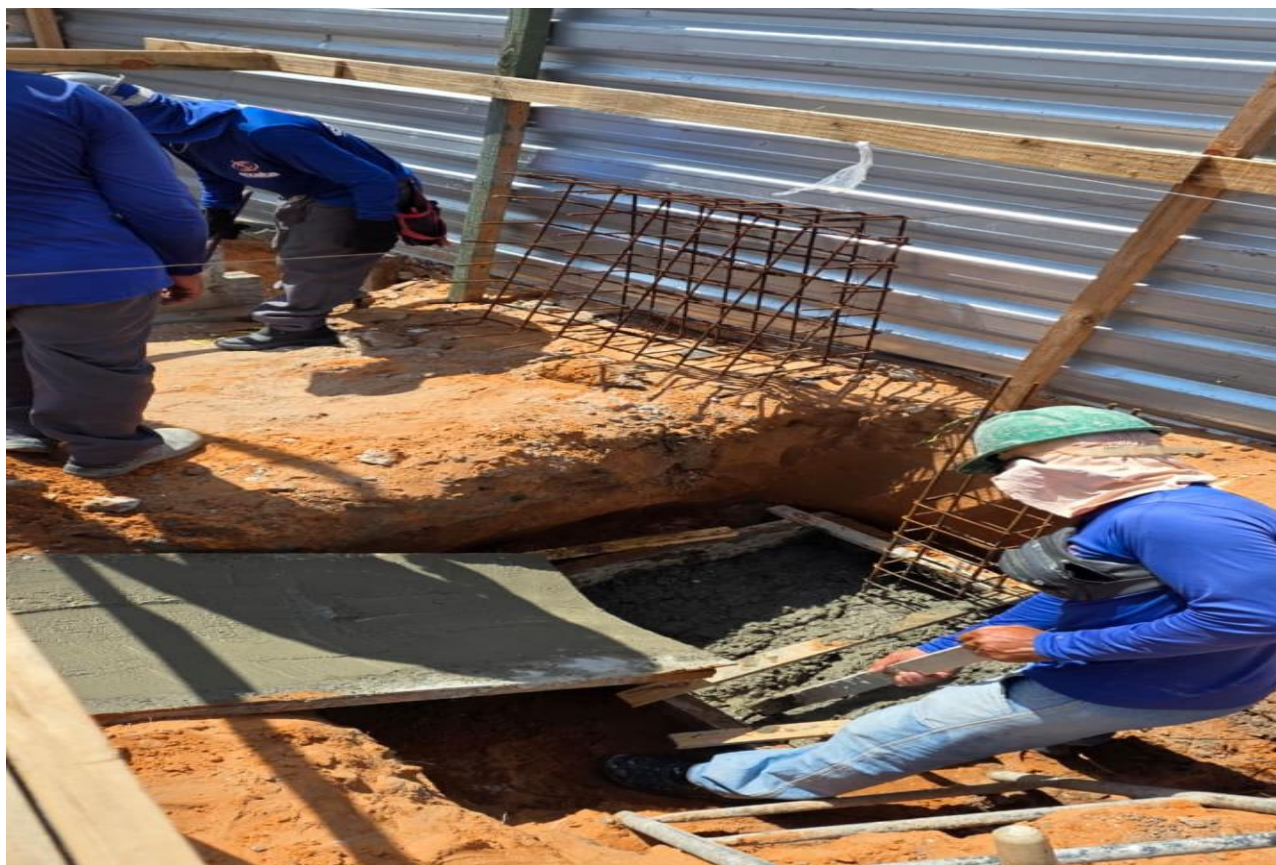
Figura 4. Concretagem da sapata para o pilar no muro lateral.
