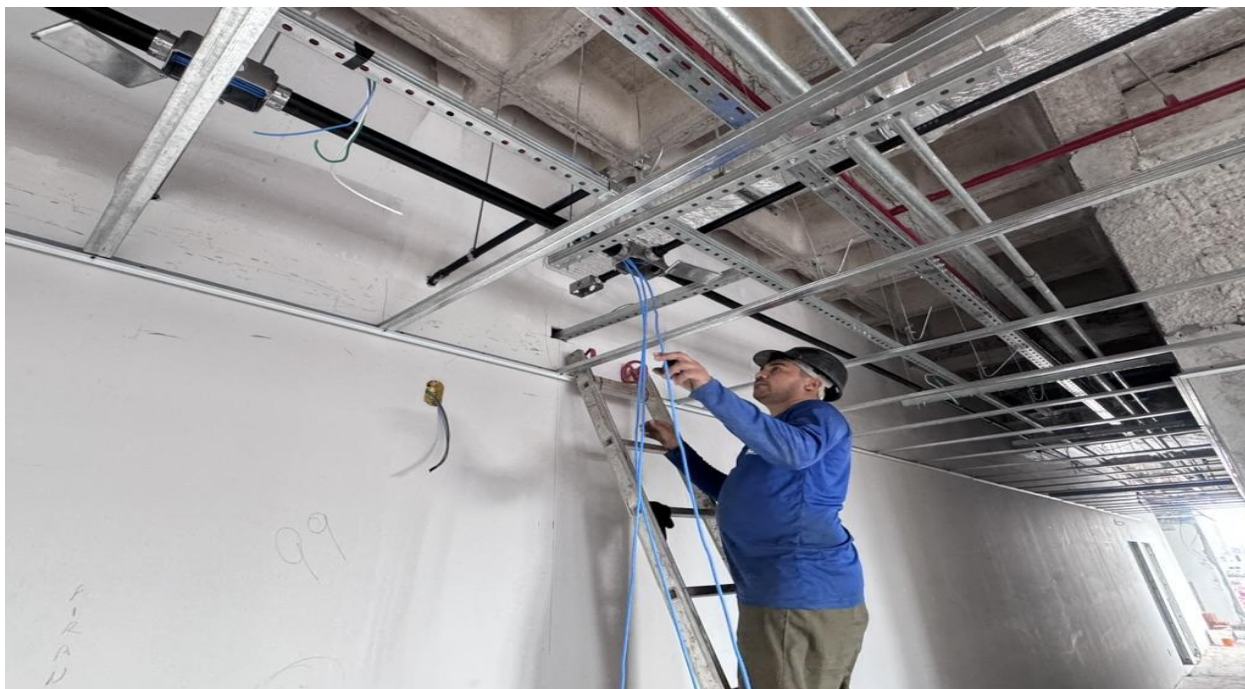
Figura 28. Instalação dos cabos e eletrodutos..
