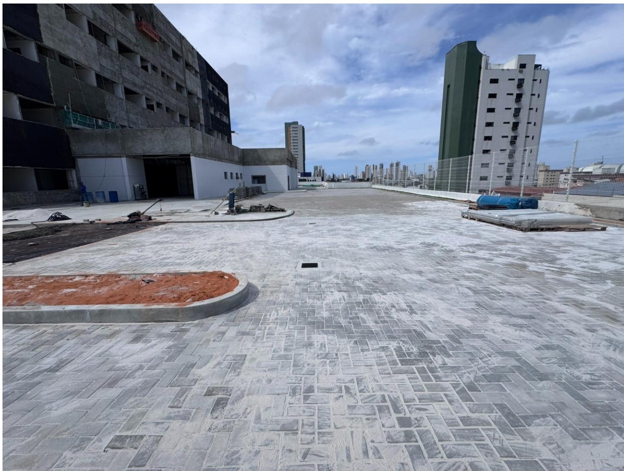
Figura 21. Instalação do piso intertravado..
