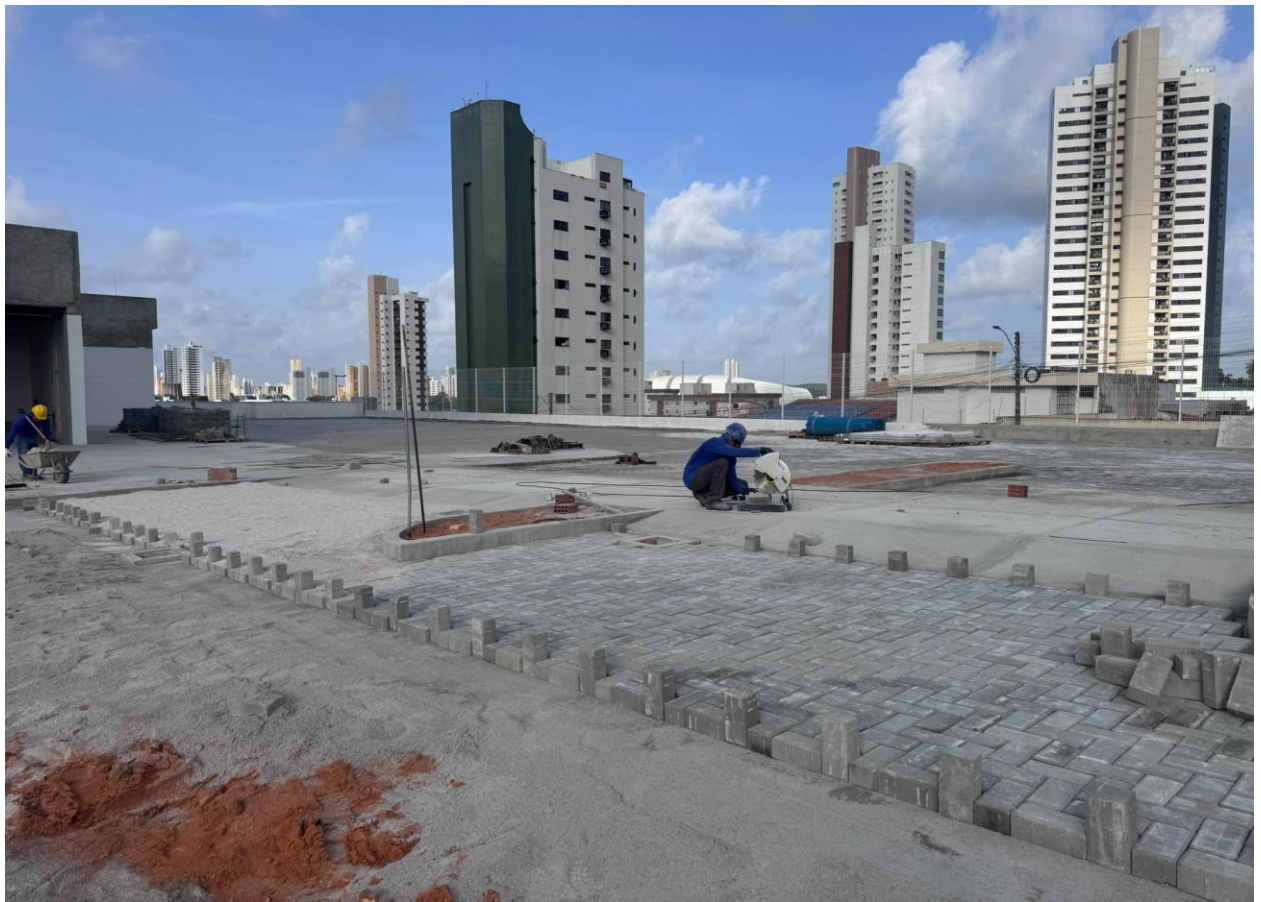
Figura 19. Instalação do piso intertravado.
