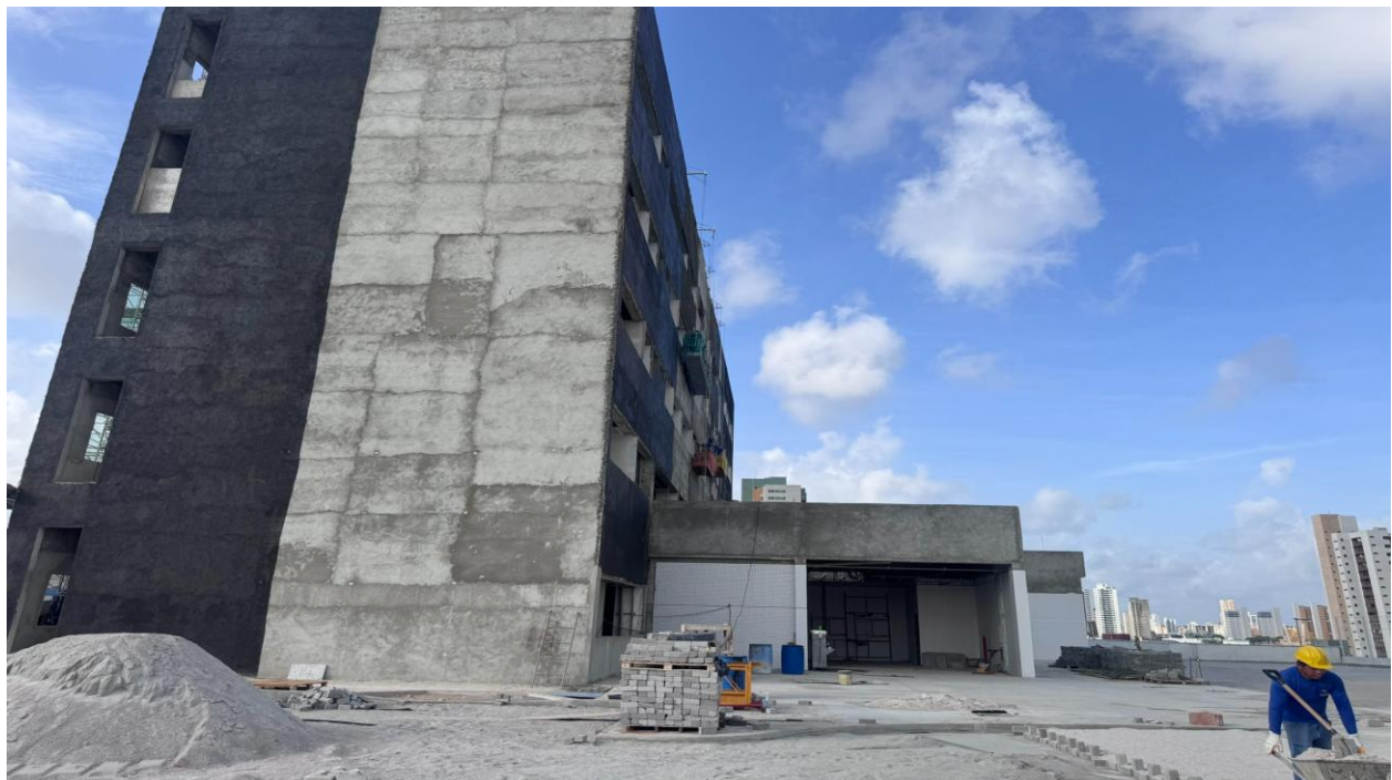
Figura 8. Aplicação de chapisco e emboço de na fachada lateral da edificação.
