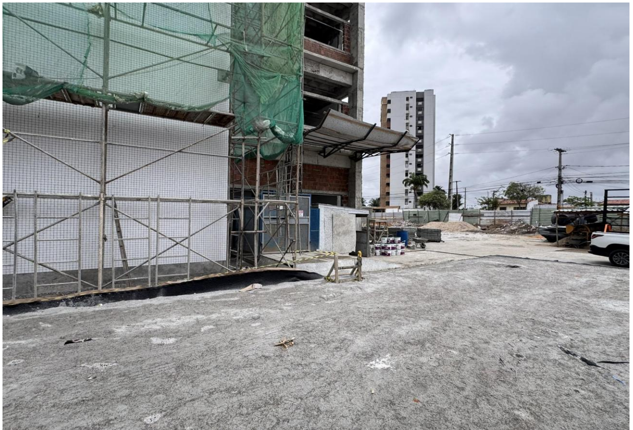
Figura 23. Execução de Manta têxtil drenante, Macdrain.
