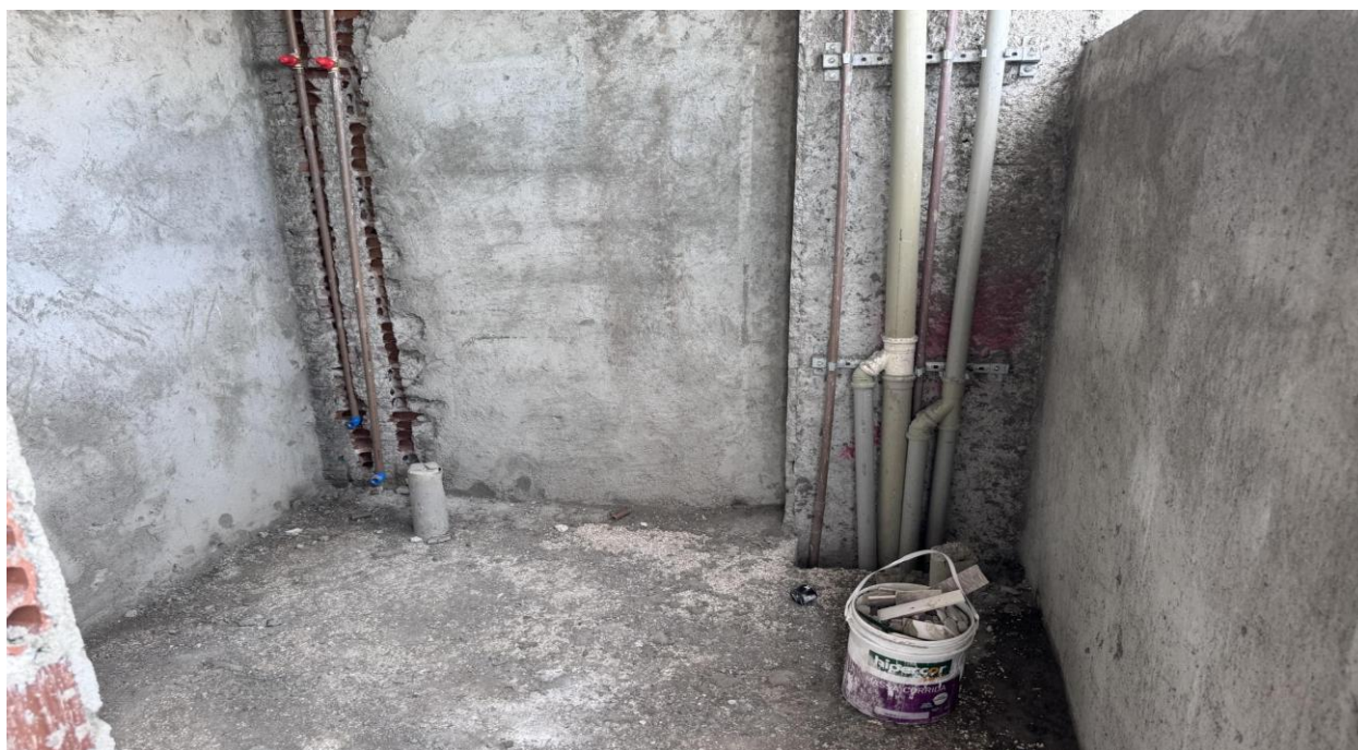
Figura 25. Passagem das tubulações no shaft do banheiro dos gabinetes.
