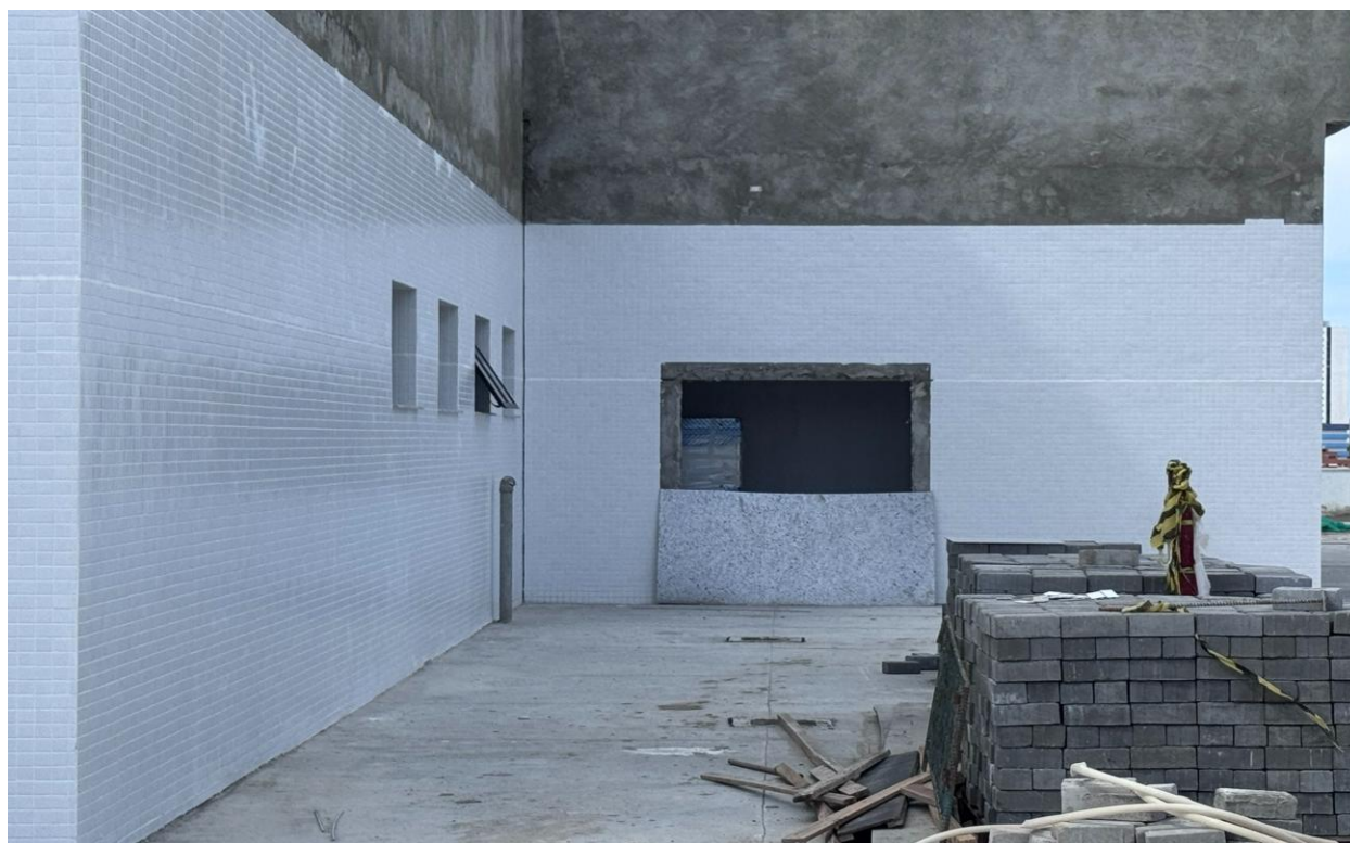
Figura 09. Assentamento de pastilhas cerâmicas na lateral do auditório.
