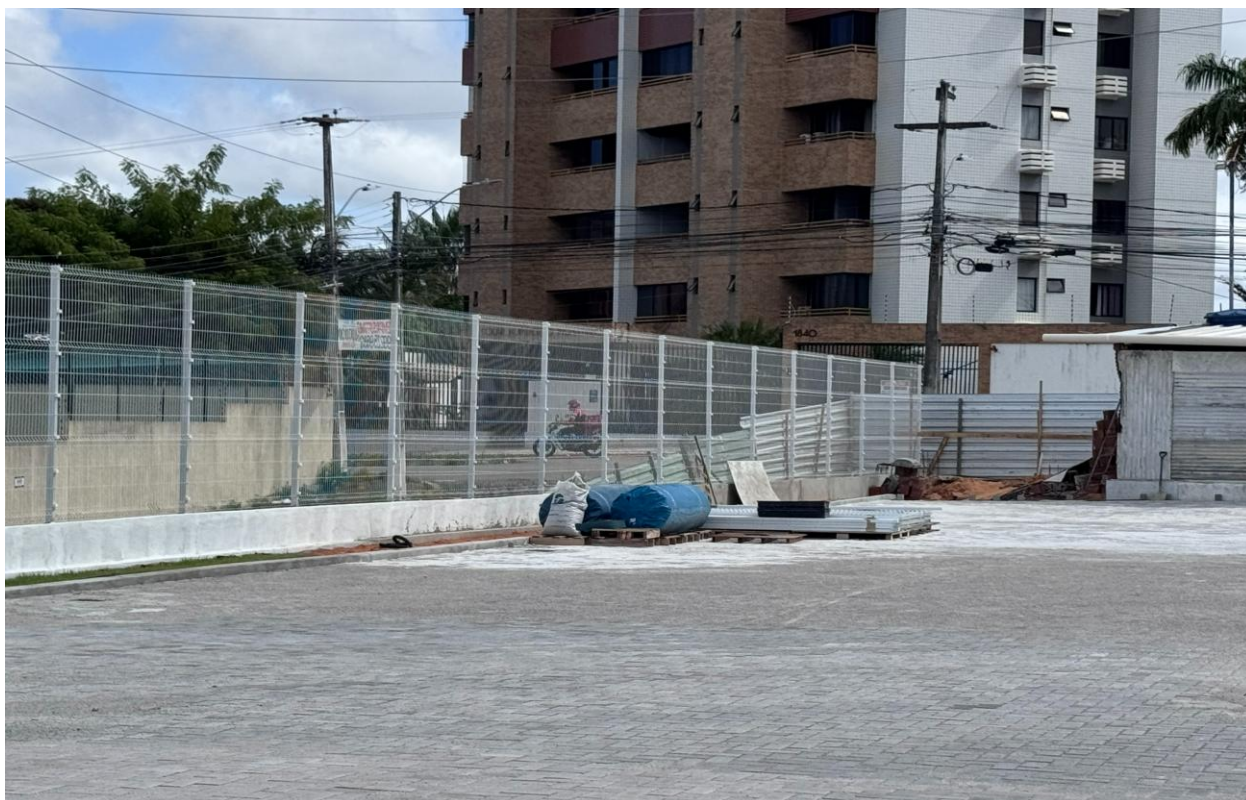
Figura 18. Instalação de gradil e mureta.
