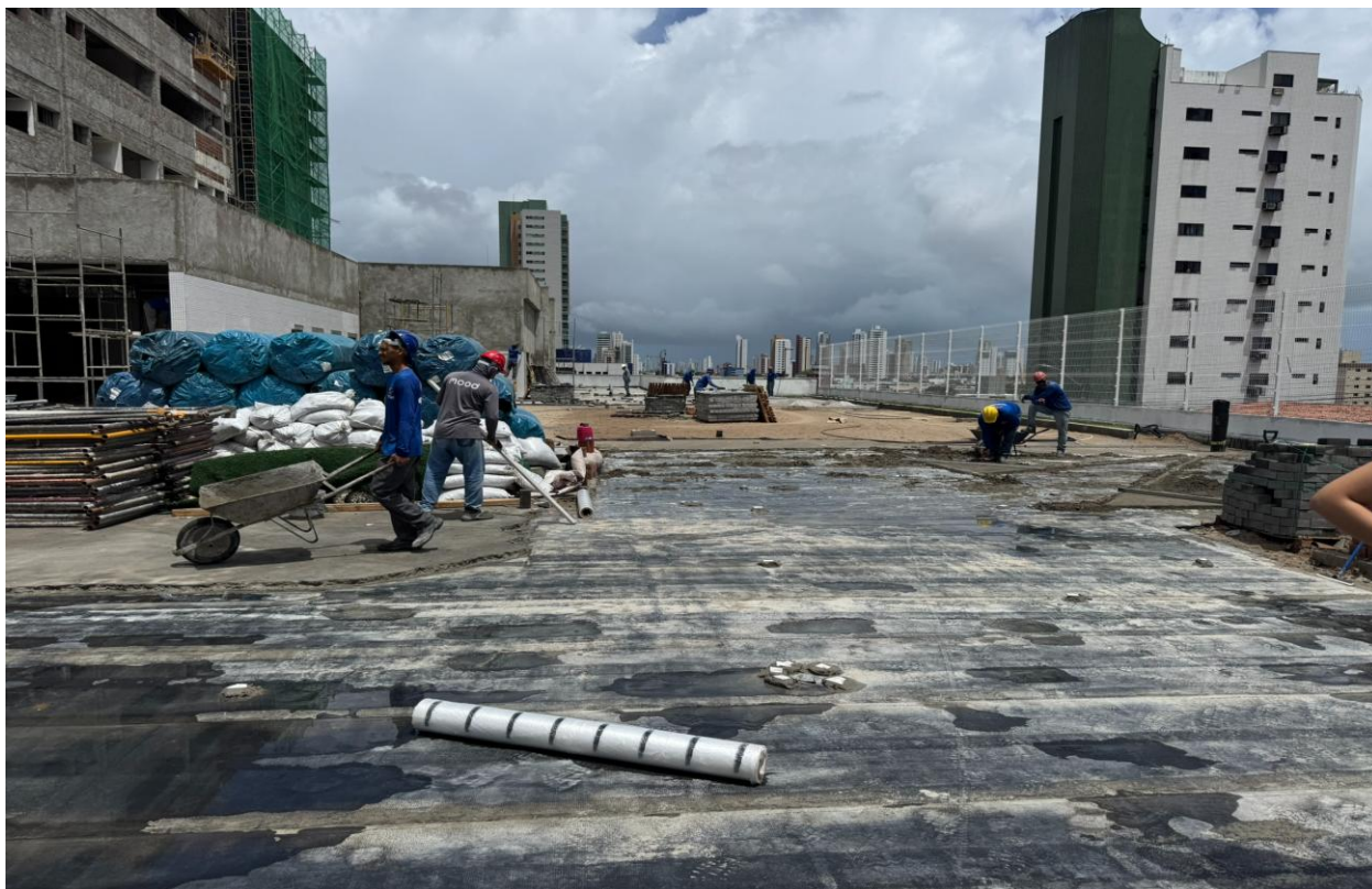
Figura 21. Aplicação de manta asfáltica dupla.
