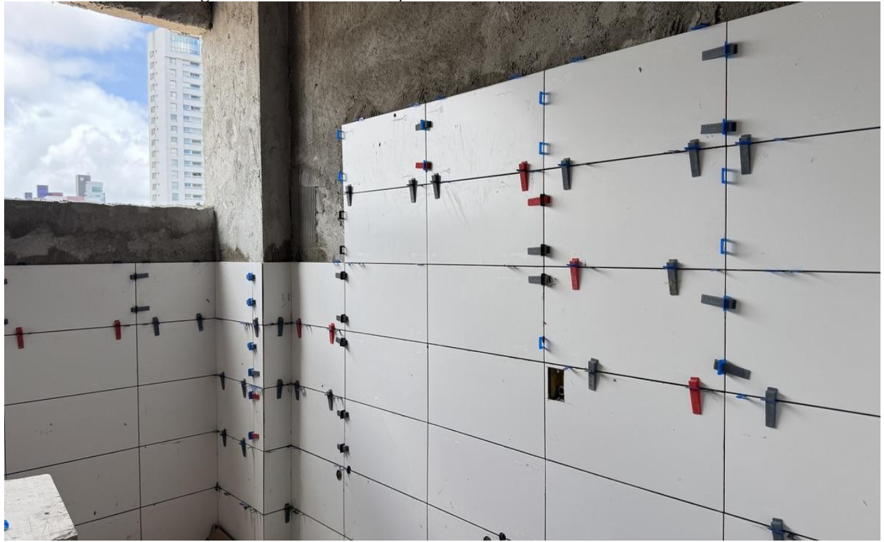
Figura 11. Assentamento de revestimento cerâmico 30x60cm nas paredes dos banheiros do 4o pavimento.
