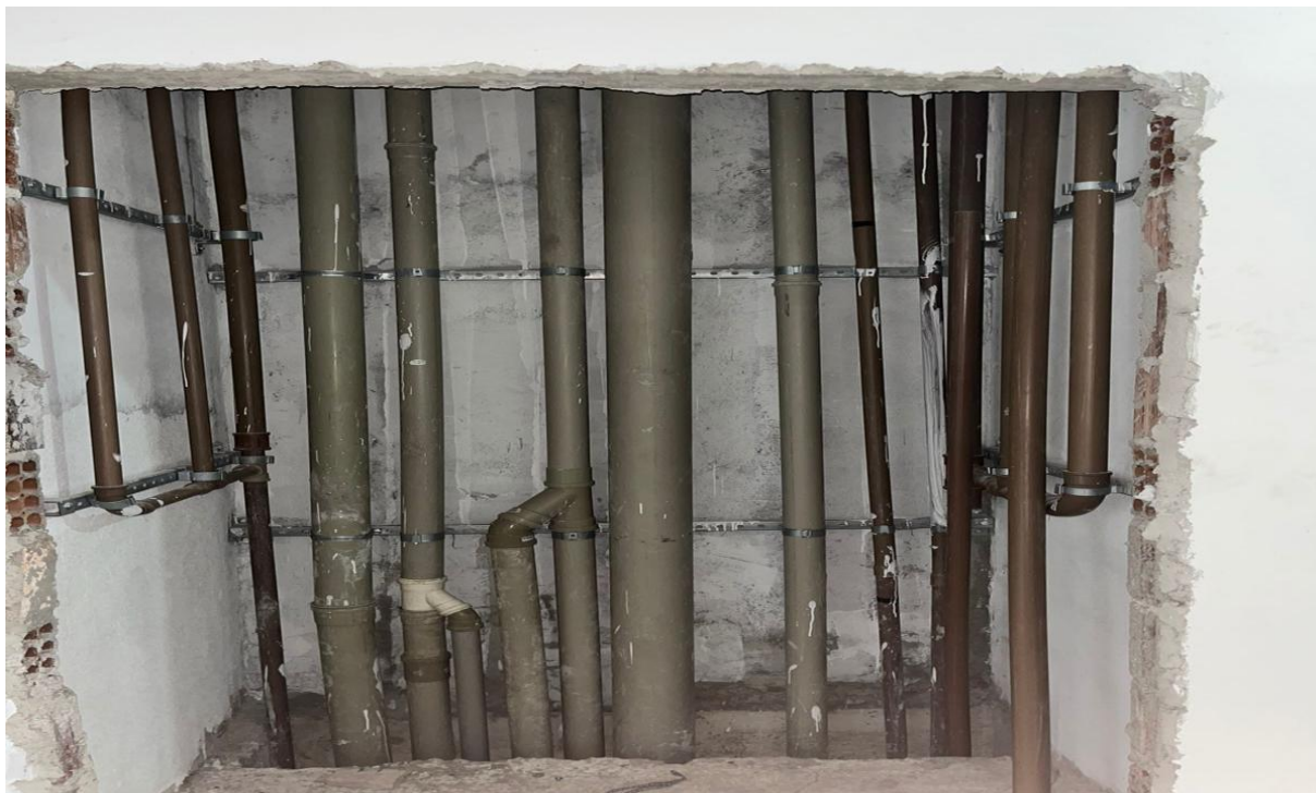
Figura 25. Passagem das tubulações no shaft do corredor.
