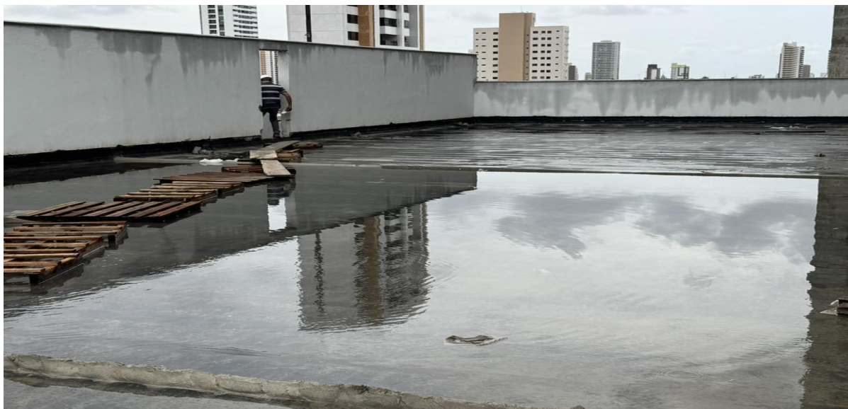
Figura 24. Teste de estanqueidade da manta asfáltica uma camada.
