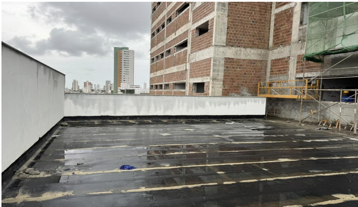
Figura 20. Aplicação de manta asfáltica dupla.
