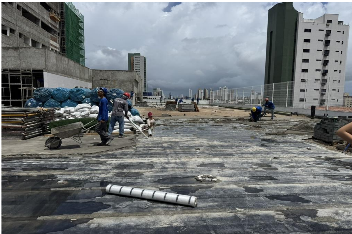
Figura 21. Aplicação de manta asfáltica dupla.
