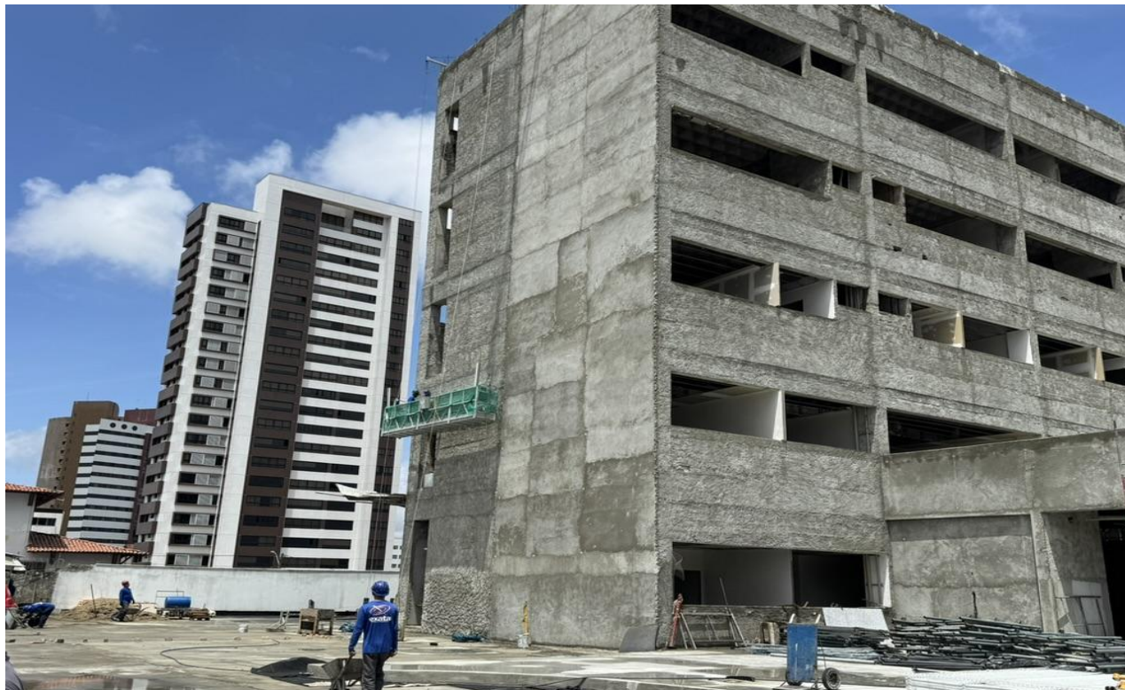
Figura 7. Aplicação de chapisco e emboço de na fachada frontal e lateral da edificação.
