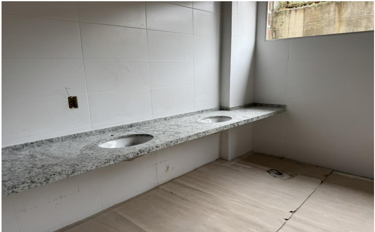
Figura 13. Bancada em granito instalada no banheiro coletivo do pavimento térreo.
