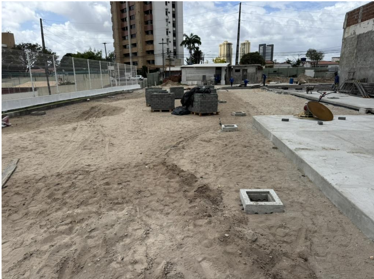
Figura 15. Concretagem da calçada e piso cimentado na entrada do prédio e preparo para aplicação do piso intertravado.
