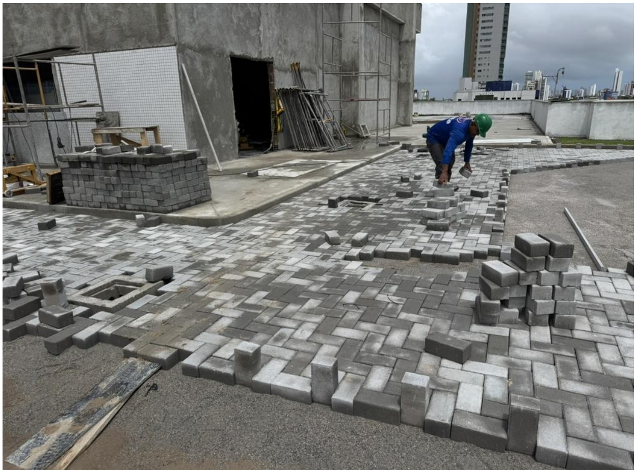
Figura 17. Instalação do piso intertravado ao lado da calçada do auditório.
