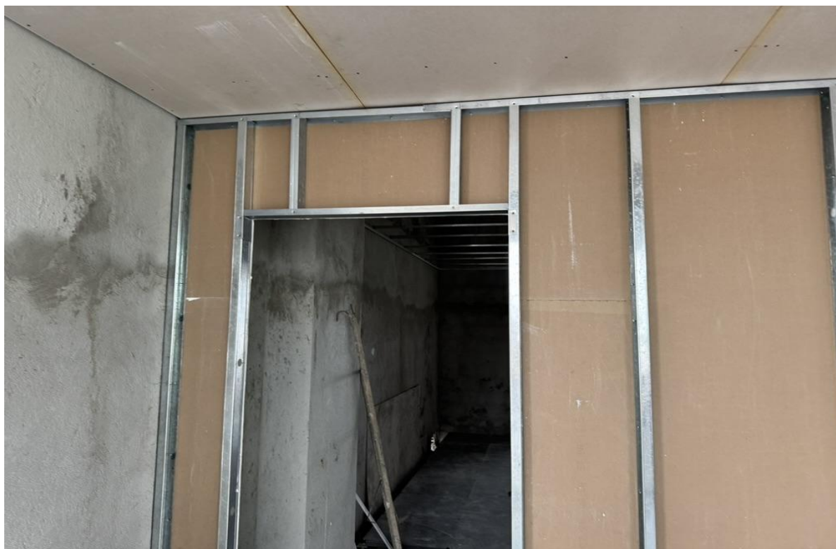
Figura 2. Instalação de paredes Drywall no 4o pavimento, aguardando o preenchimento com a lã de rocha para fechamento.
