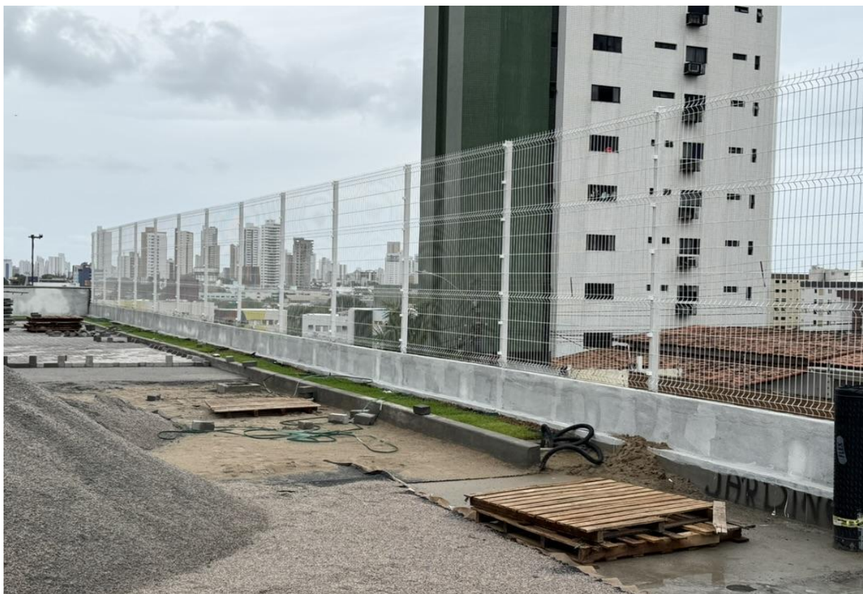
Figura 18. Instalação do Instalação de gradil e mureta.
