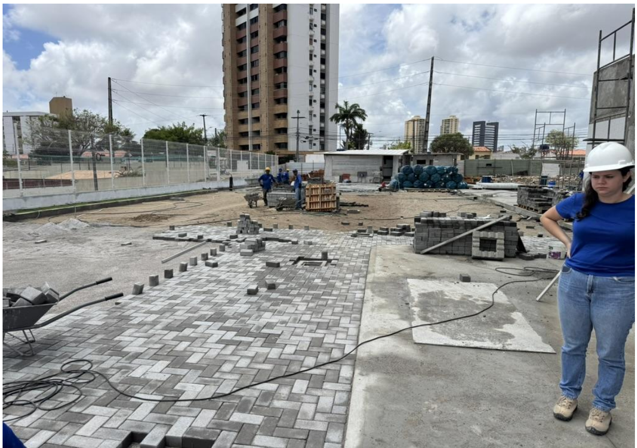
Figura 16. Instalação do piso intertravado.
