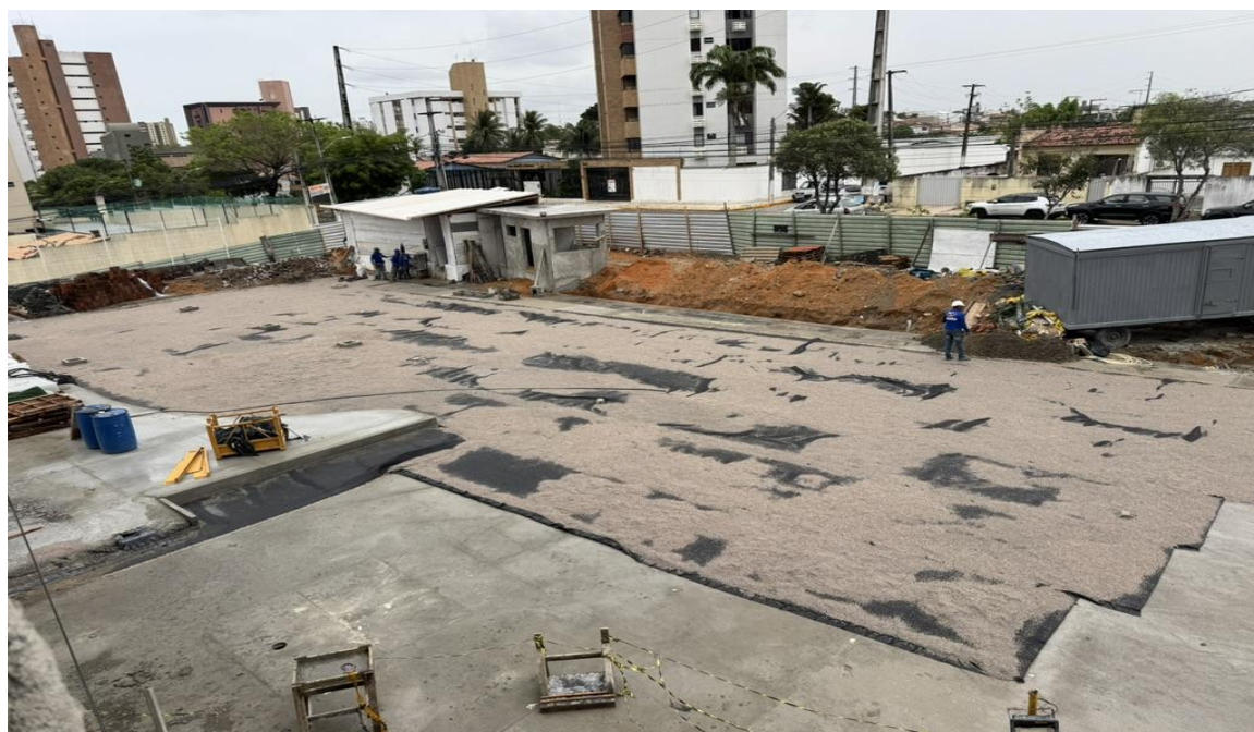
Figura 23. Execução de Manta têxtil drenante, Macdrain.
