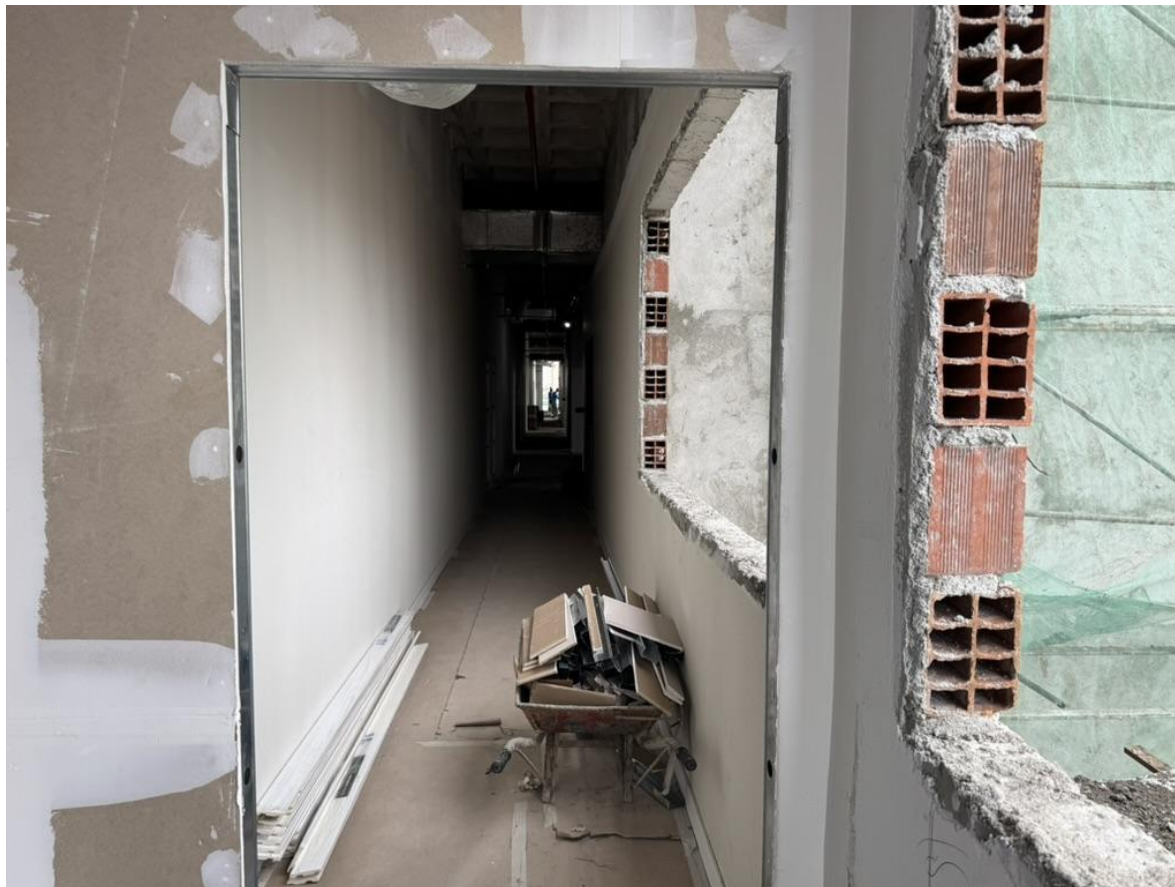
Figura 4. Instalação do piso no corredor de acesso aos banheiros acessíveis do 3o pavimento.
