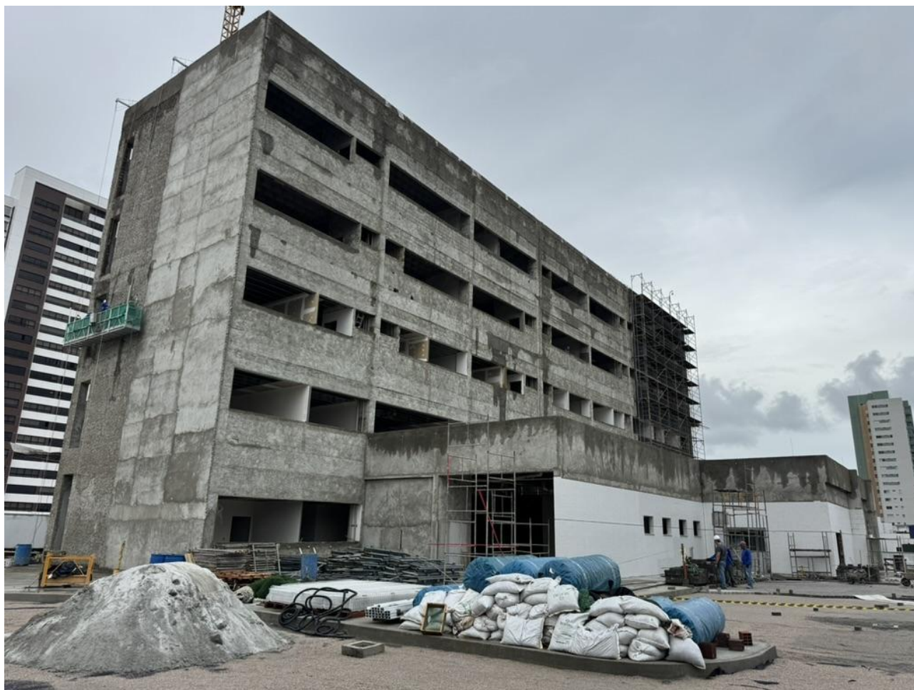
Figura 1. Visão geral da obra.
