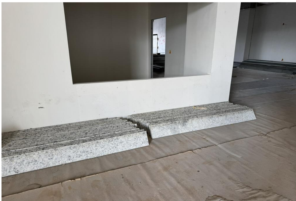
Figura 6. Soleiras para serem instaladas.
