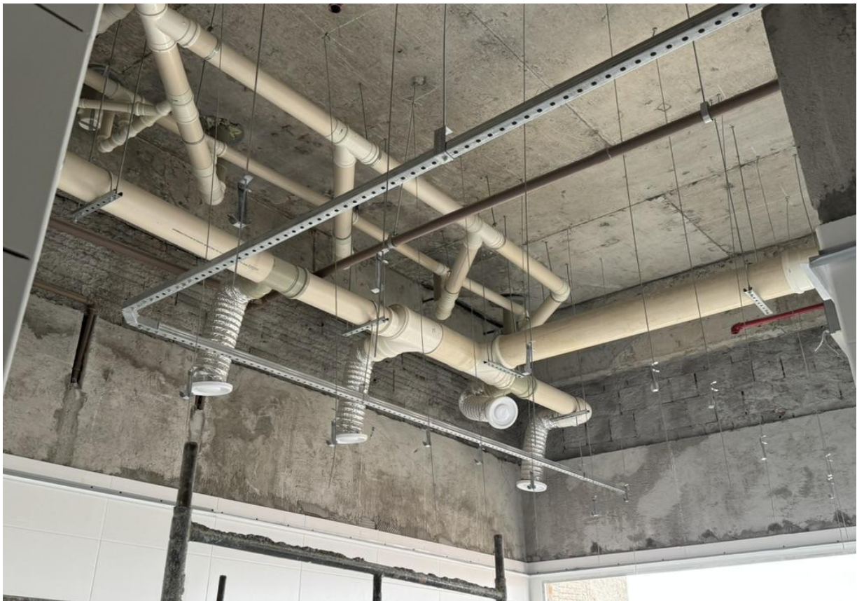
Figura 25 .Detalhe da tubulação da rede de esgoto.
