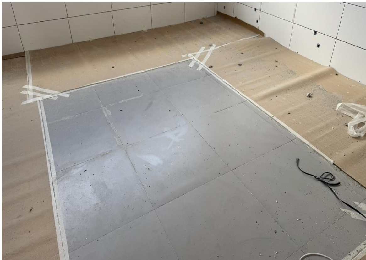
Figura 6. Piso dos banheiros coletivos no 2o pavimento.
