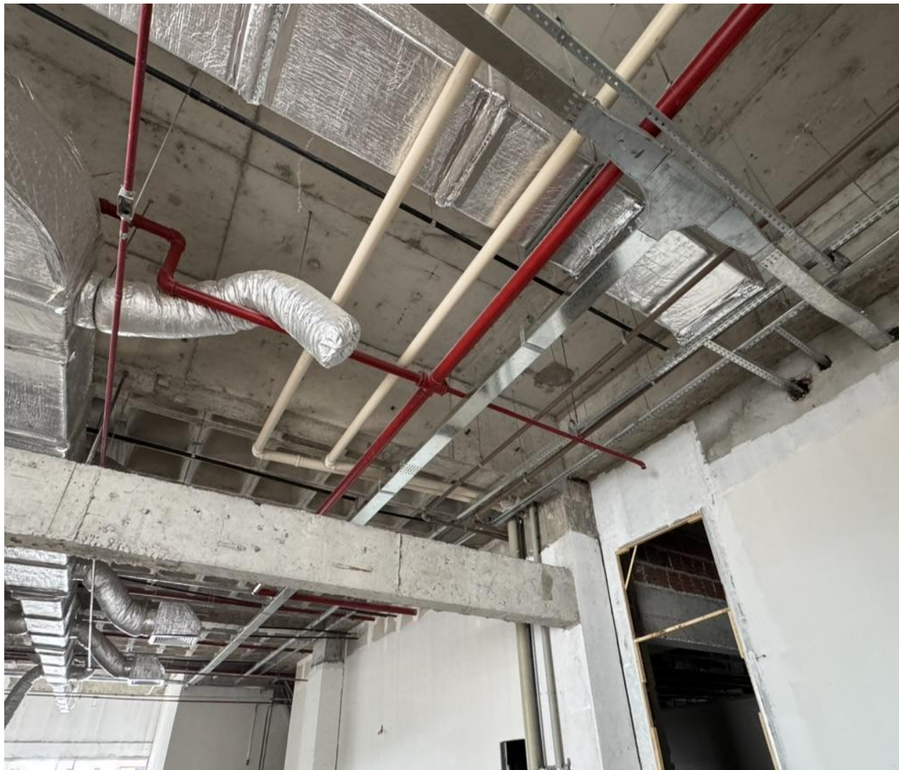
Figura 27. Instalação das eletrocalhas da infraestrutura das instalações elétricas no térreo .
