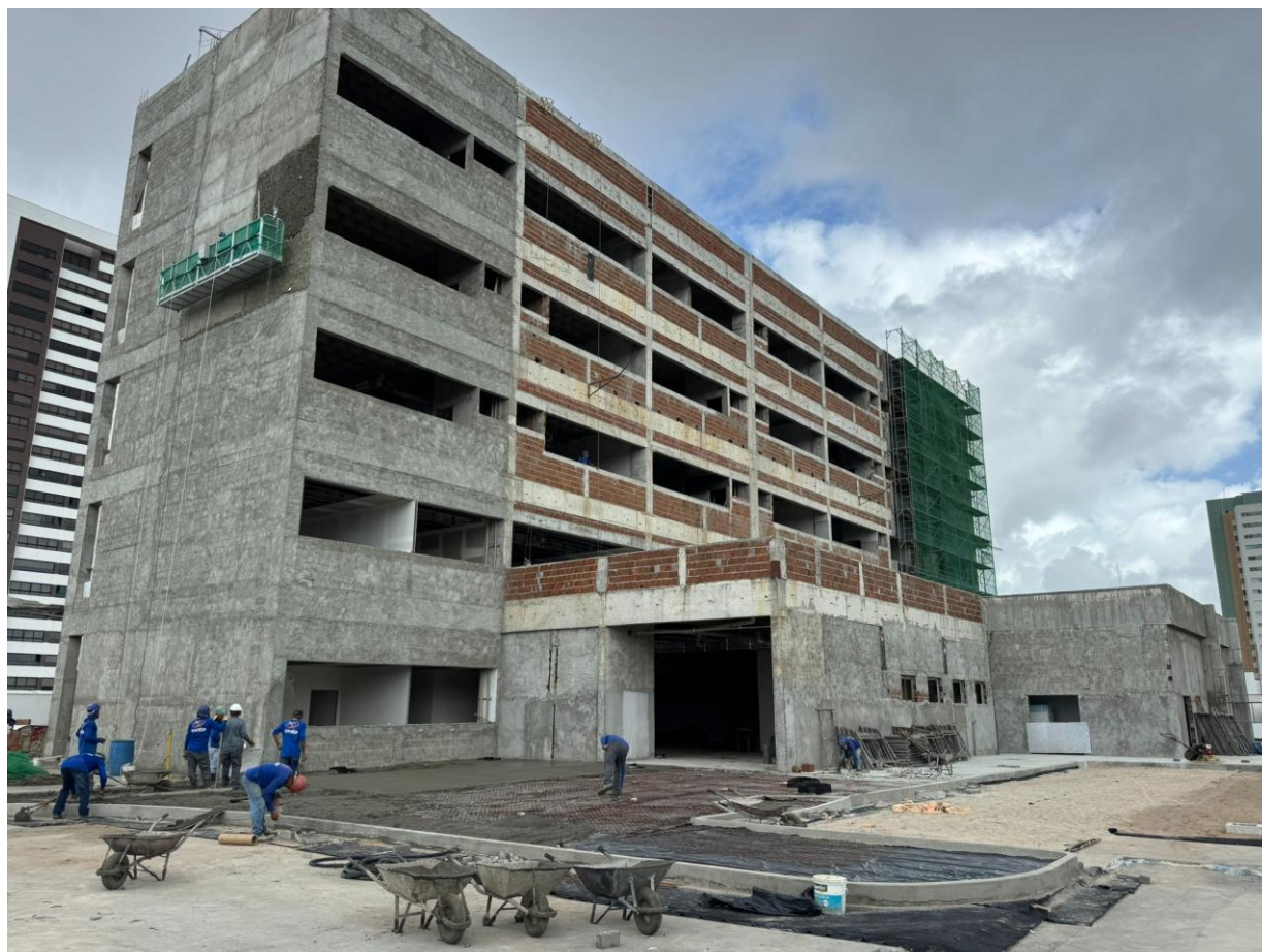
Figura 1. Visão geral da obra.
