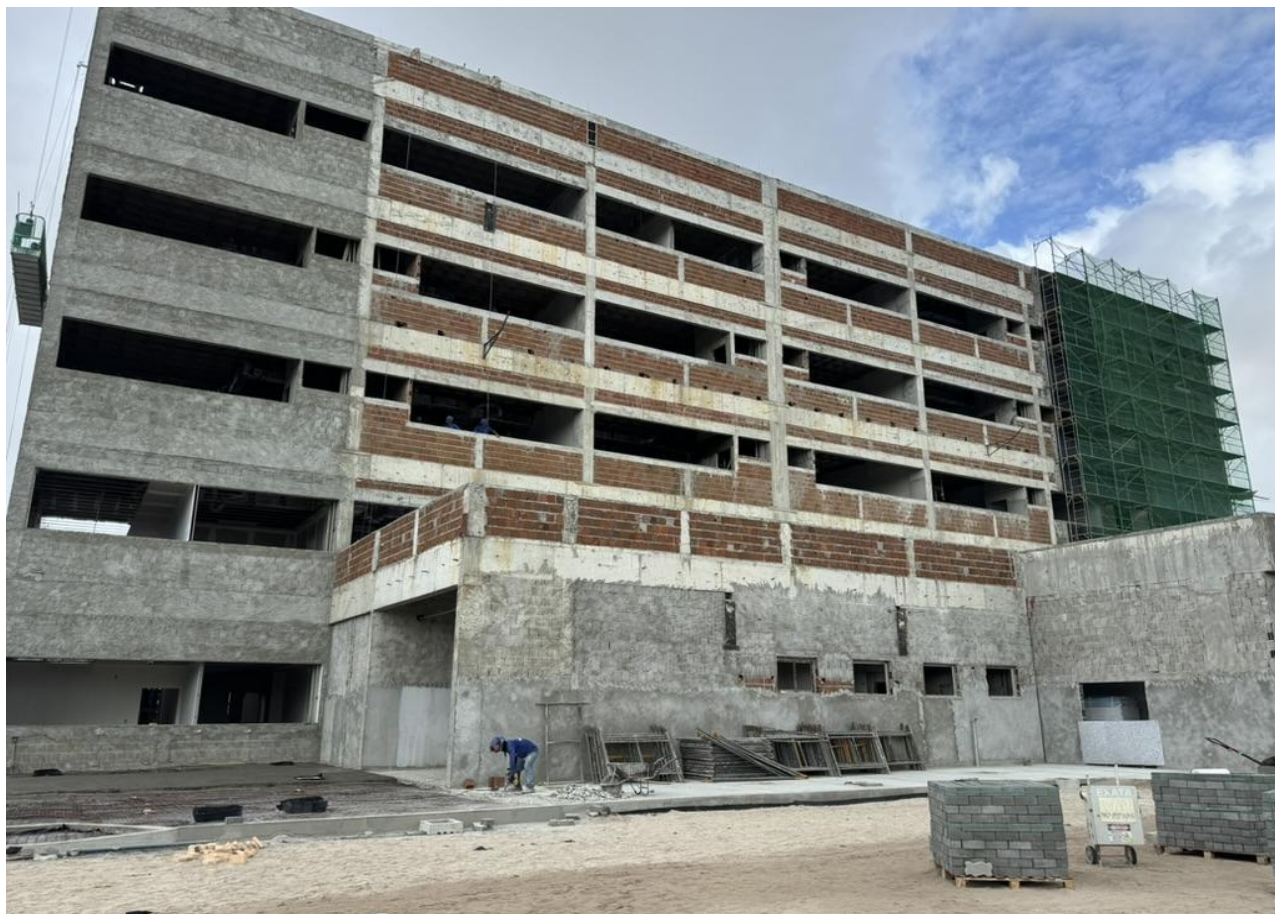
Figura 9. Aplicação de chapisco e emboço de na fachada frontal da edificação.
