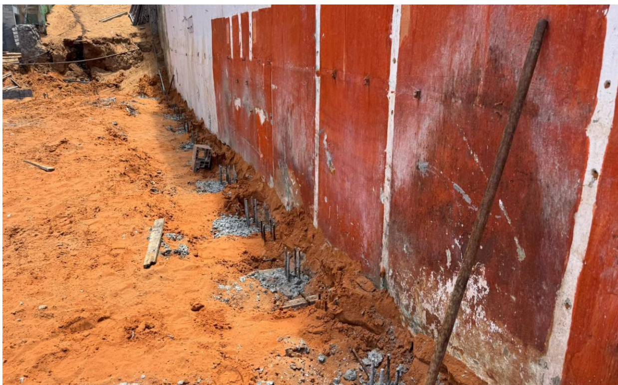
Figura 2. Concretagem das estacas na lateral da casa do lixo..
