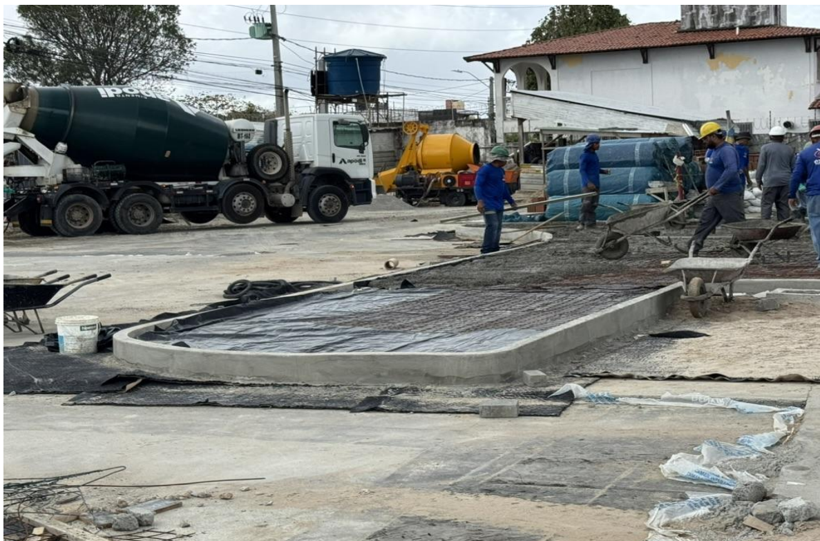
Figura 14. Execução de meio-fio..
