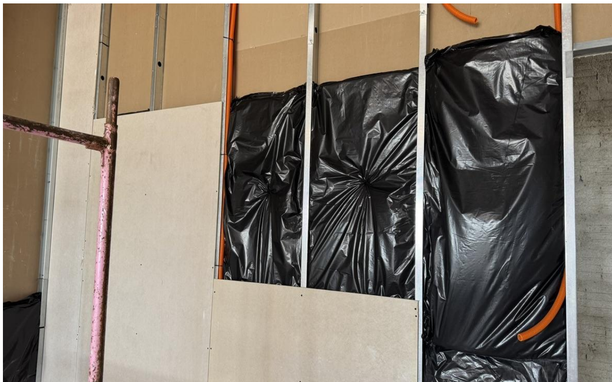
Figura 4. Instalação de lã de rocha em paredes Drywall no 1º pavimento.
