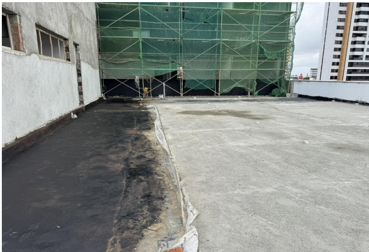
Figura 17. Execução de proteção mecânica para manta asfáltica dupla na laje do térreo.
