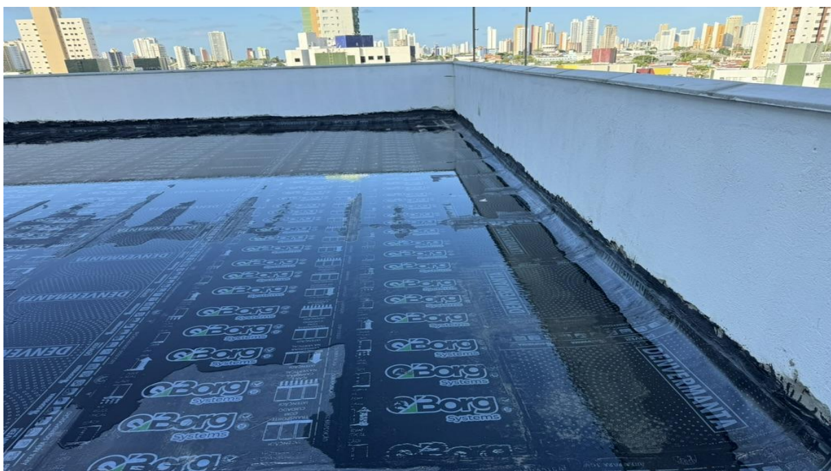
Figura 20. Execução de Manta têxtil drenante, Macdrain.
