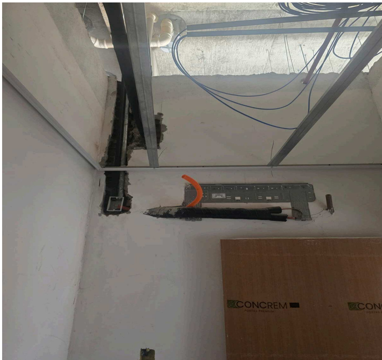
Figura 30 Instalação de tubulação frigorígena.
