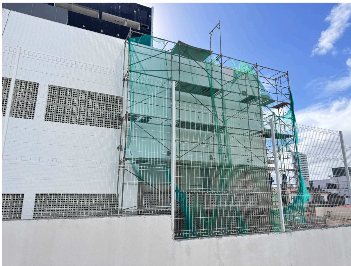
Figura 4 Fechamento das paredes da sala do gerador com alvenaria e cobogós.
