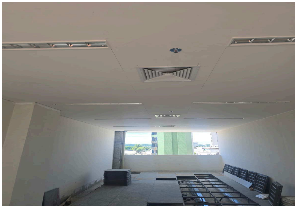
Figura 28 Instalação das luminárias em LED.
