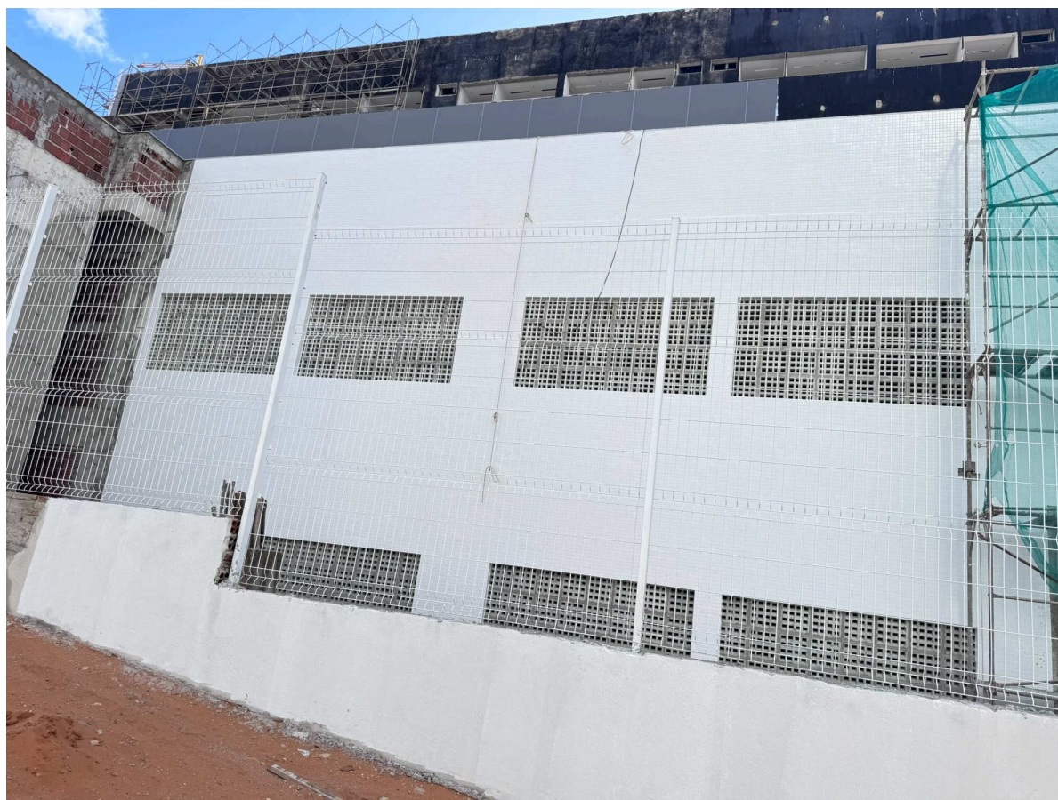
Figura 9 Aplicação de pastilhas cerâmicas na parede lateral dos pavimentos semienterrados 1 e 2.
