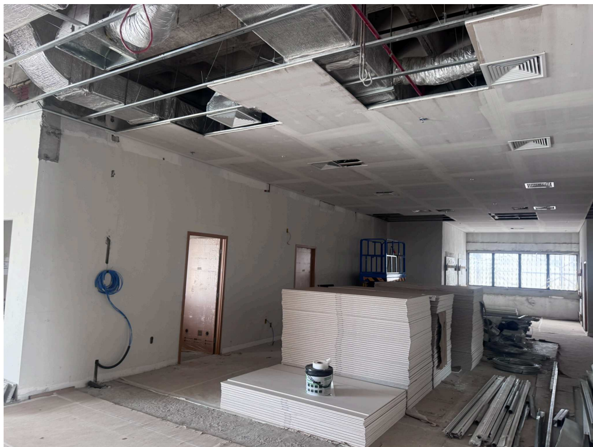
Figura 10 Aplicação do forro drywall nos ambientes internos.
