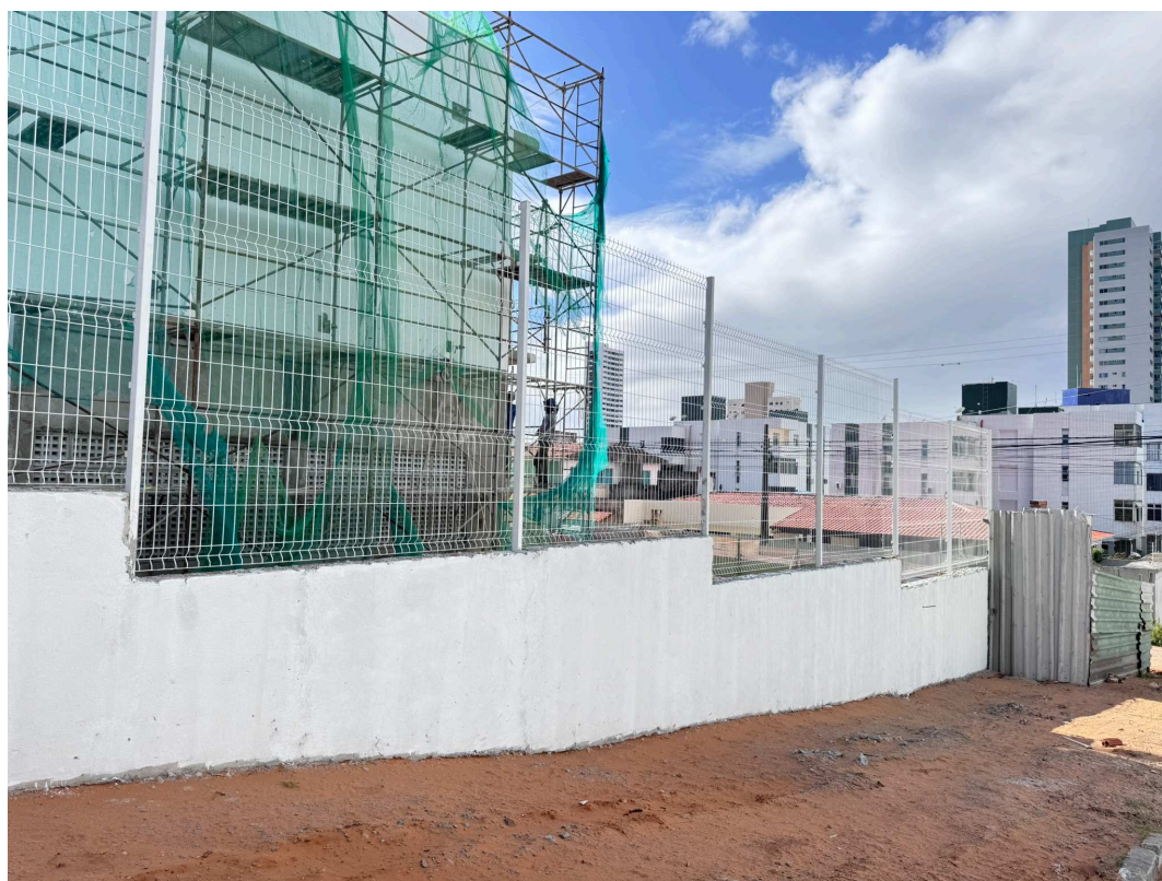
Figura 18 Instalação das muretas e gradil na lateral leste da edificação.
