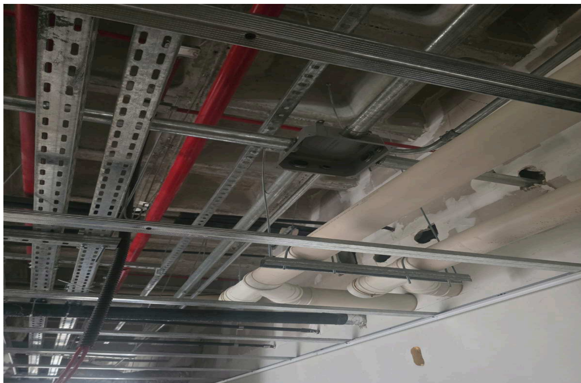
Figura 26 Instalação da estrutura elétrica.
