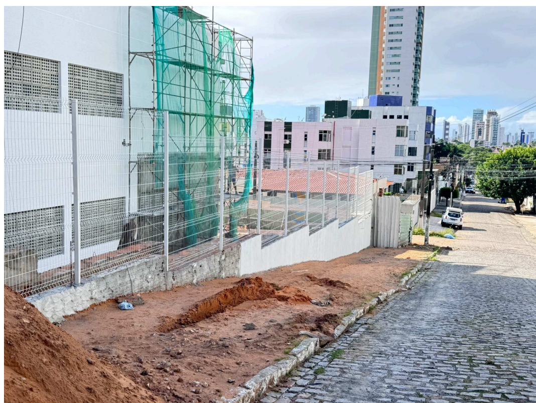
Figura 3 Execução de mureta e gradil na lateral leste.
