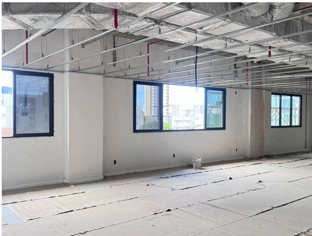
Figura 17 Instalação das esquadrias no refeitório.
