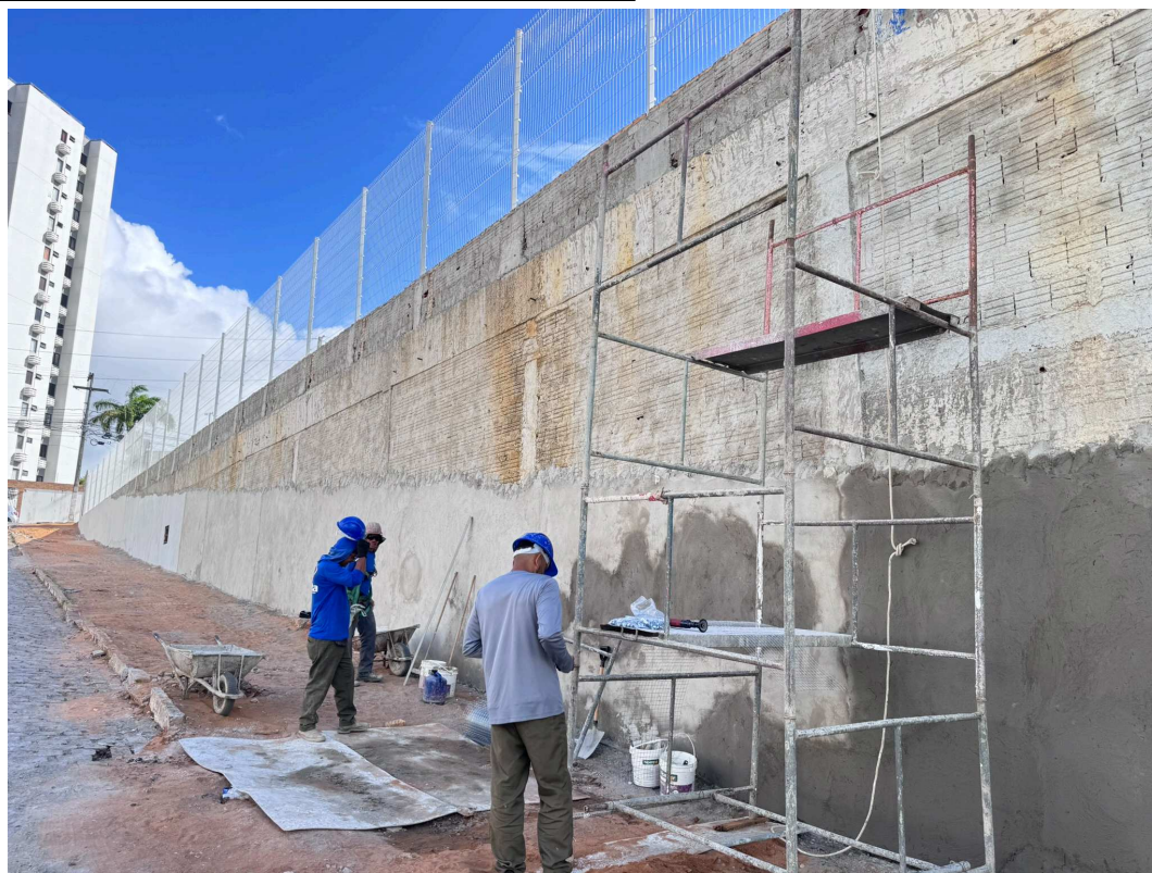
Figura 2 Execução do fechamento do muro em L.
