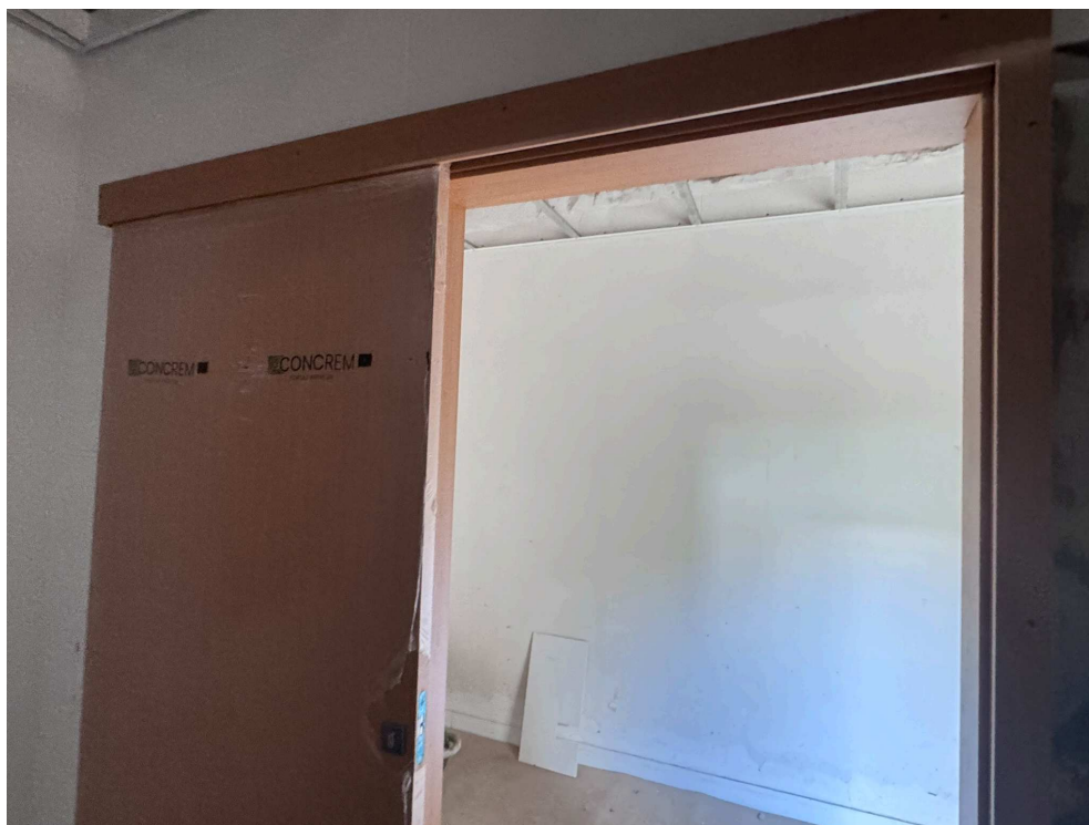
Figura 13 Instalação das portas de correr nos banheiros PCD.
