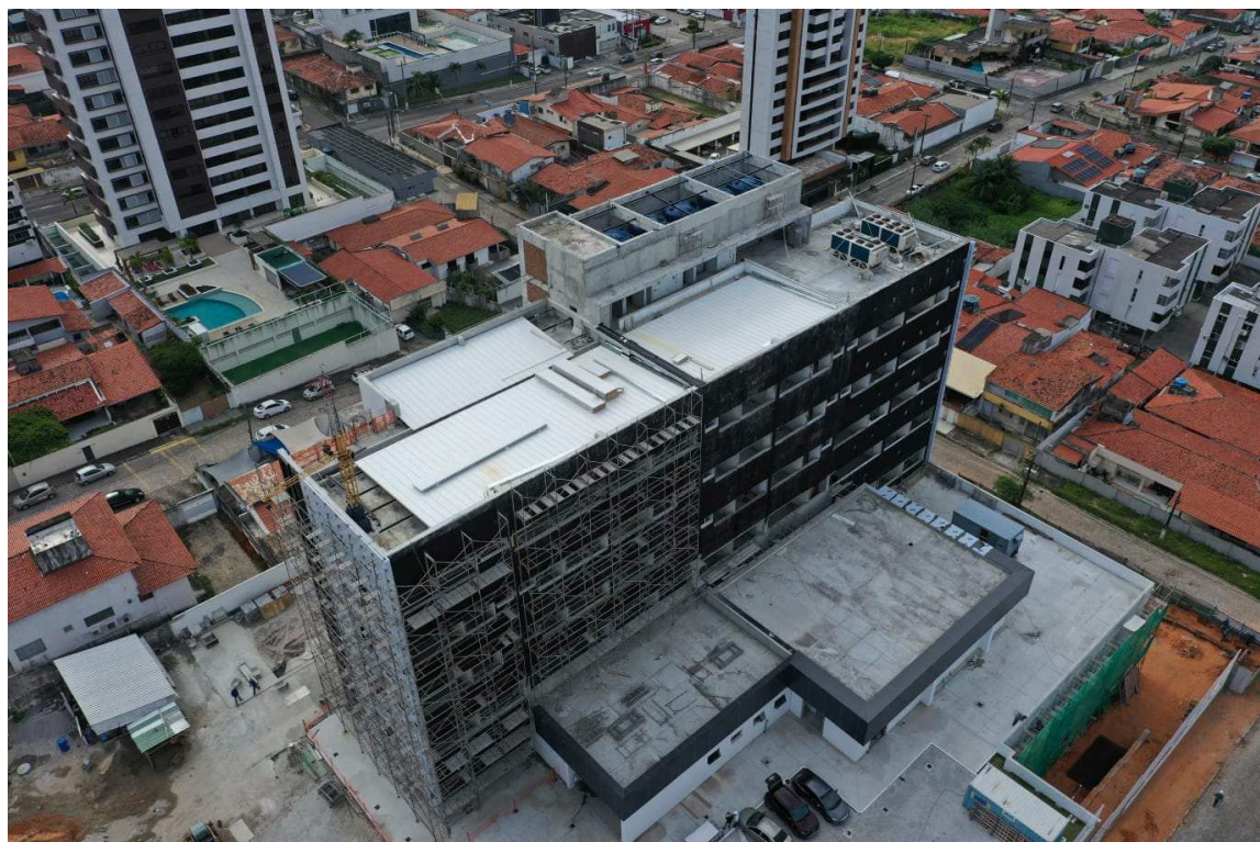
Figura 22 Fachada impermeabilizada com aplicação de emulsão asfáltica.
