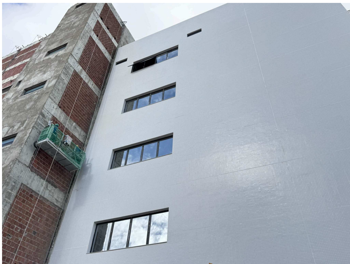
Figura 7 Instalação da junta de dilatação na fachada da edificação.
