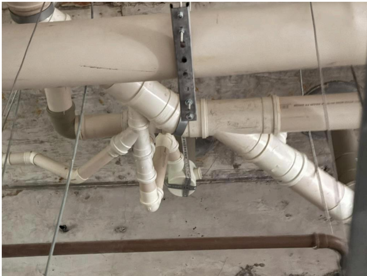
Figura 23 Sistema de esgotamento sanitário.
