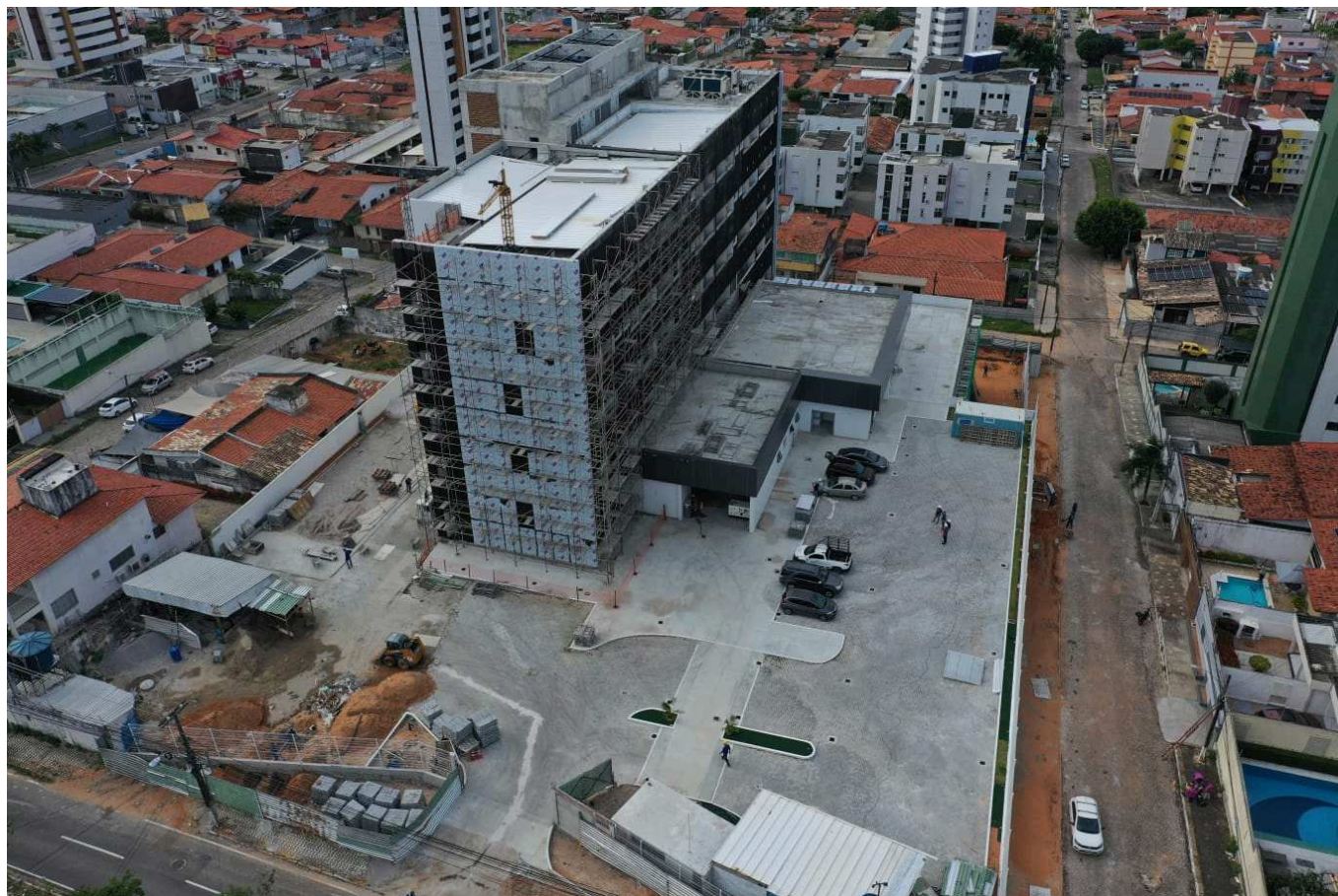
Figura 1. Visão geral da obra.
