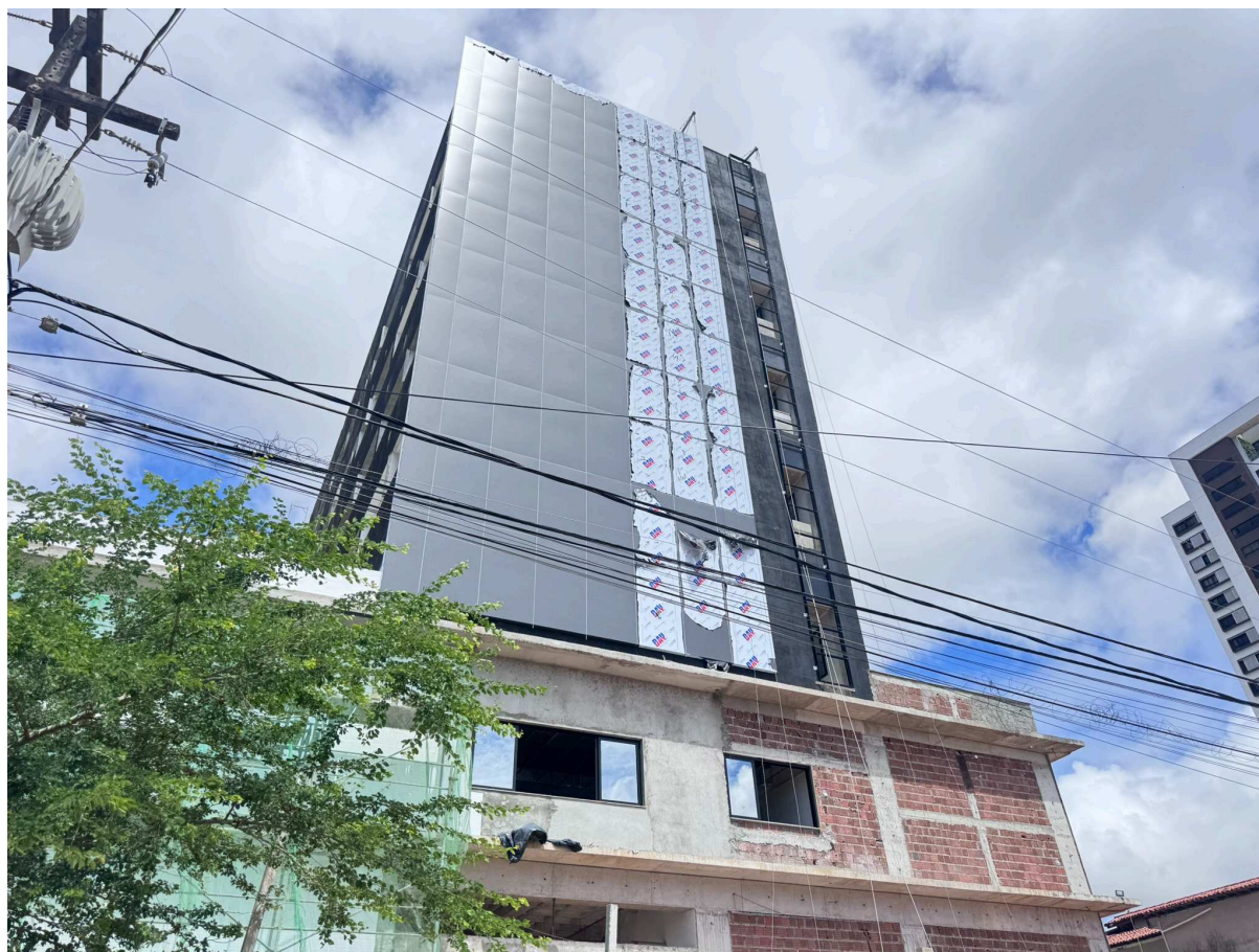
Figura 8 Instalação do ACM na fachada lateral norte da edificação.
