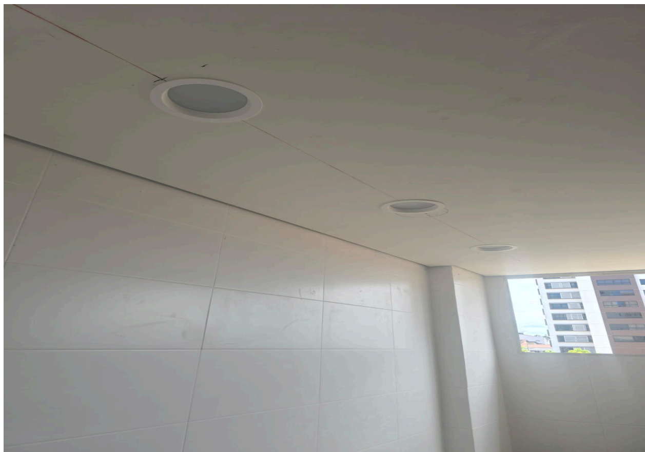
Figura 27 Instalação das luminárias em LED circulares.
