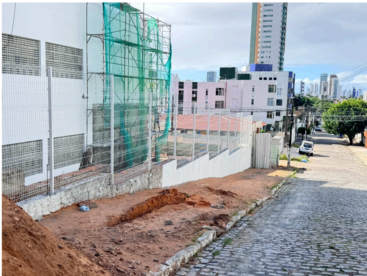
Figura 21 Instalação das muretas e gradil na lateral leste da edificação.
