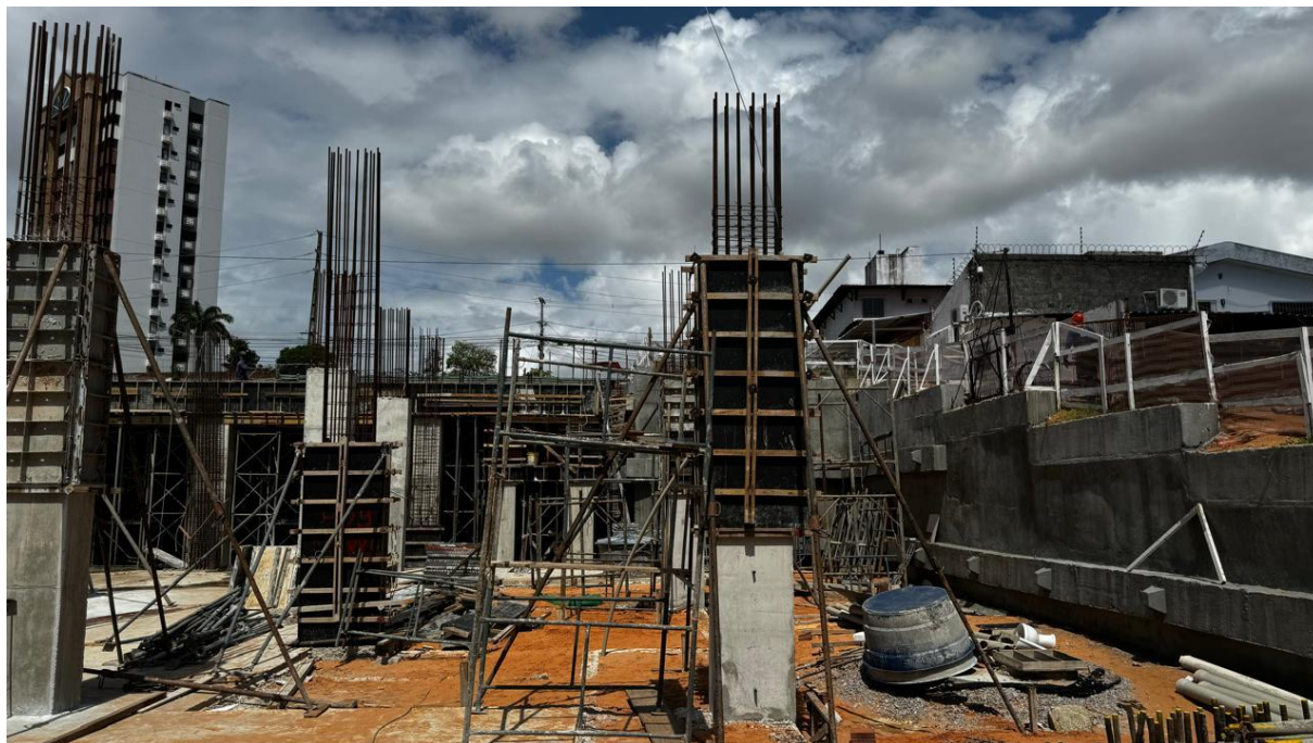
Figura 2. Concretagem do segundo trecho dos Pilares do segundo subsolo.
