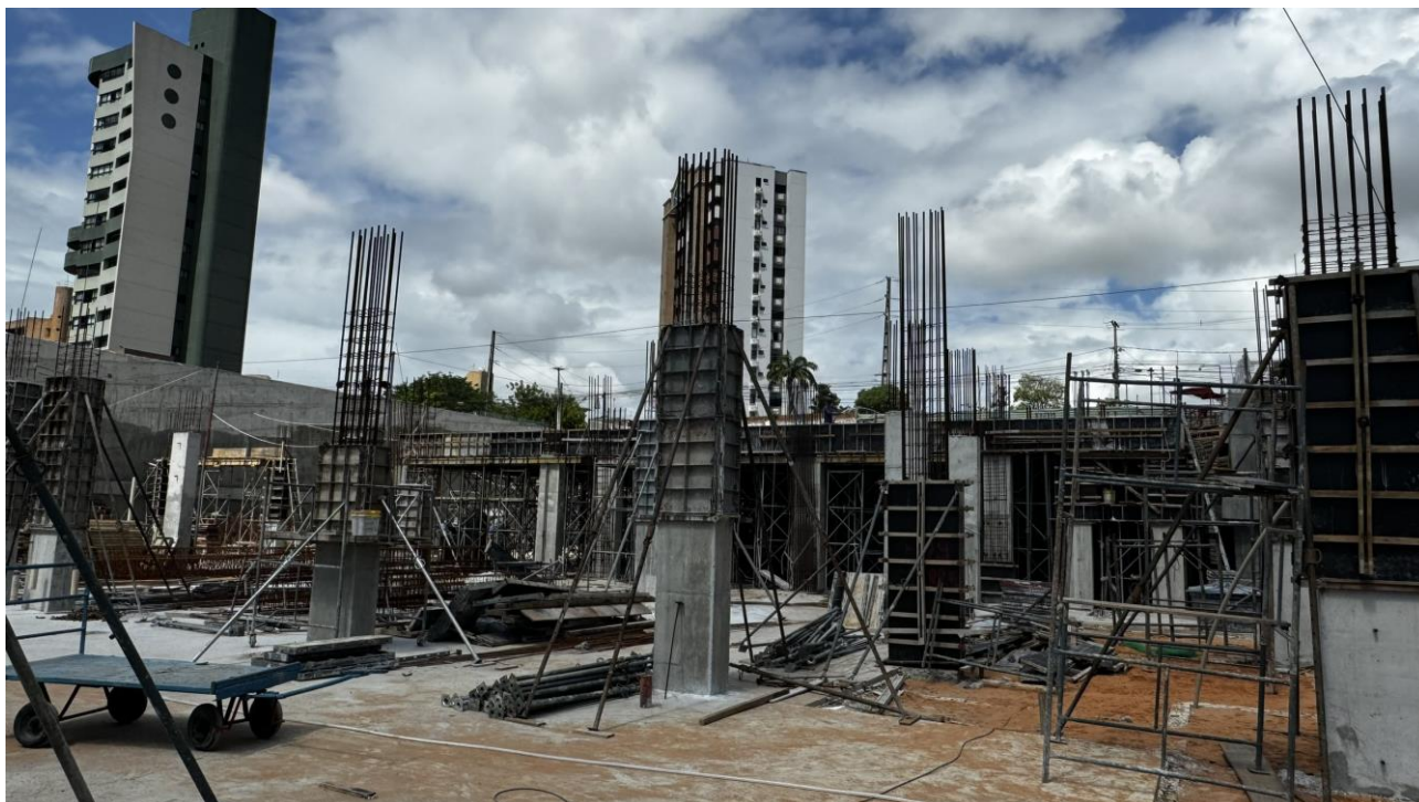
Figura 4. Visão geral dos pilares do segundo subsolo e de parte da laje de cobertura do segundo subsolo.
