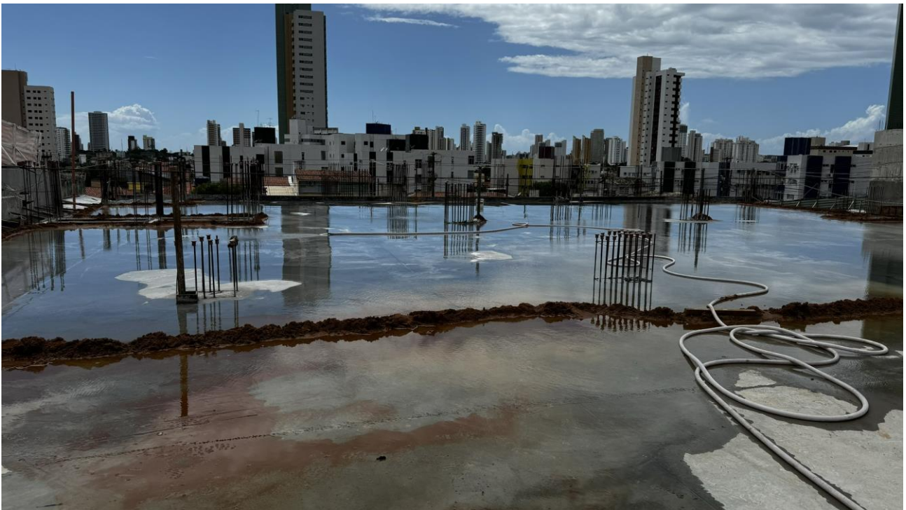
Figura 7. Laje de cobertura do segundo subsolo concretada.
