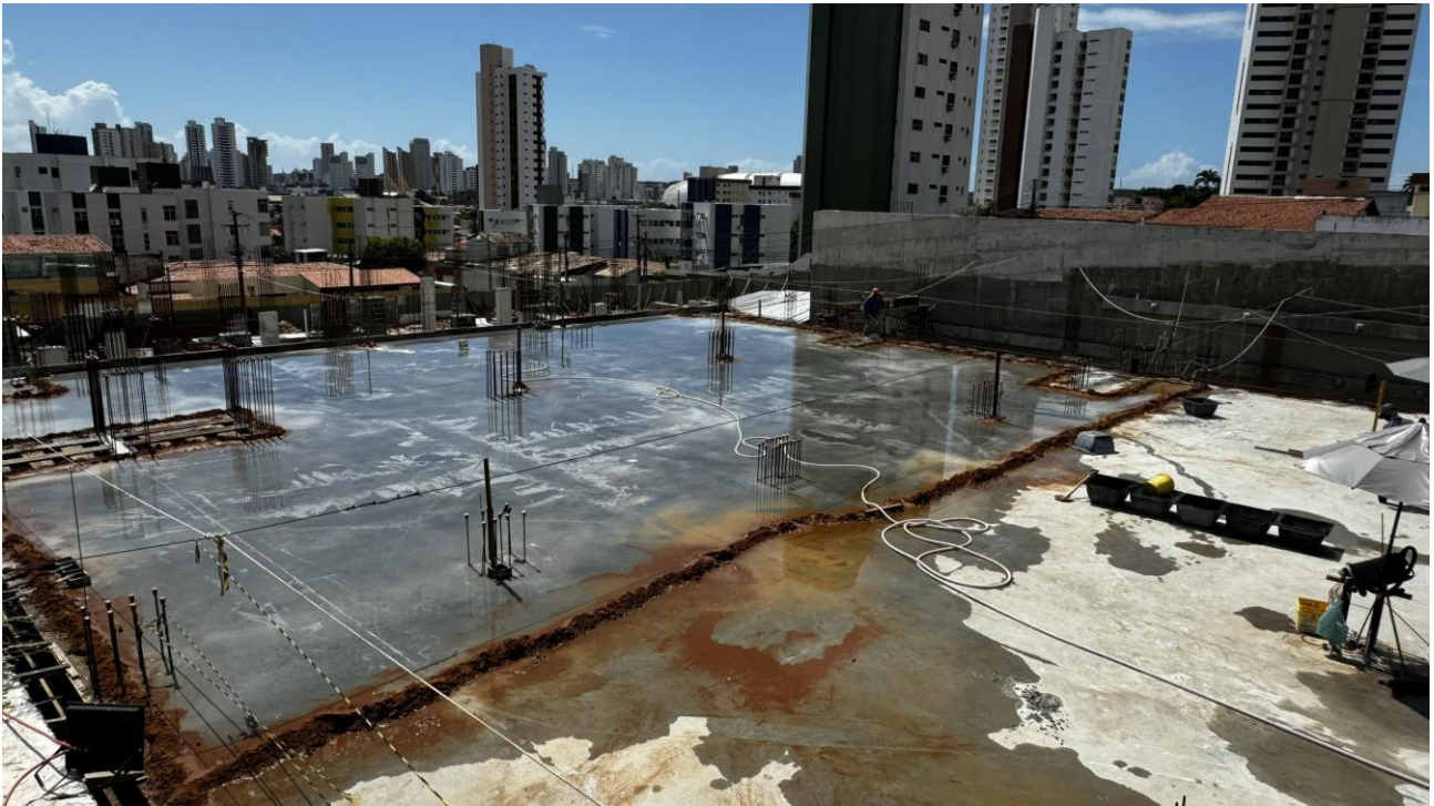
Figura 6. Local da laje do segundo subsolo onde foi concretada parte da laje de cobertura do segundo subsolo.
