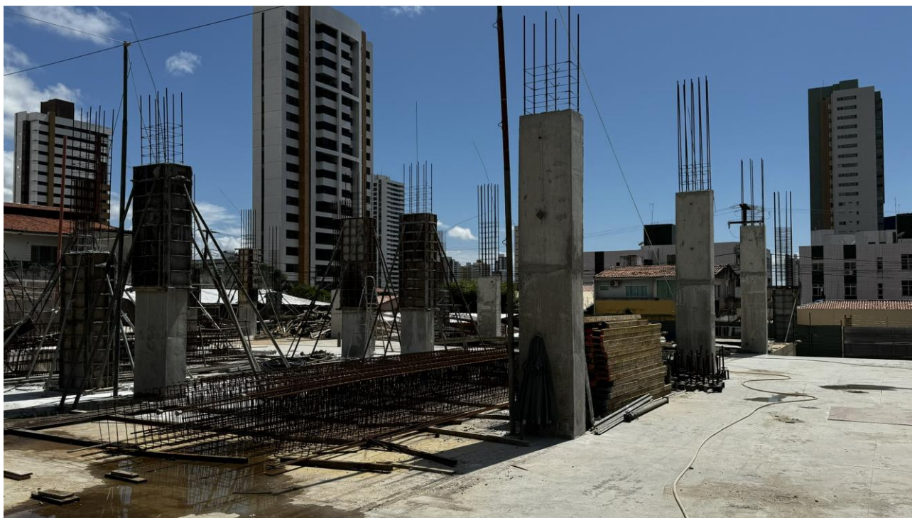
Figura 5. Pilares do segundo subsolo.
