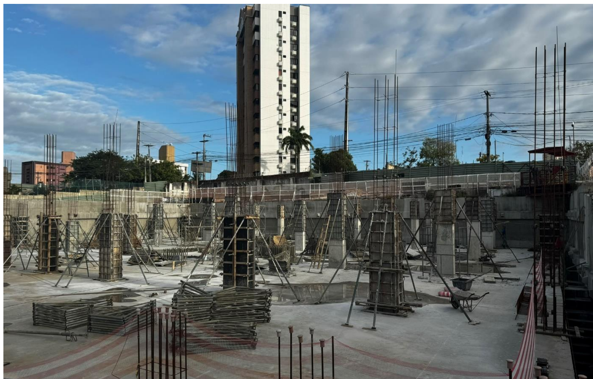
Figura 4. Visão geral dos pilares do primeiro subsolo.
