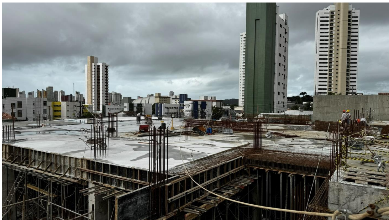
Figura 7. Laje de cobertura do segundo subsolo concretada.
