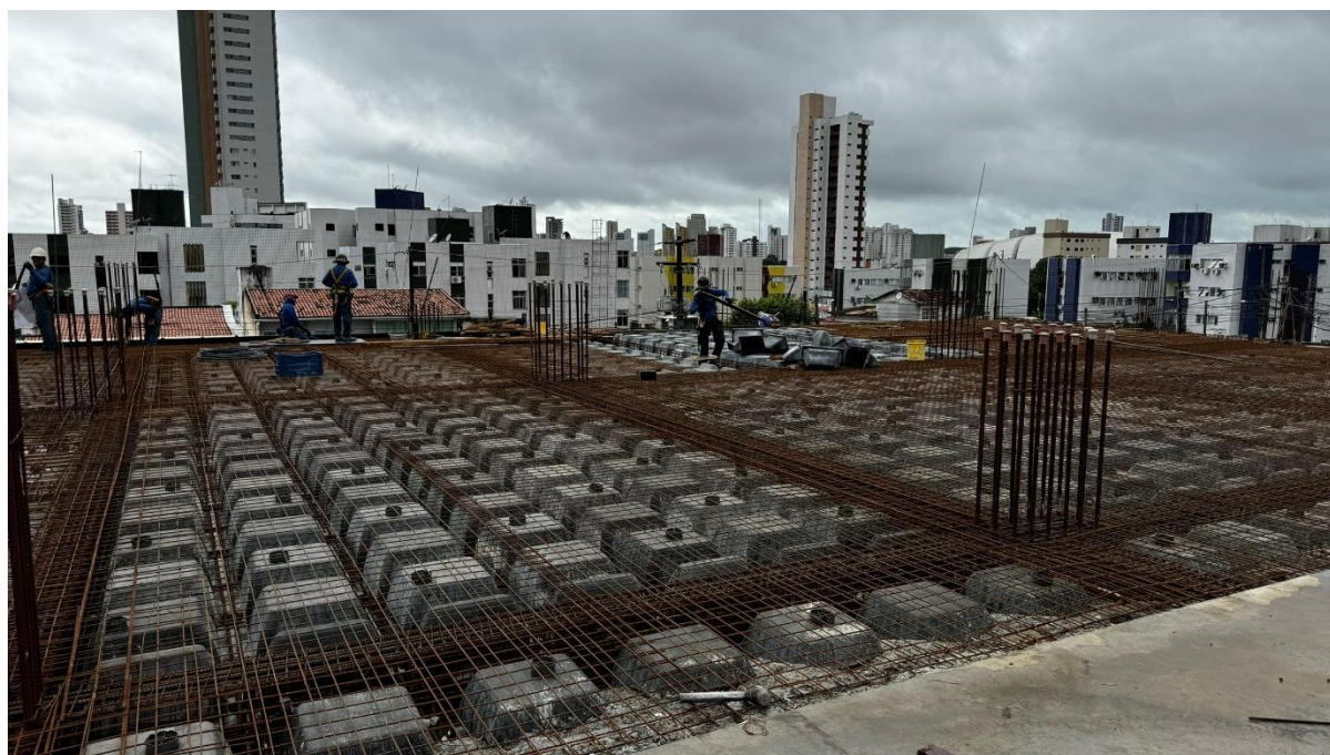
Figura 6. Montagem das cubetas e ferragens do trecho da laje de cobertura do segundo subsolo para ser concretado.
