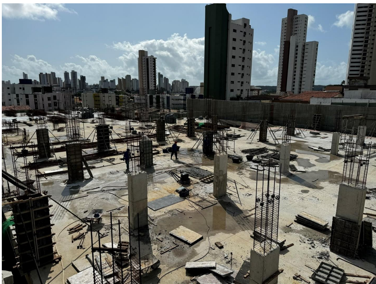
Figura 8. Visão geral da laje de cobertura do segundo subsolo após concretagem.
