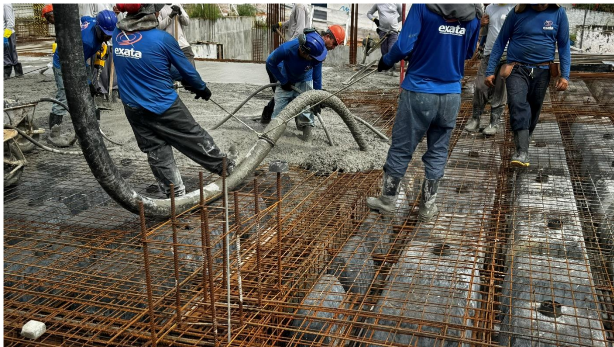
Figura 5. Local da laje de cobertura do segundo subsolo onde foi concretada a sétima etapa.
