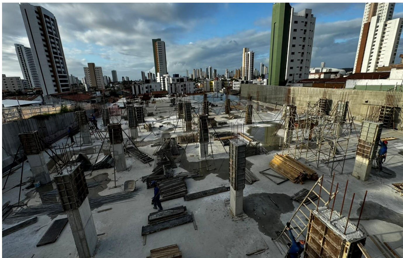
Figura 1. Visão geral da obra.
