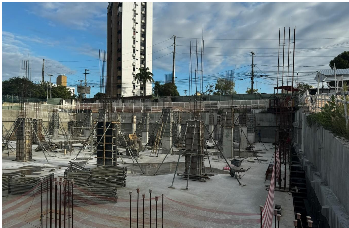
Figura 3. Concretagem do segundo trecho dos Pilares no primeiro subsolo.
