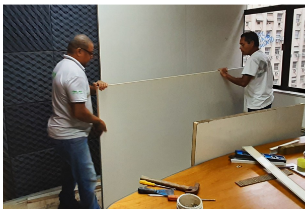
Painéis acústicos foram instalados na Sala de Imprensa: Privacidade da informação
