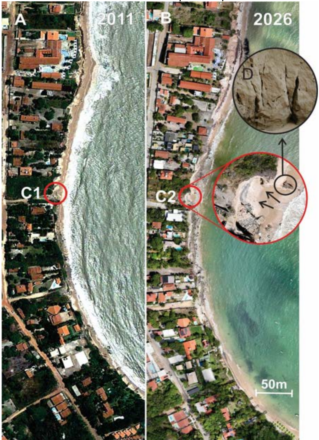
Figura 6: Comparativo entre 2011 e 2026 da Falésia de Conde – PB. No detalhe C1 e C2 observa-se uma reentrância erosional ampliando-se a partir de uma base de rochas fraturadas (Detalhe B) Essa situação é bastante comum na área, onde fraturas levam a formação de reentrâncias e estas ao colapso da escarpa.
