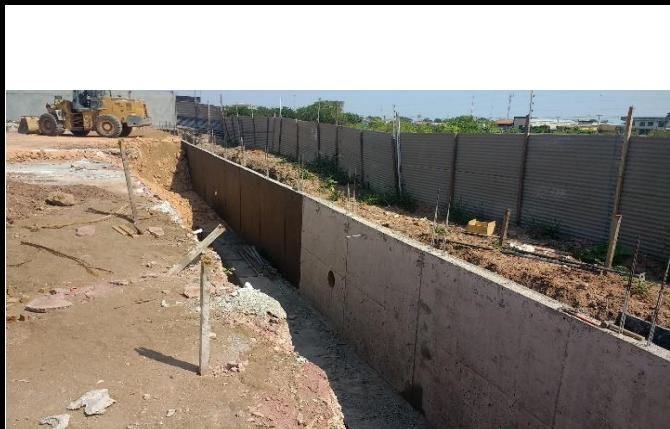
**4. EXECUÇÃO DE ALVENARIA E CHAPISCO DO MURO ACIMA DA CONTENÇÃO;**
