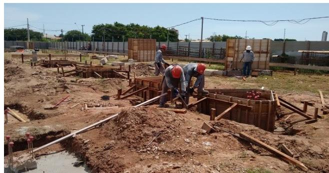
**6. INICIAMOS A COLOCAR A FERRAGEM DAS BLOCOS DENTRO DAS FORMAS;**
