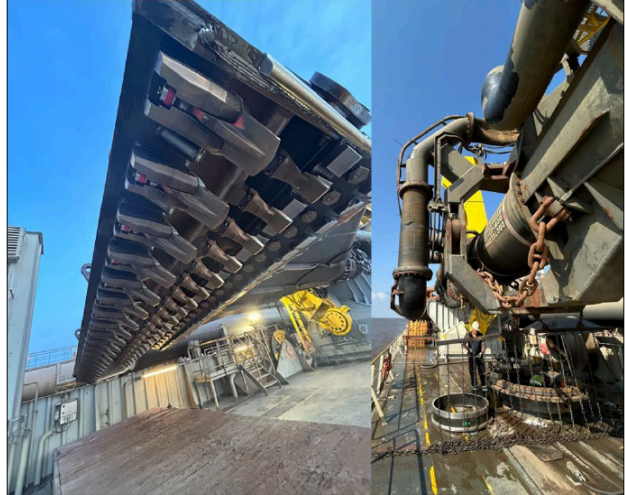
Figura 4-9 - Inspeção de equipamentos durante dragagem.
