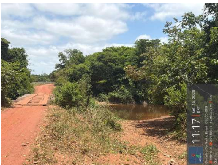
Foto 62 — Ponte sobre o Rio Tawari - Registro capturado em orientação horizontal, com o selo de geolocalização à direita da imagem. Ramal de chão em declive, com trecho alagado ao fundo, no acesso ao ponto apontado como um dos mais vulneráveis do território. Registro de 15/09/2026, às 11h17 (BRT). Coordenadas: 2.024844 S, 46.905839 W; altitude 51 m; azimute 198° S. Município de Garrafão do Norte/PA.
