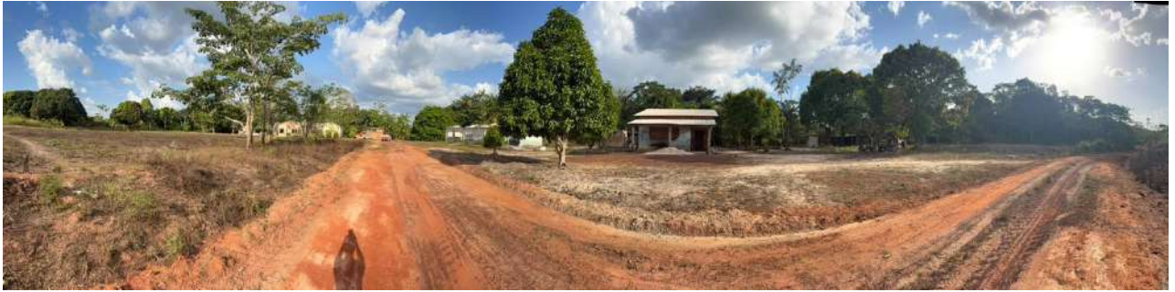
Foto 100 — Ramal de chão de acesso à localidade da Vila do pepino, uma visão panorâmica do local, com sulcos de erosão, e edificações ao fundo. Fotografia sem selo de geolocalização, capturada na mesma ocasião.
