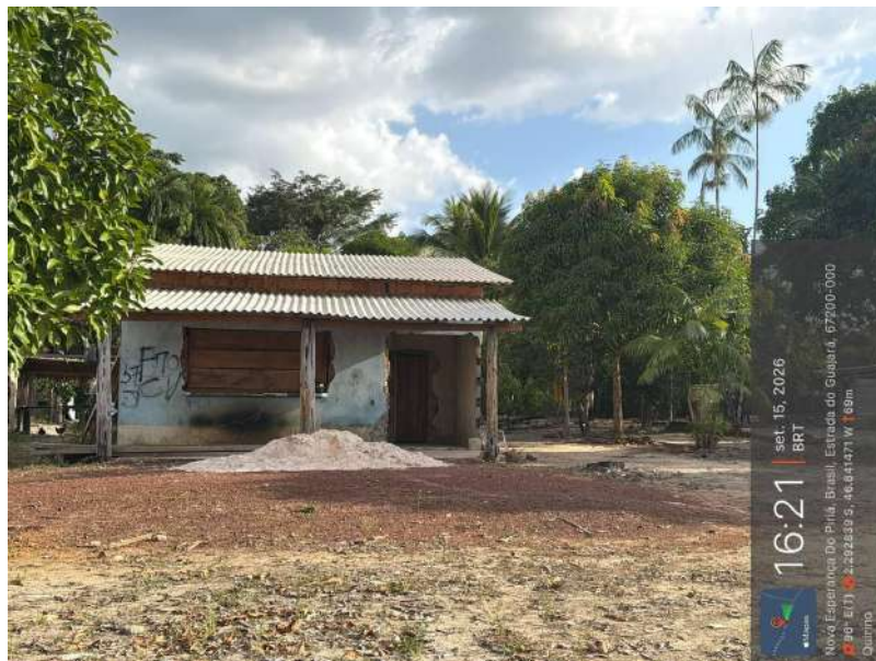
Foto 91 — Outros registros de construções na Vila do Pepino, com o selo de geolocalização à direita da imagem. Edificação alongada, com cobertura de telha e paredes de alvenaria sem revestimento, e material de construção depositado em frente. Registro de 15/09/2026, às 16h21 (BRT). Coordenadas: 2.292839 S, 46.841471 W; altitude 69 m; azimuth 96° E. Estrada do Guajará, Município de Nova Esperança do Piriá/PA.
