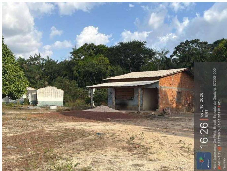
Foto 94 — Registro de outros ângulos das construções, com o selo de geolocalização à direita da imagem. Edificação de alvenaria sem revestimento e sem esquadrias, com cobertura em telha de fibrocimento. Registro de 15/09/2026, às 16h26 (BRT). Coordenadas: 2.292789 S, 46.841671 W; altitude 67 m; azimute 44° NE. Estrada do Guajará, Município de Nova Esperança do Piriá/PA.
