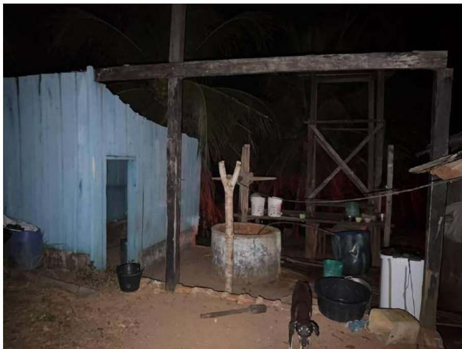
Foto 44 — Poço de alvenaria e reservatórios de água no interior da edificação, evidenciando a forma de abastecimento da comunidade.
