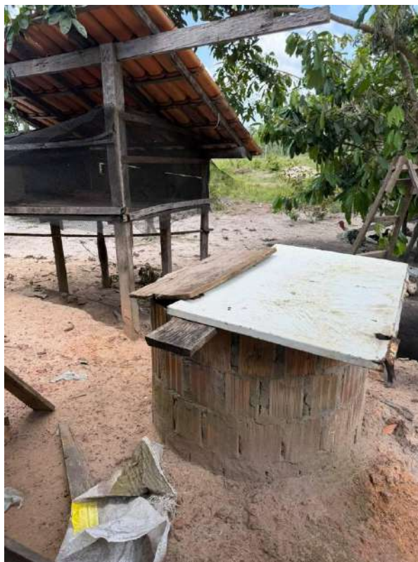
Foto 79 — Estruturas de apoio da residência: jirau de madeira com cobertura de telha e forno de alvenaria, em terreiro de solo arenoso. Fotografia sem selo de geolocalização, capturada na mesma ocasião.
