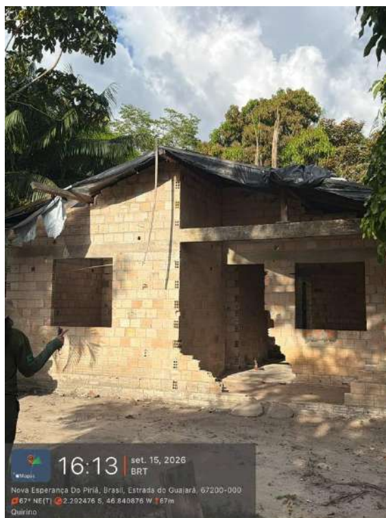
Foto 86 — Edificação de alvenaria inacabada, sem esquadrias e com cobertura provisória de lona plástica. Registro de 15/09/2026, às 16h13 (BRT). Coordenadas: 2.292476 S, 46.840876 W; altitude 67 m; azimuth 67° NE. Estrada do Guajará, Município de Nova Esperança do Piriá/PA.
