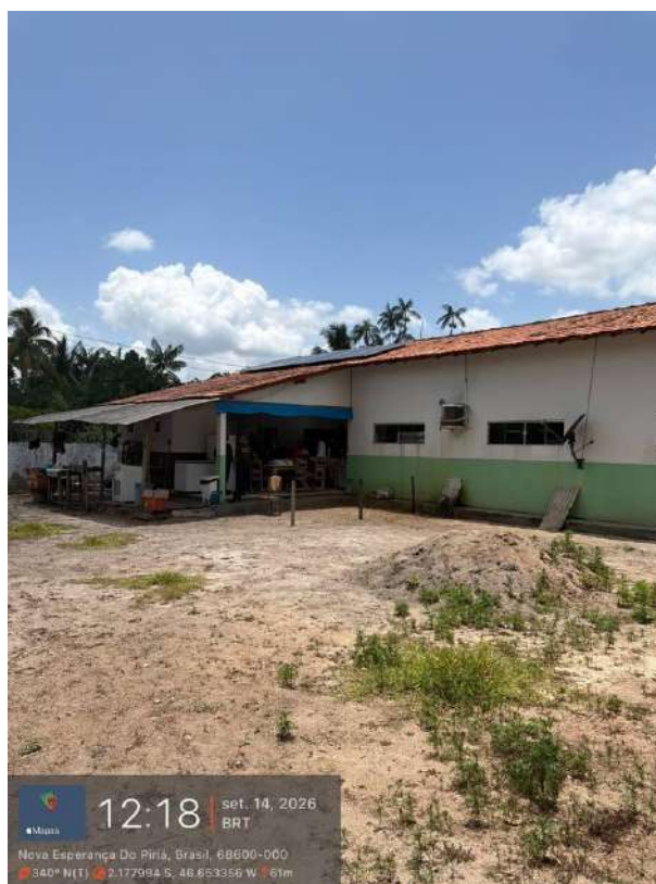
Foto 13 — Fachada da edificação principal da Base do Pedão, em alvenaria, com cobertura de telha cerâmica e área externa desprovida de pavimentação. Registro de 14/09/2026, às 12h18 (BRT). Coordenadas: 2.177994 S, 46.653356 W; altitude 61 m; azimute 340° N. Município de Nova Esperança do Piriá/PA.
