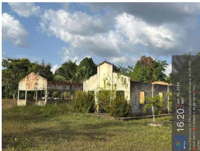
Foto 87 — Registro de construções inacabadas na Vila do Pepino, com o selo de geolocalização à direita da imagem. Conjunto de edificações da localidade, em alvenaria, com sinais de abandono e vegetação em crescimento sobre o terreno. Registro de 15/09/2026, às 16h20 (BRT). Coordenadas: 2.292863 S, 46.841186 W; altitude 67 m; azimuth 324° NW. Estrada do Guajará, Município de Nova Esperança do Piriá/PA.
