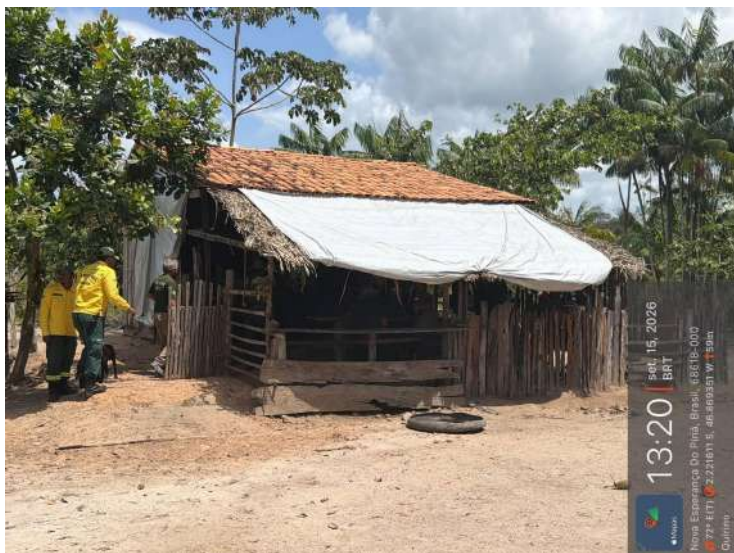
Foto 76 — Registro capturado em orientação horizontal, com o selo de geolocalização à direita da imagem. Residência de madeira com cobertura de telha cerâmica e lona plástica, situada no interior da Terra Indígena. Registro de 15/09/2026, às 13h20 (BRT). Coordenadas: 2.221611 S, 46.869351 W; altitude 59 m; azimuth 72° E. Município de Nova Esperança do Piriá/PA.
