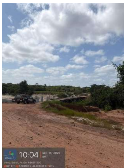
Foto 5 — Travessia sobre curso d'água na rodovia PA-108: ponte de madeira em uso, à direita, e obra de nova ponte em concreto, à esquerda, com viatura da Polícia Militar no local. Registro de 14/09/2026, às 10h04 (BRT). Coordenadas: 1.798132 S, 46.693781 W; altitude 22 m; azimuth 84° E. Município de Viseu/PA.
