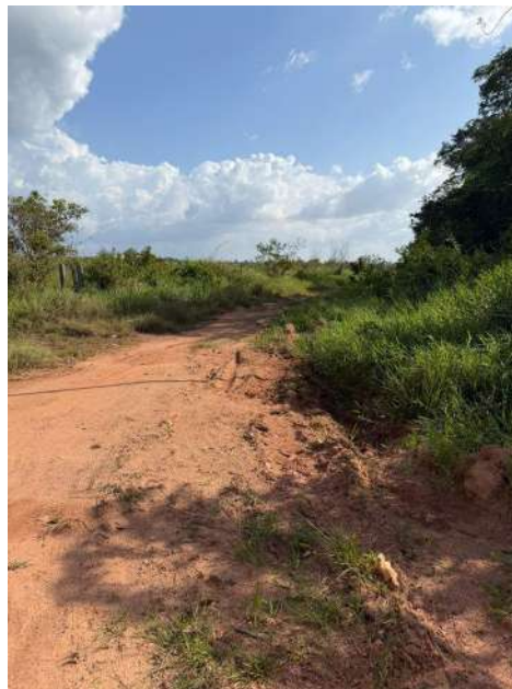
Foto 28 — Ramal de chão em relevo ondulado, com sulcos de erosão e ausência de obras de drenagem, na entrada que dá acesso ao Wiriri. Registro de 14/09/2026, por volta das 15h40.
