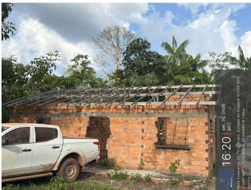
Foto 88 — Registro capturado em orientação horizontal, com o selo de geolocalização à direita da imagem. Edificação de alvenaria com estrutura de cobertura em madeira, sem telhamento, e veículo da comitiva em primeiro plano. Registro de 15/09/2026, às 16h20 (BRT). Coordenadas: 2.292900 S, 46.840953 W; altitude 66 m; azimuth 347° N. Estrada do Guajará, Município de Nova Esperança do Piriá/PA.
