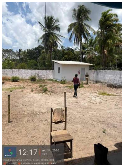
Foto 10 — Edificação anexa de alvenaria, com muro de fechamento e área externa de solo arenoso. Registro de 14/09/2026, às 12h17 (BRT). Coordenadas: 2.177834 S, 46.653438 W; altitude 60 m; azimuth 131° SE. Município de Nova Esperança do Piriá/PA.
