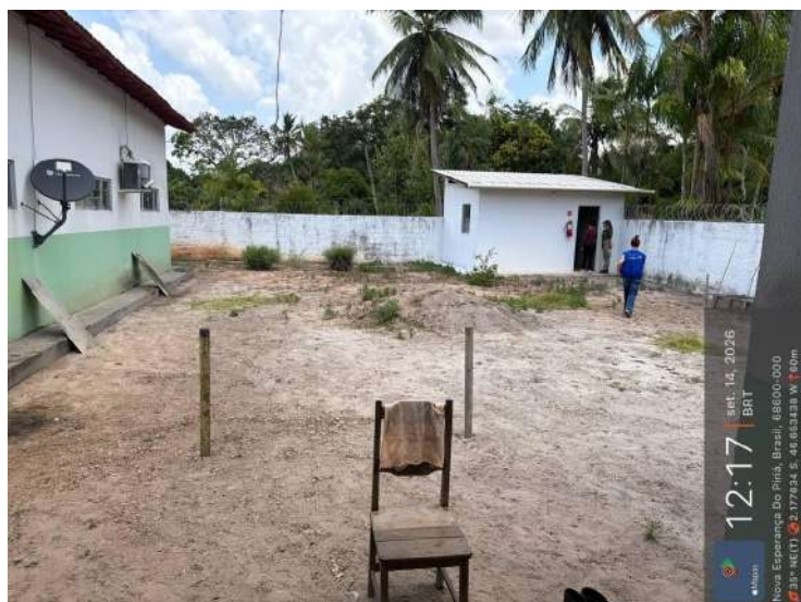
Foto 12 — Registro capturado em orientação horizontal, com o selo de geolocalização à direita da imagem. Área externa da base, com mobiliário e equipamentos de refrigeração dispostos ao lado da edificação. Registro de 14/09/2026, às 12h17 (BRT). Coordenadas: 2.177834 S, 46.653438 W; altitude 60 m; azimute 35° NE. Município de Nova Esperança do Piriá/PA.
