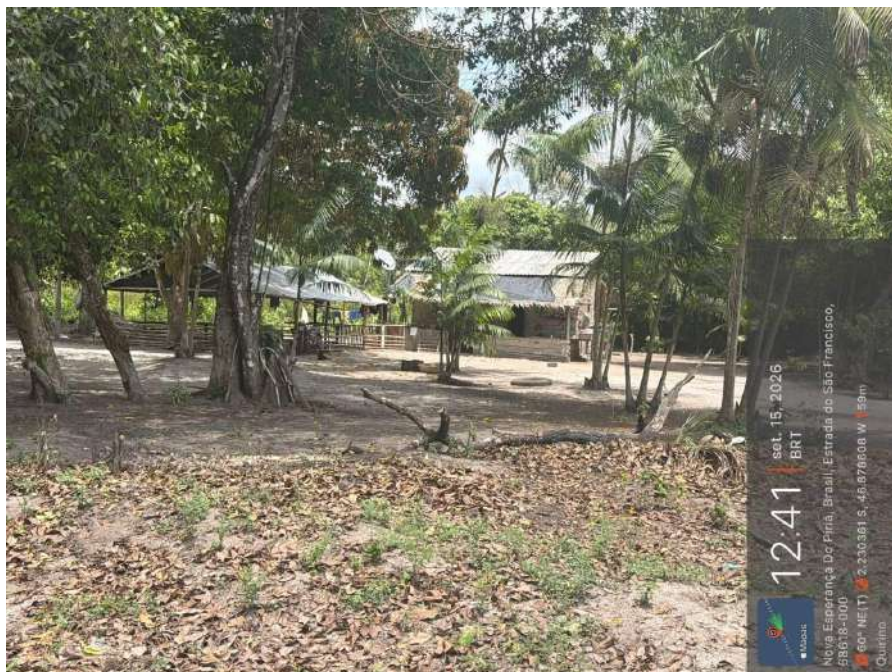
Foto 73 — Registro capturado em orientação horizontal, com o selo de geolocalização à direita da imagem. Conjunto de edificações de madeira com cobertura de telha e de palha, em meio a açaizal, à margem da estrada. Registro de 15/09/2026, às 12h41 (BRT). Coordenadas: 2.230361 S, 46.878608 W; altitude 59 m; azimuth 60° NE. Estrada do São Francisco, Município de Nova Esperança do Piriá/PA.
