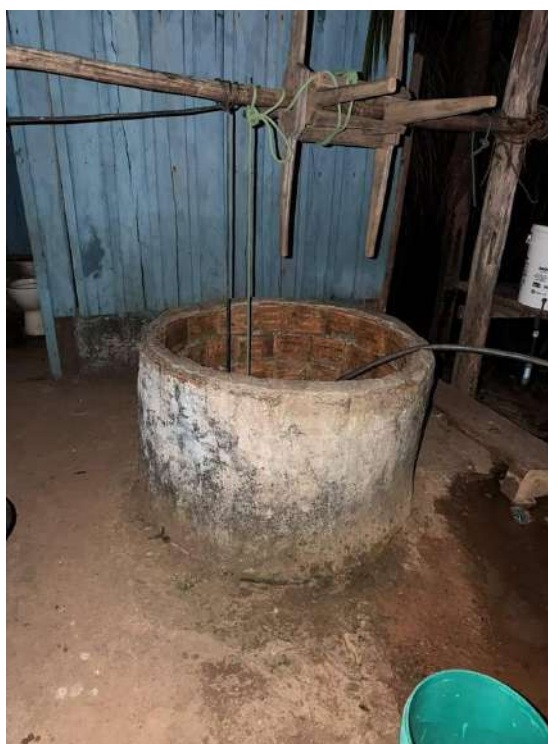
Foto 45 — Detalhe do poço, com roldana de madeira e mangueira de recalque.
