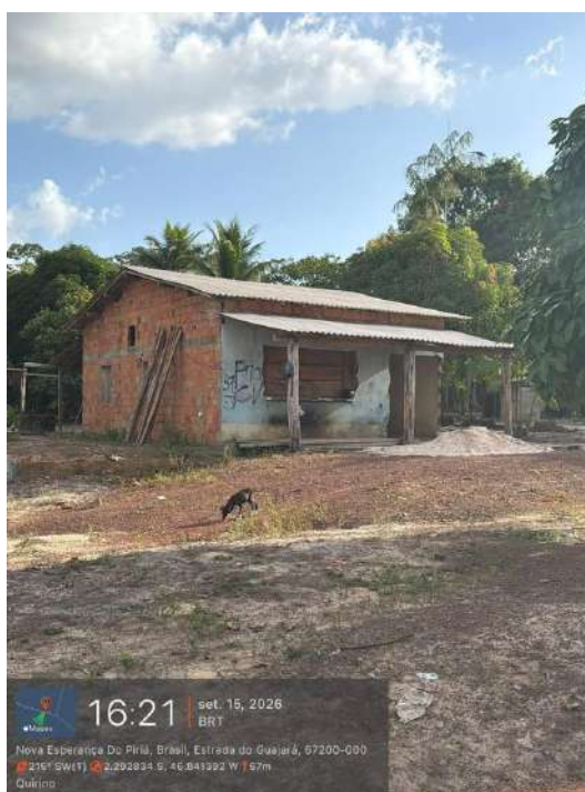
Foto 89 — Edificação de alvenaria com cobertura metálica, sem revestimento, com vãos vedados por tábuas. Registro de 15/09/2026, às 16h21 (BRT). Coordenadas: 2.292834 S, 46.841392 W; altitude 67 m; azimuth 215° SW. Estrada do Guajará, Município de Nova Esperança do Piriá/PA.
