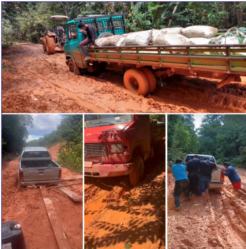
Figura 20 - Imagens registradas, em março/2026, do trecho da BR-163/PA entre o km 1.430,41 e km 1.501,10 com outros pontos críticos de alagamentos, atoleiros e estrangulamento da pista.
