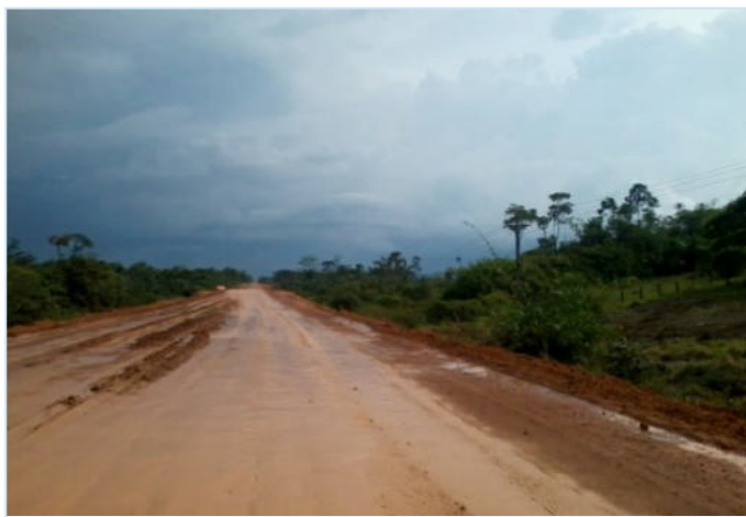
Figura 03 - Rodovia federal com superfície física implantada.
