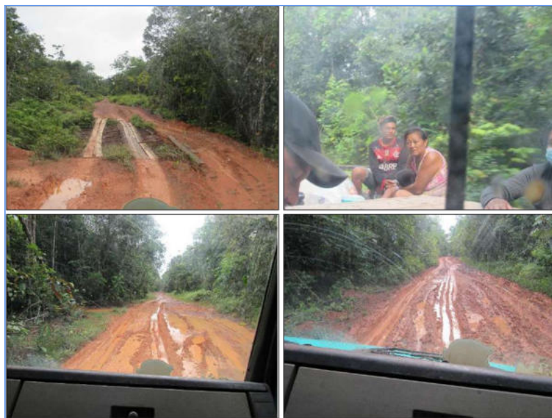
Figura 24 - Imagens registradas pela AIKATUK, em 29/06/2021, de partes do trecho da BR-163/PA entre o km 1.430,41 e km 1.501,10 intrafegáveis.
