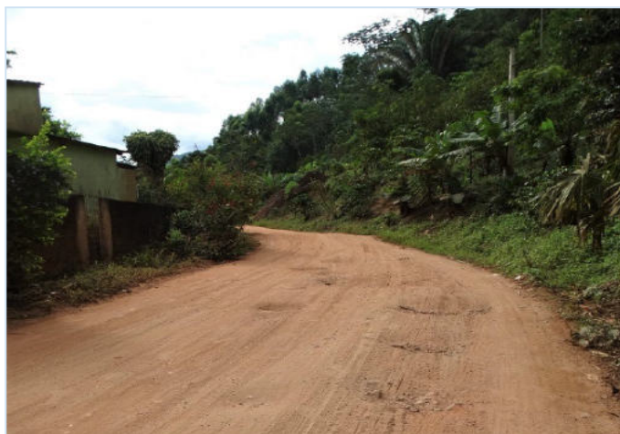
Figura 02 - Rodovia federal com superfície física leito natural.
