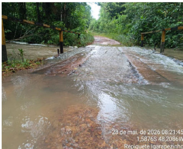
Figura 43 - Transbordamento do ramal do Alto Igarapezinho, devido ao repiquete ocorrido no Igarapezinho em 23 de maio de 2026.
