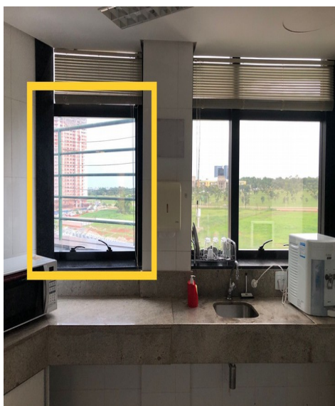
Fig. 7 – janela copa - 5º andar
