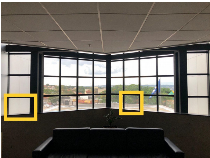
Fig. 9 e 10 – fachada frontal central – 1º andar
