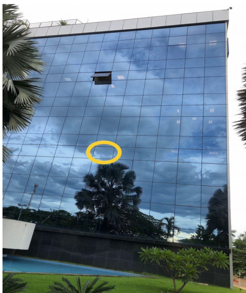
Fig.11 - fachada frontal lado oeste - 1º andar
