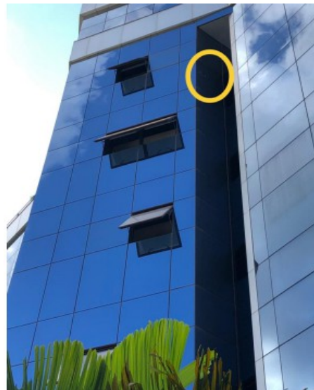
Fig. 13 - fachada não frontal (interno) lado leste - 4º andar
