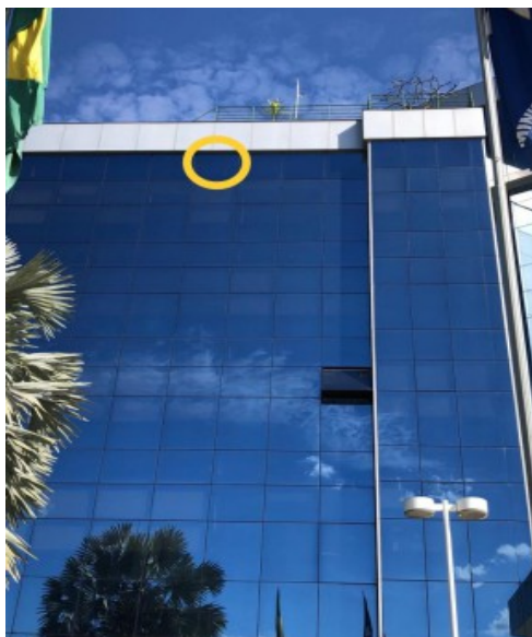
Fig. 12 - fachada frontal lado leste - 4º andar
