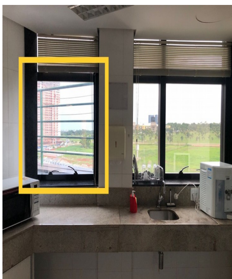
Fig. 7 – janela copa - 5º andar
