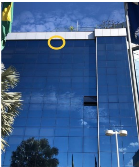
Fig. 12 - fachada frontal lado leste - 4º andar
