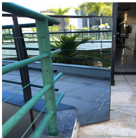
Fig. 5 - fachada saída da recepção – lado leste - Térreo
