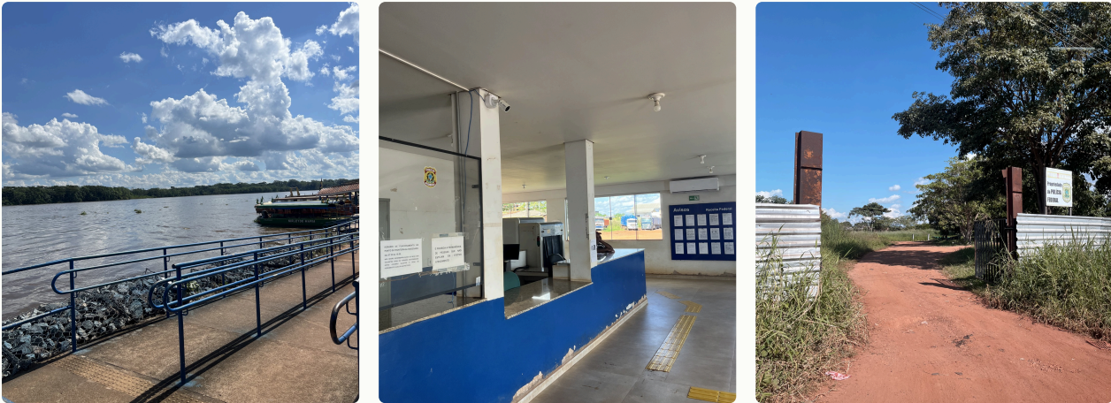
Registros da inspeção do Ministério Público Federal no Porto Fluvial de Guajará-Mirim e em seu entorno, em junho de 2025. Fotos: MPF.
