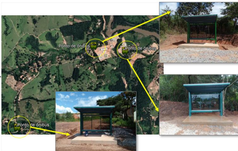
Figura 9 – Abrigos de ônibus já instalados em Ponte das Almorreimas.
