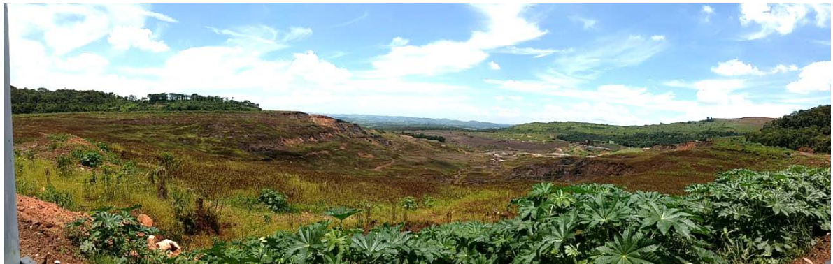
Figura 2. Vista da área dos rejeitos da Barragem I, em janeiro de 2020.
