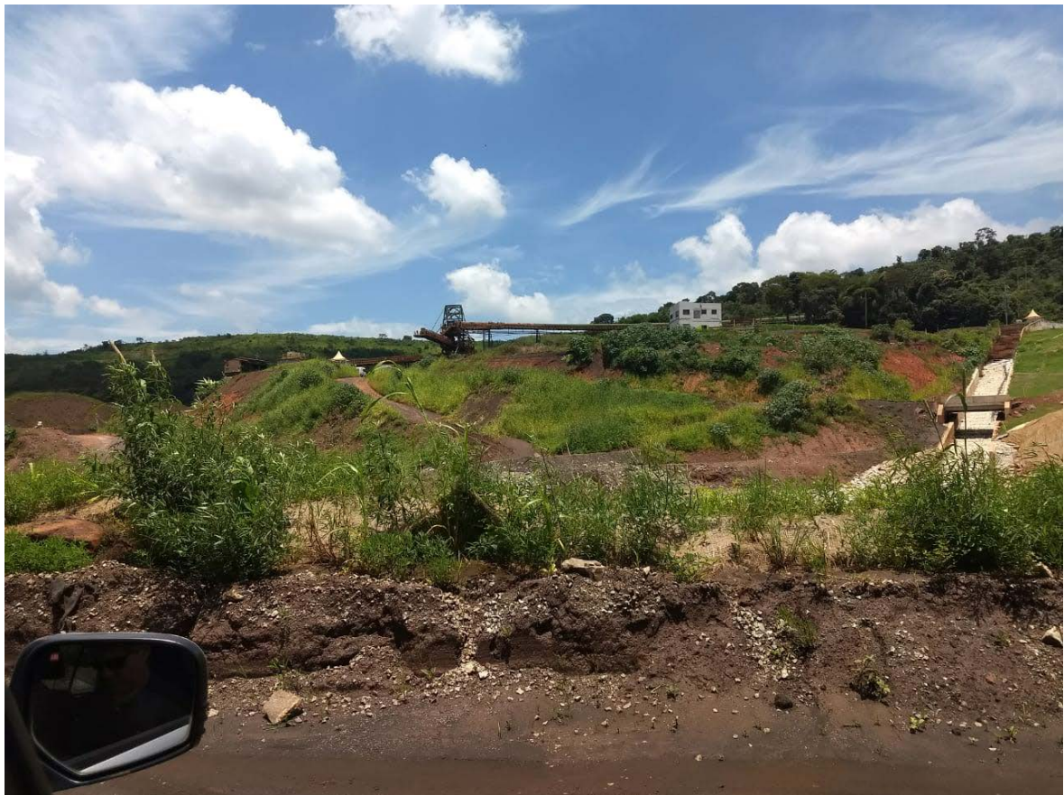
Figura 3. Área original de armazenamento dos rejeitos da Barragem I, em janeiro de 2020.
