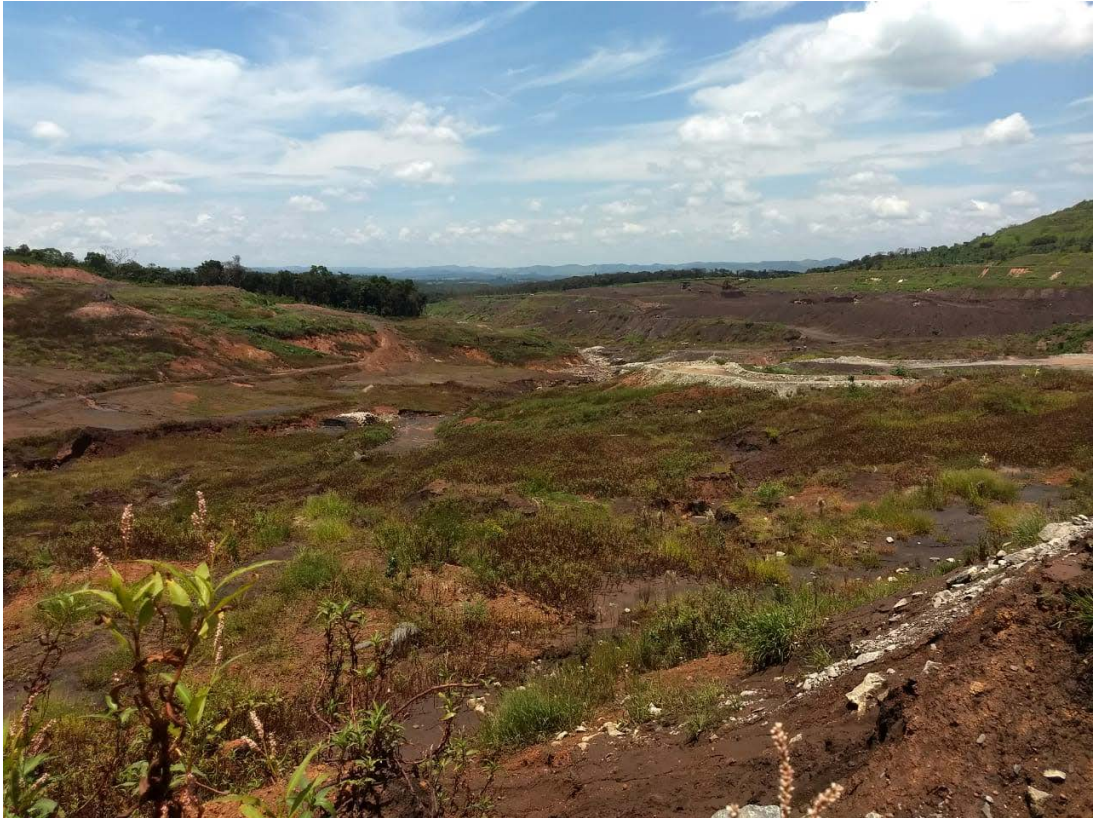
Figura 4. Vista do vale a jusante da Barragem I, soterrado pela lama de rejeitos, em janeiro de 2020.
