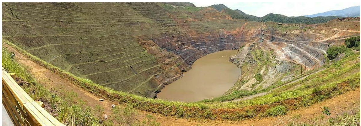
Figura 1. Vista da cava da mina em janeiro de 2020, alagada após o encerramento da exploração do minério.
