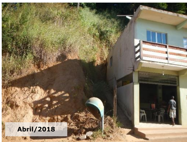
Figuras 2.10-23 e 2.10-24: Estabelecimento comercial indicado como "não concluído" pela Ramboll, reformado pela Fundação Renova, confrontando pelas laterais e fundo com uma grande encosta não estabilizada.
