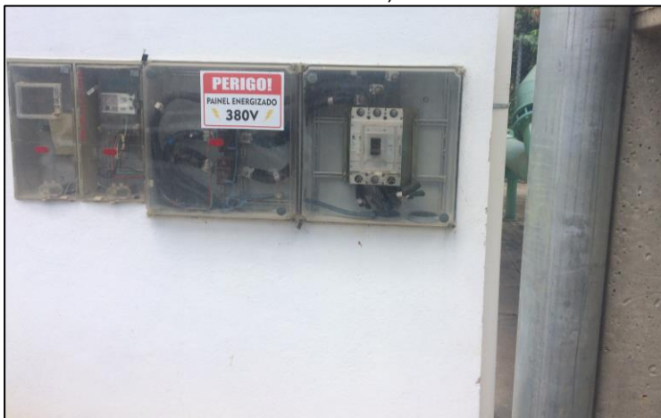
Figura 4.32-4 e .32-5: Colatina/ES – Situação atual das instalações da captação alternativa no rio Pancas, com avarias devido ao furto de cabos e equipamentos elétricos
