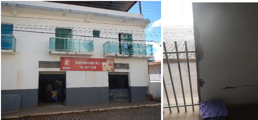
Figura 2.10-22: Reforma de estabelecimento comercial indicada como "não concluída" pela Ramboll. Foram observados problemas como estufamento do reboco, trincas, fiação elétrica exposta e intervenções inacabadas. Data das imagens: 16/05/2018.
