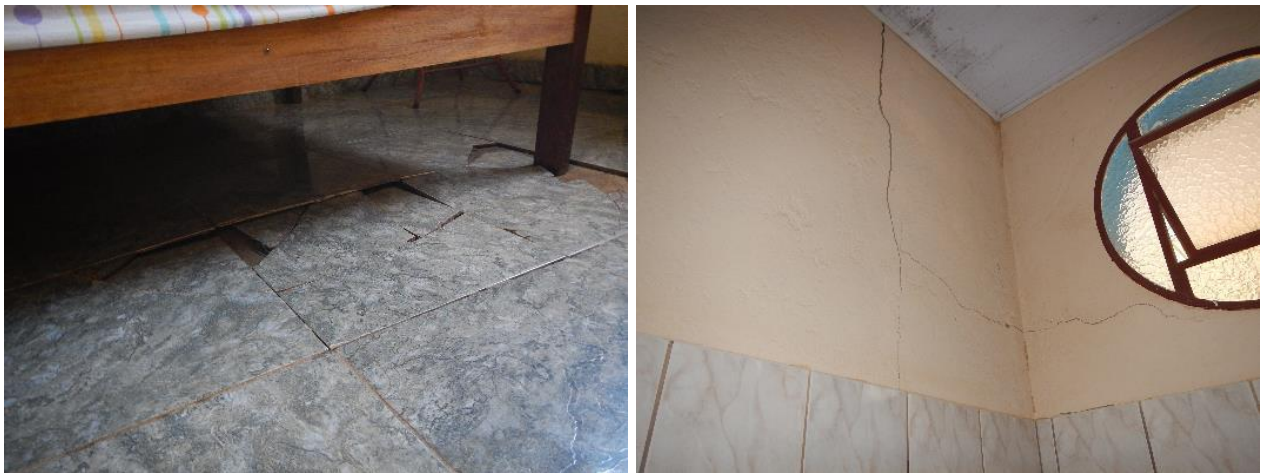
Figura 2.10-22: Reforma de estabelecimento comercial indicada como "não concluída" pela Ramboll. Foram observados problemas como estufamento do reboco, trincas, fiação elétrica exposta e intervenções inacabadas. Data das imagens: 16/05/2018.
