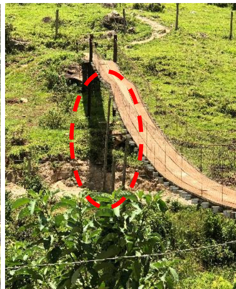
Figuras 2.10-9 e 2.10-10: Ponte de cabo de aço com acesso tomado por vegetação (esquerda) e com escora improvisada (direita). Data das imagens: 24/01/2019.
