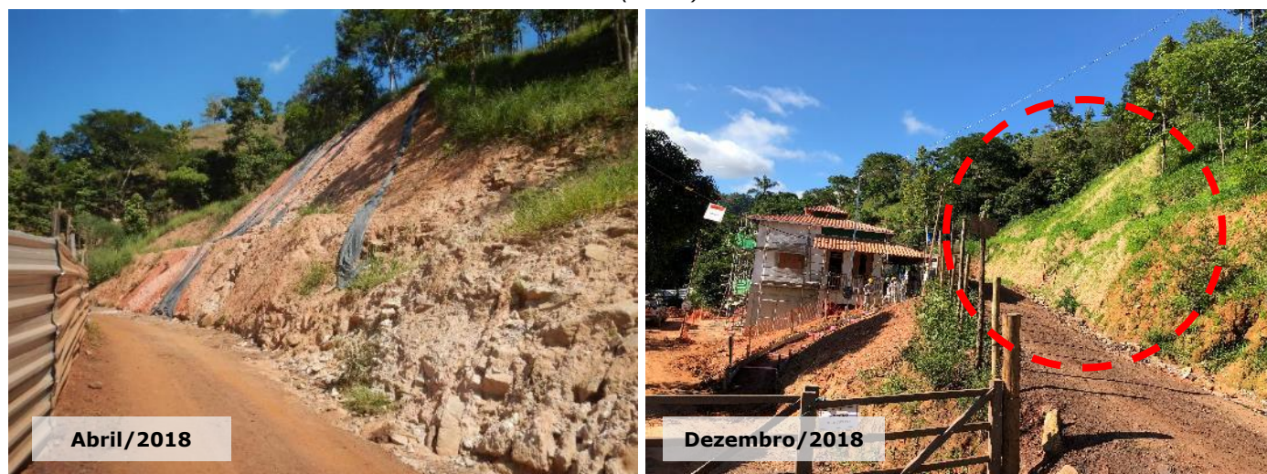
Figuras 2.10-5 e 2.10-6: Acesso não pavimentado com talude não estabilizado (esquerda) e após tratamento com uso de biomanta (direita).
