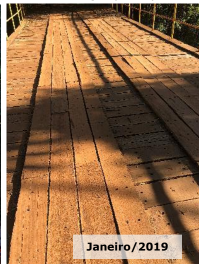
Figuras 2.10-11 e 2.10-12: Ponte Bento x Mariana em construção (esquerda) e após sua conclusão com tabuleiro de madeira aparentemente sem tratamento contra umidade e ataque de insetos/fungos (direita).
