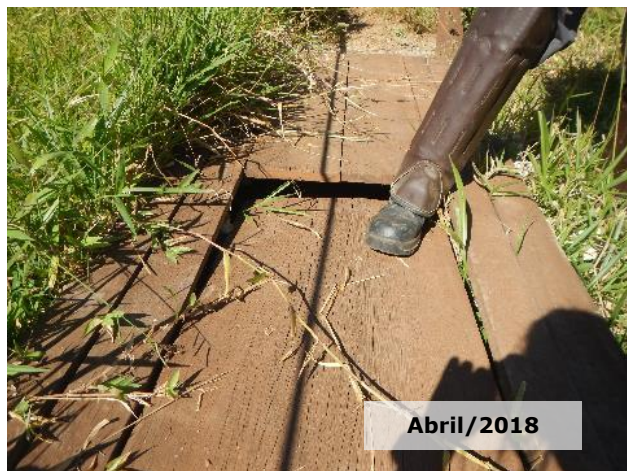
Figuras 2.10-7 e 2.10-8: Ponte de cabo de aço com tabuleiro danificado. As fotos mostram a mesma ponte vistoriada em abril/18 e janeiro/19, indicando que não houve manutenção nesta estrutura.
