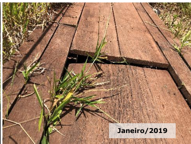
Figuras 2.10-7 e 2.10-8: Ponte de cabo de aço com tabuleiro danificado. As fotos mostram a mesma ponte vistoriada em abril/18 e janeiro/19, indicando que não houve manutenção nesta estrutura.
