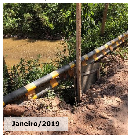
Figuras 2.10-1 e 2.10-2: Erosão nos acessos das vias não pavimentadas.
