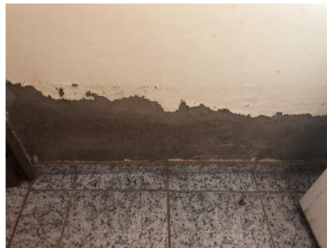
Figuras 2.10-29, 2.10-30 e 2.10-31: Ponto 552 – Reforma não concluída (destaque para o descascamento da pintura, banheiro sem forro/laje; quintal improdutivo), localizada em área de Dam Break. Data das imagens: 28/11/2018.
