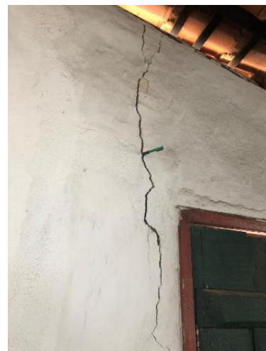
Figuras 2.10-25 e 2.10-26: Reforma da edificação não iniciada (de acordo com a proprietária foi feito apenas o fechamento do paiol com madeira, a casa possui várias trincas como mostrado na imagem à direita). Data das imagens: 28/11/2018.
