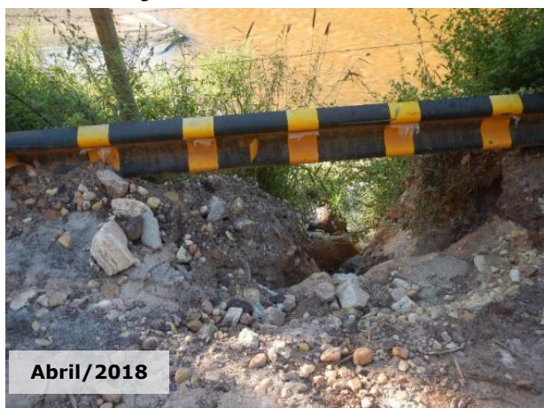
Figuras 2.10-1 e 2.10-2: Erosão nos acessos das vias não pavimentadas.
