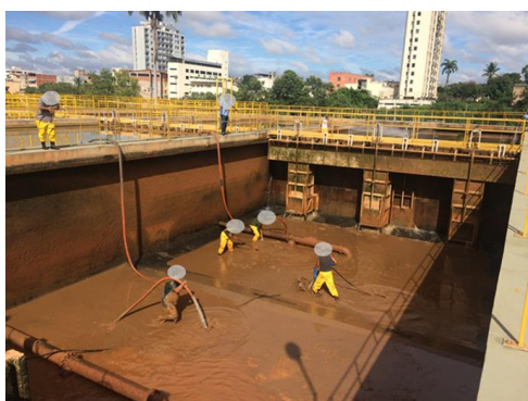
Figura 2.38-01: limpeza do decantador SAAE de Governador Valadares- ETA Central no dia 12/12/18 (Fonte: Ramboll, 2018)
