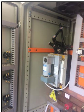
Figura 4.32-4 e .32-5: Colatina/ES – Situação atual das instalações da captação alternativa no rio Pancas, com avarias devido ao furto de cabos e equipamentos elétricos
