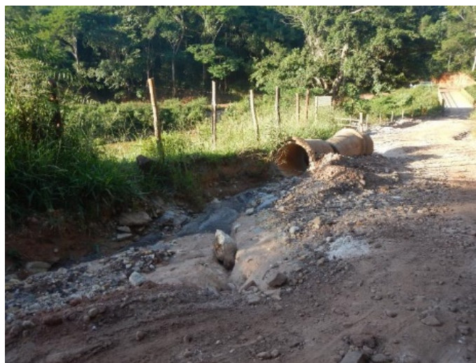
Figuras 3.10-1 e 3.10-2: Erosão nos acessos das vias não pavimentadas
