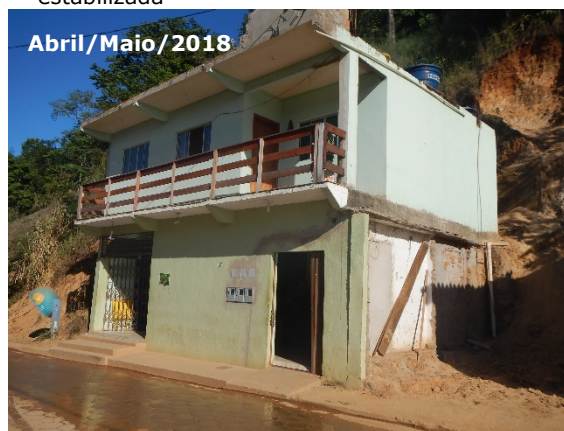
Figuras 3.10-21 e 3.10-22: Estabelecimento comercial confrontando pelas laterais e fundo com uma grande encosta não estabilizada
