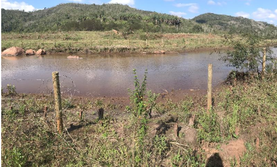
Figura 3.25-5 - Cercamento danificado identificado na Área Prioritária 11.
