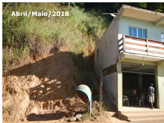
Figuras 3.10-21 e 3.10-22: Estabelecimento comercial confrontando pelas laterais e fundo com uma grande encosta não estabilizada
