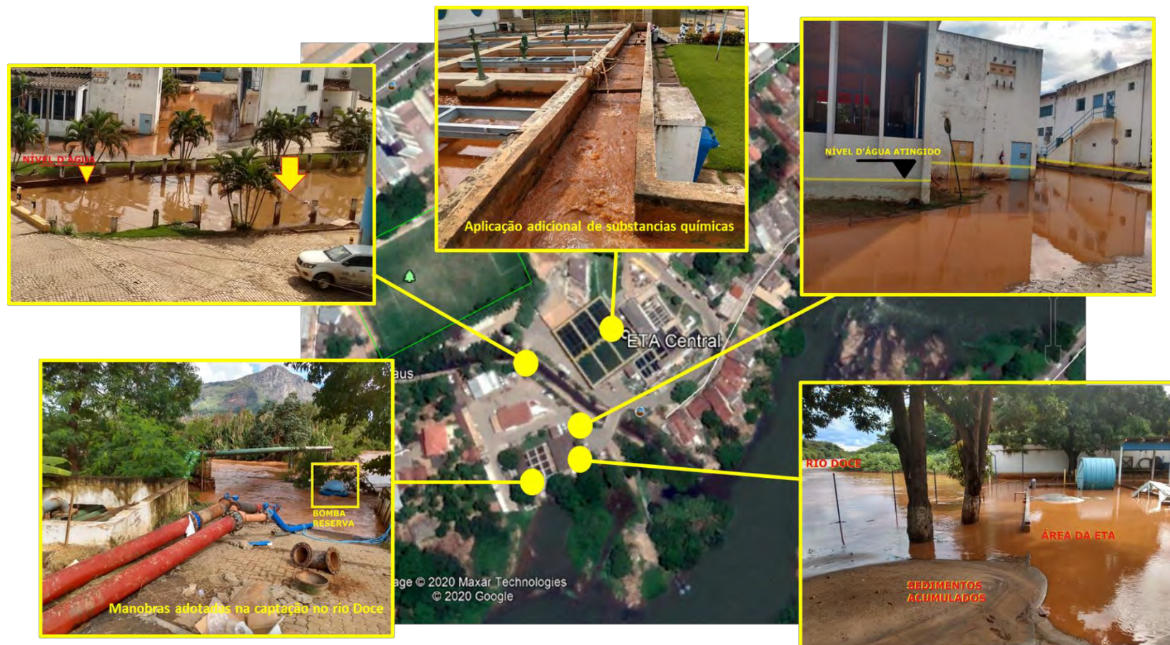
Figura 10. Registro fotográfico da ETA Central em Governador Valadares durante visita técnica realizada pela Ramboll nos dias 28 e 29 de janeiro de 2020 (Fonte: RAMBOLL. 2020)
