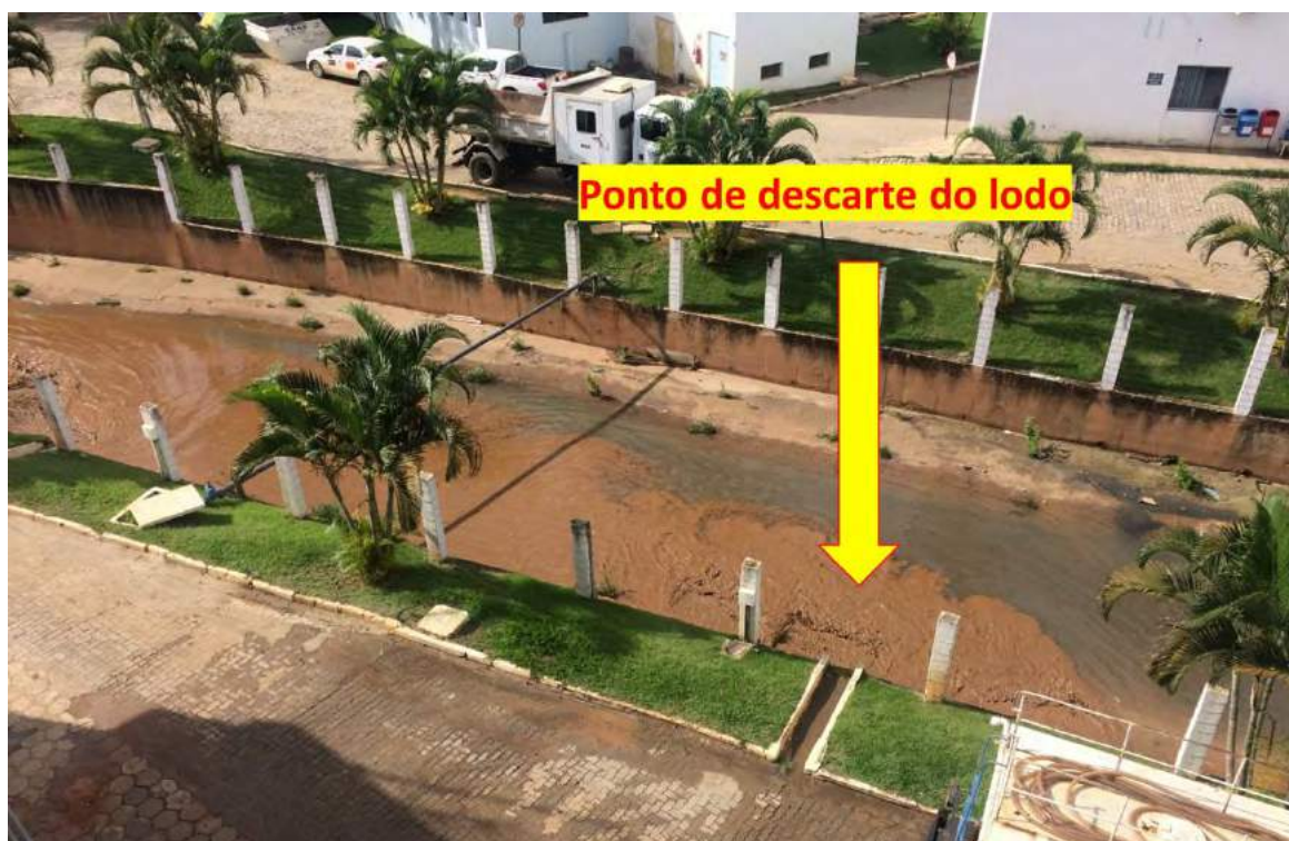
Figura 8. Foto do ponto de descarte do resíduo de limpeza dos decantadores da ETA Central, em Governador Valadares/MGno dia 12/12/18 (Fonte: Ramboll, 2018)
