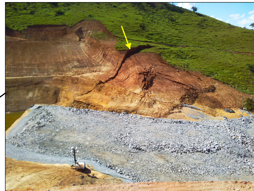
Foto 1 - Vista da ruptura na ombreira esquerda do Dique Intermediário (foto tomada em 28 de junho de 2018)
