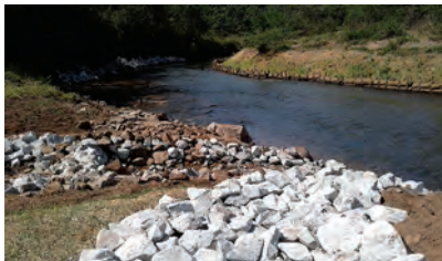
Enrocamento na margem
