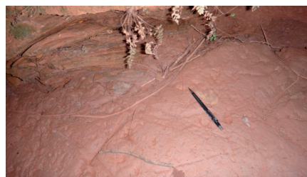
D – Detalhe da presença de lama de rejeito
