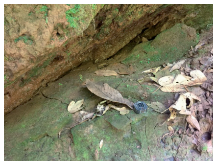
D - Detalhe da presença de lama de rejeito
