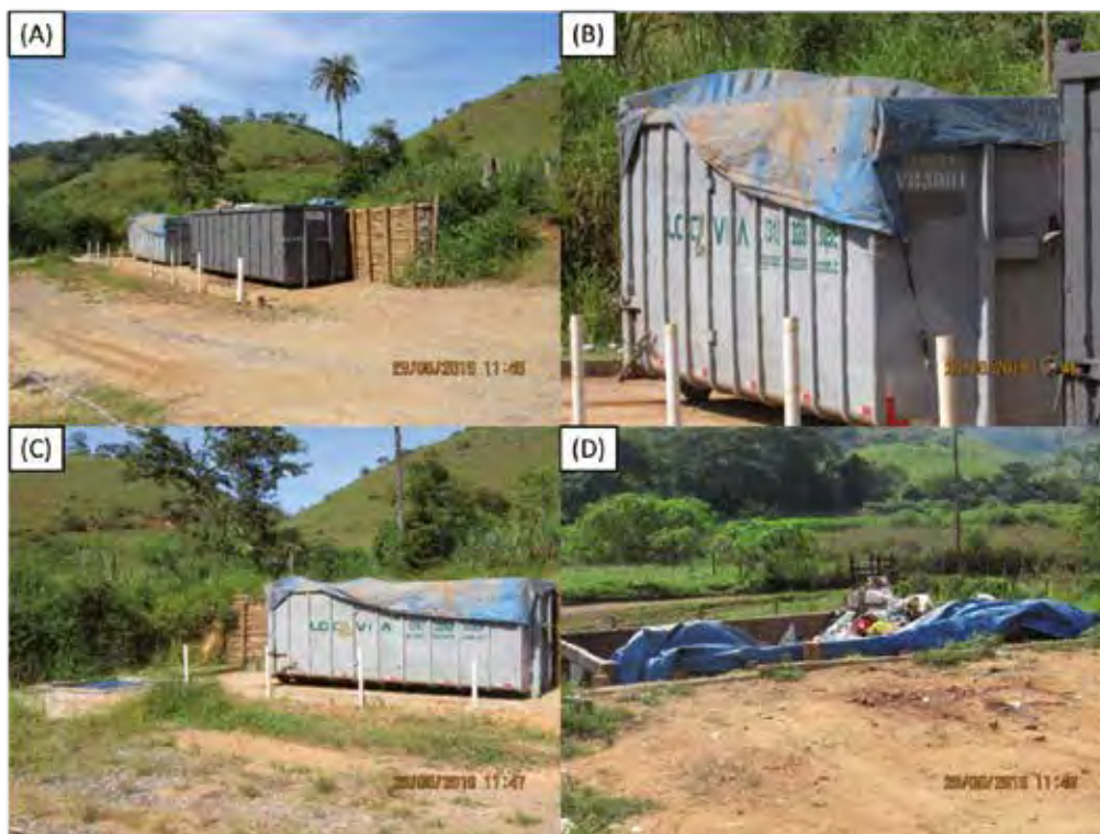
Figura 5 – Estação de transbordo provisória de Barra Longa: (A) caixas estacionárias, aparentemente sem processo de separação de resíduo; (B) caixa estacionária com cobertura adequada; (C) caixa estacionária e caixa coletora de efluente e (D) caixa estacionária e rampa de acesso. Fonte: LACTEC (2019).
